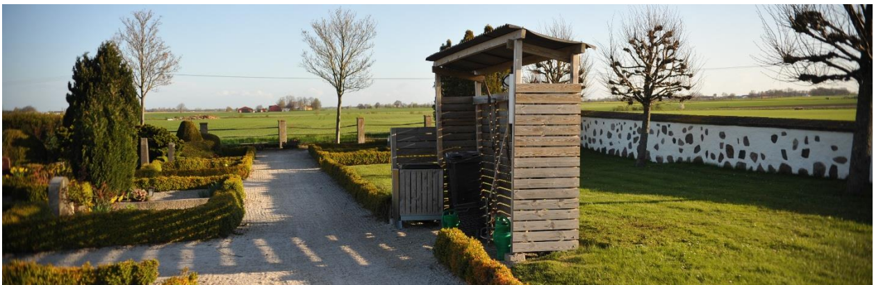
Serviceplatser är väl ordnade med en inbyggnad av naturfärgad glespanel och tak.
