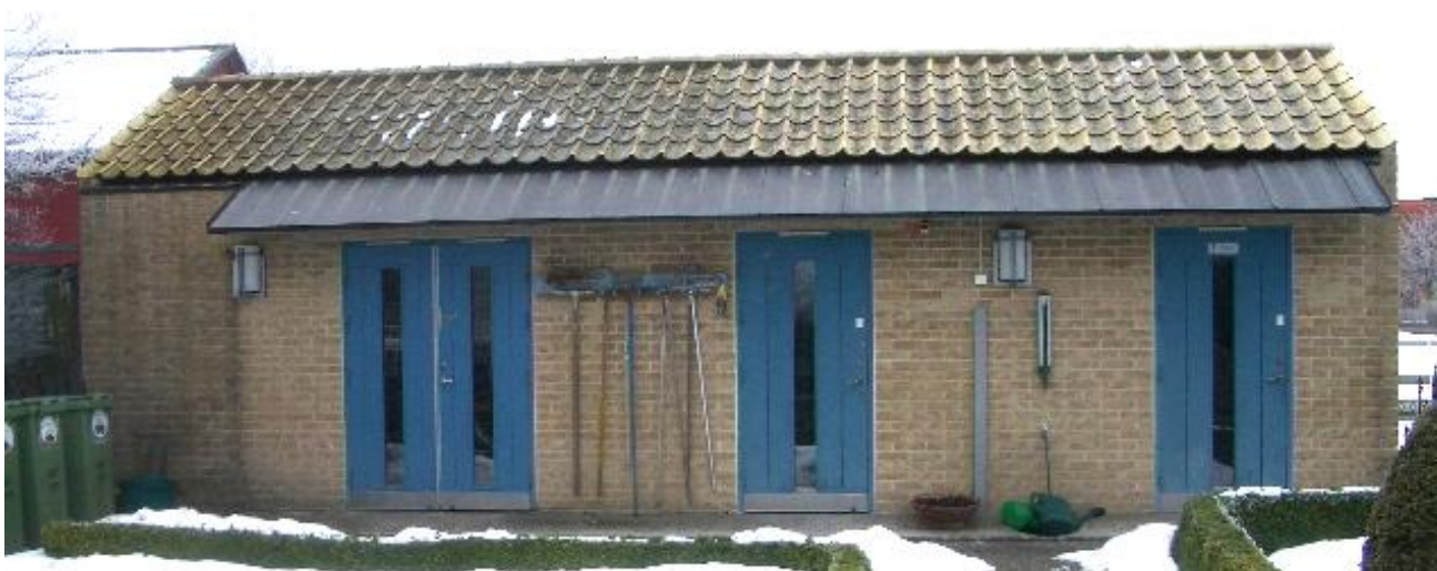
Vaktmästeriet norra fasad har ett utbyggt skärmtak av plåt med fyra dörrar och en serviceplats med redskap mm.
