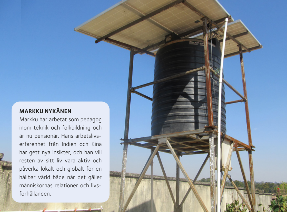
Solcellsdriven pump monterad i en indisk by där Markku arbetat som volontär kortare perioder.
