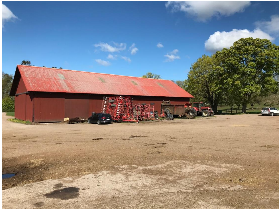
Maskinhall i trä om ca 14*32 m. Tak av plåt och med betonggolv.
