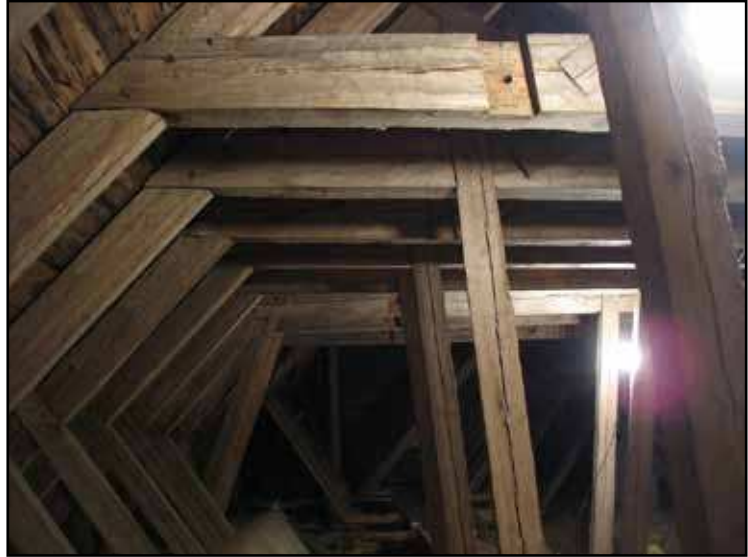
Detalj från väster. Hopfogningar är raka bladningar med en till två dymlingar. Alla ytor är sprättäljda.
