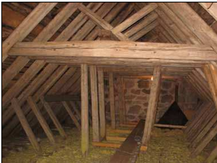
Taklaget över långhusets västra del sett från öster. Sparrkrysset över hanbjälken återfinns i bl.a. Dädesjö gamla kyrka.
