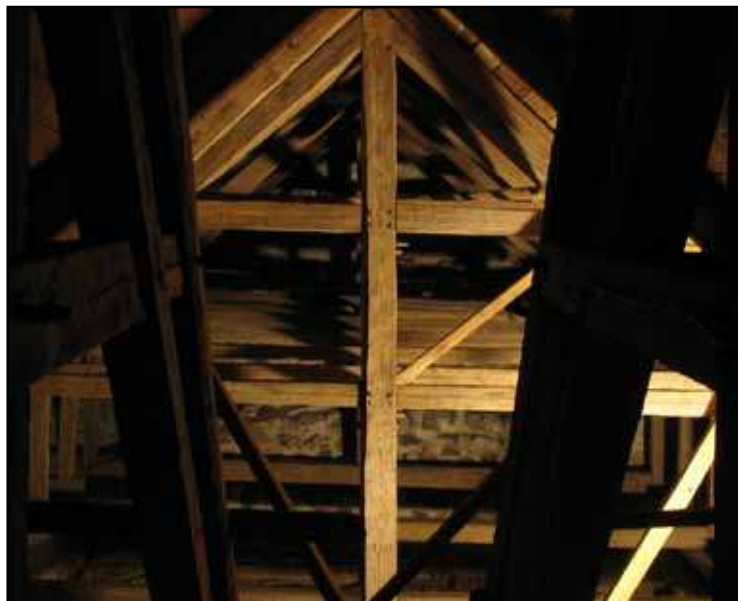
Taklaget österifrån. Den östra kungsstolpen visar att långstolen ej fortsatt längre, sannolikt på grund av ett murat eller timrat gavelröste till långhusets ursprungliga utsträckning.
