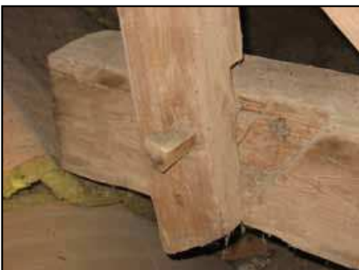
Infästning stödben i tass. Några av tassarna i nordväst har spår av äldre bladningar som också talar för en ombyggnad.
