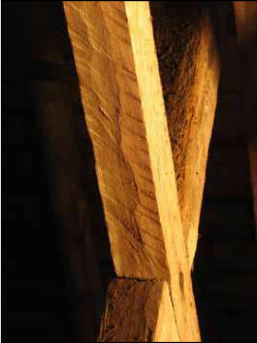
Möte mellan stödben, bladning med spik och tydlig sprättäljning. Ovan till höger syns bindbjälkarnas inmurning i murkrönet. Mellan bindbjälkarna syns puts.
