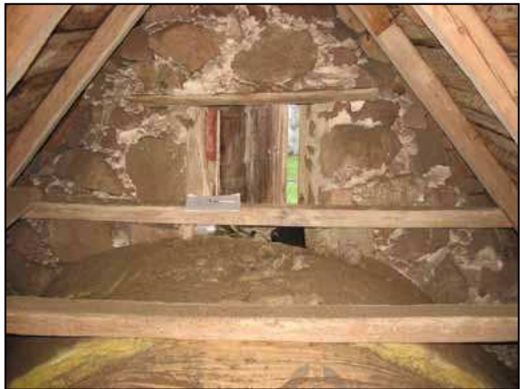
Sett från söder. Ovan gavelöppningen sitter en troligen återanvänd ekplanka med profilering. Se detaljfoto till vänster.
