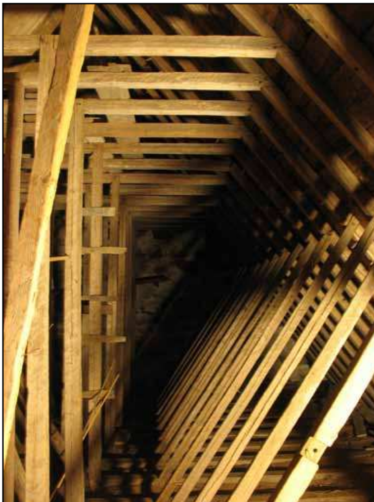
Södra halvan av långhusets taklag sedd från väster. Notera bladningen i det främsta stödbenet.
