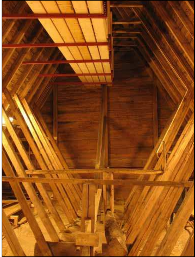
Långhusvinden mot öster. I mitten syns vippor för nedhissning av takkronor. Överst är en landgång monterad för underhåll av sprinkler.
