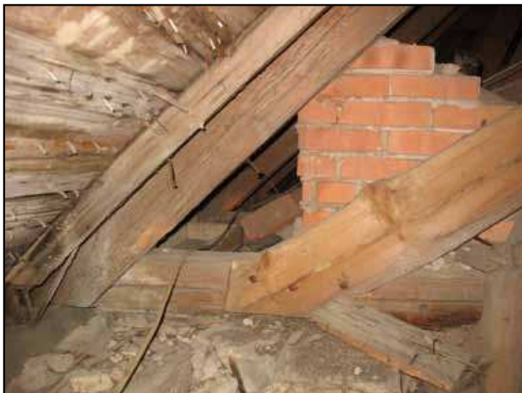
Den första av de gotiska takstolarna över långhusets östra hälft, sedd från väster.
