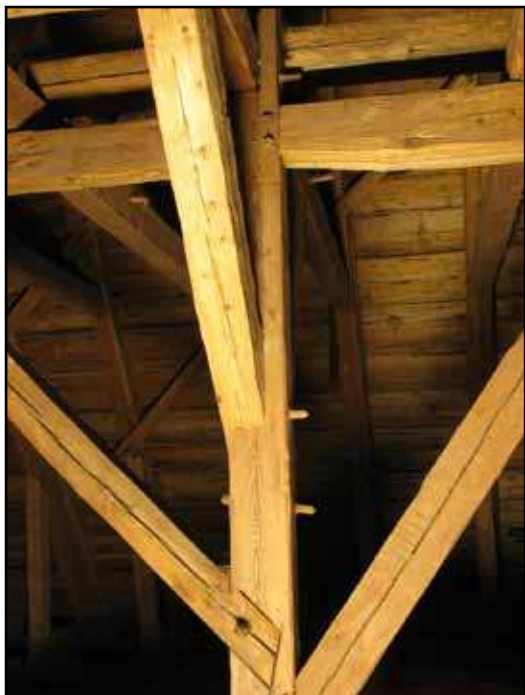
Den andra av kungsstolparna sedd från söder.
