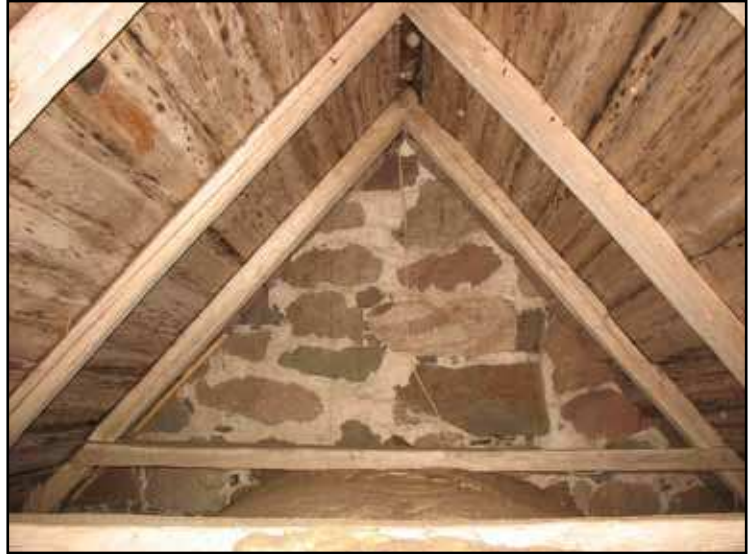
Sakristians gotiska taklag sett från norr.
