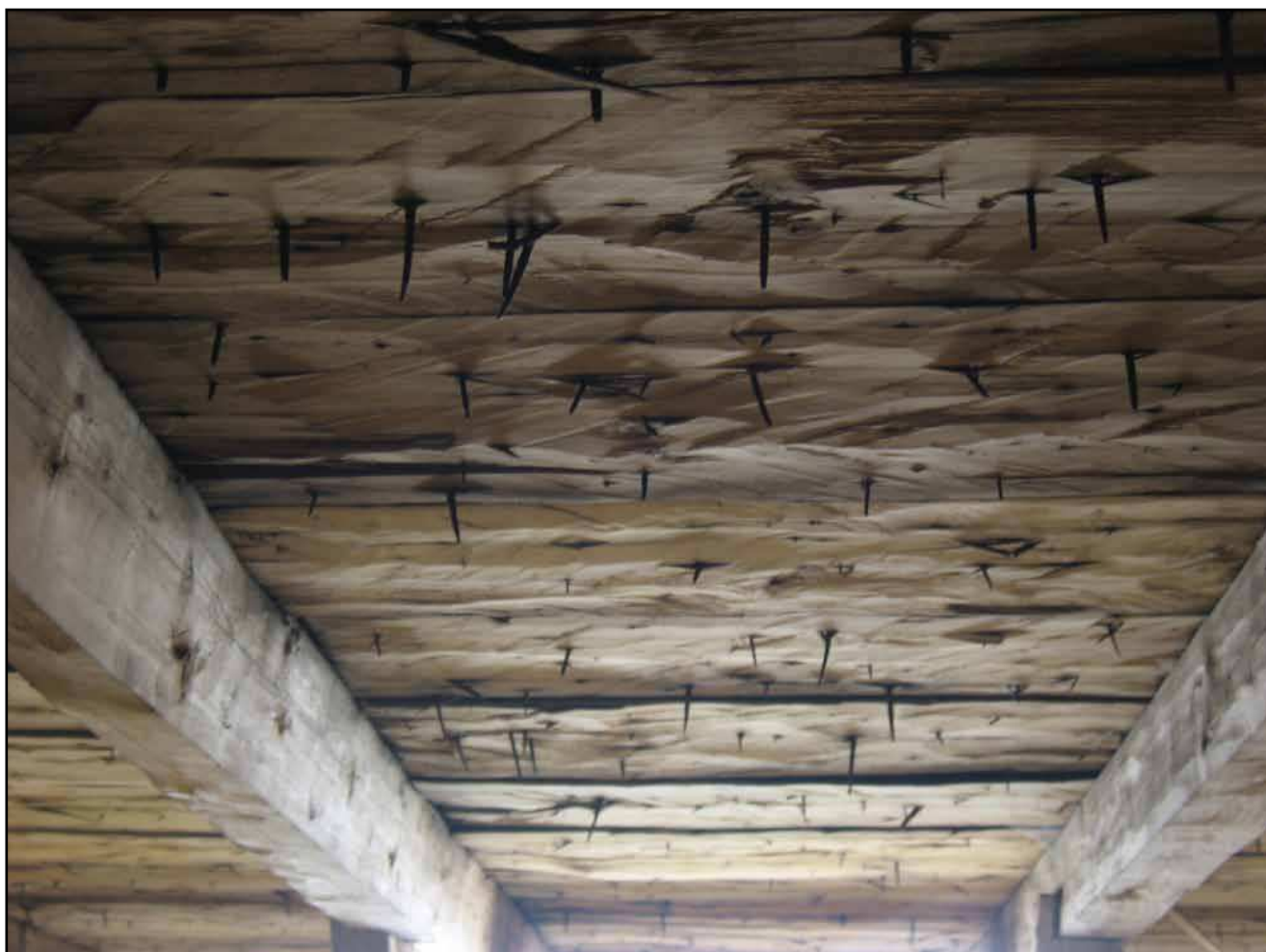
Sprättäljda trobräddor på korets norra takfall.
