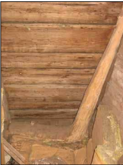
Ett så kallat "rotknä" i södra vinkeln mellan remstycket och västra gavelröstet.
