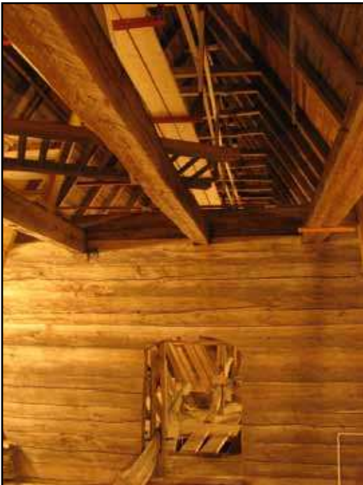
Vy mot öster inifrån tornet. Alla bjälkar är sprättäljda.
