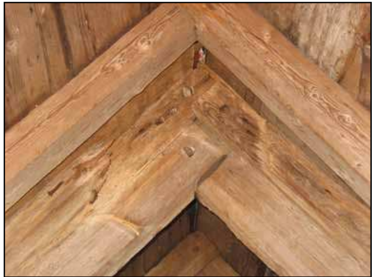
Högbenens sick-sackformade hopfogning. Den utsparade listens avbrott till höger därom vittnar om att där suttit en vertikal bräda som avslutning på gaveln.
