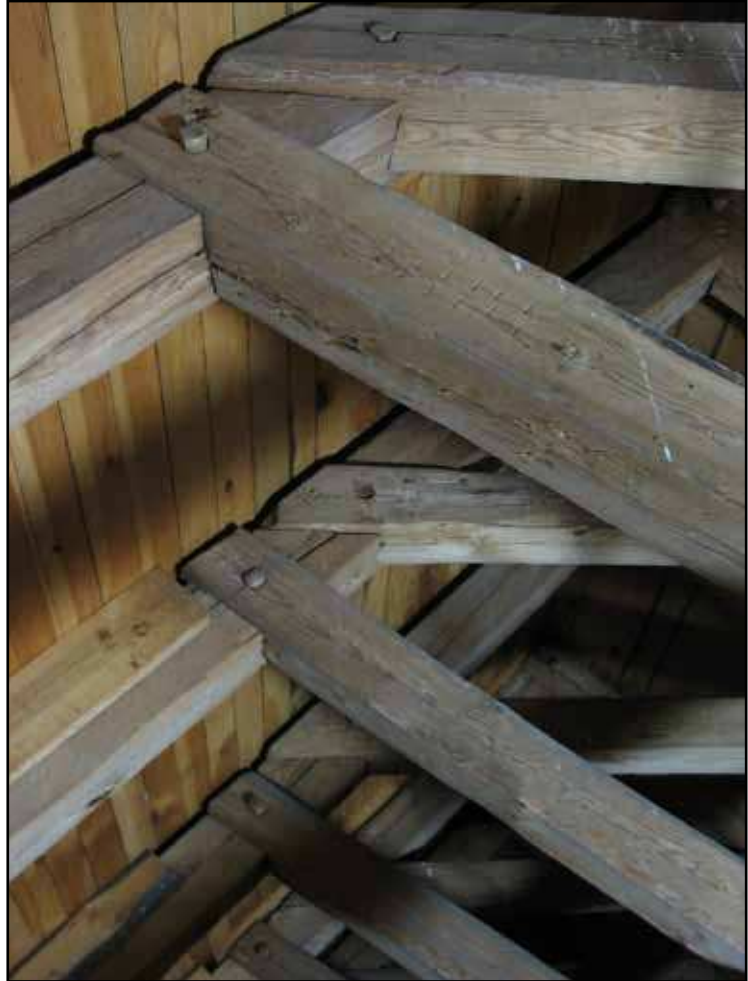
Hopfogning mellan högben, kryssparre och hanbjälke, sedd från öster.
