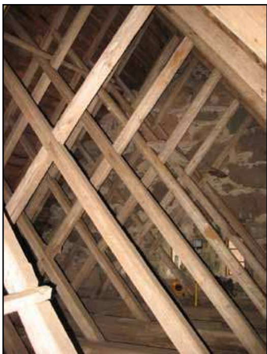
Långhusets taklag från nordost.
