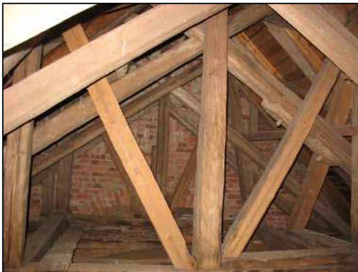
Konstruktion vid västgaveln som kan vara spår av en försvunnen takryttare. Notera den fastdymlade regeln på kryssparren till höger.
