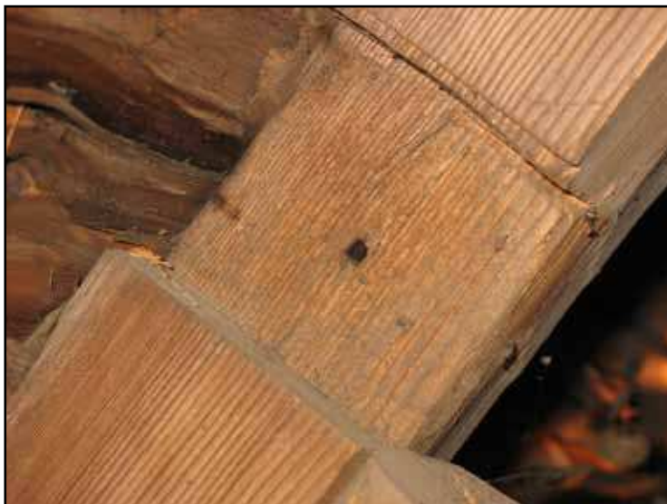
Urtag med spikhål i högben efter bladning med varandra korsande stödben.
