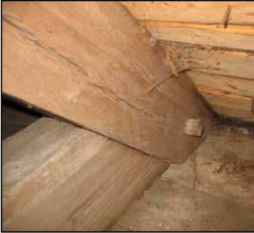
Möte mellan högben och bindbjälke.
