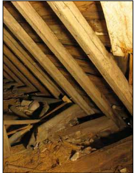
Möte mellan bindbjälkar och högben på södra sidan.
