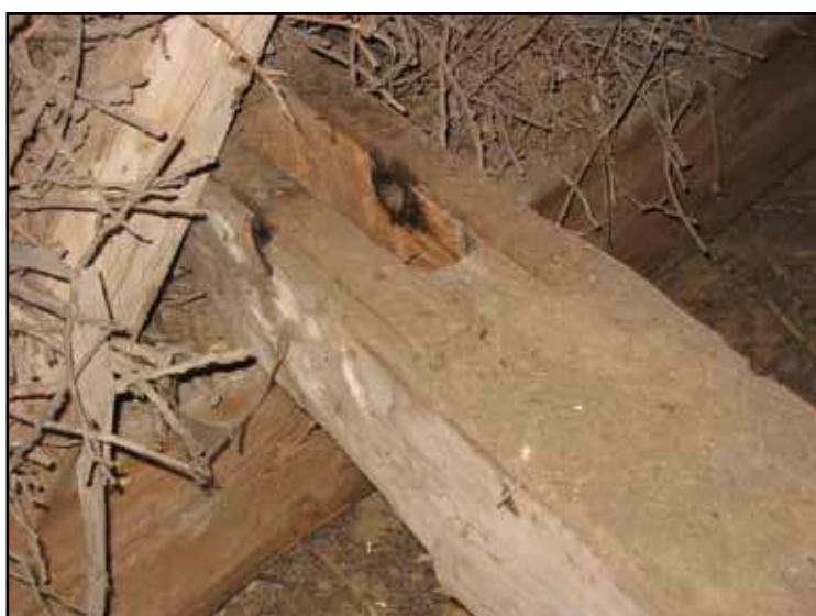
TVå konstruktionsdetaljer invid gavelröset mot koret som kan tolkas som klockupphängningar. Nedan frottage av sprättäljning.
