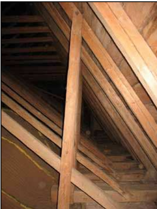
Knäbockar på norra sidan, sedda från öster.
