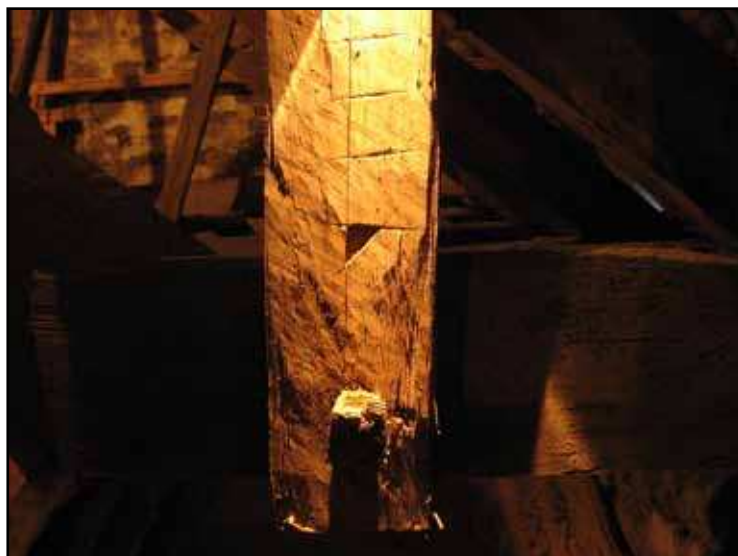
Timmermärkning på det norra stödbenet i takstol nr. 7.
