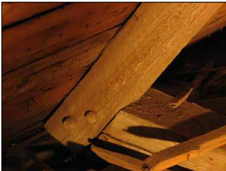
Möte mellan högben och bindbjälke med fint arbetade dymlingar.
