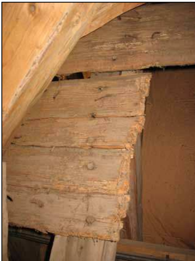
Taktrobräddor sedda från nykyrkans vind.
