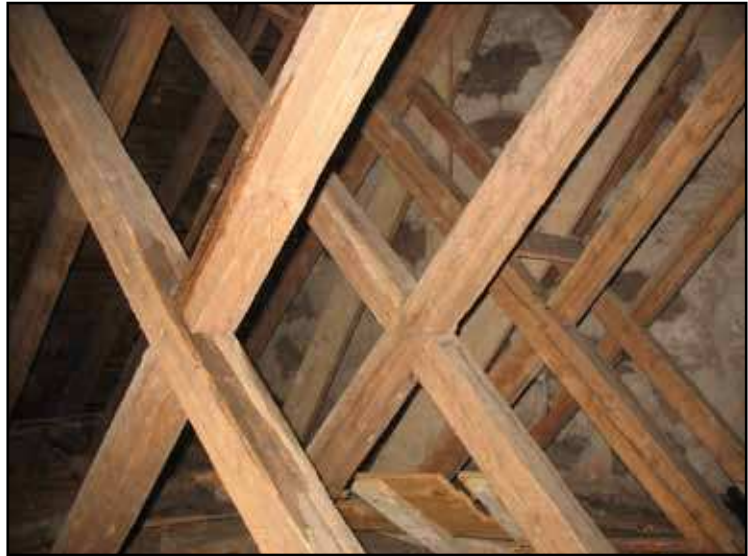
Korets taklag med korsande sparrar, sett från nordost.
