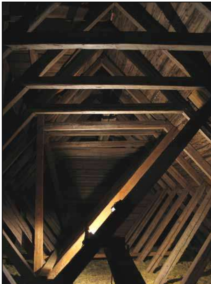
Taklaget över långhusets östra del och koret är av romansk typ med sprättäljda ytor. De diagonala strävorna är uppsatta i samband med tillkomsten av nykyrkan.
