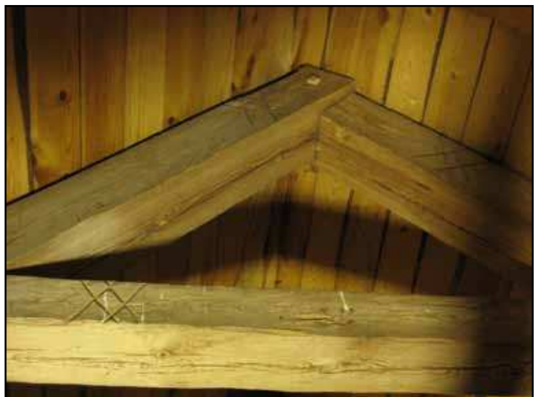
Två exempel på takstolarnas timmermärkning.
