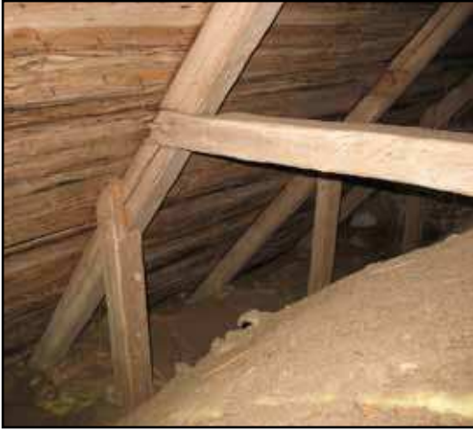
Knäbockskonstruktion.
