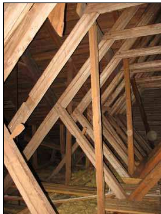
Till vänster övergången mot nykyrkans vind på norra sidan.
