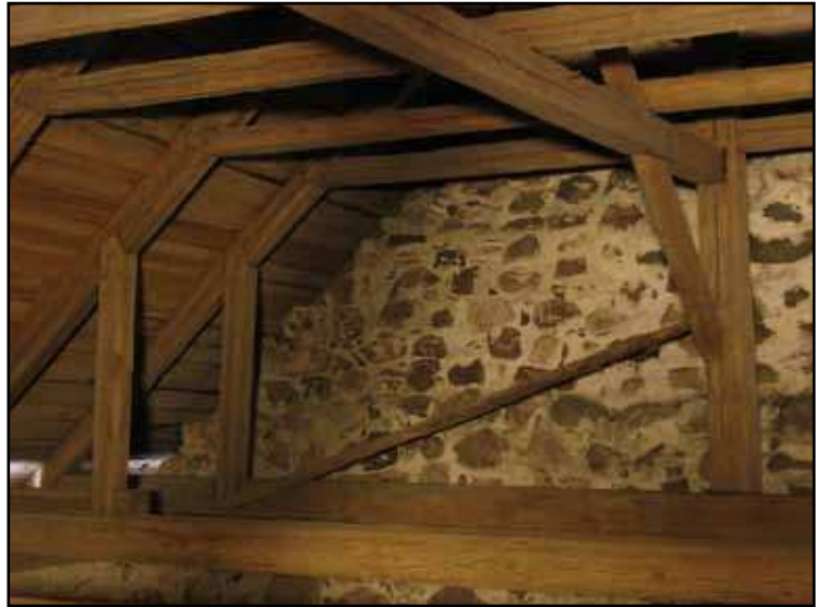
Nordvästra delen av taklaget över västra korsarmen. Till höger i bild den västra kungstolpen.
