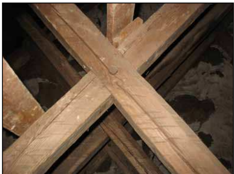
Sprättäljning och bladning med dymling på sparrar.
