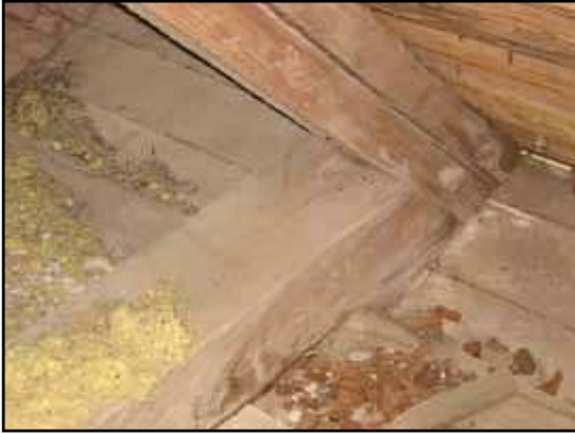
Möte mellan bindbjälke och högben.
