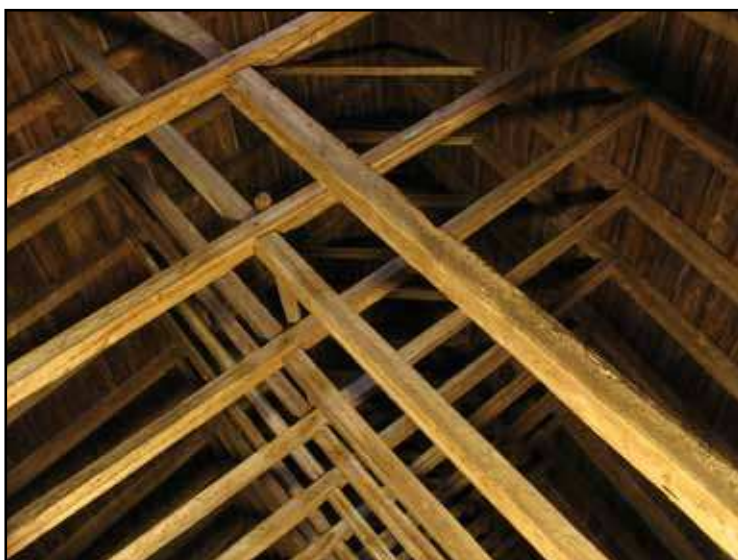
Taklaget sett nedifrån från väster.
