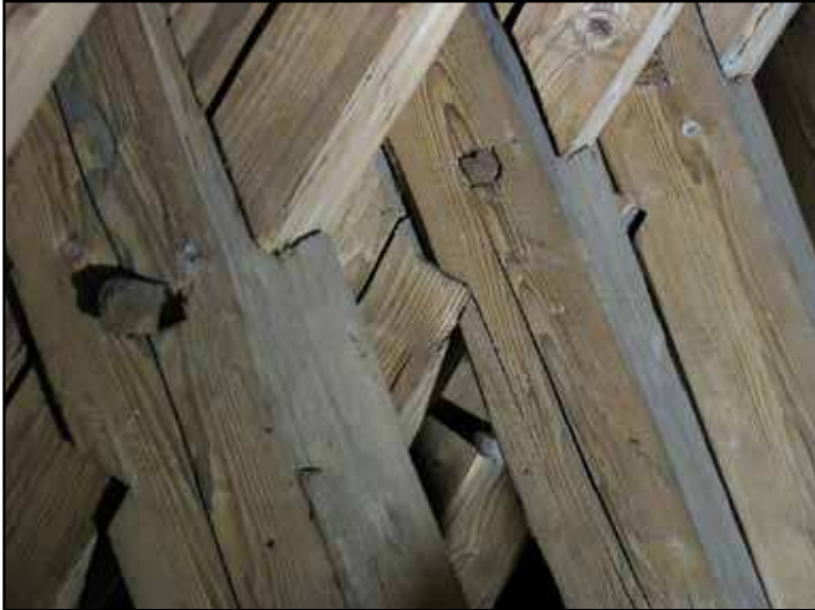
Bladning med nacke i Vireda kyrka, hopfogning mellan högben och stödben.
