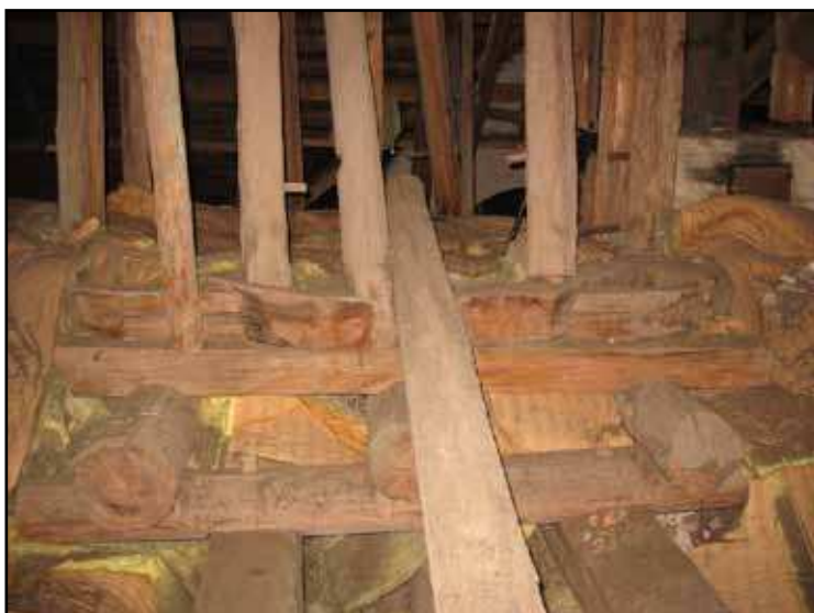
Konstruktionen till den utvändigt nedtagna takryttaren.
