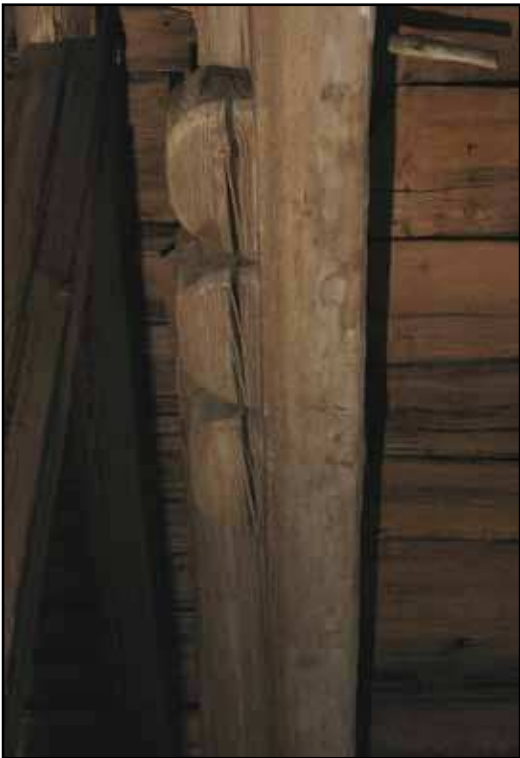
Högbenens sick-sackformade hopfogning. Den utsparade listens avbrott till höger därom vittnar om att där suttit en vertikal bräda som avslutning på gaveln.
