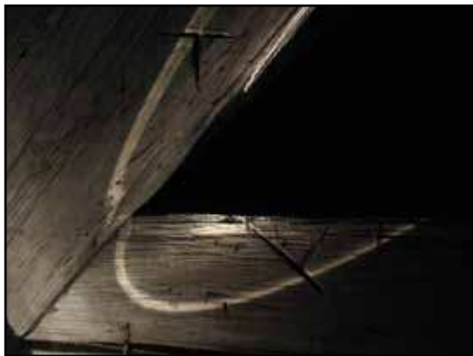
Timmermärkning på den första av de gotiska takstolarna med "T".
