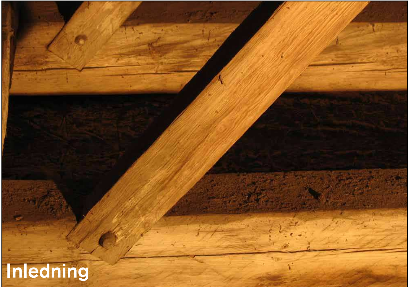
Detalj från Norra Solberga gamla kyrka. Hopfogning mellan stödben och bindbjälkar på långhusvinden.
