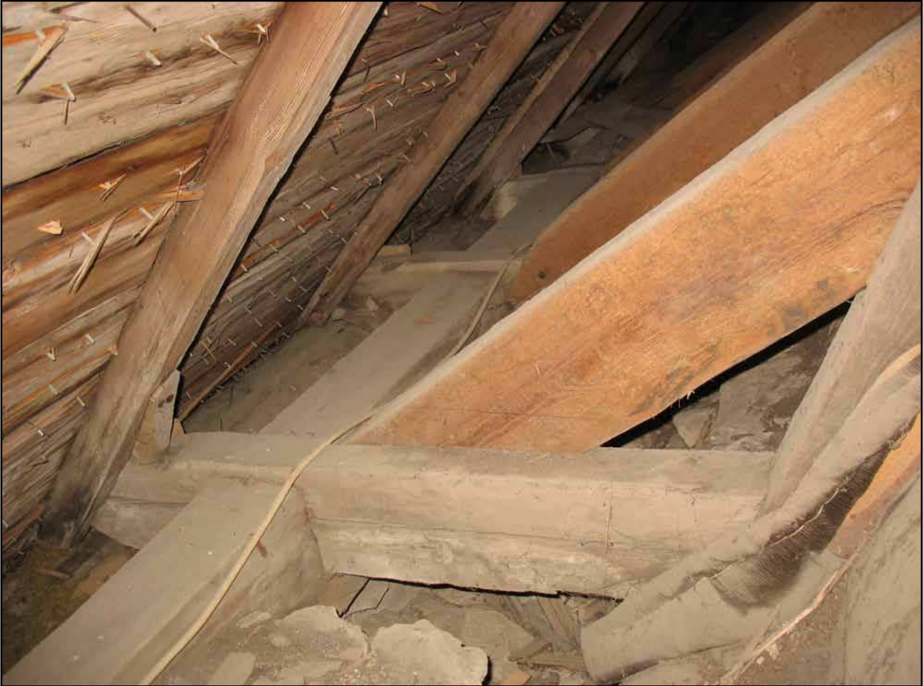
Möte mellan ursprungliga romanska remstycket, bindbjälkar (kapade för valv) och högben. Sammanfogningen mellan bindbjälkar och högben är här på norra sidan genomgående omgjorda i samband med valvslagningen, med ett undantag.
