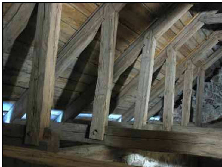
Knäbockar på södra sidan.
