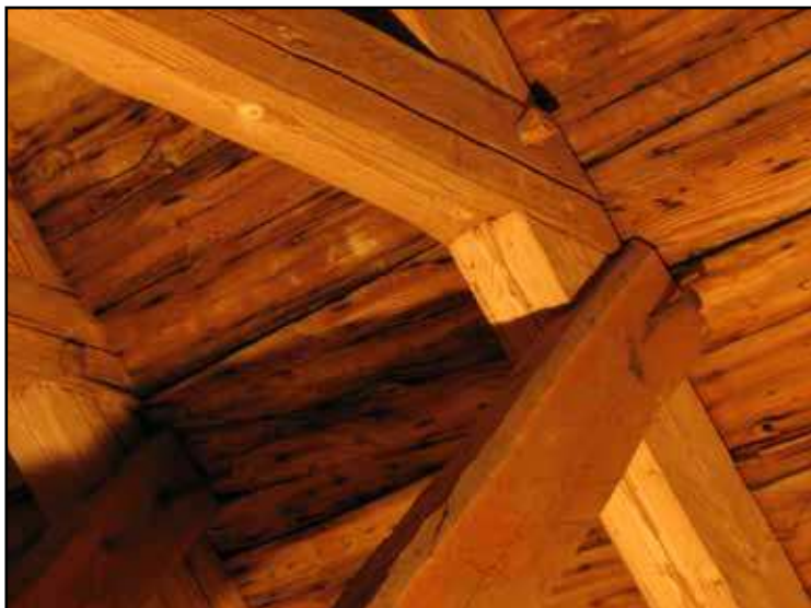
Hopfogning högben och hanbjälke.
