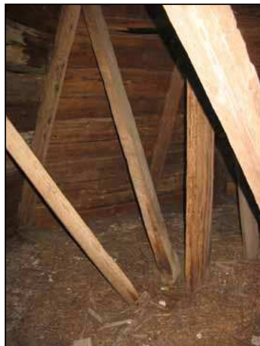
Mittstolpe och stödben på absidvinden.
