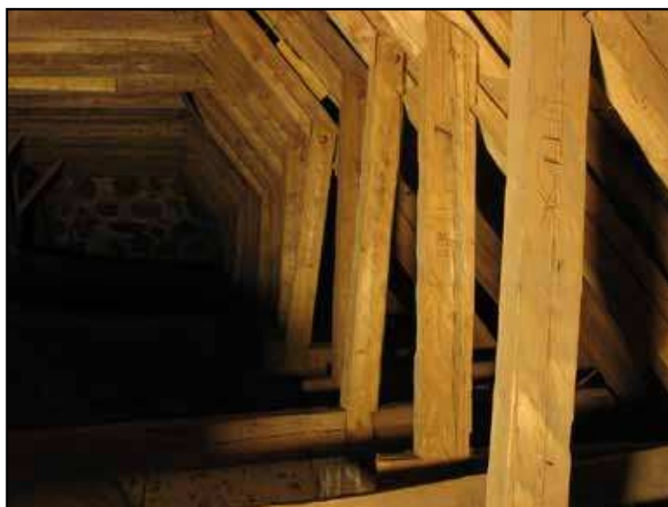
Knäbockar på taklagets södra sida. Alla bladningar är utförda med nacke och alla delar är noggrant märkta.
