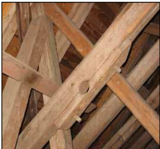
Spår efter infästning av en axel. Var syftet en klockringningsanordning eller ett spel för uppföring?
