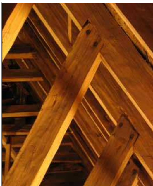
Sammanfogning mellan högben och stödben på långhusvinden. Även stödbenen är bearbetade med skave.
