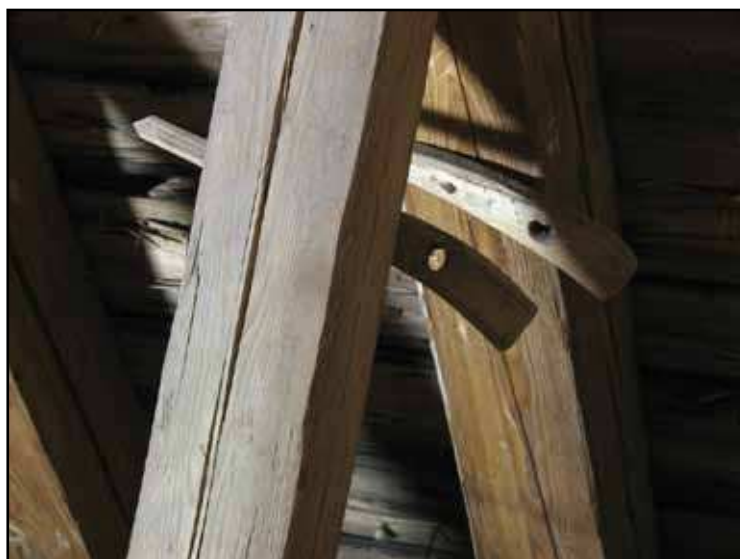
Spår av klockupphängning (?) på takstol invid korgaveln.
