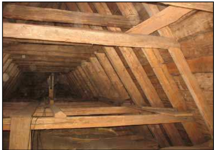
Långhusets takstolar är anpassade för 1700-talsvalvet.
