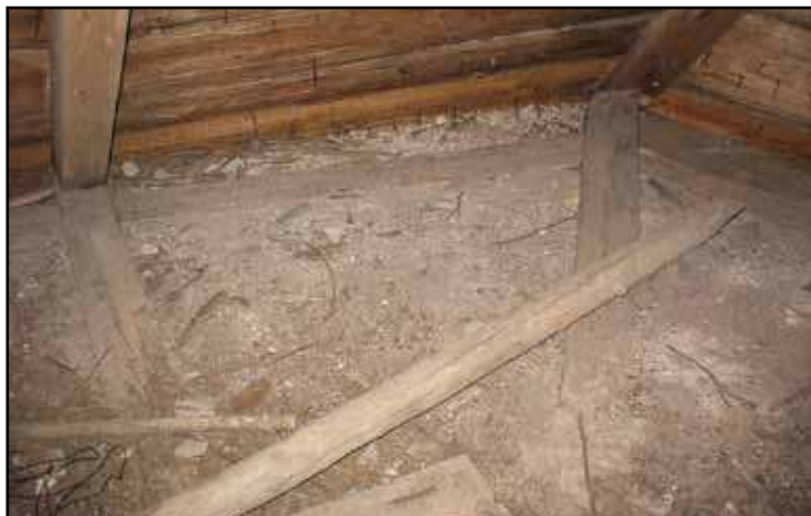
Remstycke och bindbjälkar inmurade i absidmuren.
