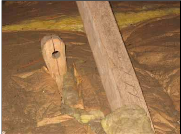
Rest efter klockupphängning (?) på bindbjälken till takstol nr 16.
