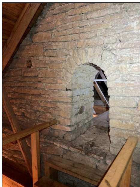
Fig 22. Kaga kyrka, vinden ovan koret, långhusets östra gavelröste med rundbågig öppning mot långhuset.
