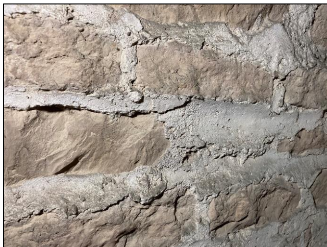
Fig 57–58. Tornets våning 2, yngre murverk med utstrukna fogar, resp ljuslugg mot S, med ovanliggande remstycke, sprättäljning (Dp18041, ej daterad).
