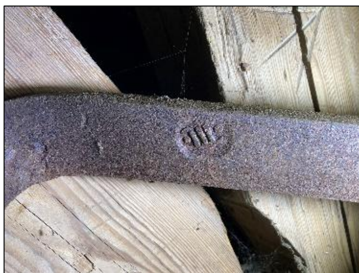
Fig 67. Järnstag med stämpel från tornspirans konstruktion. Foto Mattias Hallgren.
