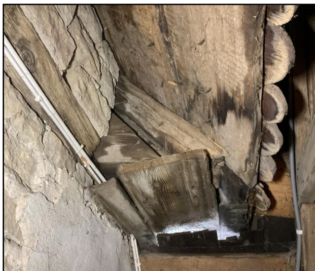
Fig 27–28. Kaga kyrka, bevarad äldre takfotsbräda, bevarad på vapenhusets vind, samt orneringen. Foto Mattias Hallgren.
