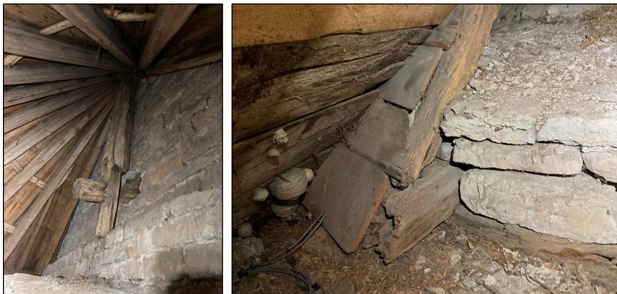
Fig 20. Kaga kyrka, taklaget ovan absiden, kungsstolpe monterad på korets östra gavelröste, samt gradsparrar.
