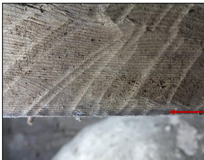
Fig 39. Långhusets takstol, urtag för klockor i bindbjälkarna, takstol 8–9, resp knut i bindbjälke.
