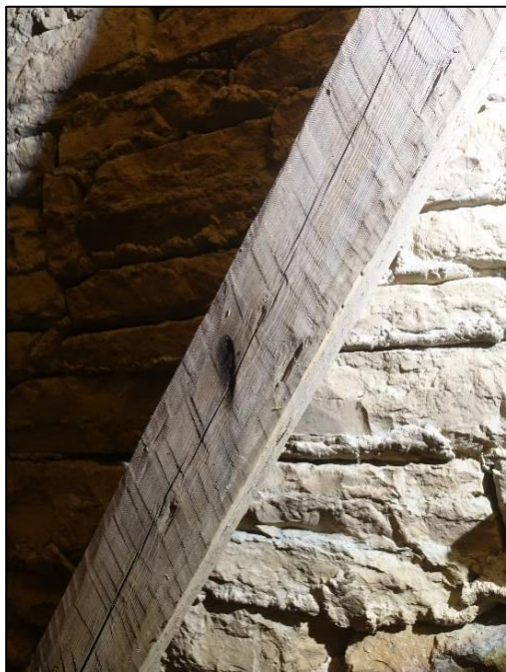
Fig 38. långhusets takstol, spår av skyddsbränning. Foto Mattias Hallgren.
