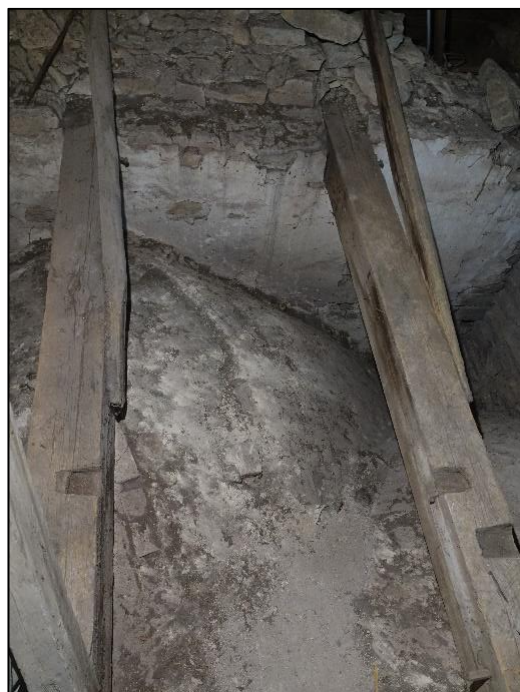
Fig 39. Långhusets takstol, urtag för klockor i bindbjälkarna, takstol 8–9, resp knut i bindbjälke.
