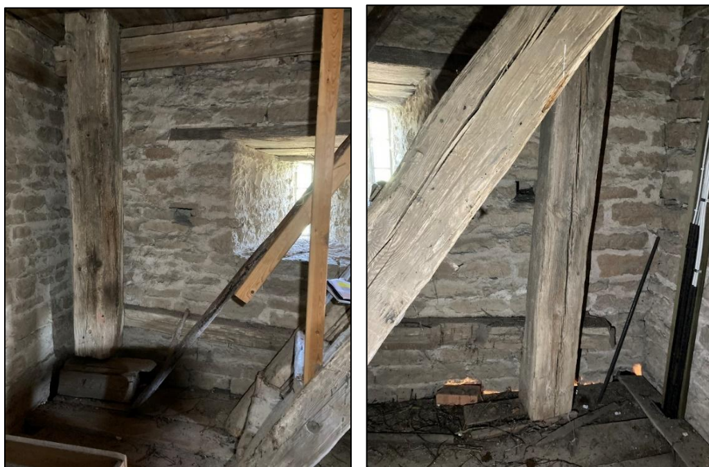
Fig 61–62. Tornets våning 3, NV resp NÖ hängdockan tillhörande klockbocken samt spår av byggnadsställning.
