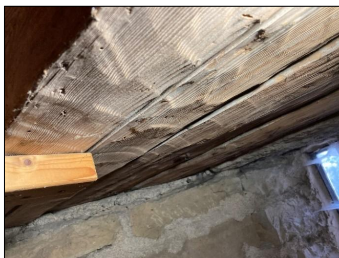
Fig 57–58. Tornets våning 2, yngre murverk med utstrukna fogar, resp ljuslugg mot S, med ovanliggande remstycke, sprättäljning (Dp18041, ej daterad).
