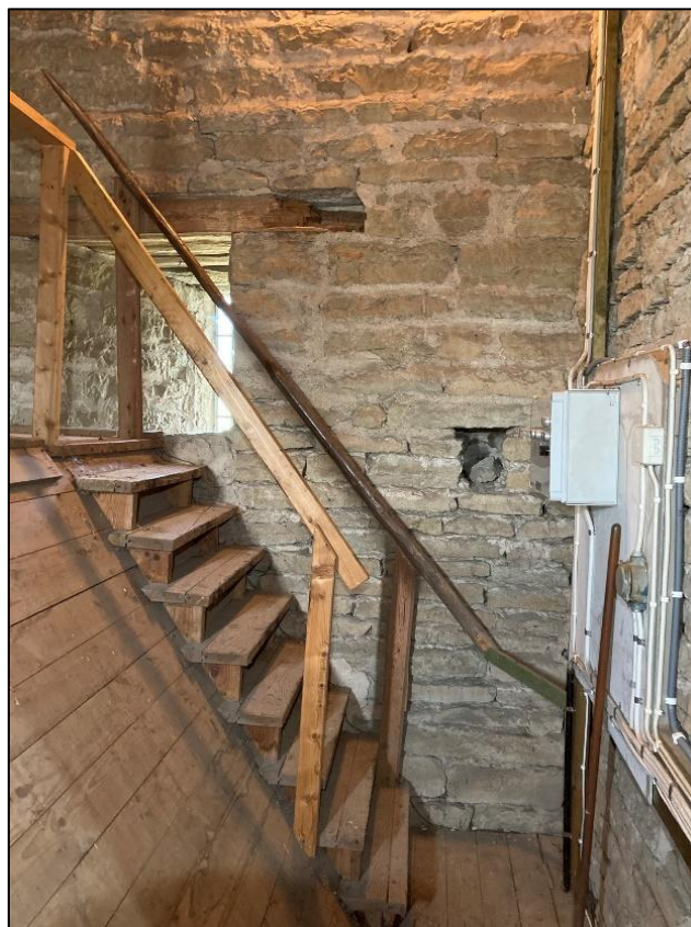
Fig 55. Tornets våning 2, ljuslugg mot S, med ovanliggande remstycke (Dp18041, ej daterat).
