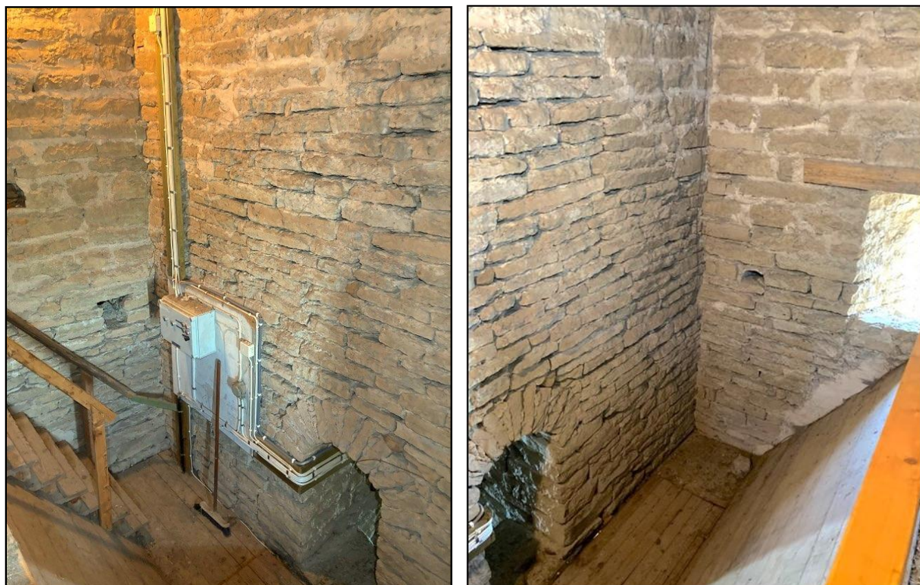
Fig 53–54. Kaga kyrka, tornets våning 1, övre delen, långhusets västvägg samt tornets norra resp södra murar. Nedre delen av tornmurarna ligger i förband med gavelröset, övre delarna murverk med större stenmaterial tillhörande etapp 2.
