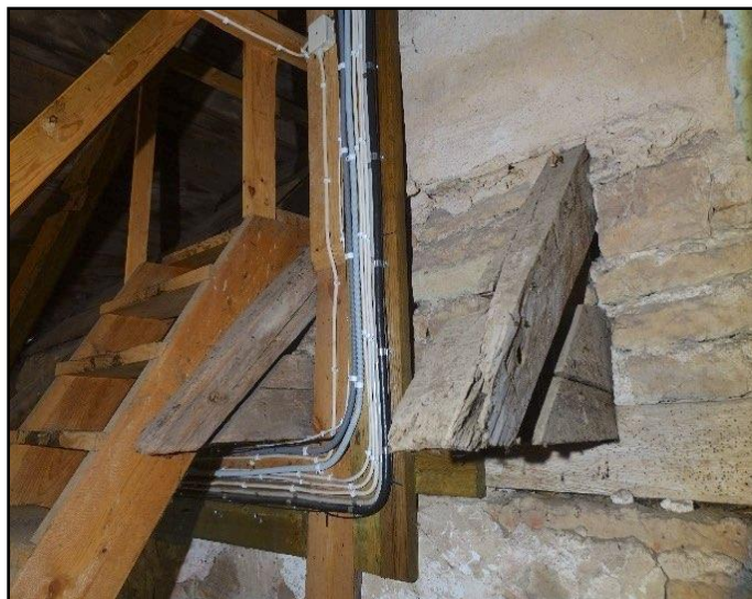
Fig 25–26. Korets utsida från norr, under murkrönet finns ett inmurat hammarband, i vilket högben och bindbjälkar är fästade, respektive närbild på halvt i halvt-knuten mellan bindbjälke och högben.
