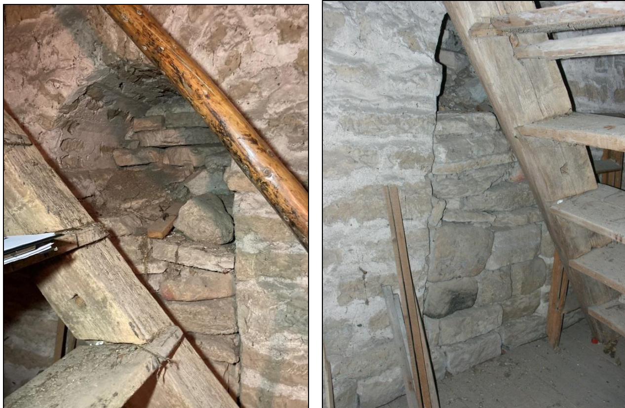
Fig 59–60. Tornets våning 2, större rundbågig öppning mot väster, sekundärt igenmurad. I rundbågen finns avtryck från sprätthuggna valvbrädor.
