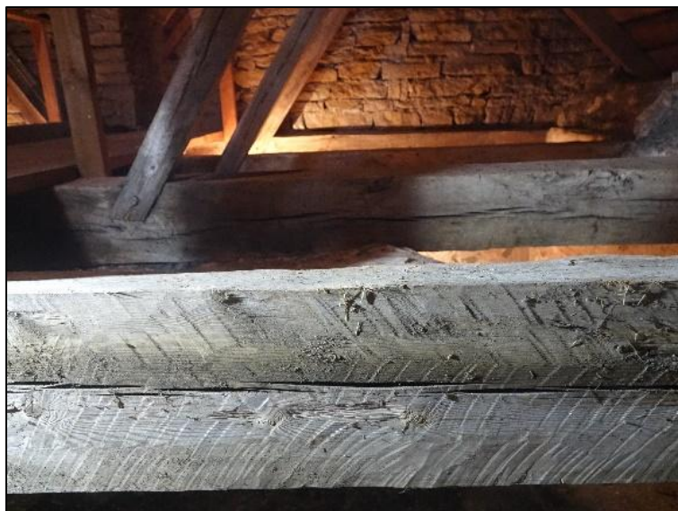
Fig 31. Långhusets bindbjälke med tydliga spår av sprätthuggning. Foto Mattias Hallgren.
