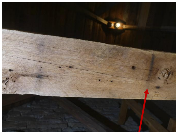
Fig 33–34. Koret, bindbjälke, undersida med smutsspår och spikrester som visar på förekomst av tidigare innertak. Foto Mattias Hallgren.
