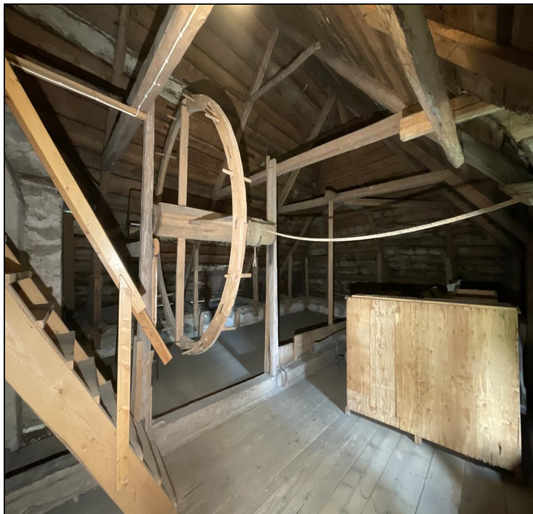
Fig 6. Kaga kyrka, vinden ovan sakristian med bevarat gångspel. Foto Mattias Hallgren.
