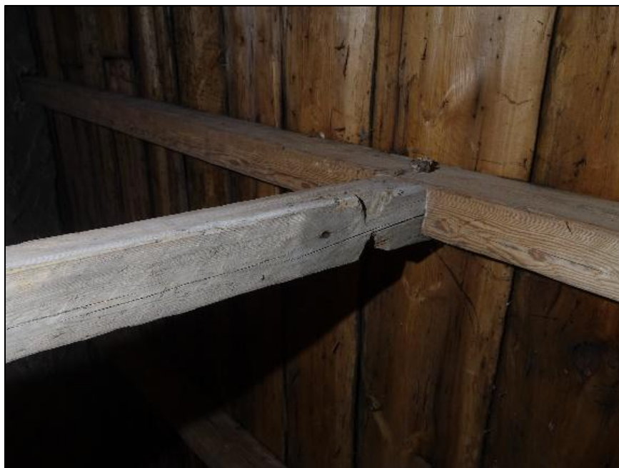
Fig 37, Långhusets takstol, stötta med jack för uppdragning av stocken. Foto Mattias Hallgren.
