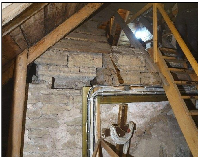
Fig 25–26. Korets utsida från norr, under murkrönet finns ett inmurat hammarband, i vilket högben och bindbjälkar är fästade, respektive närbild på halvt i halvt-knuten mellan bindbjälke och högben.
