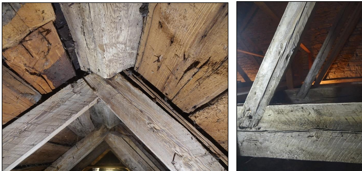
Fig 29–30. Långhusets taklag,nocken består av högbenen fogade halvt i halvt och därovan en ridande nockstyrbjälke som är ursprunglig med taklaget, respektive snedstöttor i långhuset infästa i bindbjälkarna med halvt i halvt-knut. Foto Mattias Hallgren.
