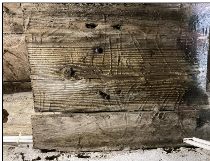
Fig 27–28. Kaga kyrka, bevarad äldre takfotsbräda, bevarad på vapenhusets vind, samt orneringen. Foto Mattias Hallgren.
