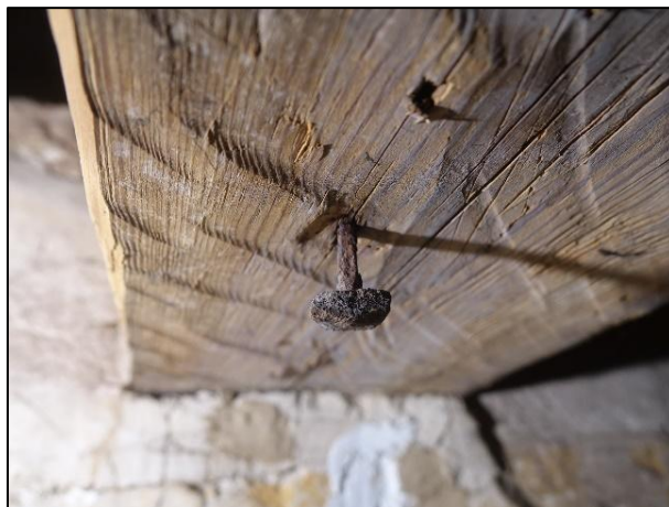
Fig 33–34. Koret, bindbjälke, undersida med smutsspår och spikrester som visar på förekomst av tidigare innertak. Foto Mattias Hallgren.
