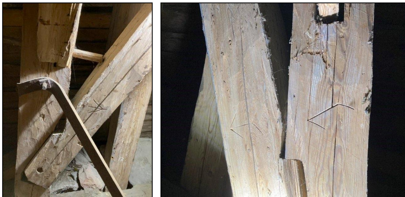
Fig 65–66. Tornspirans bockkonstruktion med timmermansmärkning. Foto Mattias Hallgren.
