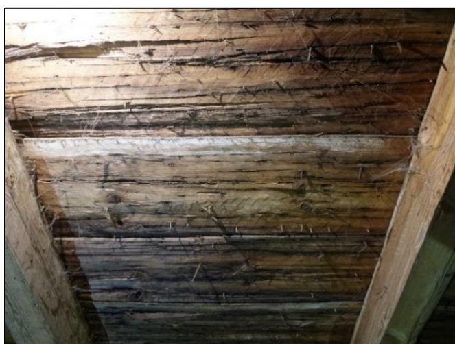
Fig 32. Långhuset, taktrobrädor, sprätthuggna och troligen samtida med taklaget. Om de är utbytta bör de vara som yngst från första halvan av 1300-talet, dvs före Digerdöden. Foto Mattias Hallgren.
