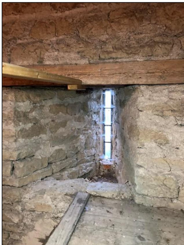
Fig 55. Tornets våning 2, ljuslugg mot S, med ovanliggande remstycke (Dp18041, ej daterat).
