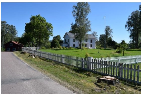
Den f.d. prästgården påbyggdes med en andra våning 1885. Här fanns tidigare en länsmsgård.
