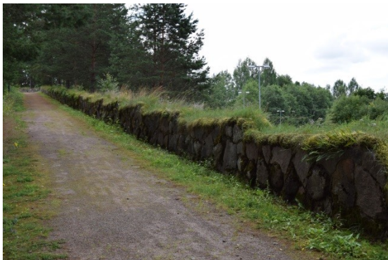
Väg i anslutning till nordvästra entrén. Muren är byggd i avsatser.
