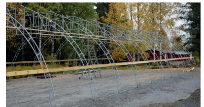
Arbetet med växthuset intill Lunds kyrkogård har påbörjats i höst. Monteringen av stommen är klar och resten ska färdigställas under våren 2022. Växthuset ska användas för plantuppdragning, som mottagningsväxthus och för plantering.
