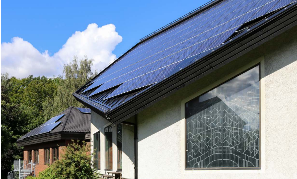
Vargöns kyrka i Västra Tunhems pastorat tar kraft från ovan. Sedan tre år tillbaka får de sin el och värme från solpaneler på taket.
