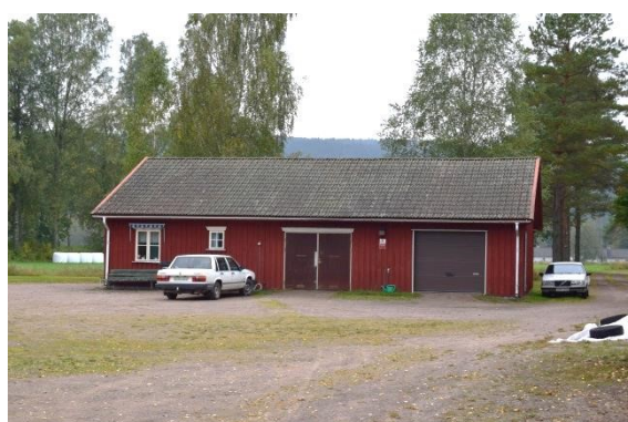
Personalbyggnaden med garage uppfördes 1986.
