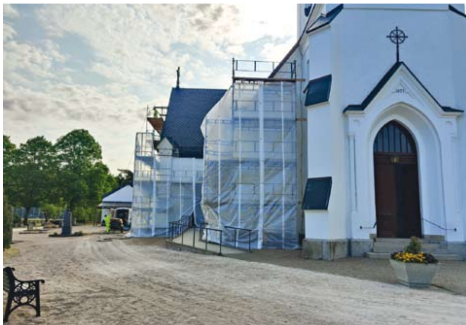
Renovering av kyrkans fasad pågår!
