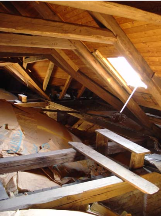
43. Valven är isolerade med mineralull. På långhusvinden finns flera takfönster.
