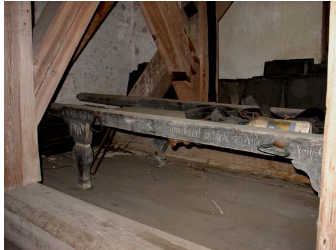
46. Klockbocken är byggd av kraftiga furubjälkar. En bår från första hälften av 1800-talet förvaras i rummet.
