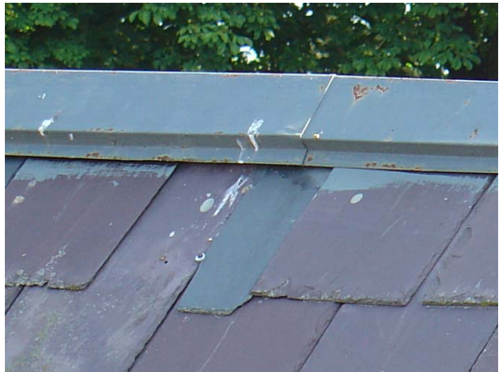
82. På några ställen saknas skifferplattor. Flera plattor har fästs med s k farmarskruv istället för att spikas.
