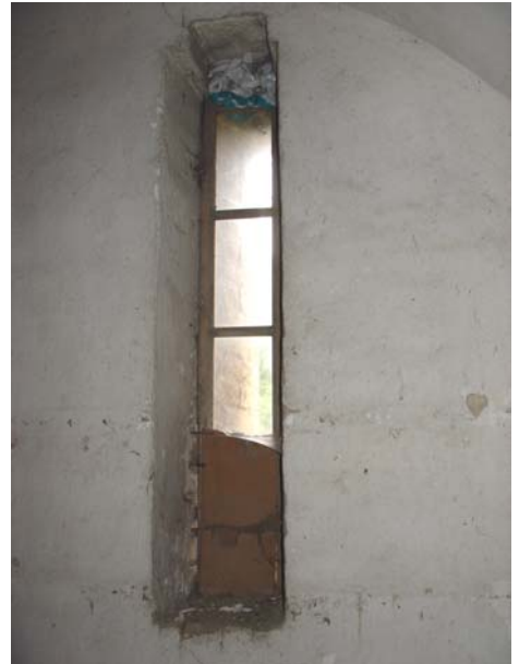
94. Tornrummets fönster mot norr är provisoriskt lagat med plastpåse och masonit.
