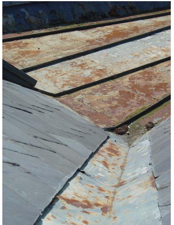
84. Ränndalar och vinkelrännor är i mycket dåligt skick p g a bristande underhåll.
