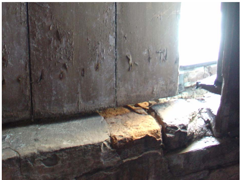
96. Vid ljudluckorna i klockrummet spjälkar teglet. Ljudluckorna är i behov av målning.
