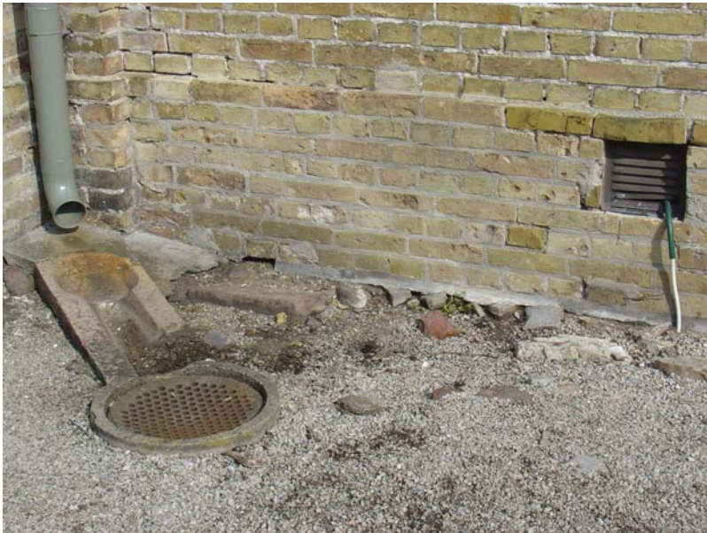
49. Stuprören kastar ut vattnet i en rännsten som leder det vidare till en brunn med galler. T h syns ett ventilationsgaller med starkströmskabel vilket är en förbjuden förläggning, dessutom saknas skyddskåpa.
