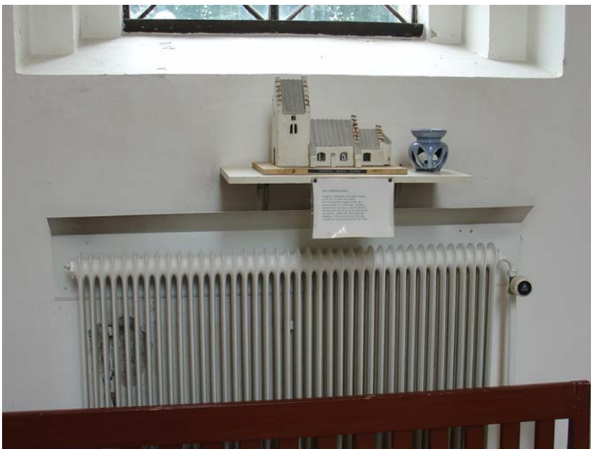
51. Radiator för vattenburen värme (bild från vapenhuset). Lagg märke till den bockade plåten i överkanten som ska hindra svärtning på väggen.
