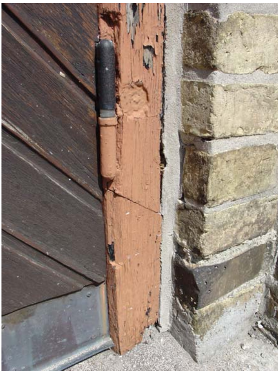
77. Karmen är rötskadad och har en äldre lusning.
