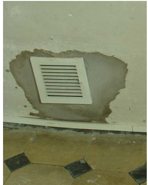
50. Invändigt är ventilerna utformade på ett mindre lämpligt sätt.
