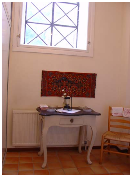
24. På väggen mot N finns den undre delen av ett spetsbågigt gjutjärnsfönster.
