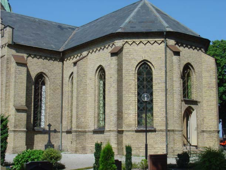
11. Anslutning mellan S sidoskeppet och kor med tresidig avslutning i öster.
