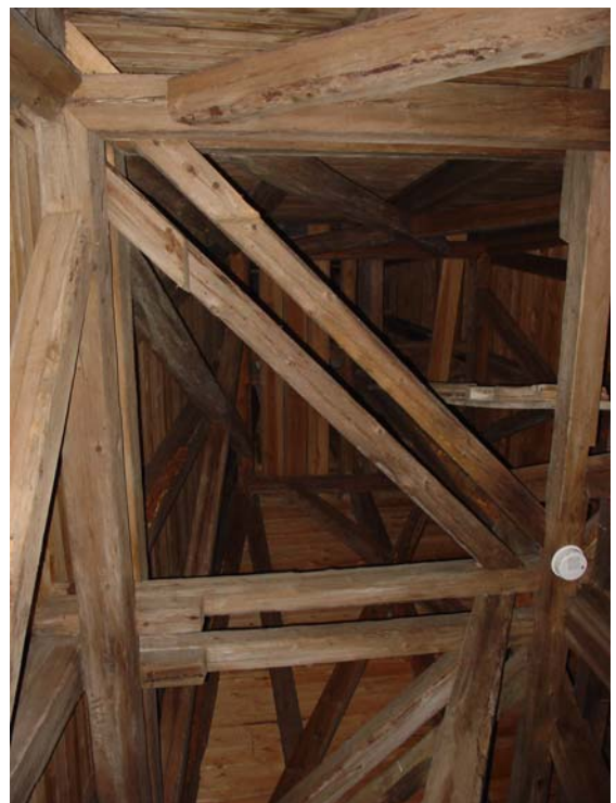
48. Vy upp i tornhuvens träkonstruktion.
