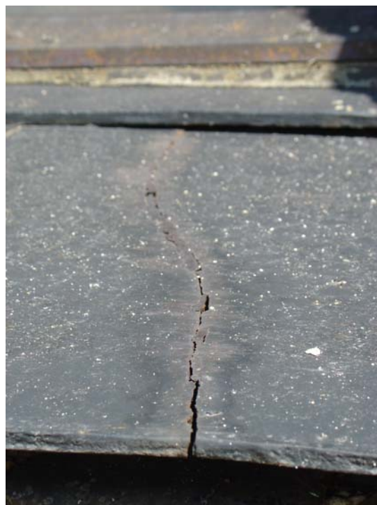
80. Liksom när det gäller fönstren är solbänkarna illa åtgångna av rost. Solbänken på bilden är dessutom spräckt.
