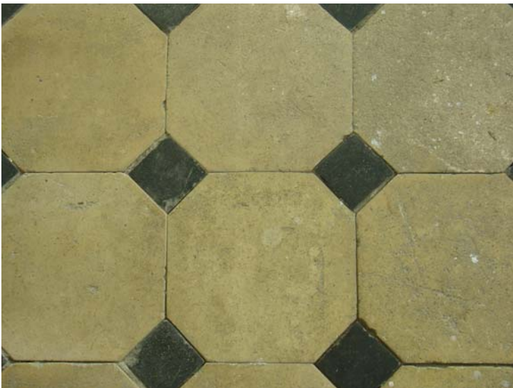
91. Cementmosaikplattor i koret. T h med blåstrad, skrovlig yta, t v glaserad yta.
