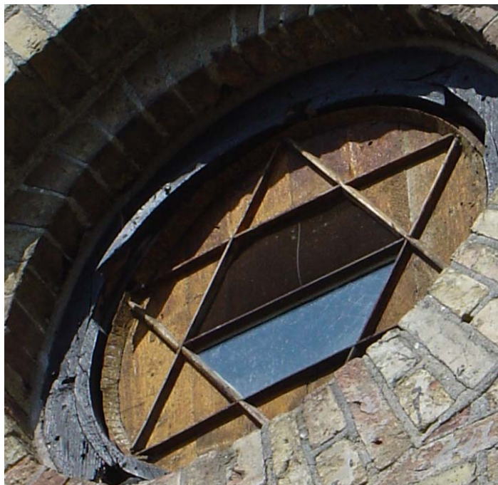
78. På karmen kring sidoskeppens fönster på gavelspetsarna har delar ramlat bort.
