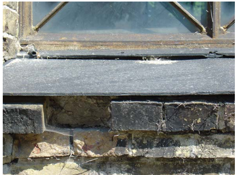
76. På sina ställen har hela fasadstenar lossnat.
