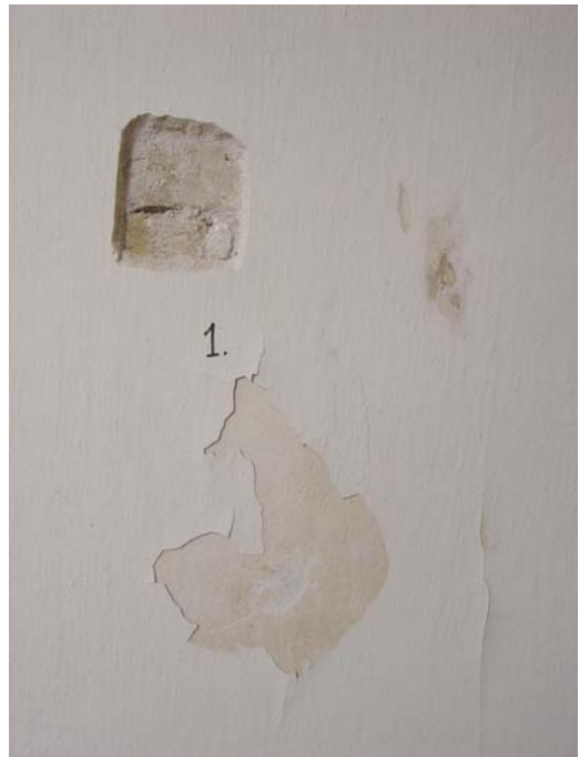
88. Färgflagnig och hål efter färgprovtagning i valvbågen mellan vapenhus och kyrkorum.
