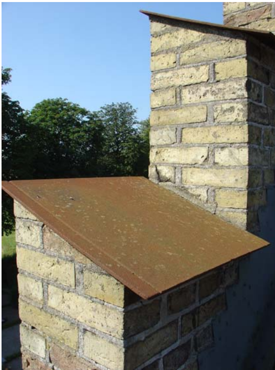
81. Trappgavlarnas plåtavtäckningar rostar kraftigt.
