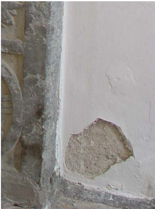
87. Ett av flera putsbortfall, troligen orsakat av saltsprängning. Bild från vapenhuset.
