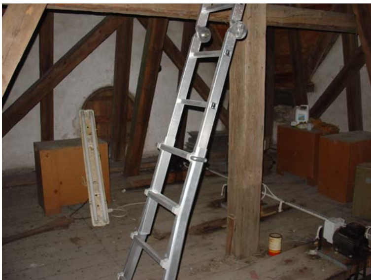
47. Vindsbjälklaget i tornet. T h syns en motor för klockringning. I fonden syns den på insidan vitputsade torngaveln med en rund trälucka.
