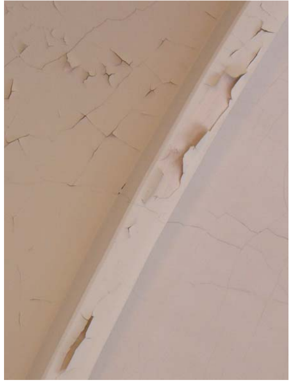
90. Kraftig färgflagning i ett valv i N sidoskeppet.
