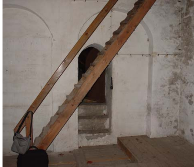
42. I rummets Ö del finns en öppning till vindarna över kyrkorummet och en trappa till klockrummet.
