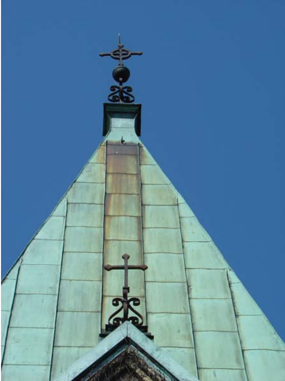
3. Tornhuven är belagd med kopparplåt som missfärgas av smidesspiorna.
