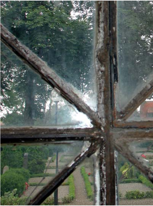
85. Samtliga gjutjärnsfönster är rostangripna och kittet lossnar. Bild från vapenhuset.
