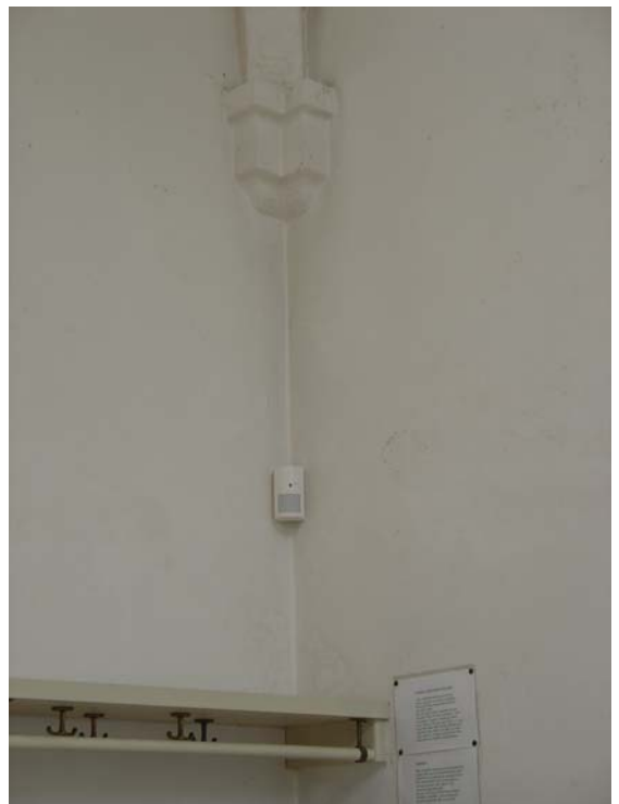
56. Rörelsevakt i vapenhuset.
