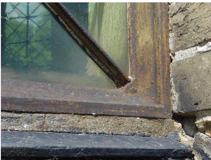
79. Samtliga gjutjärnsfönster är rostangripna och behöver ses över omgående.
