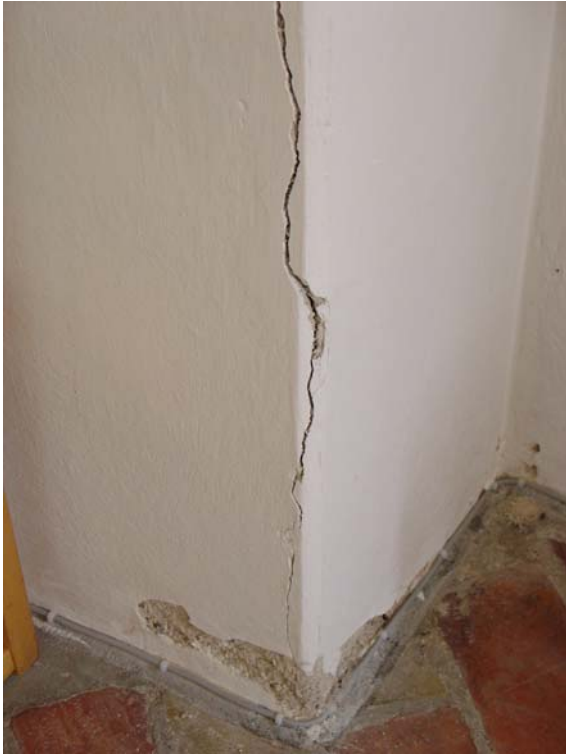
89. Kraftig spricka och putsbortfall vid ett hörn i S sidoskeppet.
