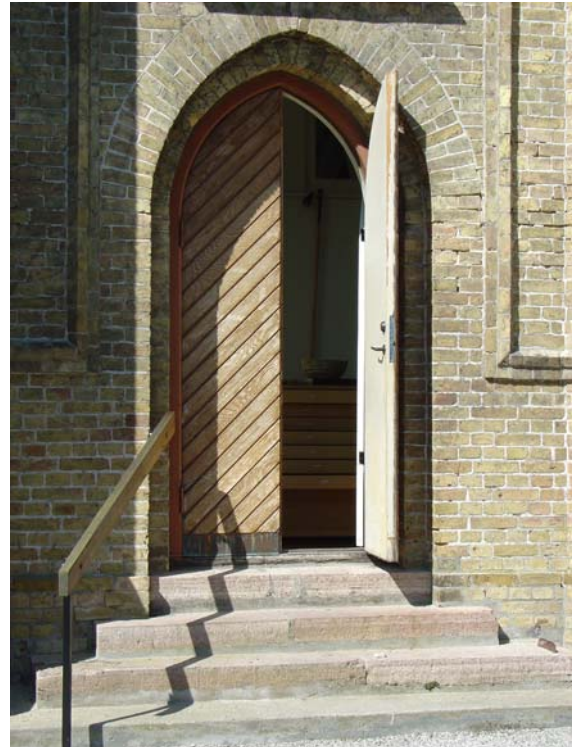
14. Även åt öster finns en port, försedd med en trappa av kalksten och betong.
