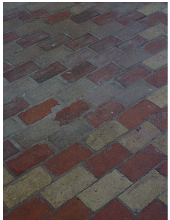
92. I långhusets mittgång är flera tegel (i bild vänstra övre hälften) missfärgade och med skadad yta.
