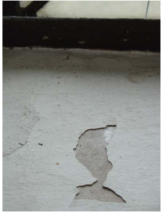
86. Färgen flagnar i fönsterbänken i vapenhuset.
