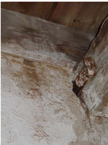
95. På västväggen syns ett rödbrunt pulver som bör undersökas för att utesluta hussvampsporor.
