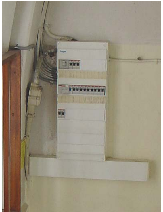
54. Längre upp i trappan finns ett proppskåp med automatsäkringar.
