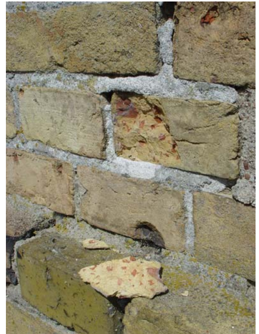
74. Teglet är av ojämn kvalitet och stora bitar spjälkar loss.
