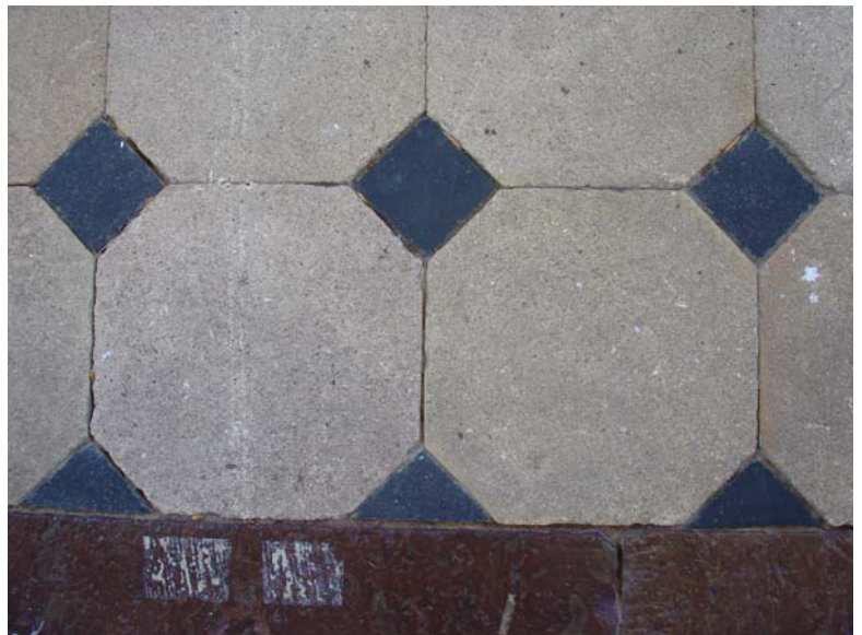
40. Korgolvet är belagt med gula och svarta cementmosaik-plattor. Längst ner i bild syns trappans röda kalksten.
