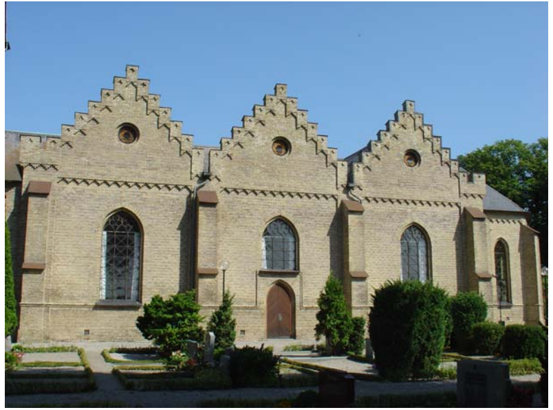
8. Sidoskeppen består av tre travéer, utåt markerade med strävpelare och trappgavlar.
