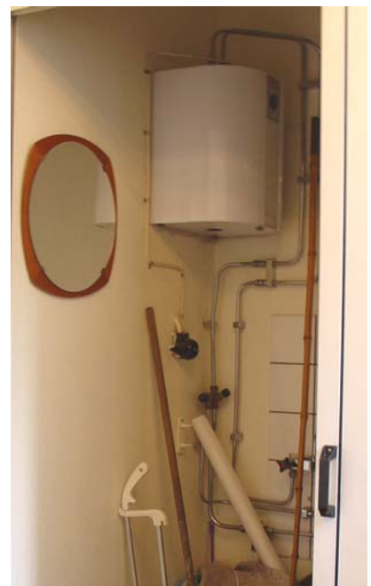
52. Varmvattenberedare i utrymme under läktaren.
