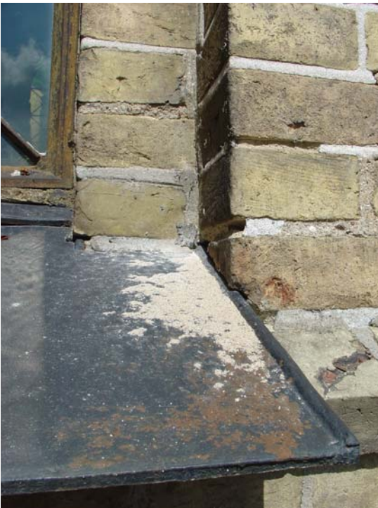
75. Murarbin gör sitt till att bryta ner fogarna. På solbänken ligger rester av fogbruk som de kratsat loss.
