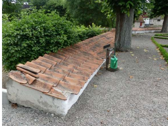
Södra delen av kyrkogårdsmuren och vattenkran.
