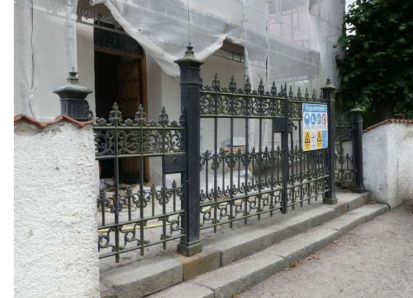
Huvudingång i väster med grind av gjutjärn, vid renoveringen sommaren 2018.
