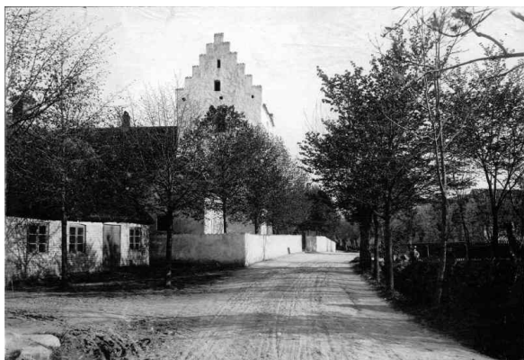
Foto mot söder. Innanför muren nordväst om kyrkan syns en byggnad. Kulturmiljöbild, Riksantikvarieämbetet.
