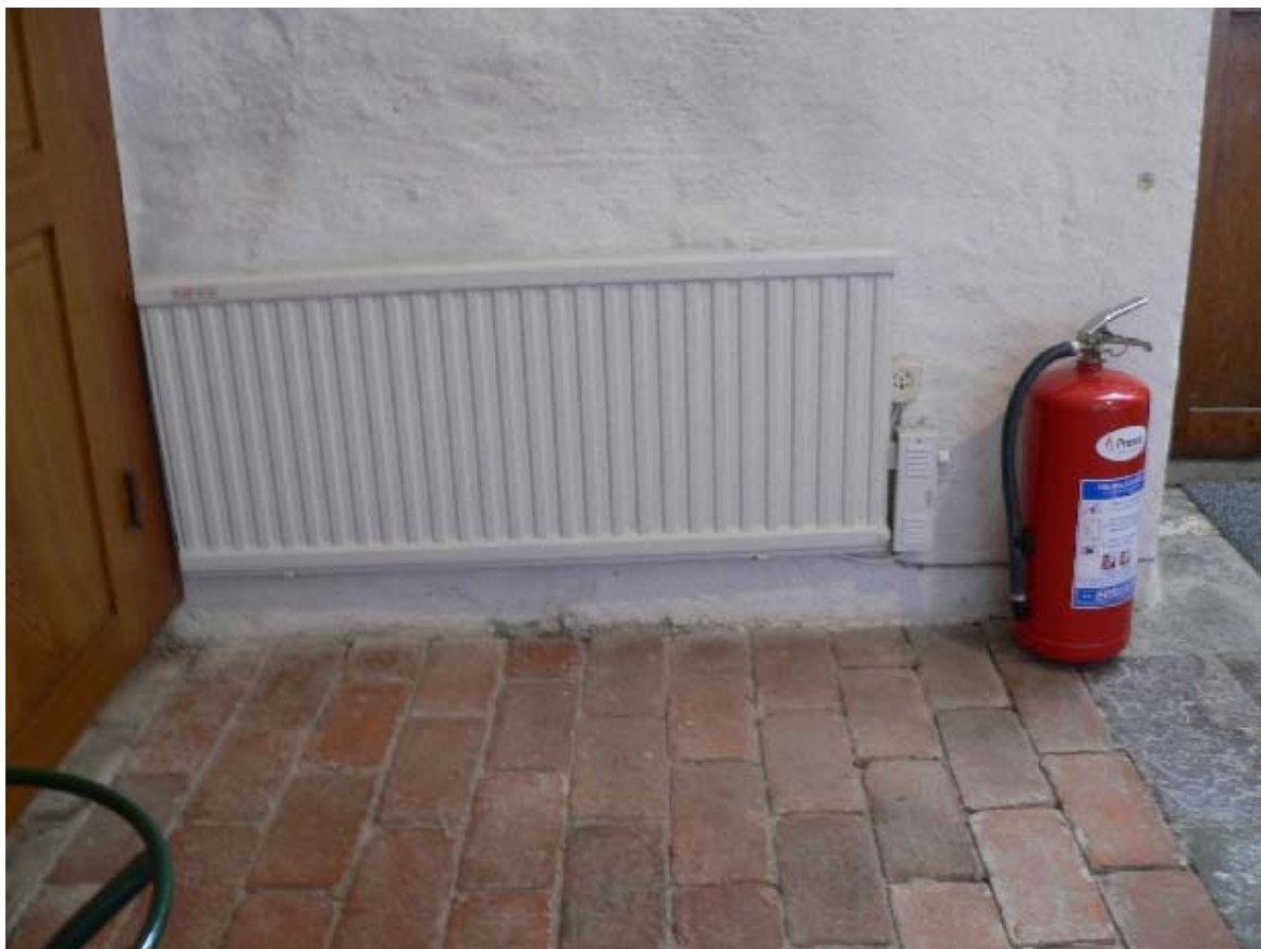
Radiator i vapenhuset.
