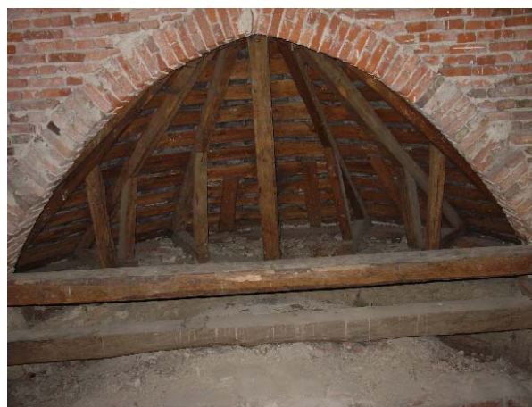
Spetsbågig öppning mellan kor och absidvind.
