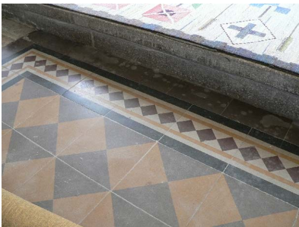
Golvet i långhuset är belagt med mönstrade cementmosaikplattor i flera färger.
