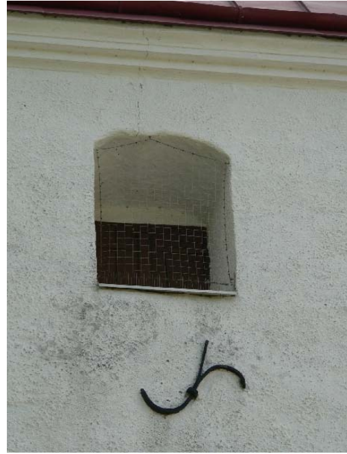
Ljudöppningarna, i tornets samtliga väderstreck, är stickbågiga.
