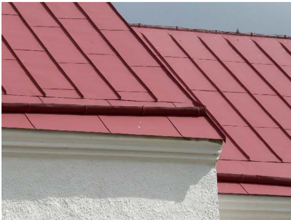
Takfallen på långhus, kor och torn är belagda med rödmålad plåt.
