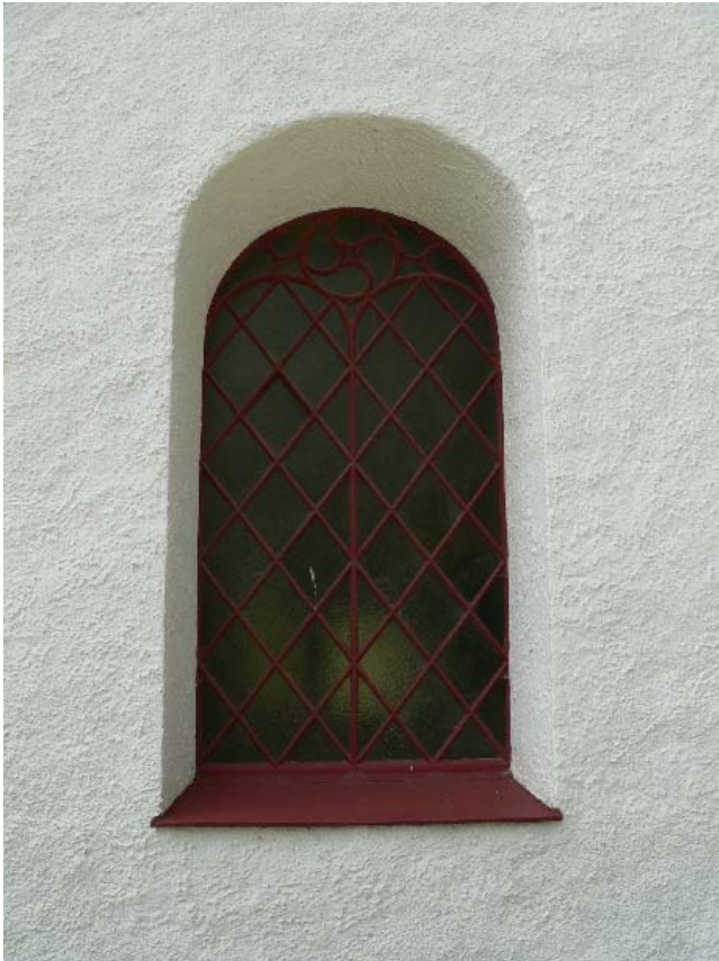
Kyrkan har rödmålade och spröjsade järnfönster.
