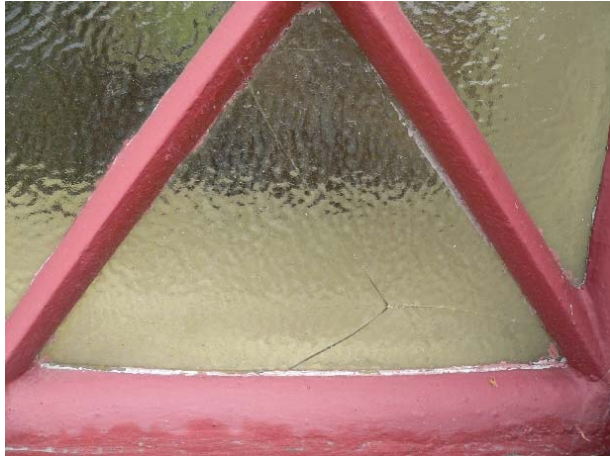
Spricka i glas på långhusets södra fasad.
