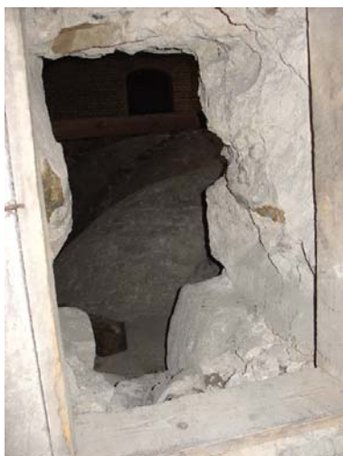
Ingången till vindarna från det 1:a tornrummet.
