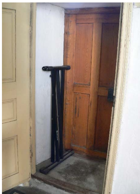
Vindfånget i absiden mot öster.
