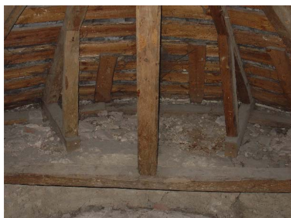
Absidens takstolar med en central mittstolpe vilande på en bindbjälke.
