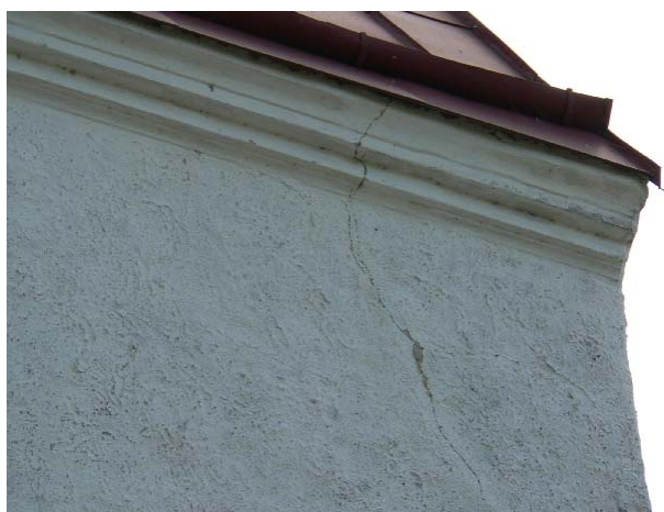
En av två sprickbildningar på tornets västra fasad.
