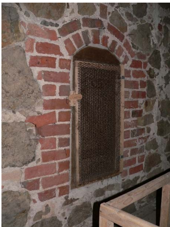
Tegel förekommer i murverket runt ljudöppningarna och i den södra gaveln.
