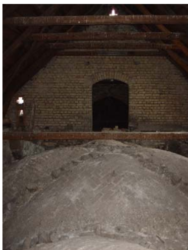
Vy över långhusvinden mot koret.
