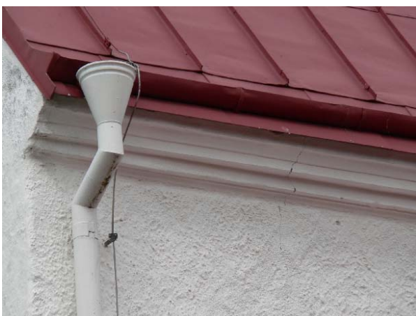
Kyrkan är försedd med fotrännor och stuprör av målad plåt.
