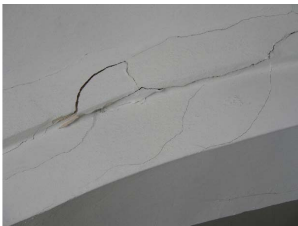
Sprickbildning med bebyggande materialbortfall i gördelbågen mellan 1:a och 2:a traven
