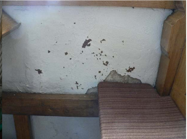
Färgflagnig och putsbortfall i den nedre delen av väggarna i långhuset.
