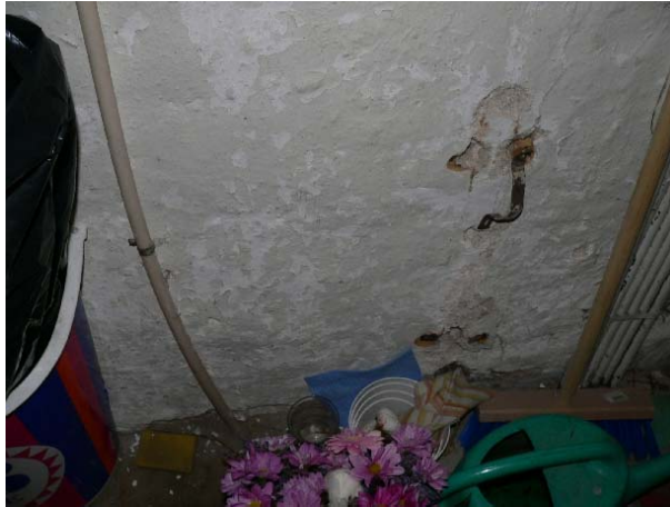
Färgflagnig av väggar i el-centralen i vapenhuset.
