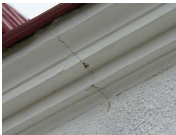
En spricka i takfoten på långhusets södra fasad.
