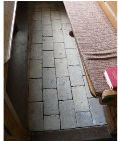
Golvet i bänkkvarteren är belagt med gult tegel.
