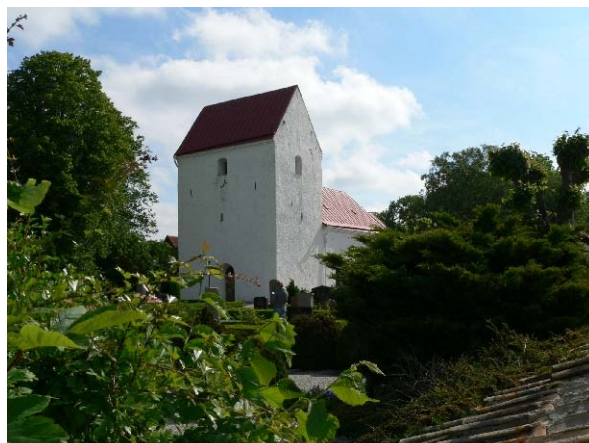
Kyrka är uppbyggd med ett kraftigt västtorn, långhus, kor och absid. Foto från sydväst.
