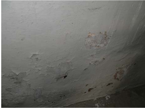
Saltsprängningar, bompartier, puttskador och färgflagning på väggar i absiden.
