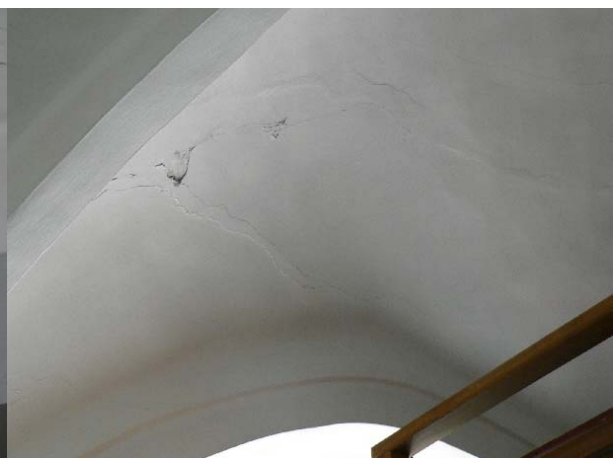
Färgflagnig och sprickbildningar i den västra traven.
