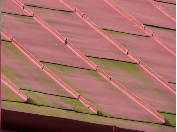
Algpåväxt förekommer på takfallen mot norr.
