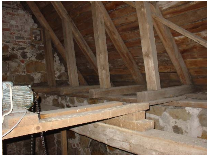
Torntakets takstolar vilar direkt på murupplaget.
