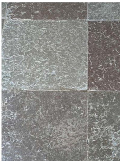
Golvet i vapenhusets mittgång är belagt med kalkstensplattor.
