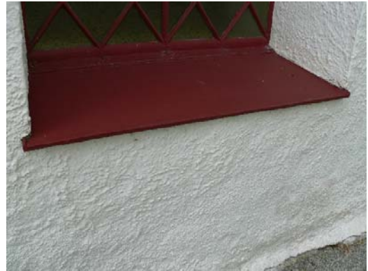
Solbänkarna är av rödmålad plåt.
