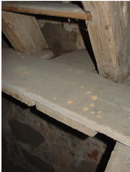
Borrmjöl efter angrepp av strimmig trägnagare på trappa mellan 1:a tornrummet och klockrummet.
