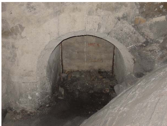
Ovan valven i långhuset finns en medeltida fönsteröppning bevarad med omfattning av kvaderhuggen sandsten. Norra väggen.
