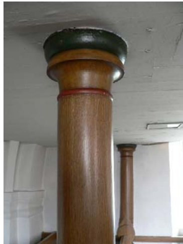
Orgelläktaren bärs upp av ett flertal kraftiga träkolonner.
