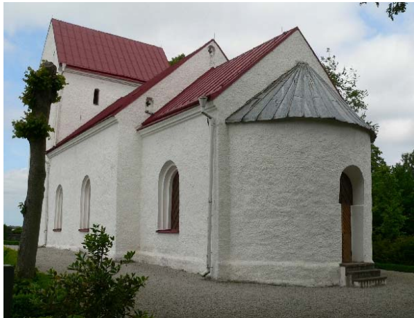
Kyrkans södra fasad sedd från öster.
