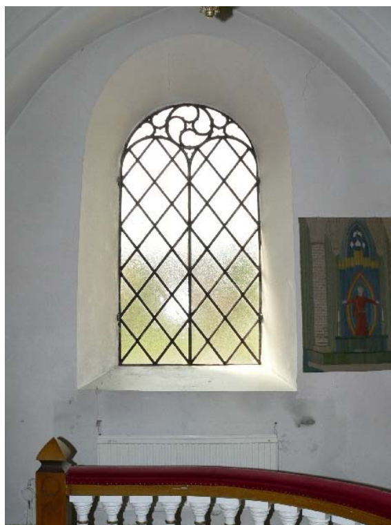
Fönster på korets södra sida.
