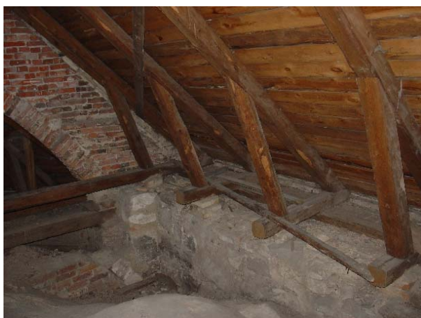
Takstolar på korets vind.
