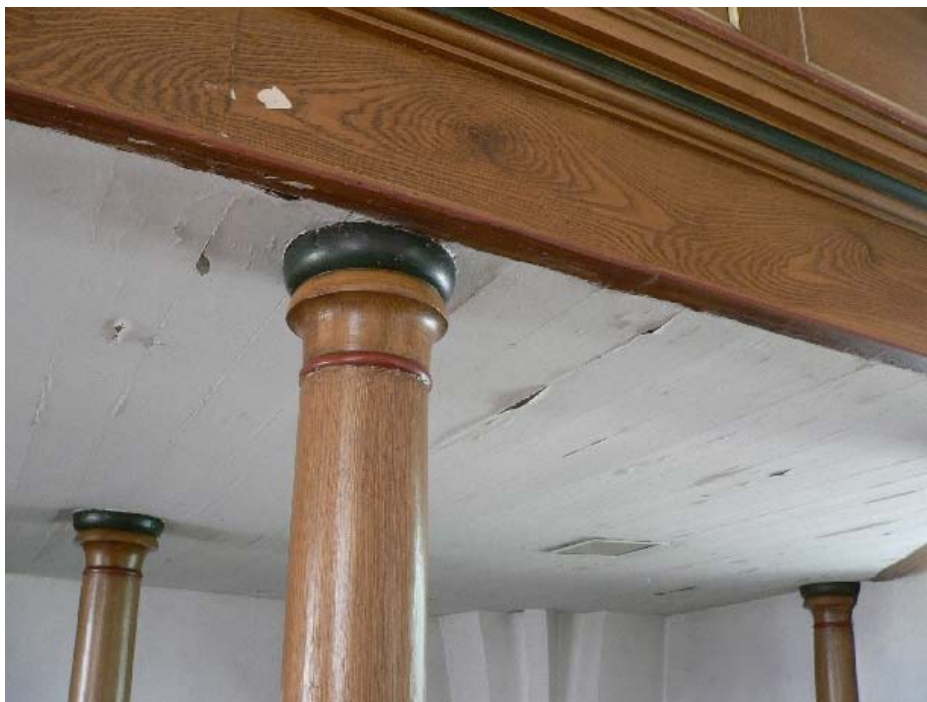
Kraftig färgflagning förekommer på undersidan av orgelläktaren.
