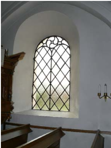
Fönster i långhuset.
