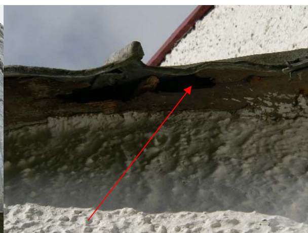
En rötskada förekommer på takfotsbrädan i absiden.
