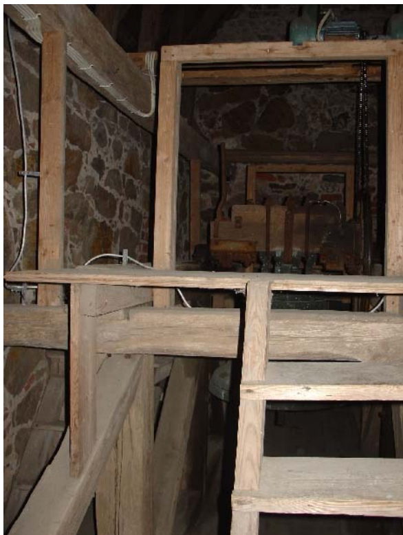
Klockrummet upptas till största delen av klockbocken med dess inspektionsramper.
