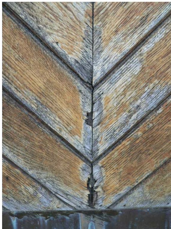
Rötskada i västporten.
