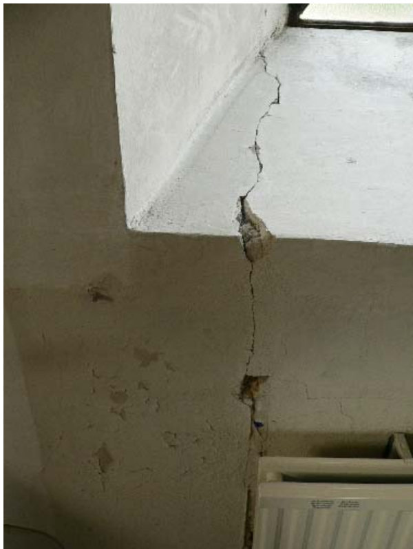
Kraftig spricka med materialbortfall i korets södra fönsternisch.
