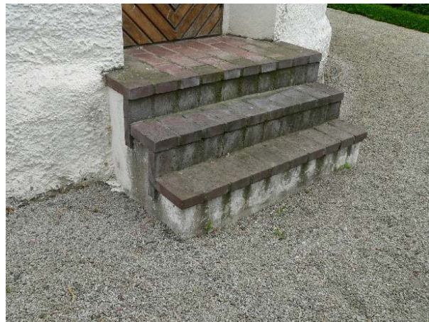
Gjuten trappa med steg av tegel framför absiddörren.
