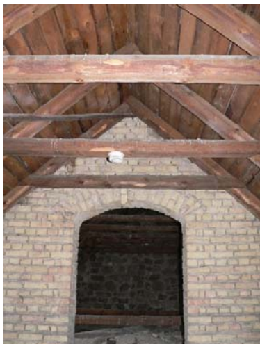
Tegelgavel på vinden mellan långhus och kor.
