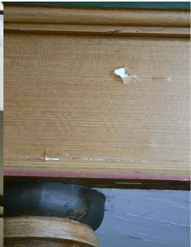
Färgflagning på utsidan av läktarbarriären.
