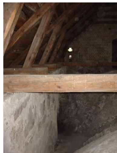
Långhusets takstolar, s.k. Svensk takstol, vilar direkt på murupplaget.
