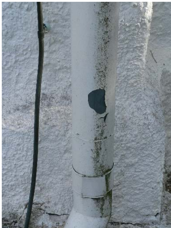
Smärre färgflagnig förekommer på stuprören.
