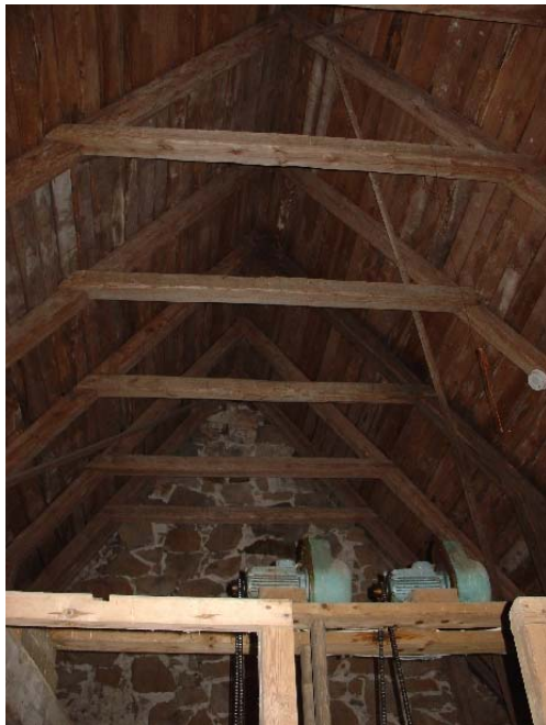
Klockrummet saknar innertak och är öppet upp i nocken.
