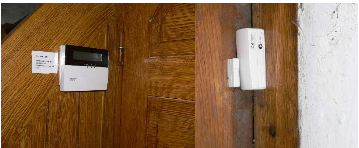
Reglage för larm i vapenhuset.
