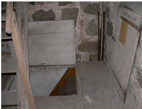
En lucka från vapenhuset öppnar upp till det 1:a tornrummet.
