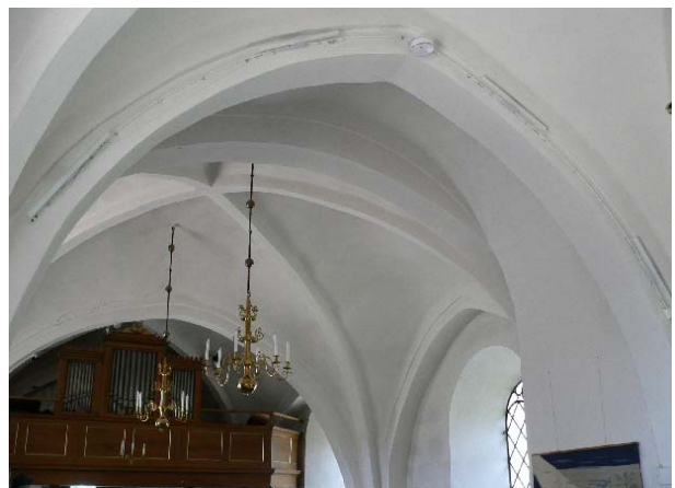
Över långhuset spänner två kryssvalv med fyrkantsprofilerade ribbor.
