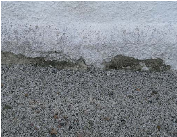
Mindre putsbortfall i den nedre delen av fasaden pga. kapillärt uppsugande fukt.
