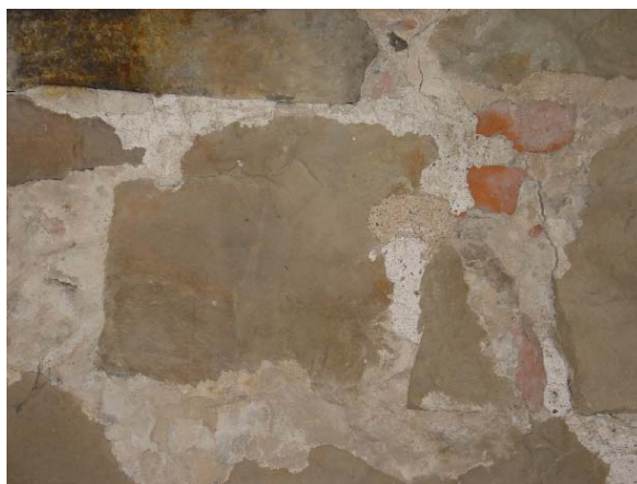
Väggarna i tornet är uppmurade av gråsten med brett utstrukna fogar. Inslag av tegel förekommer i fogarna.
