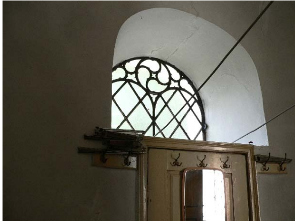
Ovanljuset över vindfånget i absiden.
