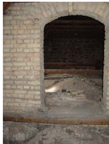
Stickbågig öppning mellan långhus och kor.
