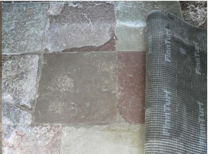
Fuktfläck under den gummibelagda mattan i vapenhuset.
