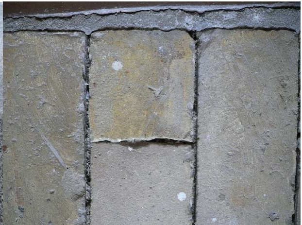
Öppna fogar förekommer i tegelgolv i vapenhus och långhus.
