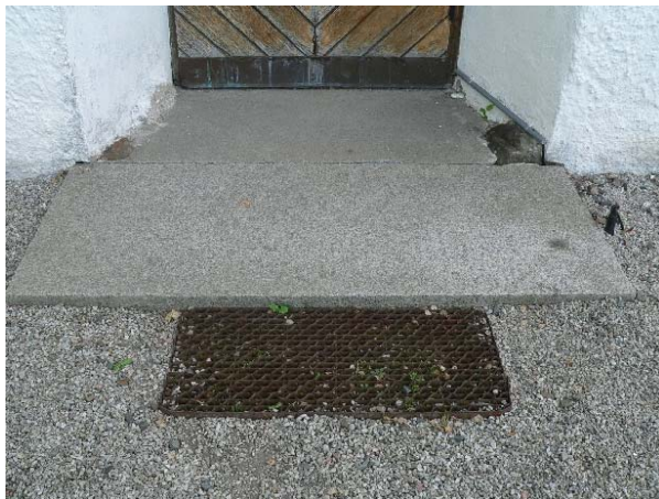
Marken framför västporten är belagd med en nersänkt granithäll.
