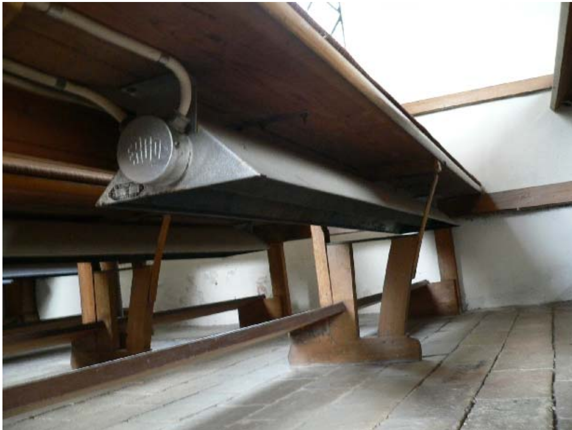
Kyrkan värms upp med radiatorer för direktvärmade el. Här en av bänkvärmarna i långhuset.
