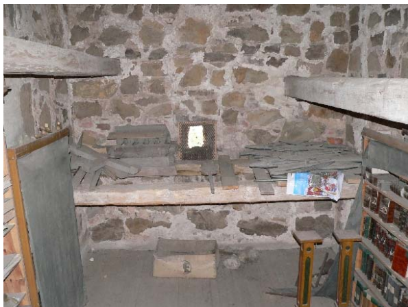
Södra delen av det 1:a tornrummet.
