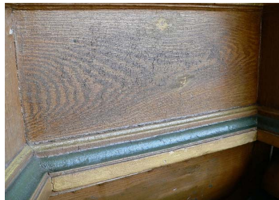
Mindre färgflagning och krackelering av färgytan är synligt på predikstolen mot söder.
