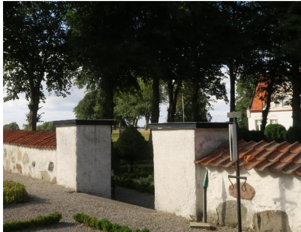
Öppningen i muren mellan den gamla och nya delen.
