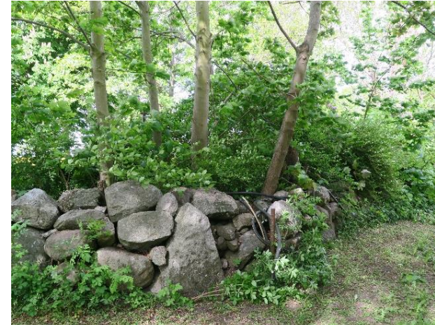
Stenmur utmed kyrkogårdens nordöstra sida med inväxning av träd och buskar som behöver tas ner och hållas efter. I hörnet står en fornminnesmärkt sten med skålgropar.
