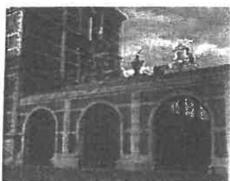
Tranchellska muren helt färdigställd efter att varit demonterad till grunden.
