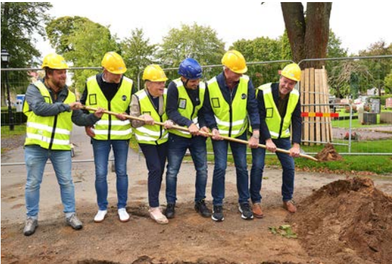
Första spadtaget tas för byggnationen vid Slottskyrkogården.
