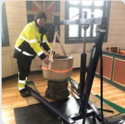
Här flyttar vi dopfunten för att slipa och lacka trägolvet i Älvsared kyrka.
