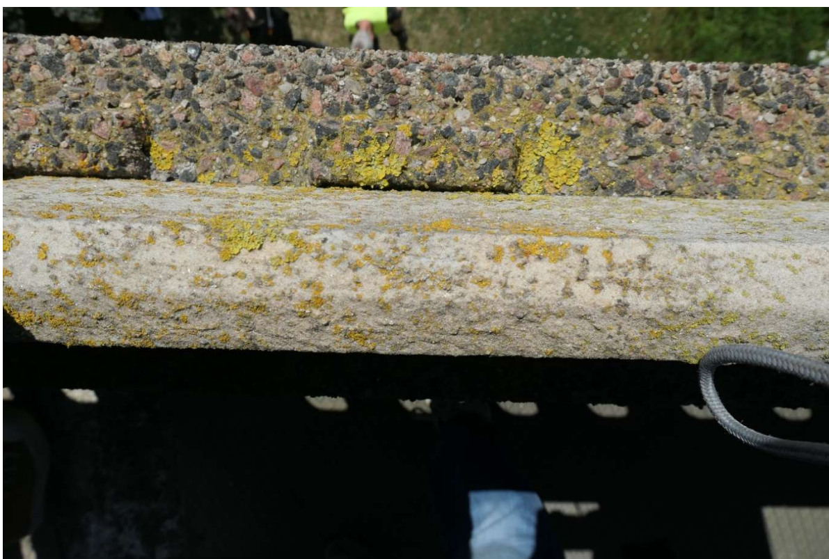
Figur 11 Marmorskivan sedd inifrån utifrån. I betongbalken finns gjutna upphöjningar som stopp som håller skivorna på plats.
