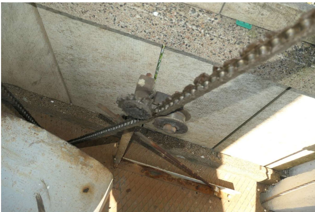
Figur 35 Kedjan fogad till ett vinkeljärn fastskruvat i durkplåten.
