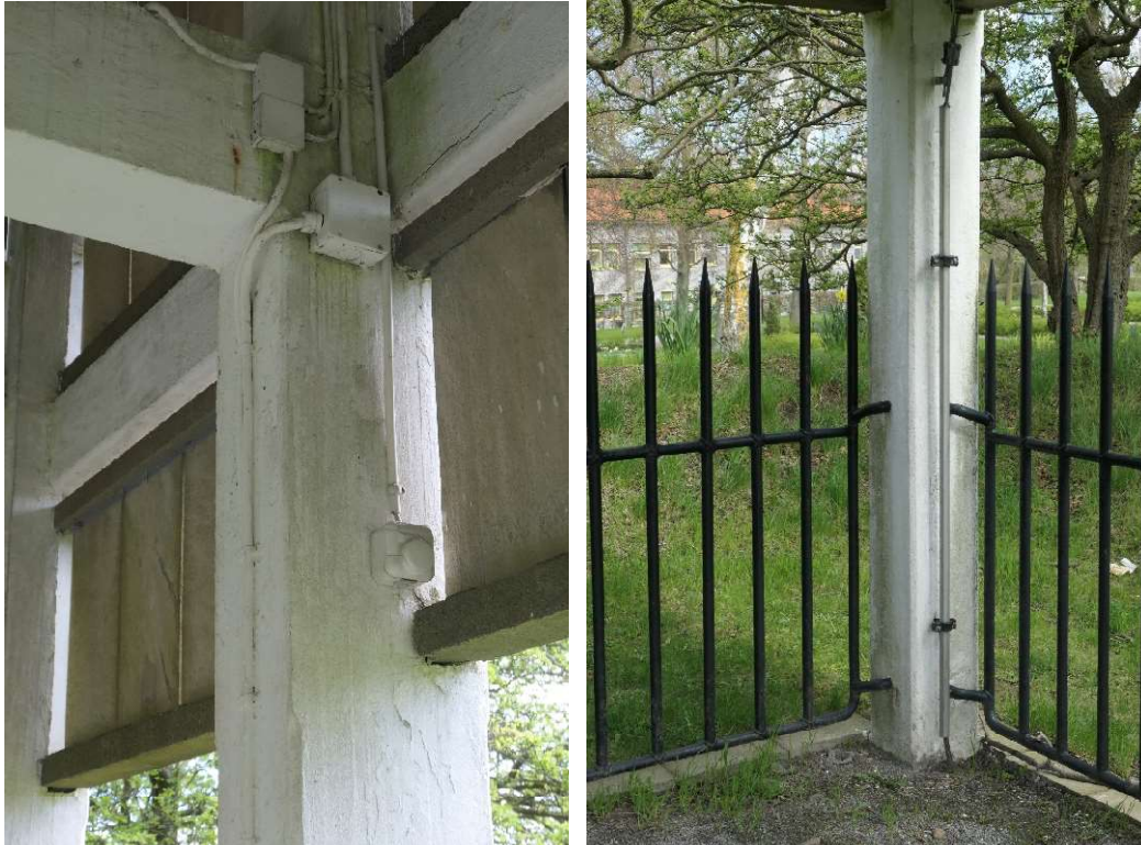
Figur 38 samt 39 Ledningsdragnig i bjälklaget mellan klockvåning och nedre plan. Mot söder.
