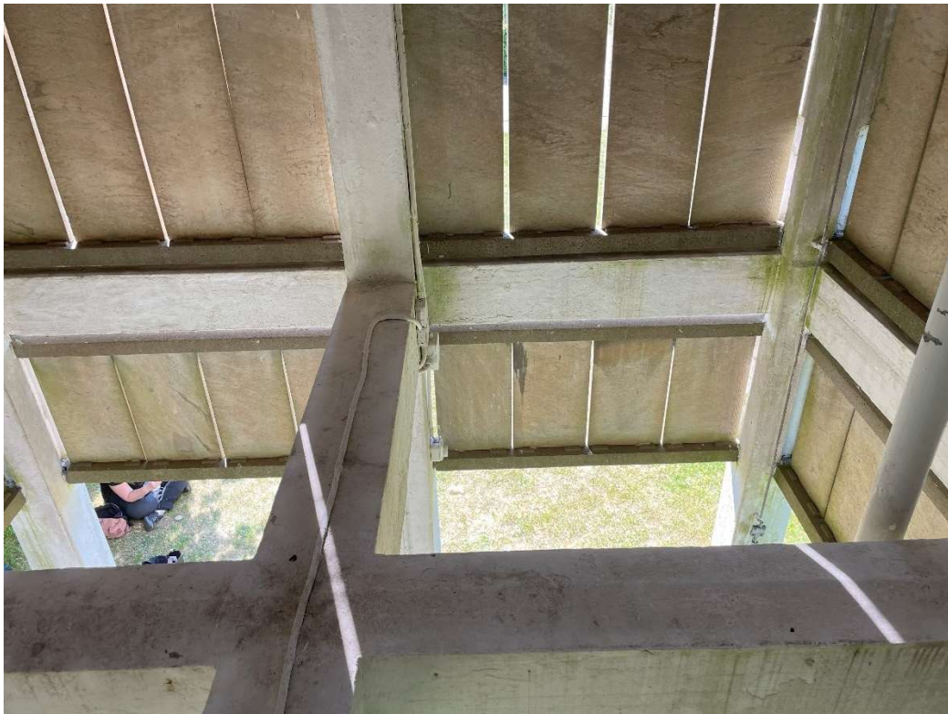
Figur 40 Ledningsdragnig i bjälklaget mellan klockvåning och nedre plan. Mot söder.
