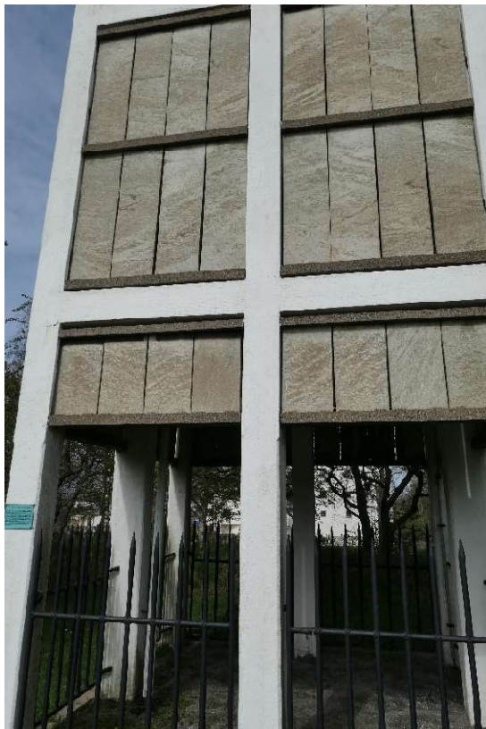
Figur 24 samt 15 Detalj av betongstommen. Gjutformen av trä med spikar anas i stommen. Till höger södra fasaden.
