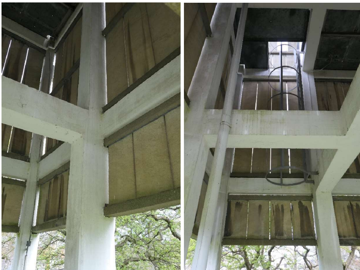
Figur 20 samt 21 Stommen sedd från insidan. Marmorblock står infogade i mindre betongbalkar. En invändig stegle- der upp till klockvåningen från första bjälklaget.
