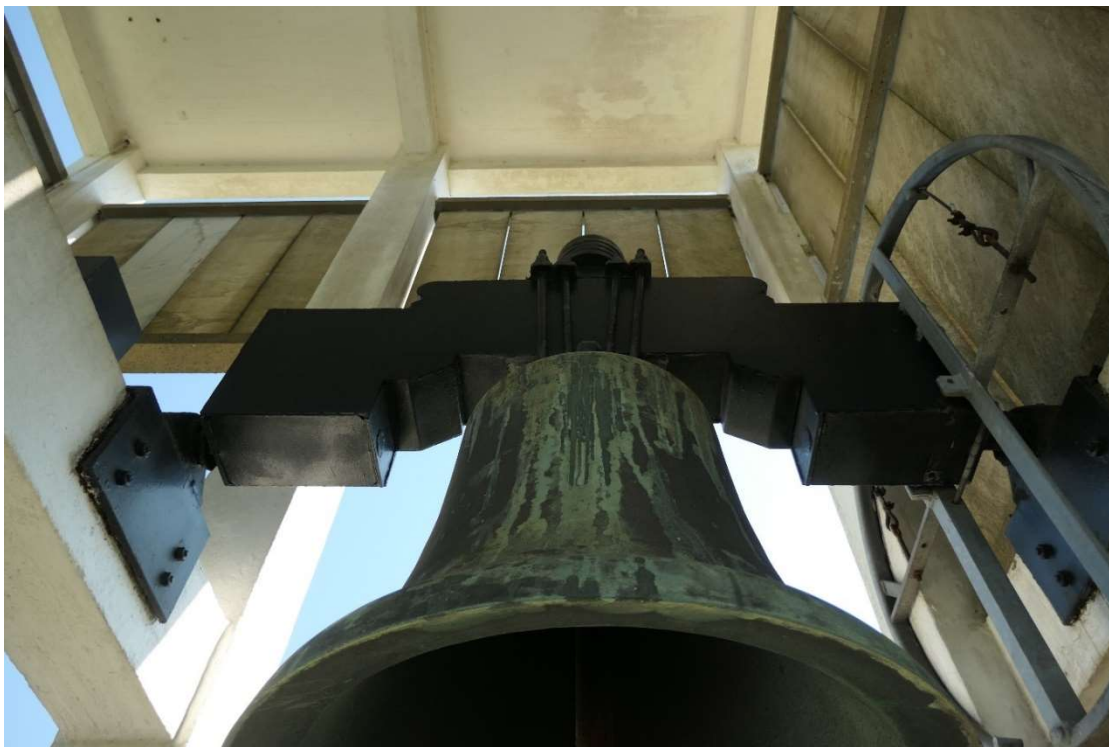
Figur 31 Klockaxlarna tycks bestå av svartmålat järn och är bultad till betongbalkar.
