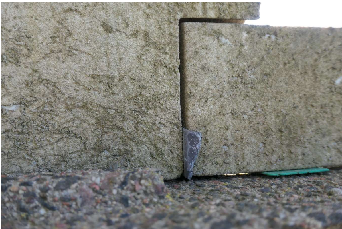
Figur 12 Infästning i sidorna av stolparna. Tätning är gjord med blyplåtbitar, mjukfog och plastmellanlägg
