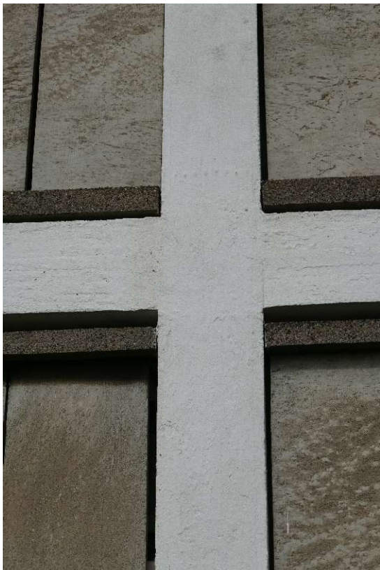
Figur 24 samt 15 Detalj av betongstommen. Gjutformen av trä med spikar anas i stommen. Till höger södra fasaden.
