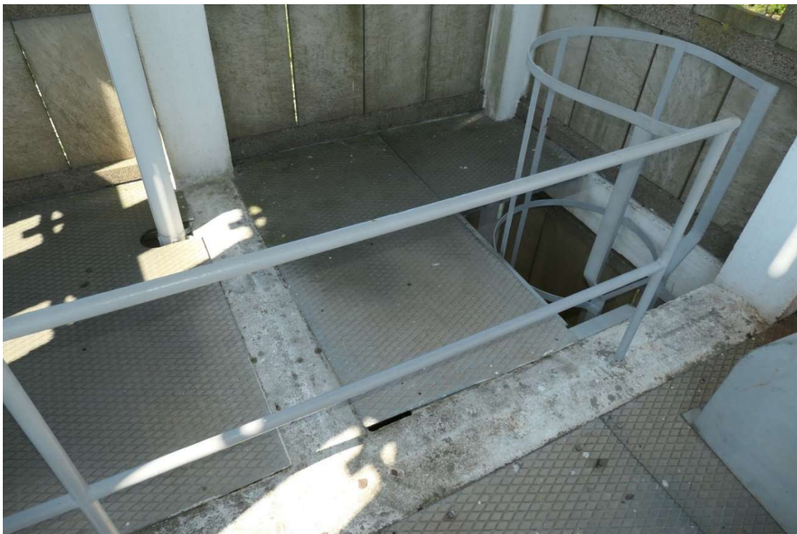
Figur 23 Golvet i klockvåningen sett mot väster. Till höger syns stegen som leder upp från ett nedre bjälklag.
