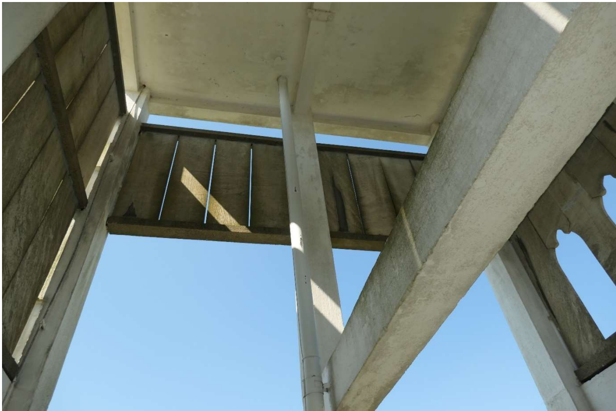
Figur 29 Mot öster och väster finns en övre rad plattor och en nedre rad. I övrigt är sidorna helt öppna.
