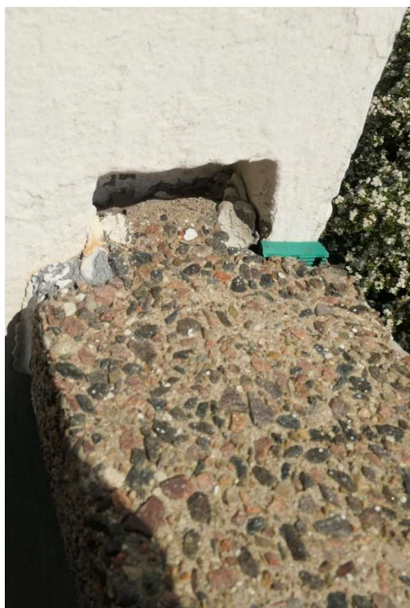
Figur 12 Infästning i sidorna av stolparna. Tätning är gjord med blyplåtbitar, mjukfog och plastmellanlägg
