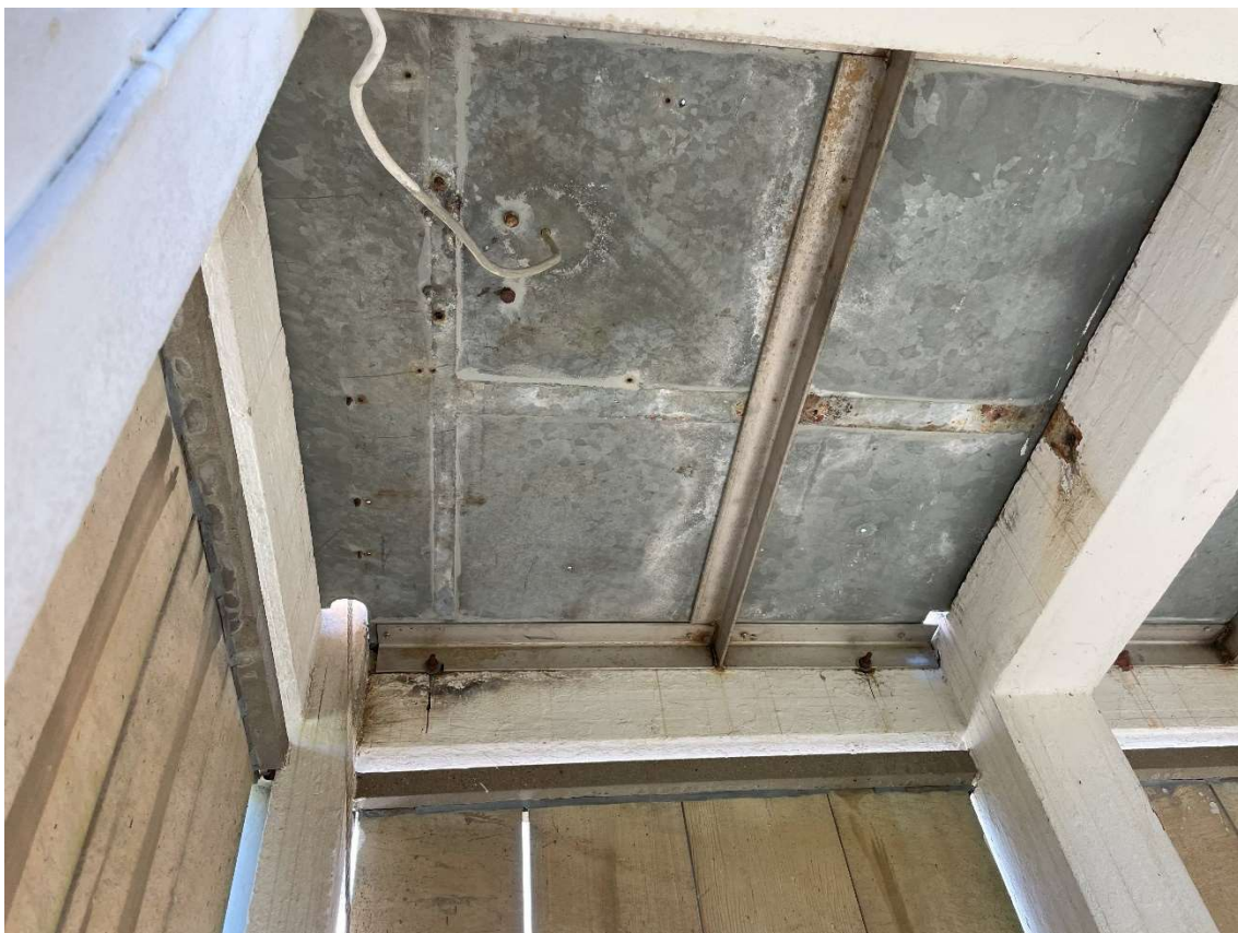
Figur 24 Klockvåningens golv utgörs av durkplåt på upplag av stommen och vinkeljärn bultade till stommen.
