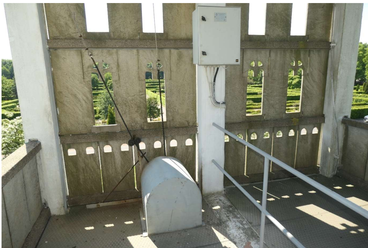
Figur 27 samt 28 Klockvåningen mot söder. Övre två raderna marmorplattor är heltäckande. Mot öster och väster finns ett lågt räcke av marmorplattor nederst.
