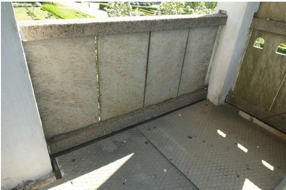
Figur 9 Konstruktionen sedd inifrån.
