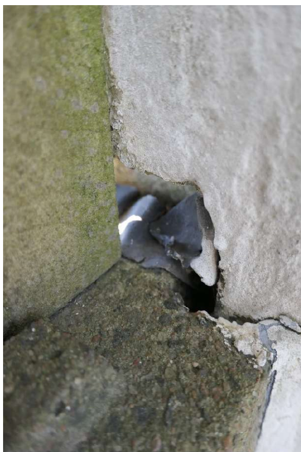
Figur 13 samt 14 Infästning i sidorna av stolparna.
