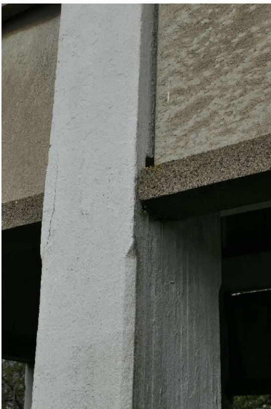
Figur 36 samt 17 Stommen består av åtta stolpar av betong. I markplan är dessa fasade i hörnen. Ett räcke av järn skärmar av nedre plan.
