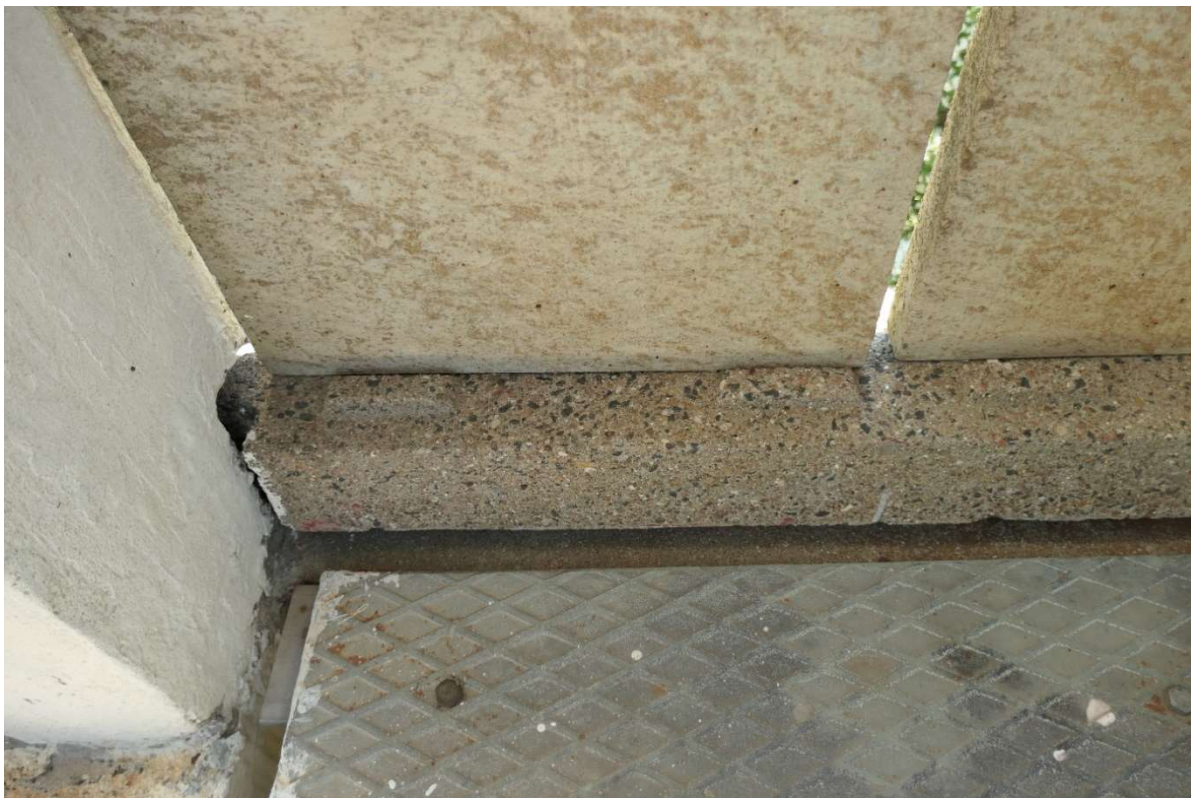
Figur 10 Marmorskivan sedd inifrån.
