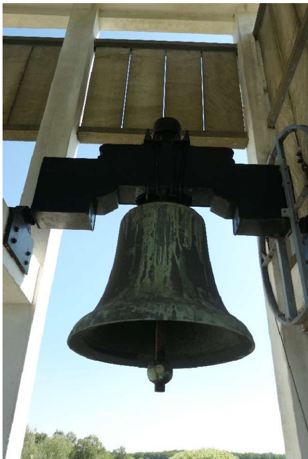
Figur 29 Mot öster och väster finns en övre rad plattor och en nedre rad. I övrigt är sidorna helt öppna.
