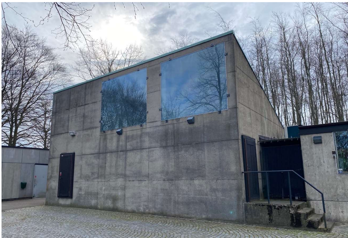
Figur 2 Norra fasaden, 1969 års byggnad.
