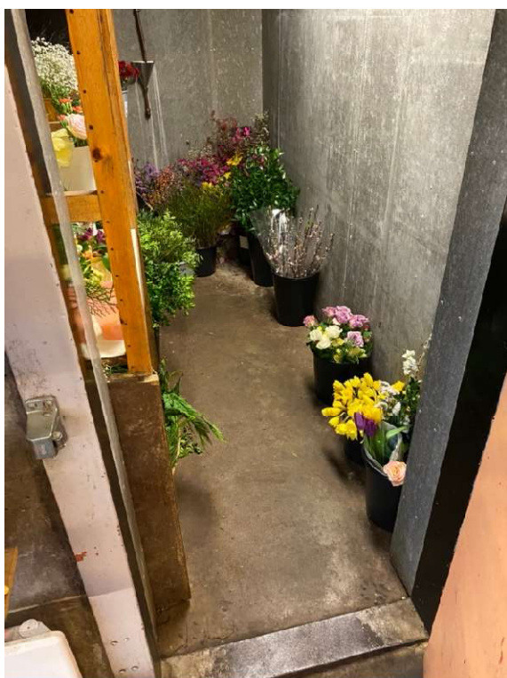
Figur 49 Kylrummet har gjutet golv.
