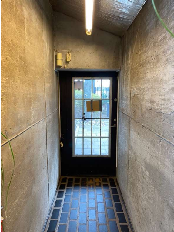
Figur 27 Entréparti, med betongväggar (likt exteriört) och klinker på golvet.
