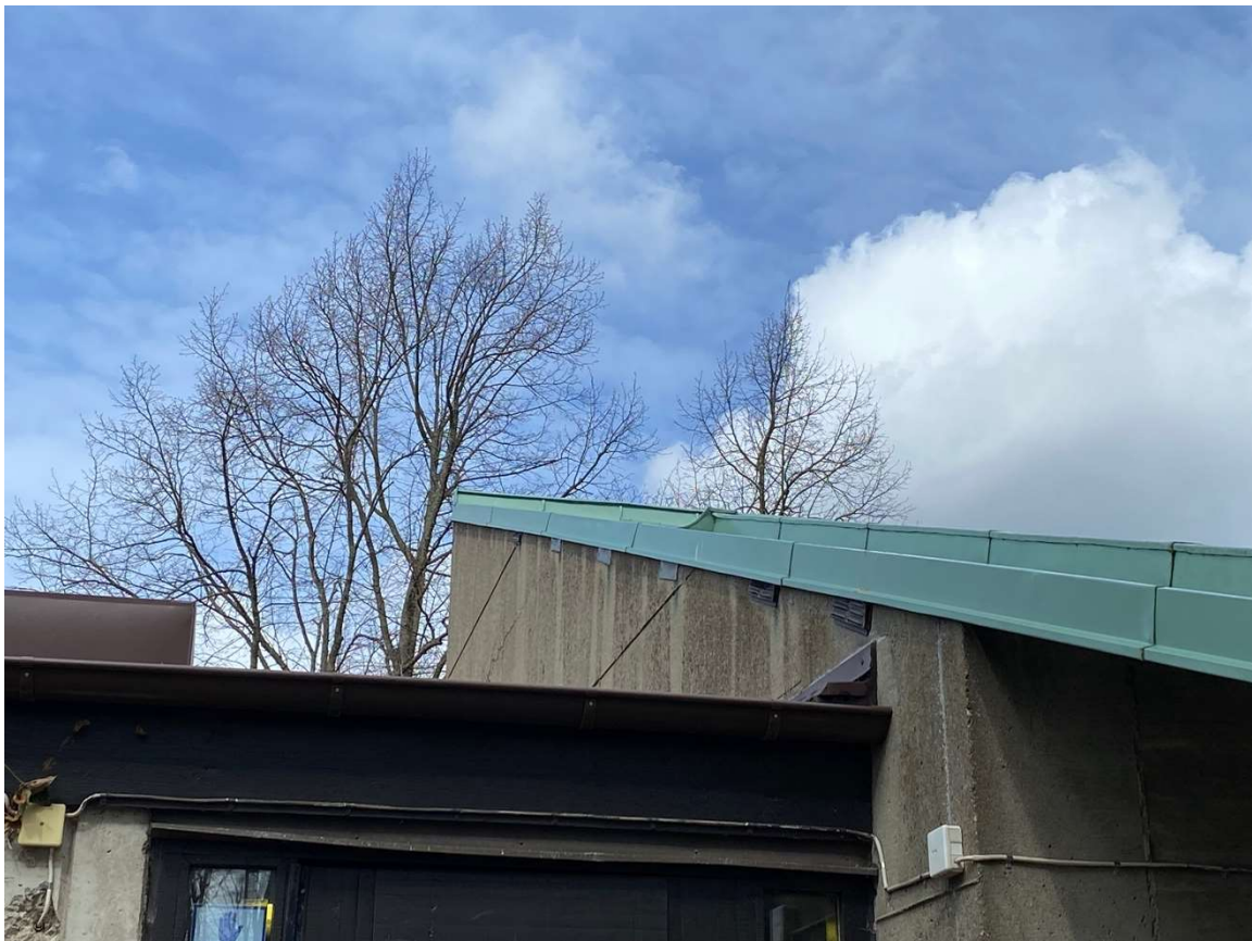
Figur 18 Västra fasaden. Ventilation av takkonstruktionen via ventiler längs västra väggens övre del.
