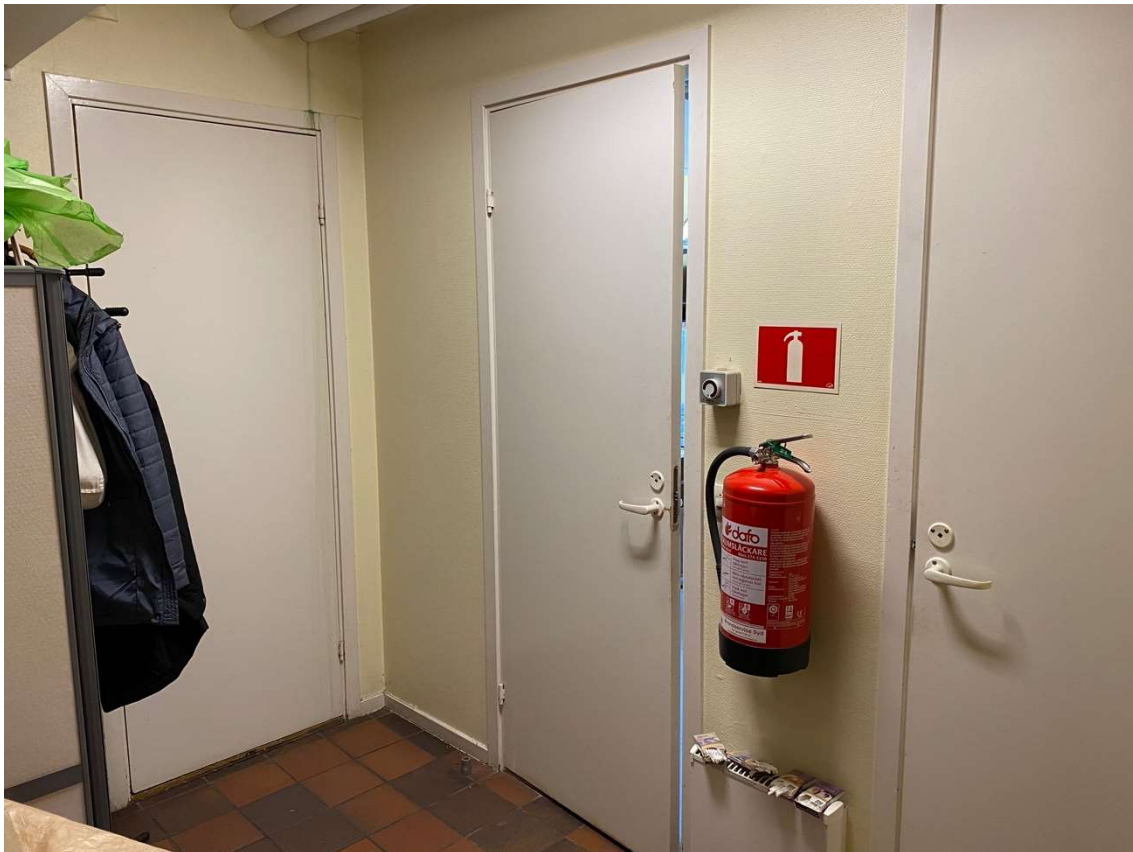
Figur 92 Hall med dörrar in till tre utrymmen, pentry till höger i bild, kontor i mitten och wc till vänster i bild.
