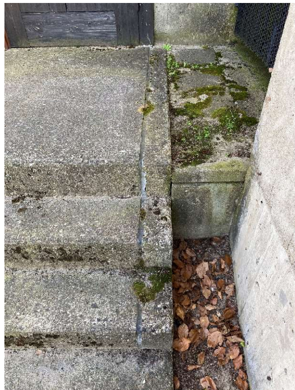
Figur 69 Detalj av trappa och avsats.
