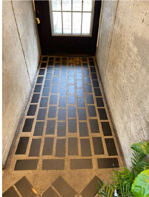
Figur 28 Klinkern fick ej, enligt arkitekten, delas på. Istället gjordes fogen bredare.
