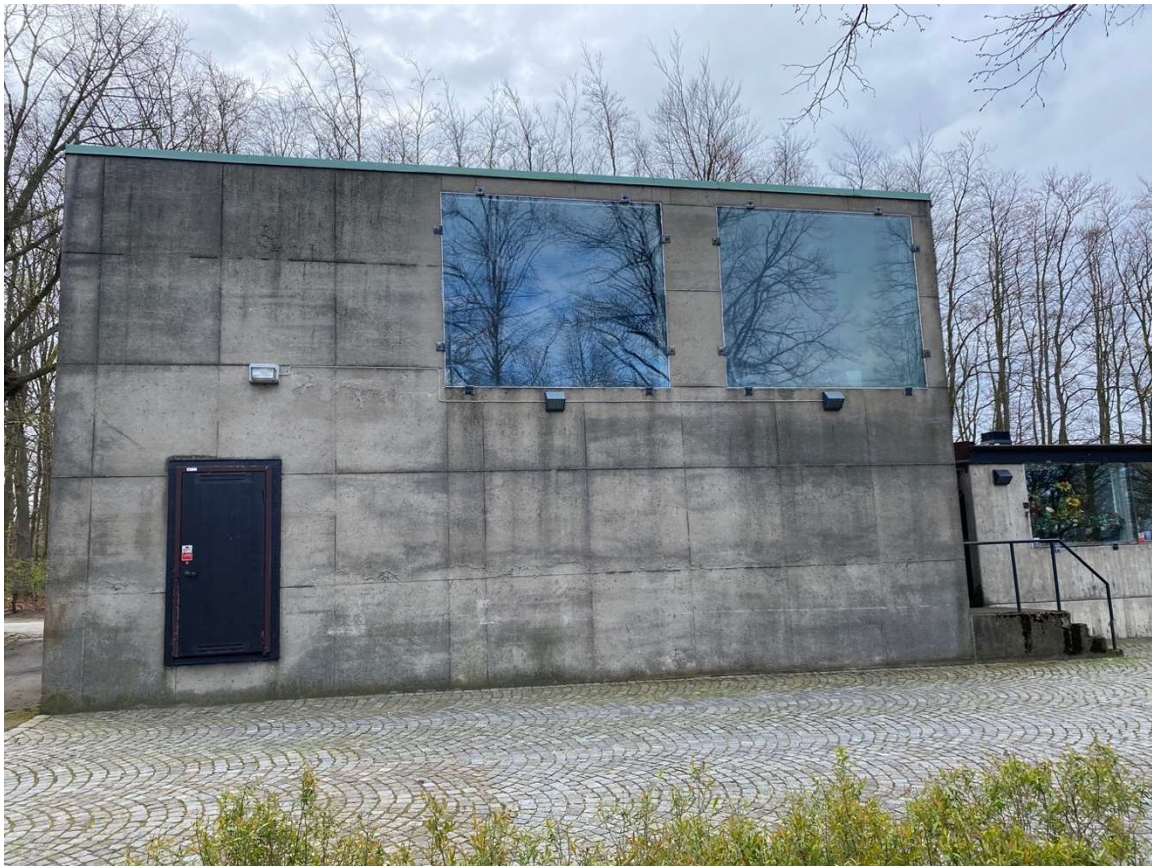
Figur 3 Norra fasaden, 1969 års byggnad.
