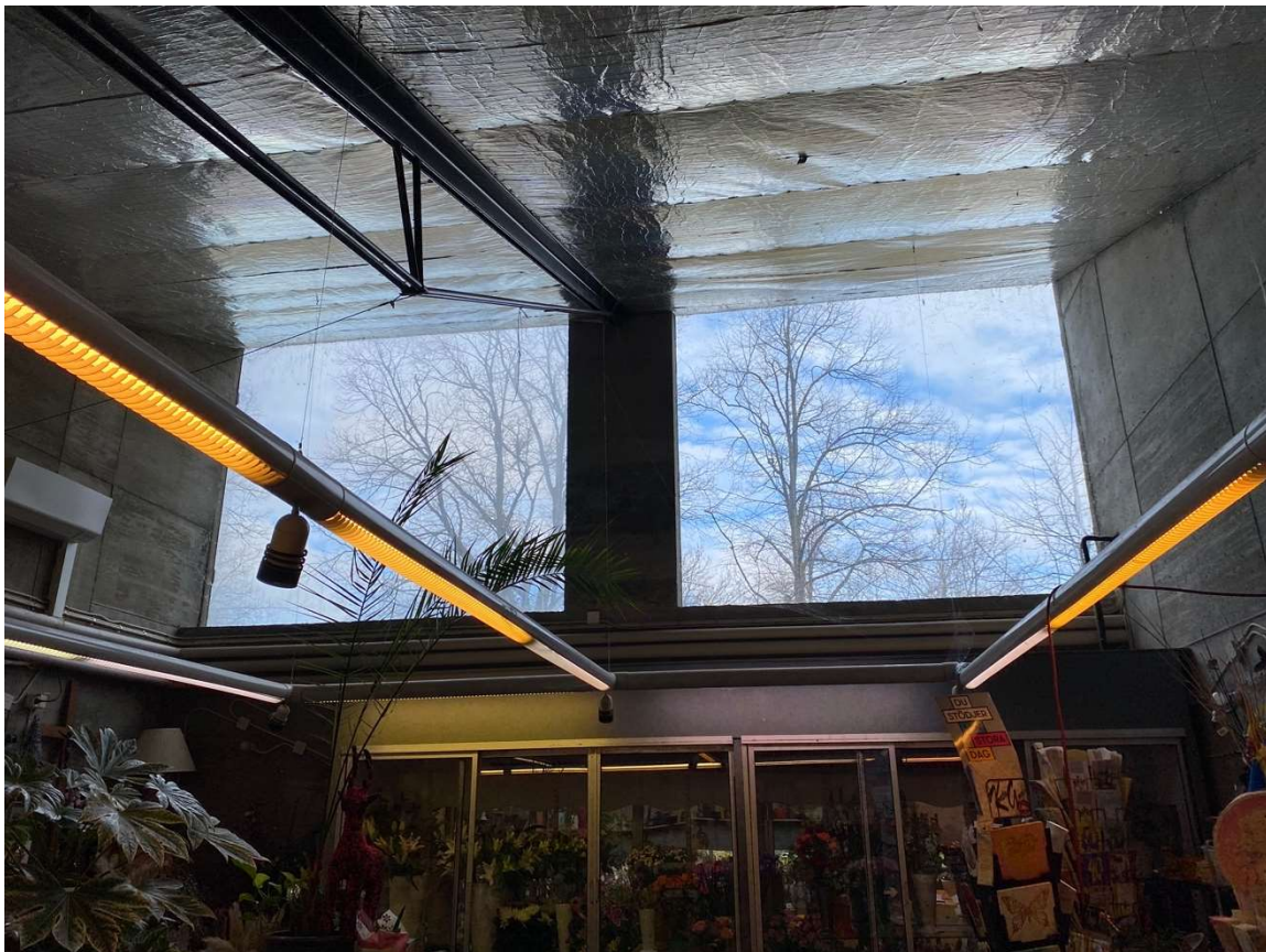
Figur 38 Butikslokalens tak med aluminiumpapp. Ursprunglig takbeklädnad. Senare tillkommen lysrörsbelysning.
