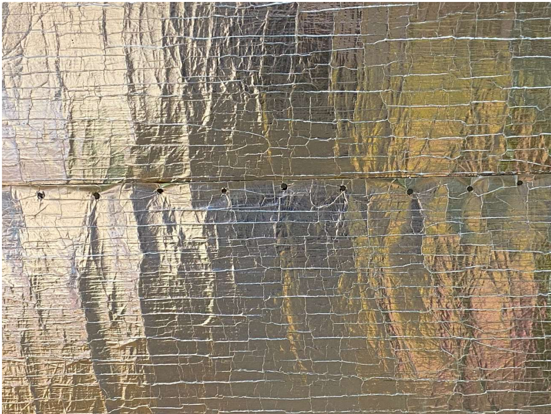
Figur 41 Närbild av aluminiumpapp fäst med spik.
