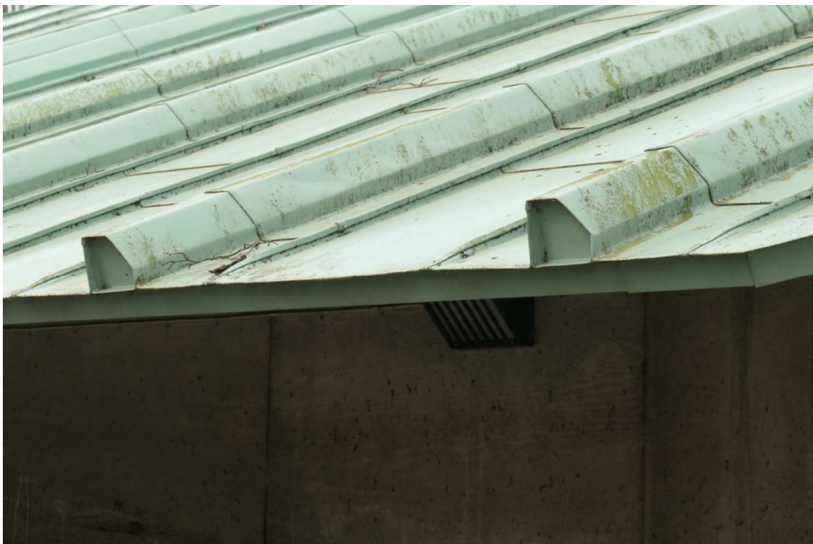
Figur 21 Vid uppförandet 1969 lades kopparplåten som skivtäckning med dubbla ståndfalsar i lutningsriktning, och förskjutna tvärfalsar utförda som dubbel hakfals. Detta efterliknades när koppertaket ersattes med ett bemålat plåttak 2014.
