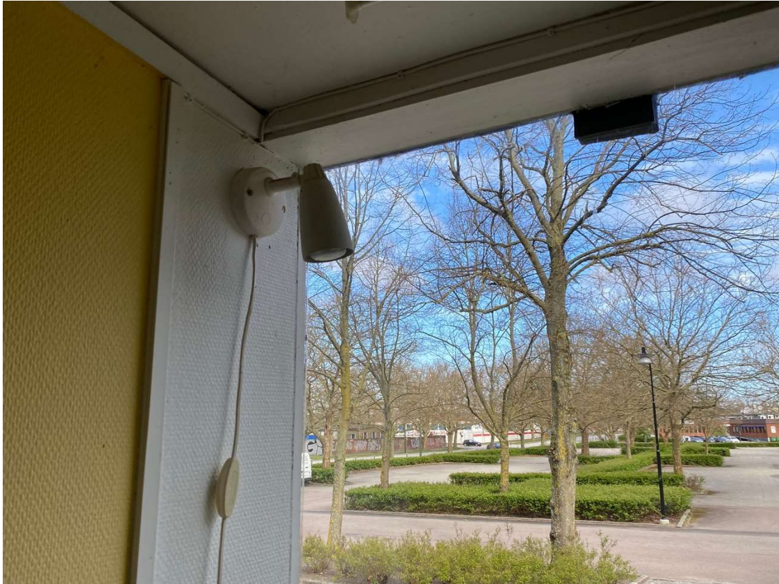
Figur 95 Fönster i pentryt, med vy ut mot parkeringen.
