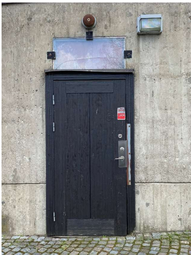
Figur 64 Dörr till offentligt wc, västra fasaden.
