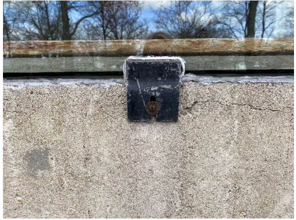
Figur 71 Detalj fönstermontering på södra fasaden.
