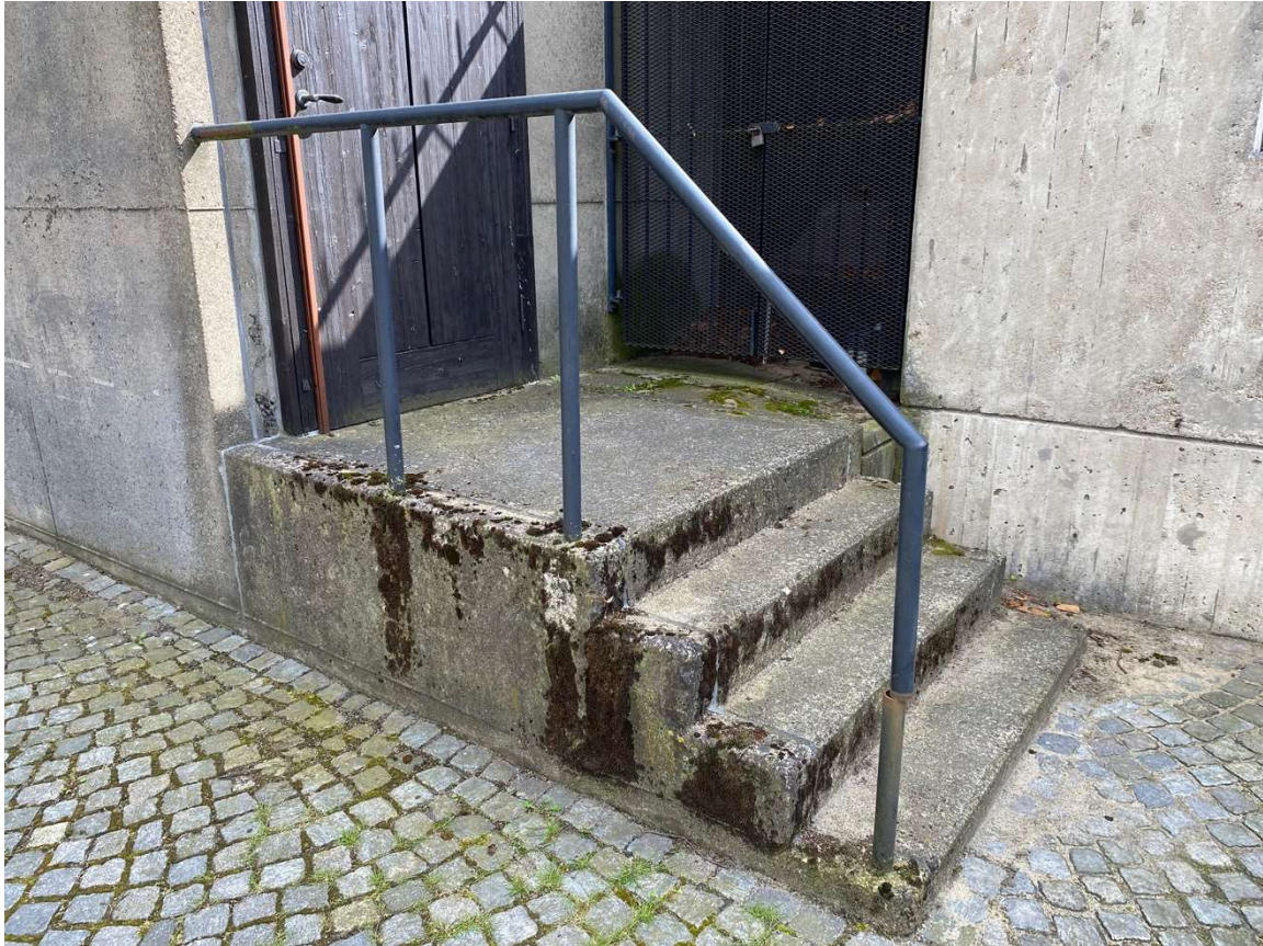
Figur 12 Trappa till dörren på västra fasaden, på 1969-års byggnad. Bredvid syns igensatt dörr på tillbyggnadens norra fasad.
