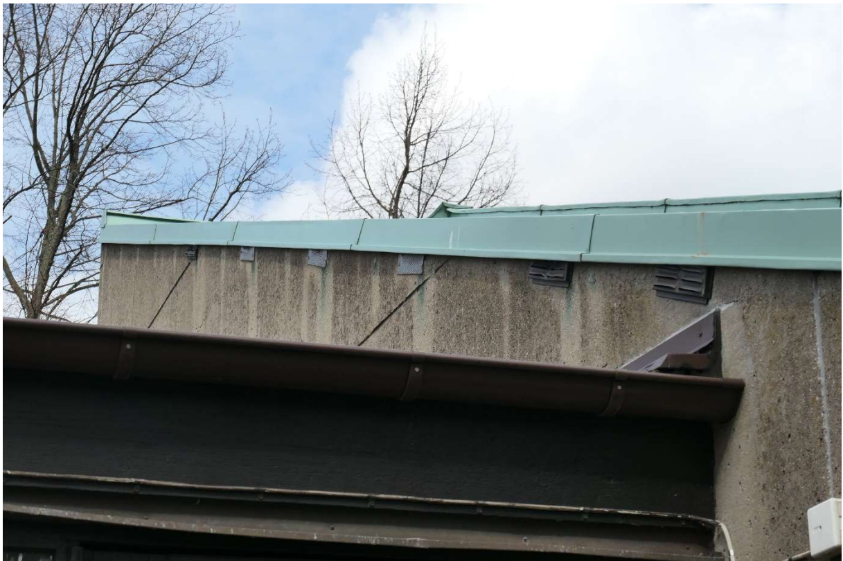
Figur 72 Tillbyggnadens tak mot västra fasaden av 1969 års byggnad.
