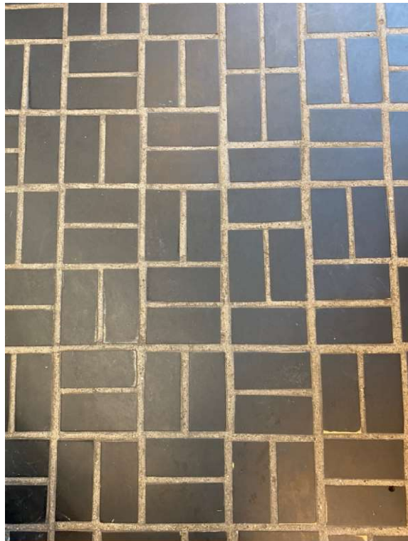
Figur 30 Butikslokalens klinkergolv.
