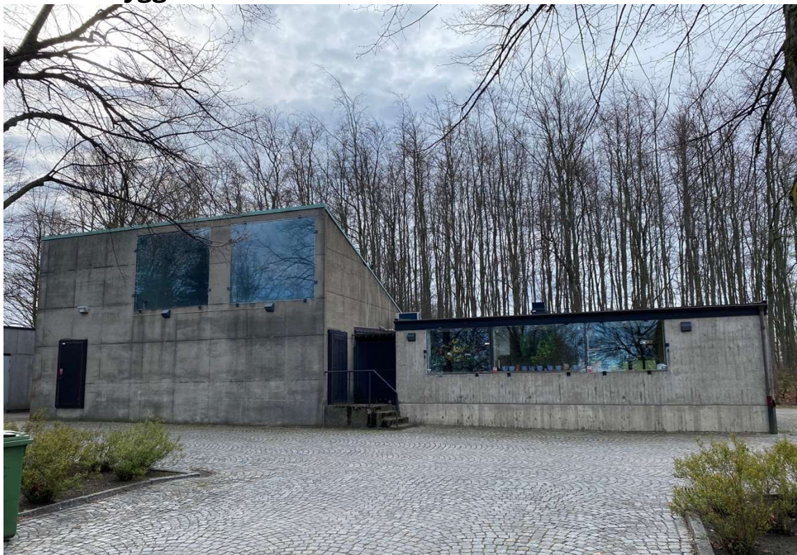
Figur 1 Norra fasaden, 1969 års byggnad till vänster i bild och 1979 års lägre tillbyggnad till höger i bild.
