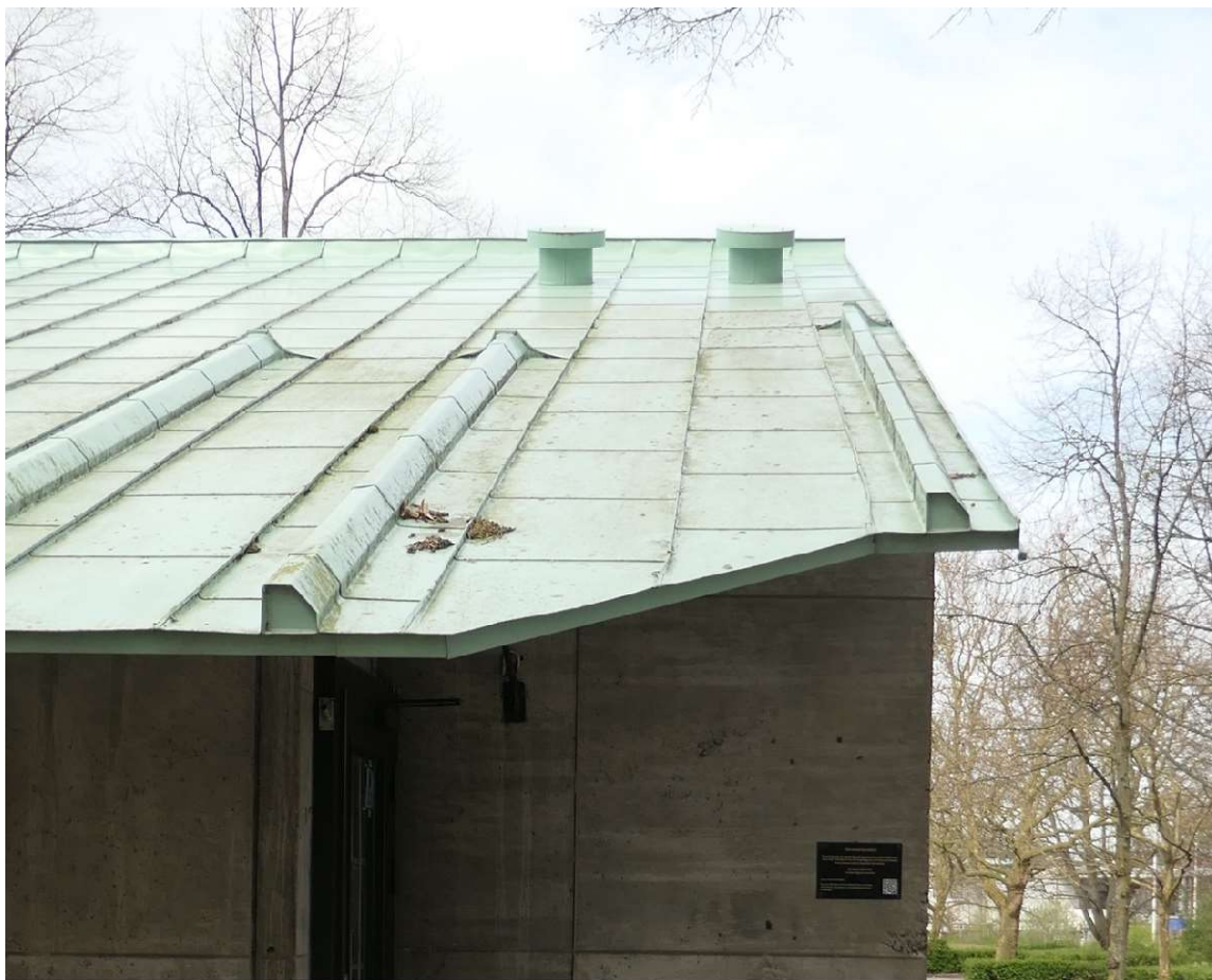
Figur 20 Ett par ventilationshuvor i yttertaket är kvar av koppertaket.
