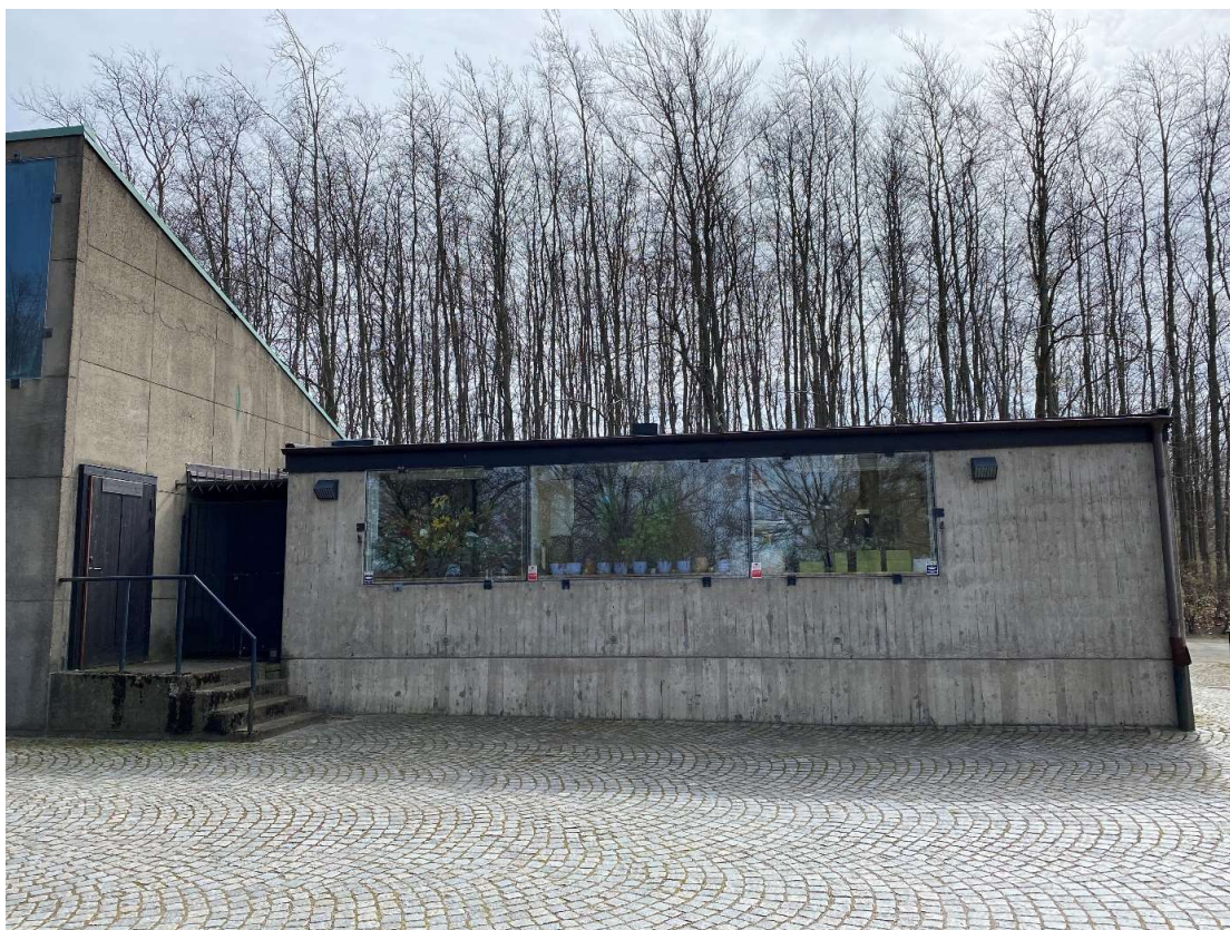
Figur 54 Tillbyggnaden sett från norr.
