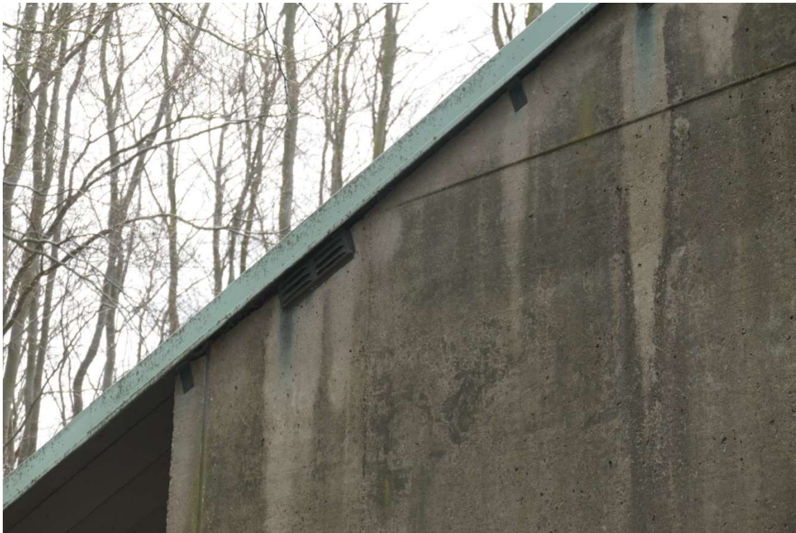
Figur 19 Närbild av ventilation längs östra väggens övre del.
