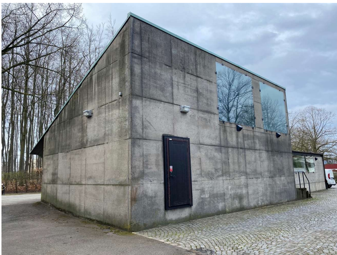
Figur 26 Senare tillkommen utomhusbelysning, en vit samt en svart modell. Norra och östra fasaden.
