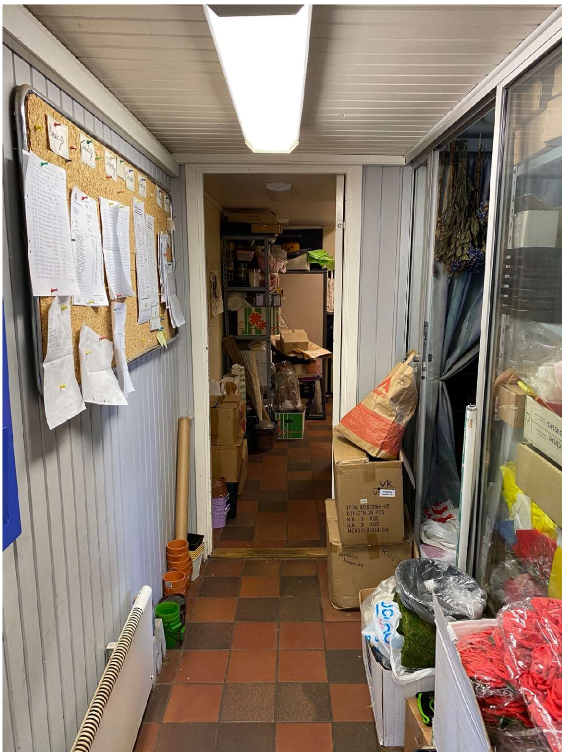
Figur 85 Korridoren sett från öster. Träpanel både på väggar och i tak. Radiator på södra väggen. Skjutdörr av glas in till bindrum. Rakt fram hall med dörrar in till pentry, kontor samt wc.
