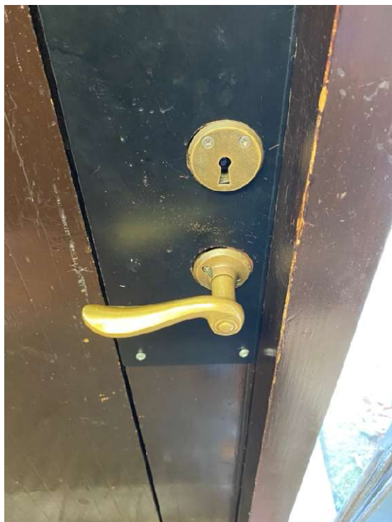
Figur 78 Trycke på södra ytterdörren.
