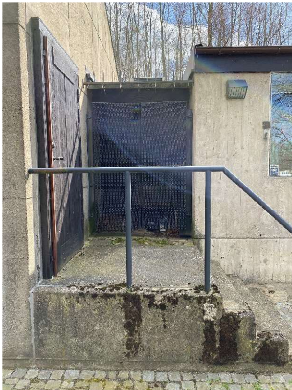
Figur 68 Trappa med räcke till ytterdörrar till både 1969 års- och 1979 års byggnad.
