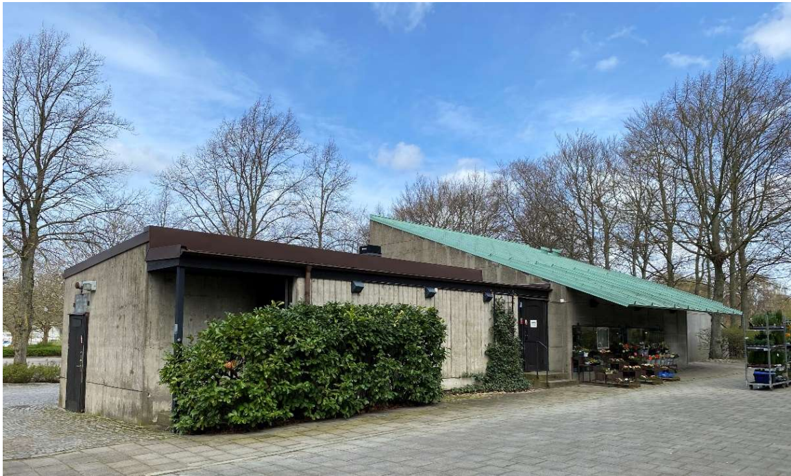
Figur 51 Blomsterkiosken sett från sydväst. Närmast i bild 1979 års lägre tillbyggnad.
