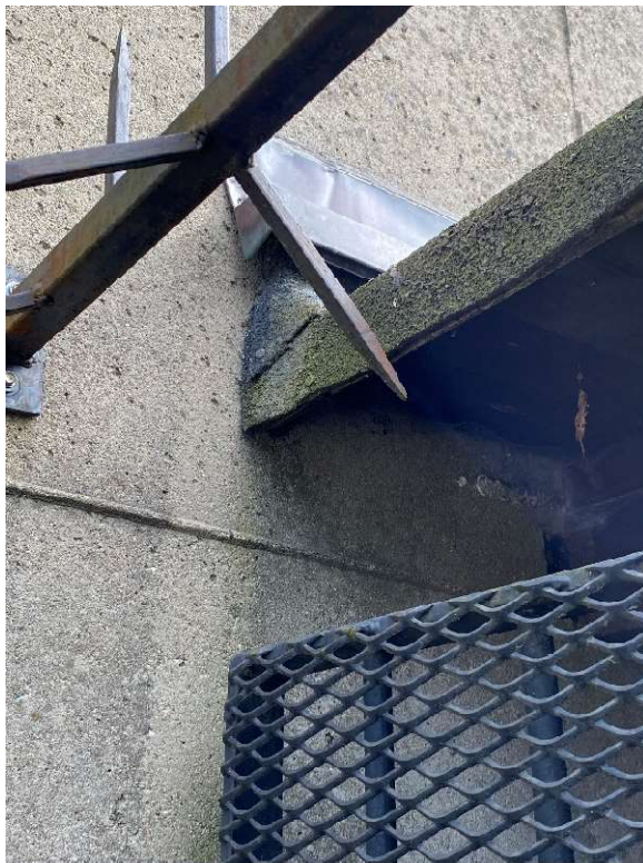
Figur 60 Tillbyggnadens anslutning till 1969 års fasad. Papptak och regnskydd av kopparbleck.
