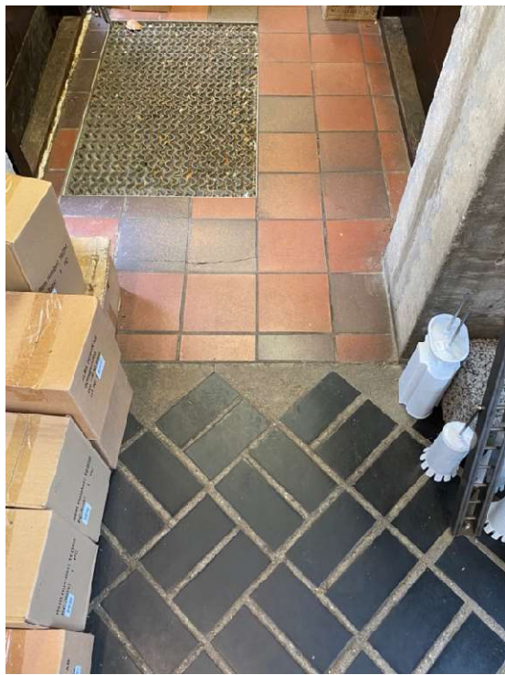
Figur 76 Korridoren har rödbrun klinker på golvet.
