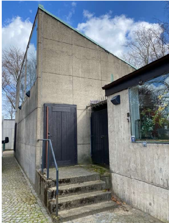
Figur 10 Dörr av limträ som leder in till butiksdelen. Dörren används ej i nuläget. Västra fasaden av 1969-års byggnad.
