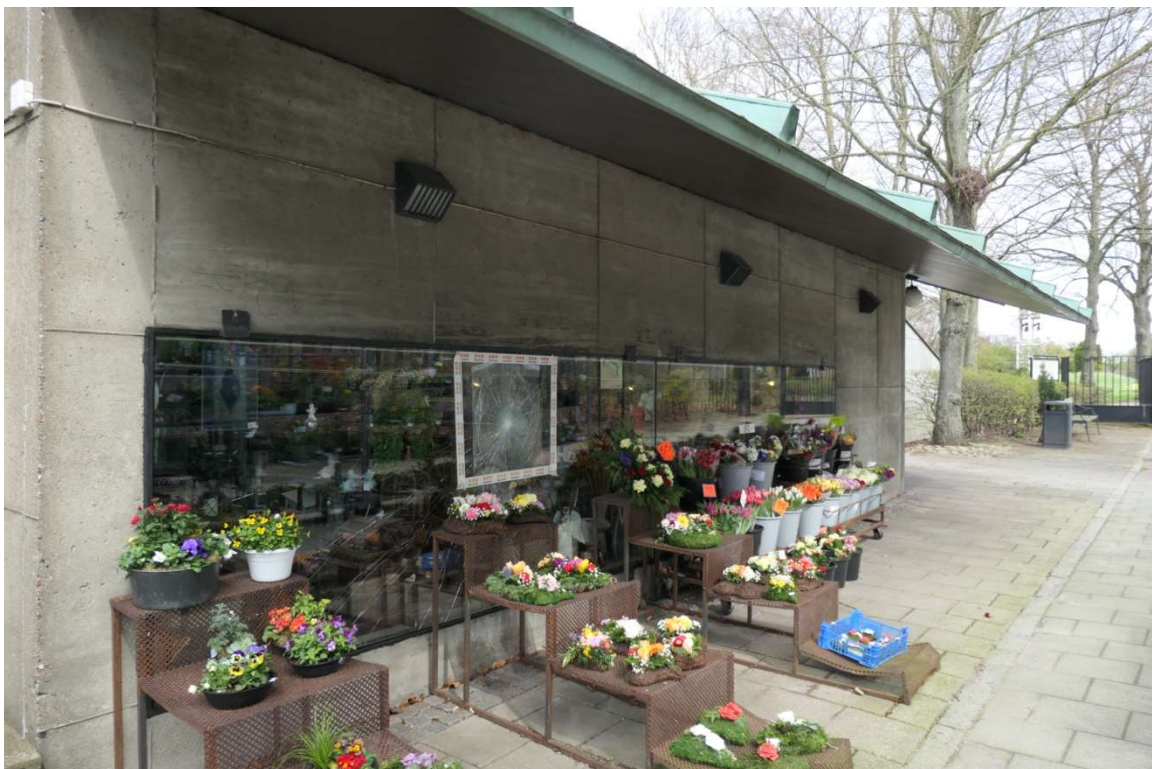
Figur 16 Södra fasaden sett från sydväst. Två rutor är sammanfogade till ett långt utdraget skyltfönster.
