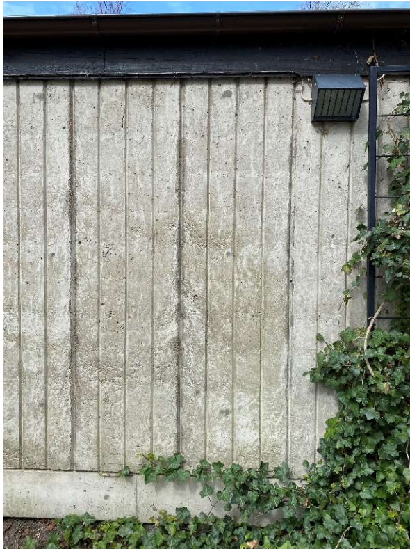
Figur 55 Tillbyggnadens betongfasad, sett från söder.
