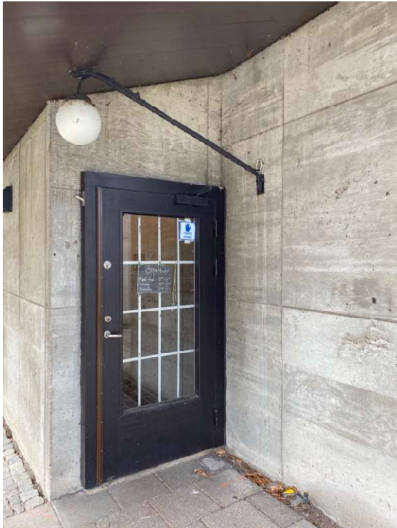
Figur 9 Entrédörren, placerad under skärmtaket öster. Enligt byggnadshandlingar utbytt under 1990-talet.
