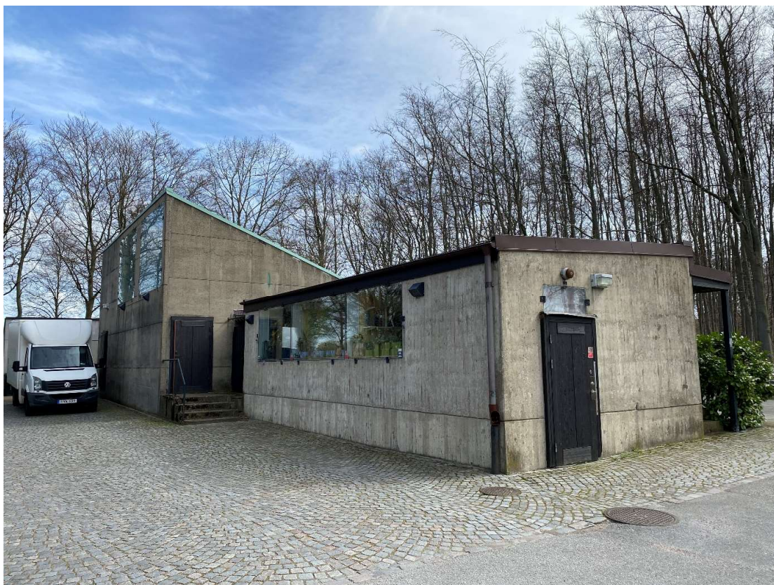
Figur 53 Tillbyggnaden sett från nordväst.
