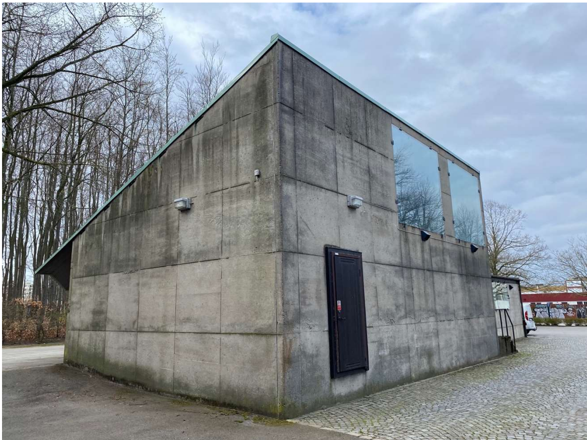
Figur 4 1969 års byggnad sedd från nordost.
