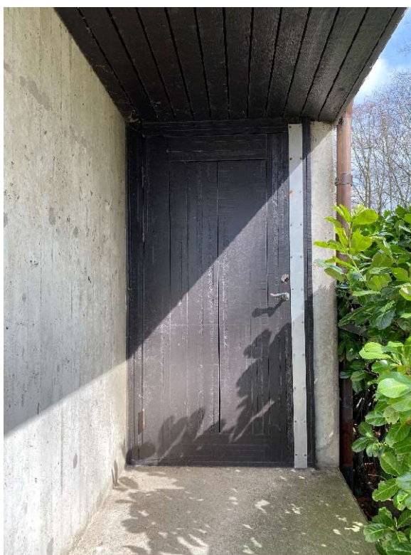
Figur 63 Ytterdörr till hallen, på västra fasaden.
