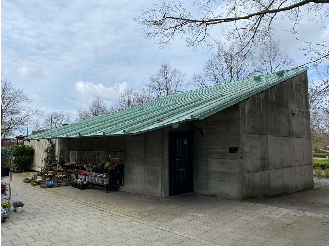
Figur 17 Ursprungliga koppartaket är ersatt med ett tak av plåt målat i en ljusgrön (turkos) kulör.
