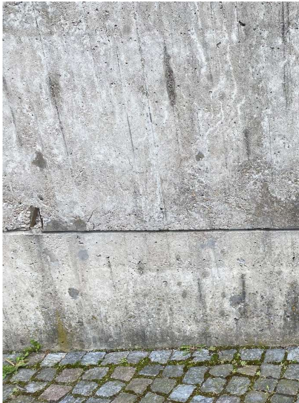
Figur 58 Närbild av betongfasaden åt norr.
