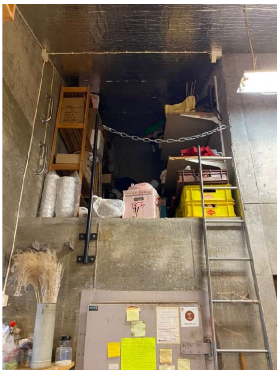
Figur 47 Utrymme ovanför kylrummet.
