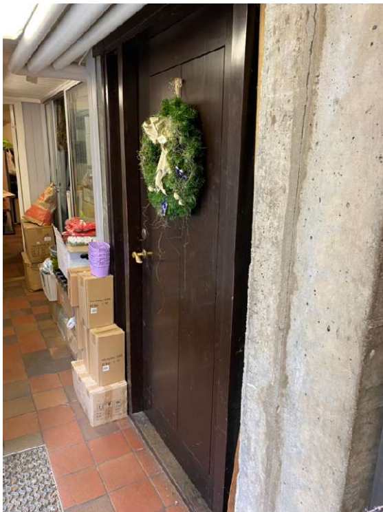
Figur 80 Dörr till kylrum. Norra sidan av korridoren.
