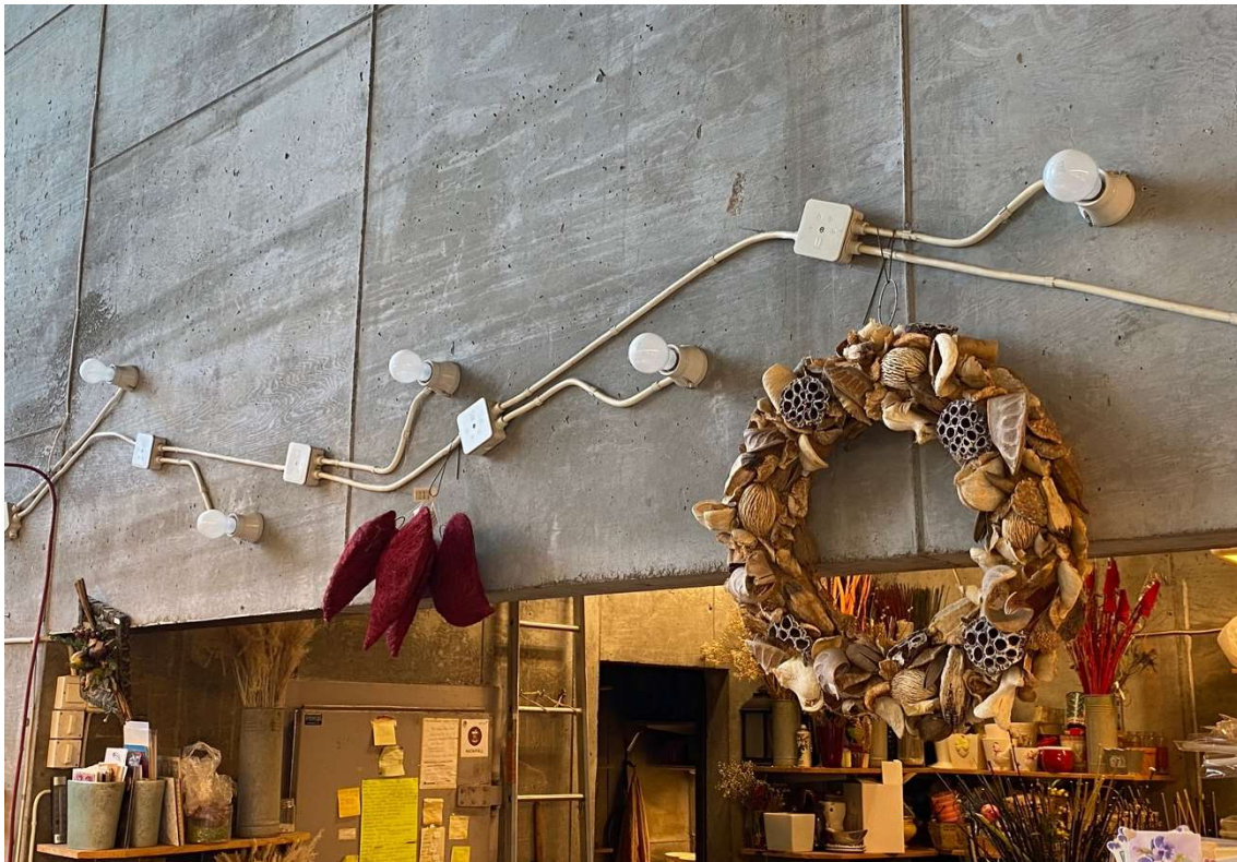
Figur 45 Elinstallation, formgiven av arkitekt Sigurd Lewerentz, som utgör en viktig del av byggnadens interiör.
