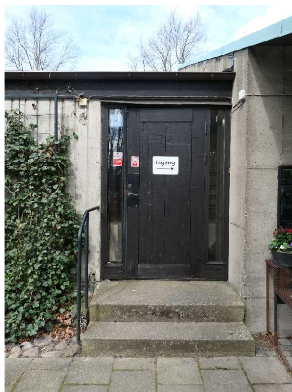
Figur 61 Ytterdörr, placerad på södra fasaden, i sydöstra hörnet.
