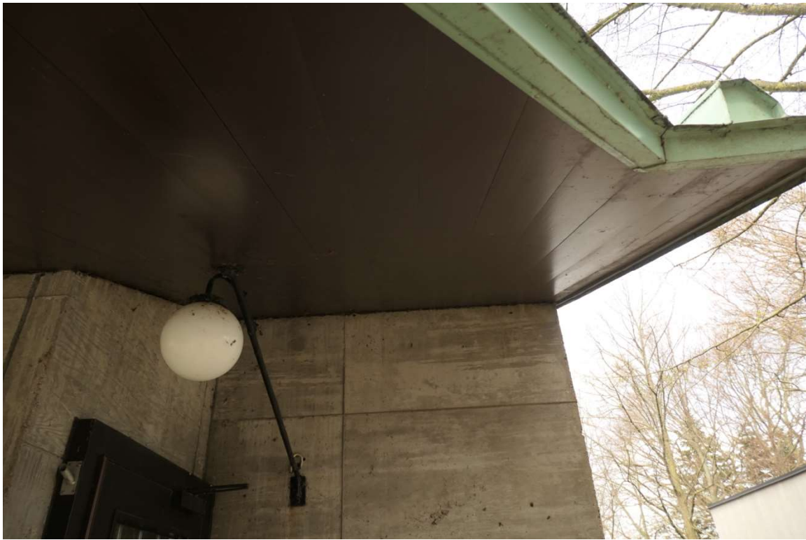
Figur 22 Trätak under det utskjutande skärmtaket, vid entrépartiet.
