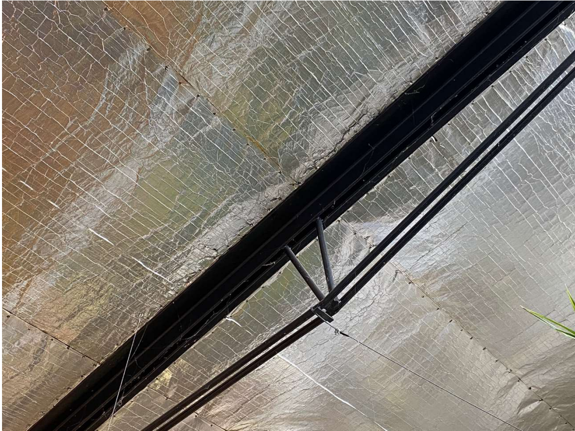
Figur 40 Närbild av butikslokalens takkonstruktion och takbeklädning.
