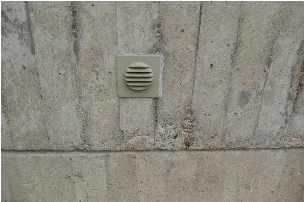
Figur 73 Senare tillkommen ventil av plast i ljus kulör. Norra fasaden.
