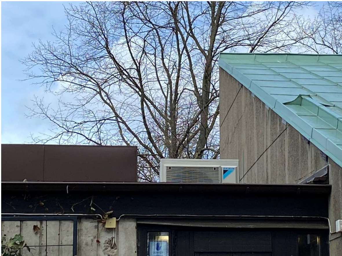
Figur 59 Tillbyggnadens plåttak med ventilationsanordning.
