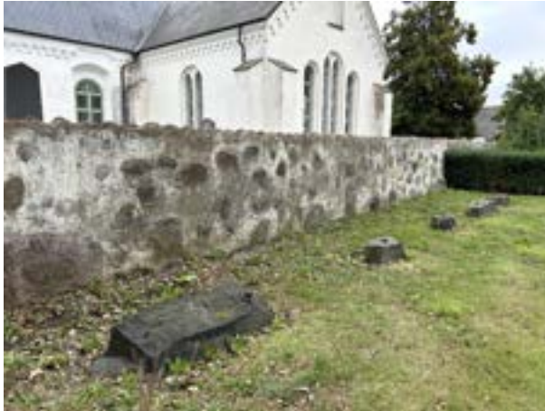
Muren i söder. I gräset framför muren ligger stenar med bindingar.
