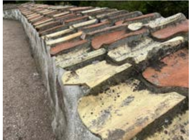
Murens avtäckning med gult och rött tegel.
