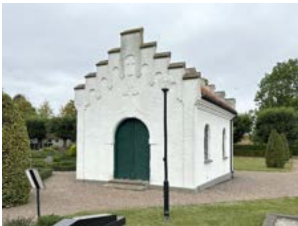
Kapellets södra fasad.
