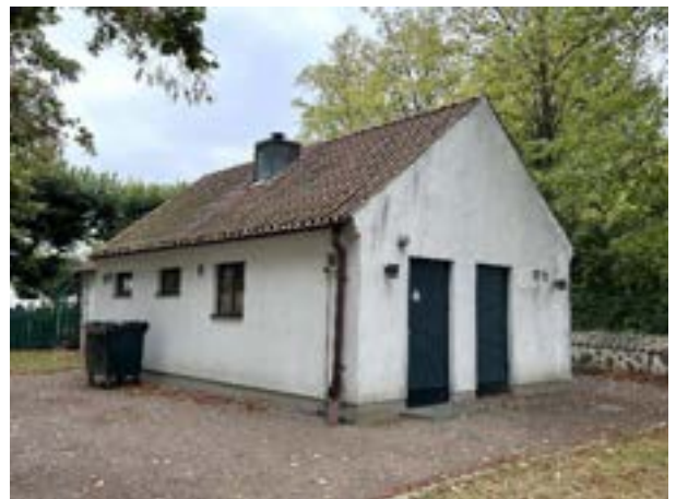
Personal- och förrådsbyggnadens norra fasad.
