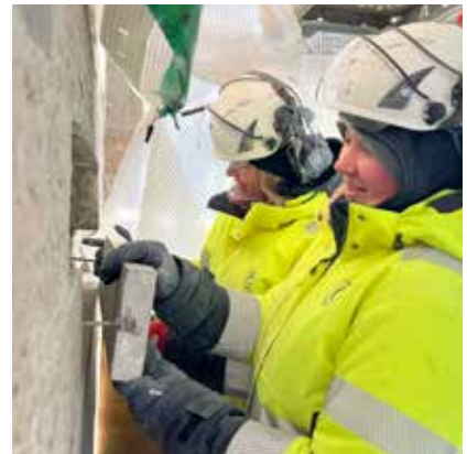
Ytterligare en sten är på väg att monteras fast på domkyrkotornet.
