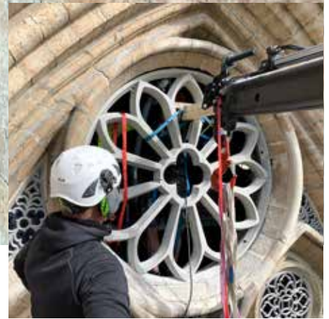
Det nya rosettfönstret som sattes på plats i Domkyrkan 2020 tillverkades i Borghamn.
