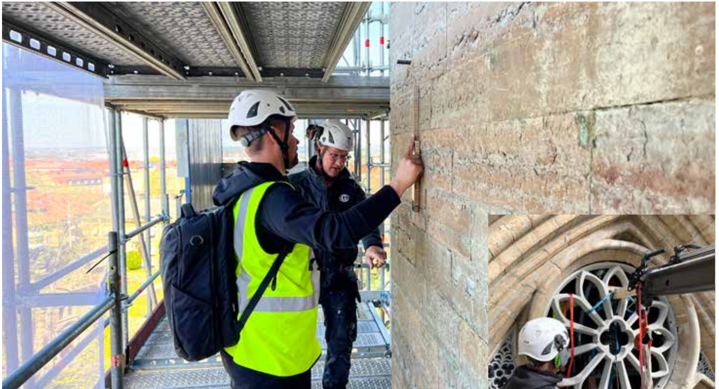
Tim och Stefan inspekterar stenarna på domkyrkotornet för att se vilka som ska bytas.
