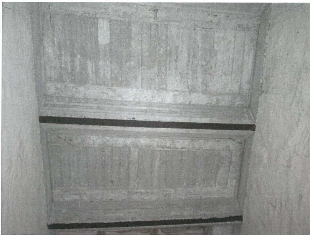
Bild 5. Undersida betongbjälklag i torn.
