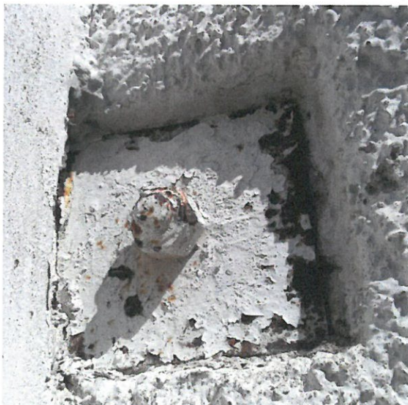
Bild 10. Infästningspunkt nr 3 i fasad.
