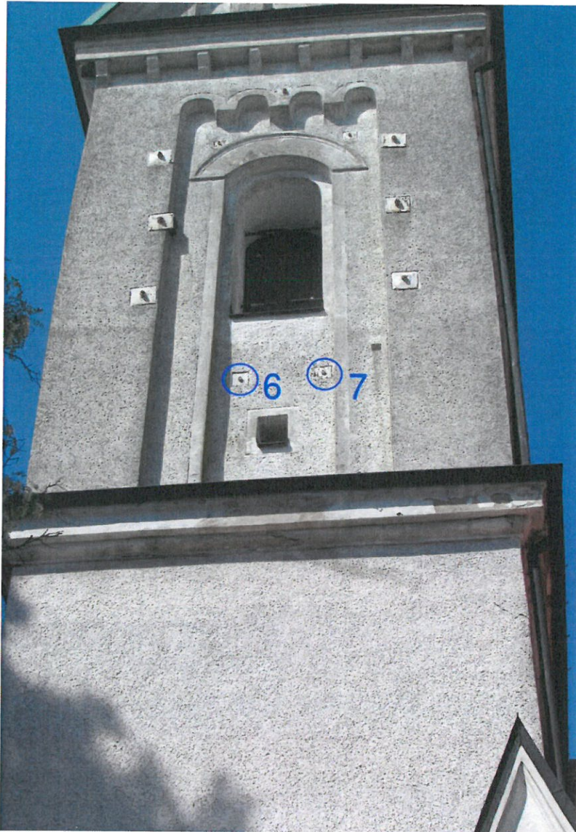
Bild 4. Översikt av fasad mot söder.
