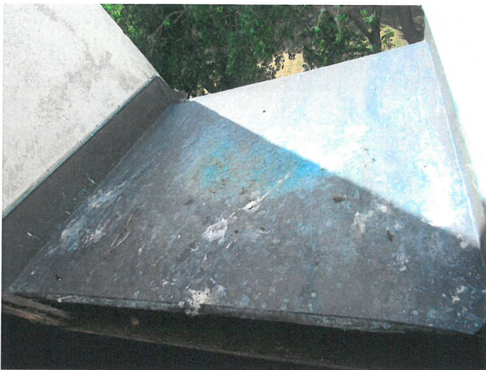
Bild 14. Plåt i öppning ut från tornet.
