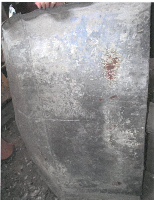
Bild 15. Fönsterplåt i tornet.
