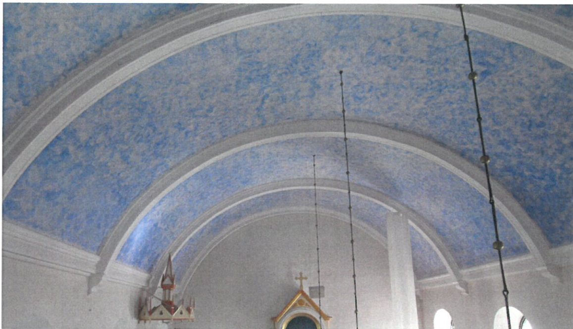
Bild 20. Bågformade putsade takbalkar.
