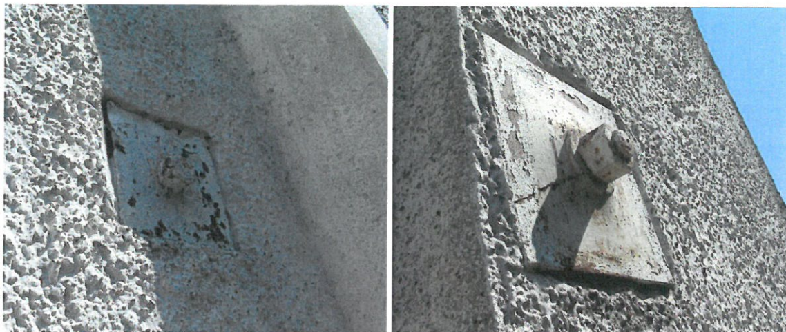
Bild 11 och 12. Infästningspunkt nr 4 och 5 i fasad.
