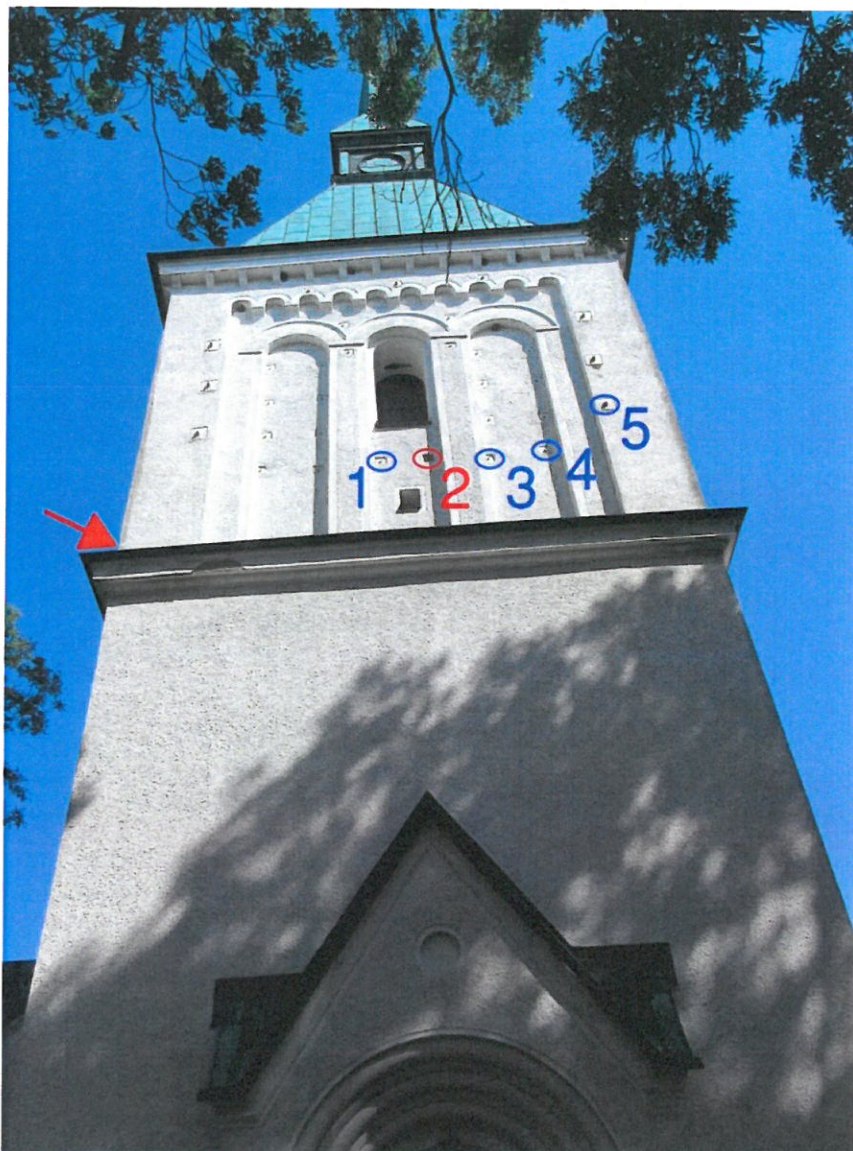
Bild 3. Översikt av fasad mot väst.
