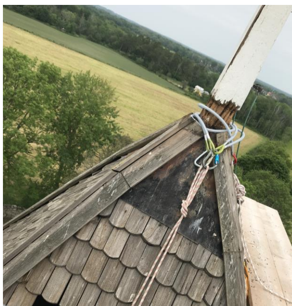
Slitet torntak och murken hjärtstock, Persnäs kyrka Foto: M Kessén
