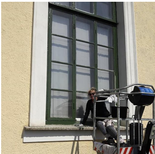
Målning av fönster, Högby kyrka. Foto: L Sörman
