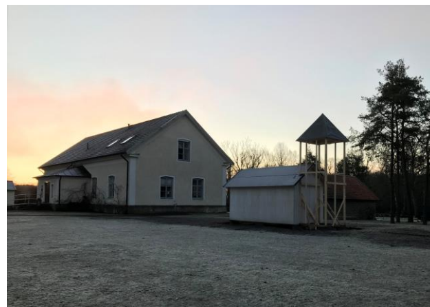
Byggnation av lekkyrka Foto: L Sörman
