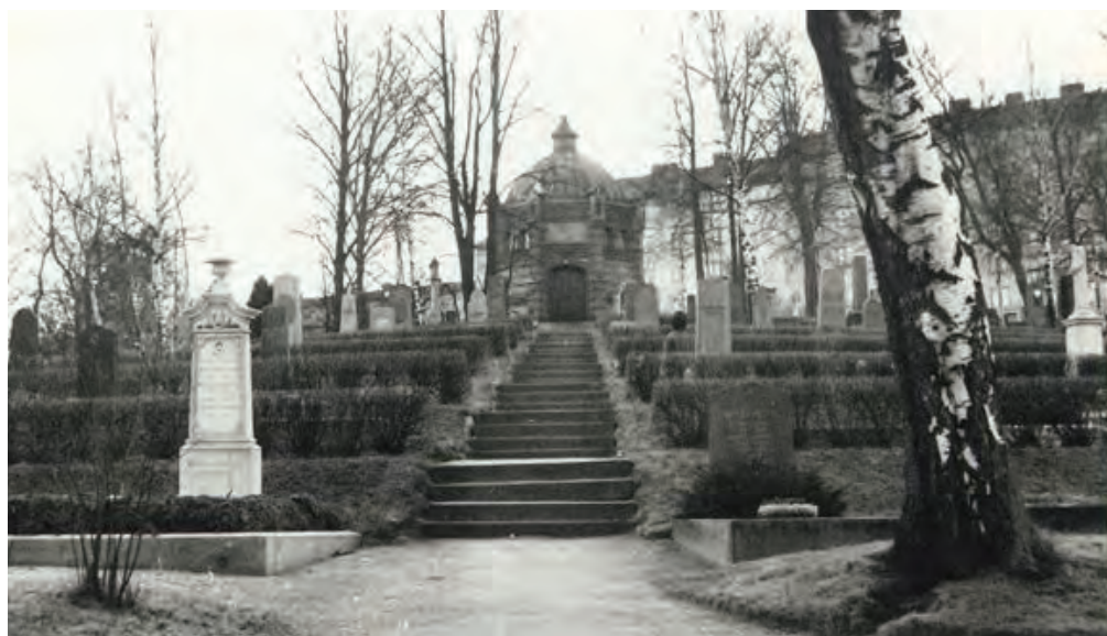
Figur 13. Gången upp mot krematoriet, foto taget på 1950-talet.
