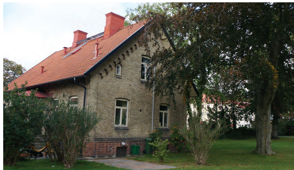
Figur 49. Inspektorbostaden uppfördes 1862, även denna byggnad är ritad av H.J. Strömberg.
