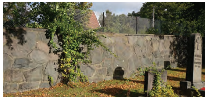
Figur 52. Mot Härlandavägen blir naturstensmuren mer dominerande, också försedd med nätstängsel.
