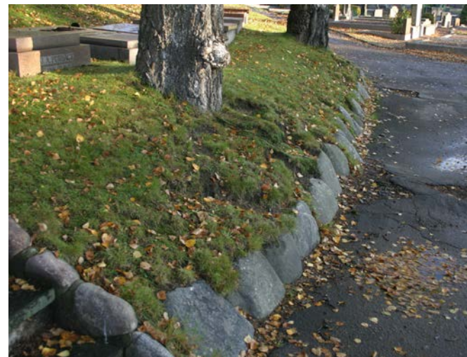
Naturstenskantad gång, där asfalten har bubblat upp till följd av trädets rötter.
