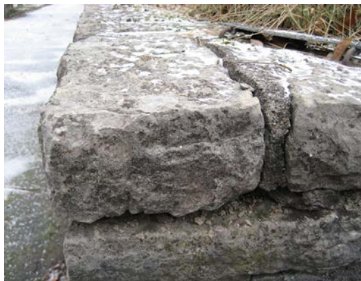
Ett par exempel på hur ilagningar av cementbruk har lossnat.
