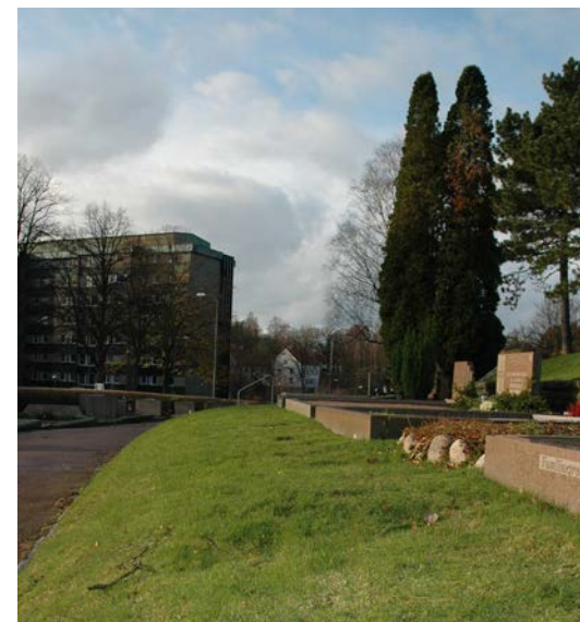
Plattbelagd gång som nästan är helt övervuxen.
