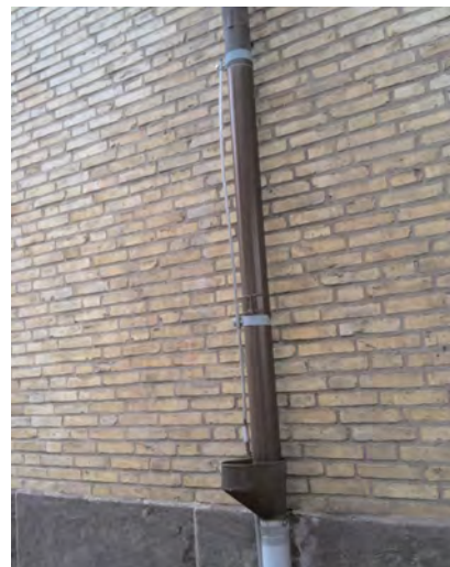
Reparation med brun plåt.
