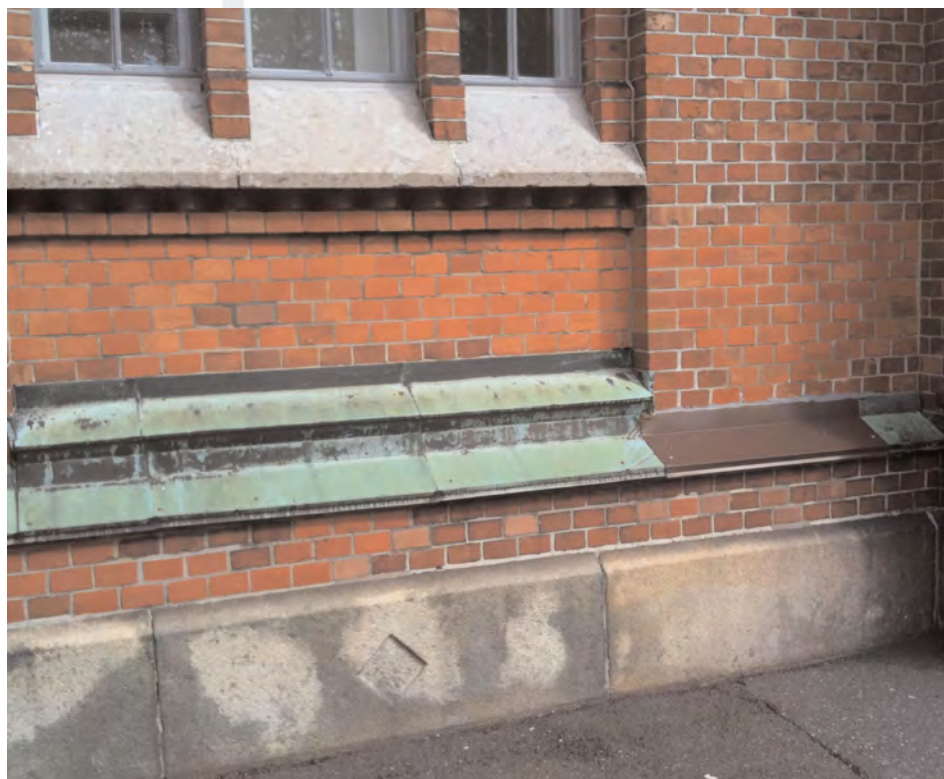
Reparation med brun plåt.
