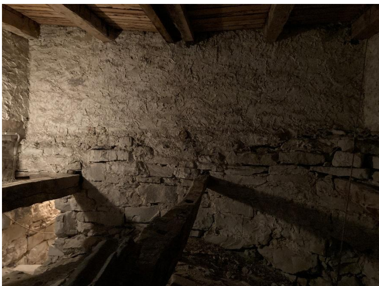
Tornets första övervåning sedd mot söder. Till vänster trappans mynning. Gränsen mellan tornets äldre nedre del och påbyggnaden från 1864 tydlig. Foto JL 2025.
