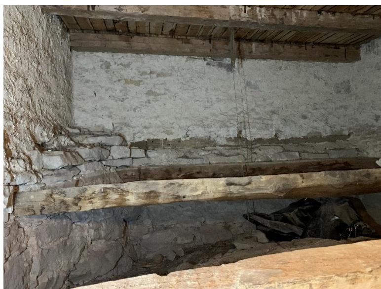
Tornets första övervåning sedd mot väster. Muren har en kraftig utbuktning i sydvästra hörnet. Foto JL 2025.
