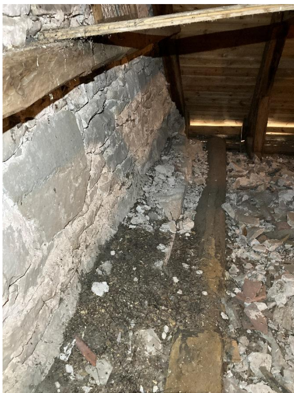
Nedre delen av korets östra gavel med avsats ovanför vilken muren blir smalare och till nedre del sannolikt är medeltida medan gavelmurens övre del förefaller ommurad. Till höger glugg i östra gavelröset, vars smyg på norra sidan utgörs av en byggnadsdetalj, troligen från en sockel. Foto JL 2025.
