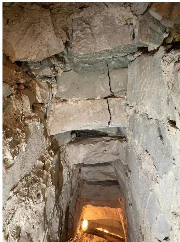
Murtrappans lopp i södra tornmuren, sett nedåt mot väster. Till vänster murtrappans tak, sett mot väster med sprickbildning. Foto JL 2025.
