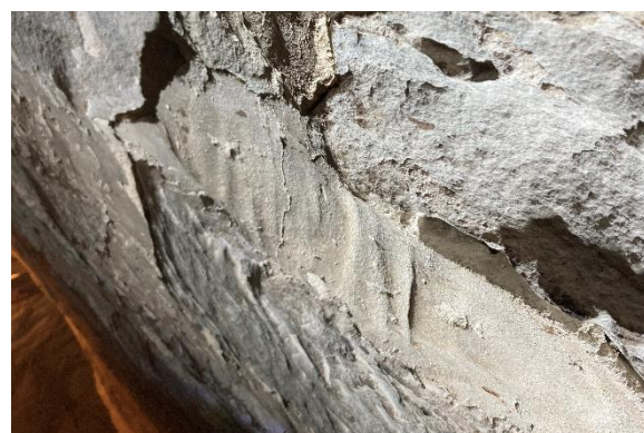
Murtrappan i tornets södra mur, övre delen sedd mot öster. Till höger mursten med huggna kant- eller klyvlinjer samt avtryck, troligen av tyg, i murbruket. Foto JL 2025.
