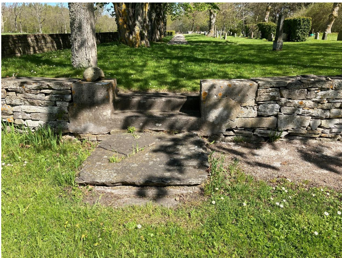
Den sydvästra ingången är öppen med en trappa med två trappsteg i betong tillkommen 1916. Foto ES 2024.
