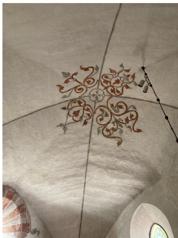
Korvalvets nordöstra konsol samt valvet sett mot sydöst med kalkmålning från byggnadstiden. Foto JL 2025.
