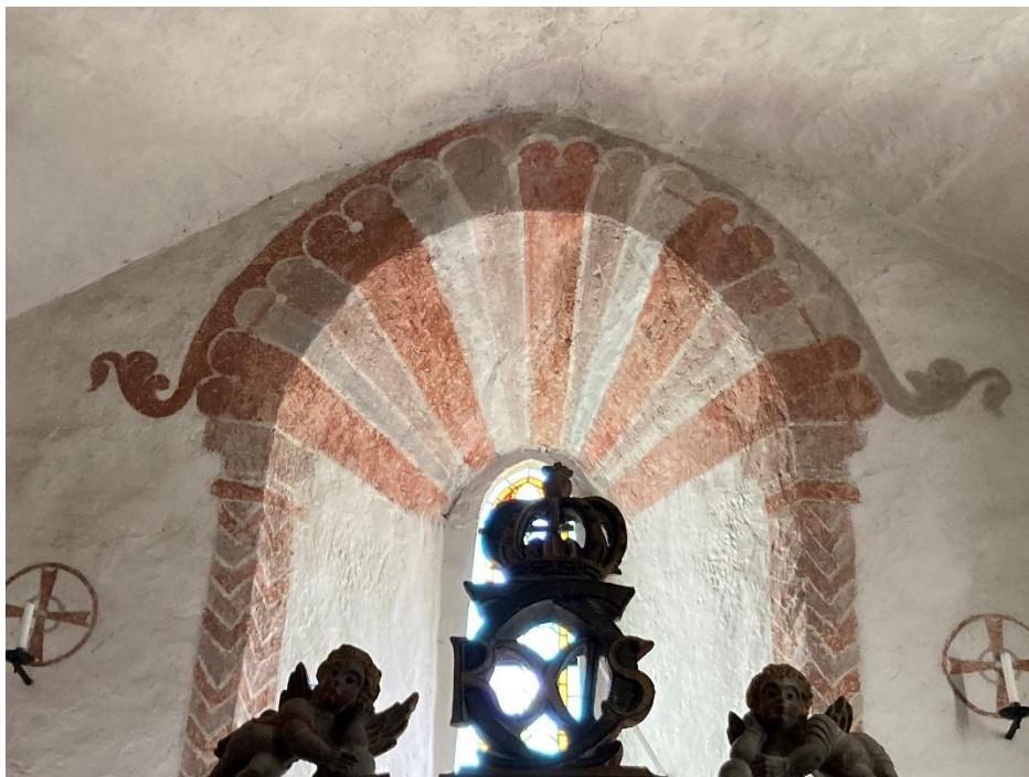
Övre delen av östfönstrets smyg med kalkmålningar från byggnadstiden. Foto JL 2025.
