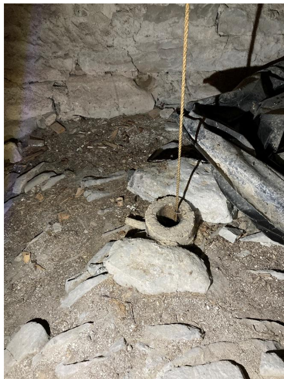
Tornets första övervåning med ovansidan av valvet över ringkammaren. Valvet sett mot norr och till höger sturk, träskoning kring klockrepet, i valvets västra del. Foto JL 2025.
