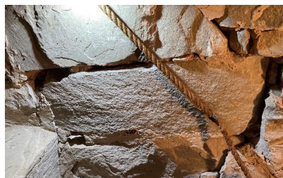
Murtrappans lopp i södra tornmuren, sett nedåt mot väster. Till vänster murtrappans tak, sett mot väster med sprickbildning. Foto JL 2025.
