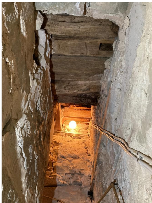
Murtrappan i tornets södra mur, övre delen sedd mot öster. Till höger mursten med huggna kant- eller klyvlinjer samt avtryck, troligen av tyg, i murbruket. Foto JL 2025.
