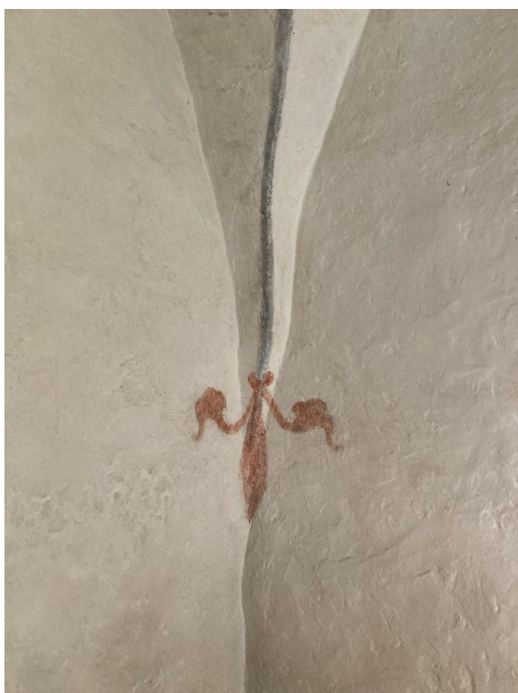
Korvalvets nordöstra konsol samt valvet sett mot sydöst med kalkmålning från byggnadstiden. Foto JL 2025.
