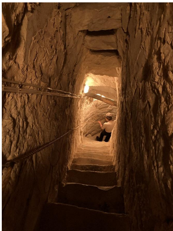
Murtrappans lopp i södra tornmuren, sett nedåt mot väster. Till vänster murtrappans tak, sett mot väster med sprickbildning. Foto JL 2025.
