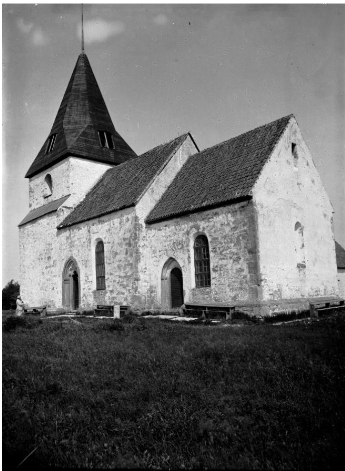
Näs kyrka fotograferad från sydost. Kyrkogården är övervuxen med gräs. Foto Olof Sörling under senare delen av 1800-talet. ATA.
