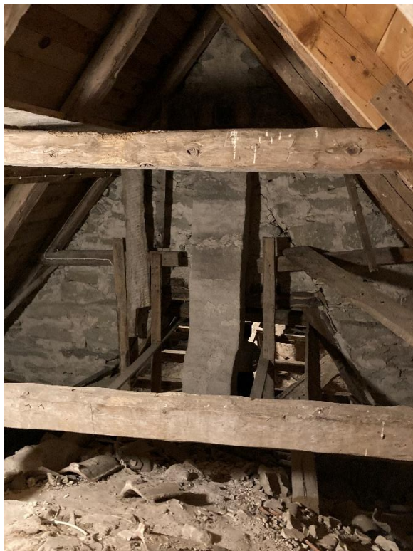
Långhusvinden mot öster med öppning till korvinden i triumfbågmuren, sannolikt medeltida, men delvis igensatt upptill vid yttertakens sänkning, troligen på 1700-talet. Till höger avtryck av skälbräder för öppningen. Brädernas jämnt bearbetade yta tyder på att de var återanvända och kan därför möjligen ha kommit från en tidigare träkyrka. Foto JL 2025.
