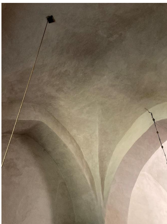
Kalkmålning och ifyllda skeppsröstningar på tornbågens norra vederlagsmur. Till höger ifylld skeppsröstning på ringkammararens södra mur. Foto ES 2025.
