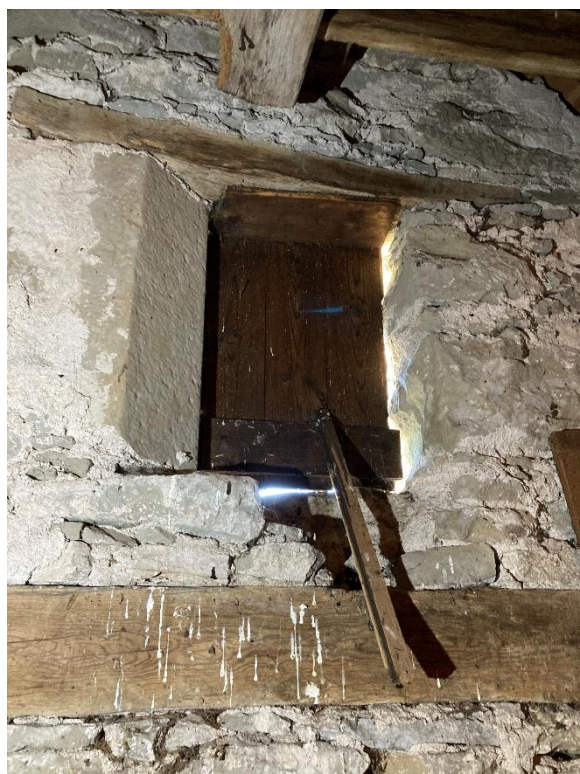
Nedre delen av korets östra gavel med avsats ovanför vilken muren blir smalare och till nedre del sannolikt är medeltida medan gavelmurens övre del förefaller ommurad. Till höger glugg i östra gavelröset, vars smyg på norra sidan utgörs av en byggnadsdetalj, troligen från en sockel. Foto JL 2025.
