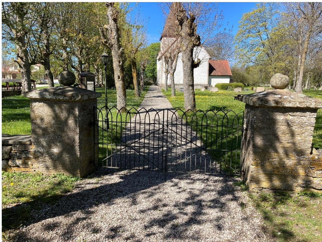
Ingången från sydost har en dubbel järngrind. Den flankeras av murade fyrkantiga stolpar med pyramidformade överliggare krönte av klot. Foto ES 2024.
