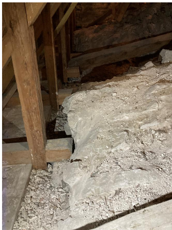
Långhusvinden mot öster. Till höger långhusvalvens anslutning till sidomurarna som visar hur sköldmurarna skjuter över muren. Foto JL 2023.
