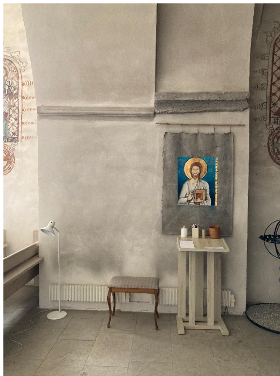
Tornbågen sedd från ringkammaren mot sydöst. Till höger tornbågens södra vederlag. De dubbla bågarna visar att tornbågen var förberedd innan tornet byggdes. Foto JL 2023.
