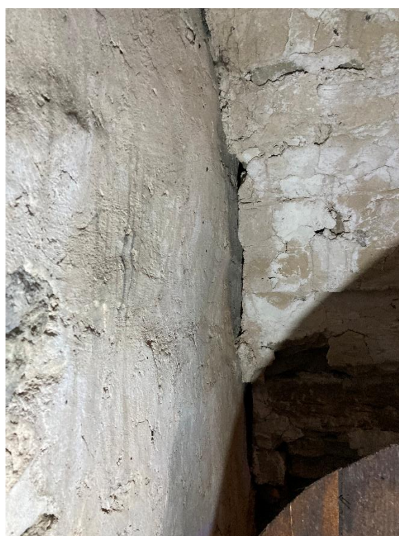
Murytan i sparbågen sedd uppåt mot norr och söder och visar hur putsen fortsätter obruten in bakom muren. Ytan tillhör långhusets västgavel och visar att putsen är från 1200-talet, innan tornet byggdes mot gaveln. Foto JL 2023.
