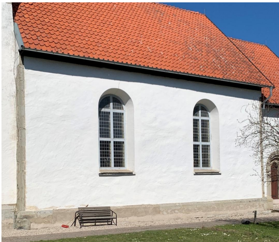
Långhusets sydfasad. Foto JL 2023.
