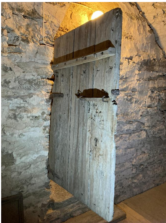
Dörren in till andra övervåningen, gjord av tre plankor, möjligen medeltida. Till höger anslutningen mot valvet, visande hur sköldmuren murades upp med en avsats och avtrycken av valvformen visar hur bräderna lades horisontellt i svicklarna och sedan diagonalt mellan sidomurarna, upp mot rummets mitt. Foto JL 2023.
