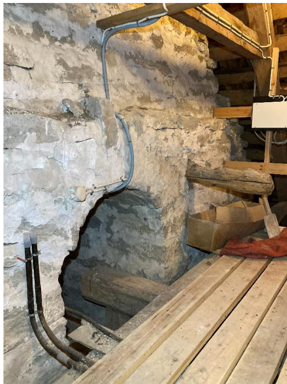
Passage mellan tornets första övervåning och långhusvinden, sedd från väster och sydöst. Foto JL 2023. Öppningen är placerad i långhusets västgavel och var synlig utifrån innan tornet byggdes.
