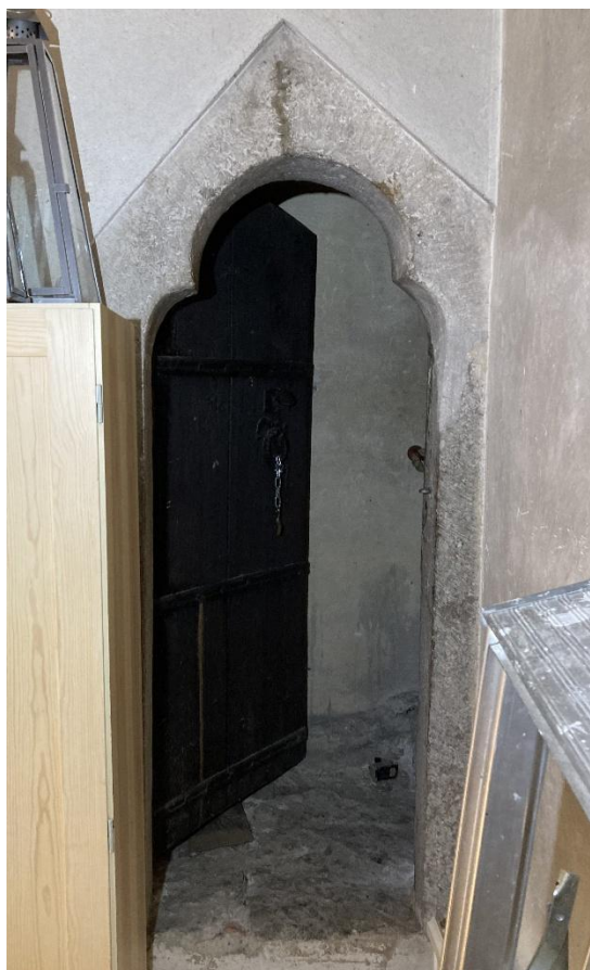
Ingång i ringkammarens sydvästra hörn till torntrappan. Till höger öppningens krön, sett utifrån och inifrån trappan. Foto JL 2023.
