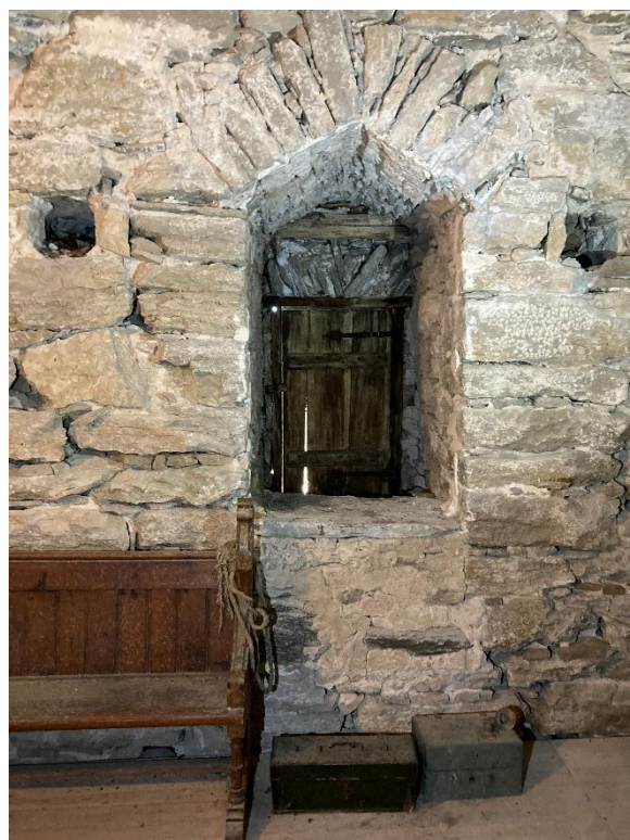
Valvet ovanför tornets andra övervåning. Till höger lastport och fästen för bärbjälkar i andra övervåningens södra vägg. Foto JL 2023.
