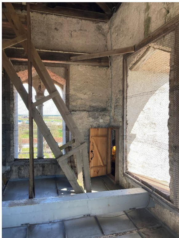
Klockvåningen mot sydöst och söder. Foto JL 2023.
