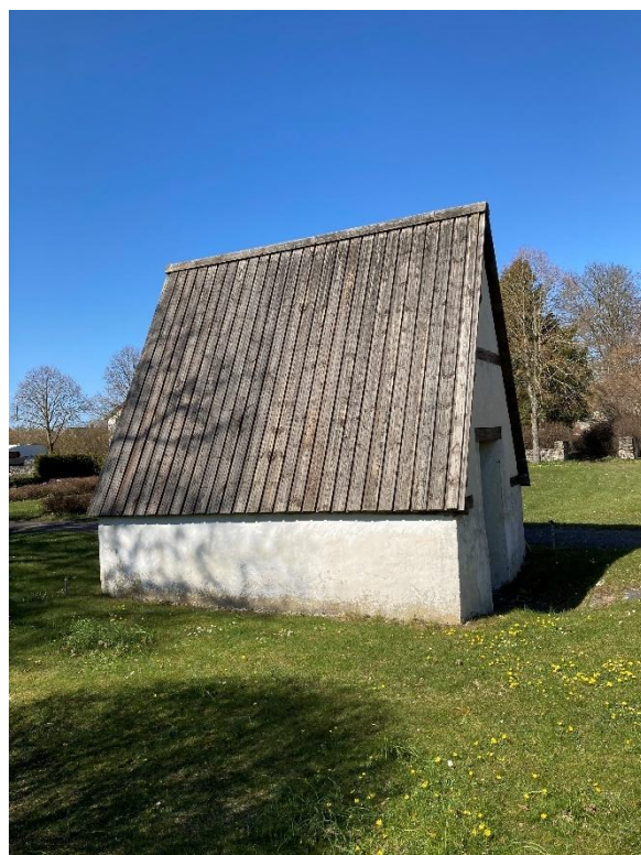
Tidigare begravningskapell, nu materialbod nordost om kyrkan. Uppfört efter ritningar av H. Du Rietz 1941. Foto ES 2023.
