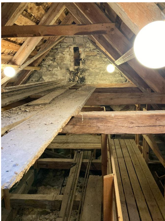
Långhusvinden mot öster. Till höger långhusvalvens anslutning till sidomurarna som visar hur sköldmurarna skjuter över muren. Foto JL 2023.
