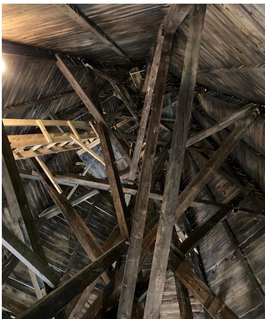
Tornets murkrön samt tornhuvens inre konstruktion och huvens inre sett rakt uppåt. Foto JL 2023.
