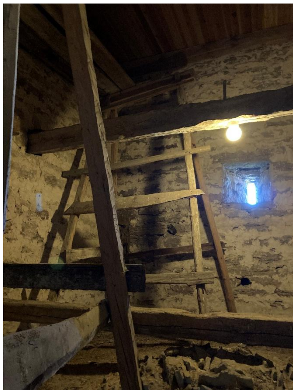
Första övervåningen sedd mot väster samt mot sydväst, snett uppåt och snett nedåt mot nedre tornvalvets ovansida. Bockarna, troligen för brädupplag, genom inhugget årtal daterade 1866. Foto JL 2023.
