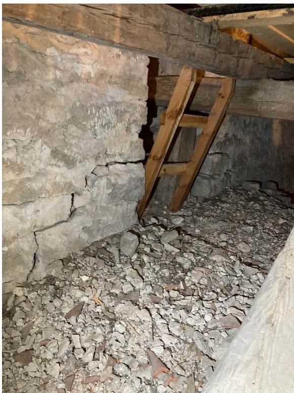
Nedre delen av passagen från tornet till långhusvinden, sedd från sydöst. Till höger del av murverket norr om öppningen med avtryck av textil som tryckts mot bruket. Foto JL 2023.
