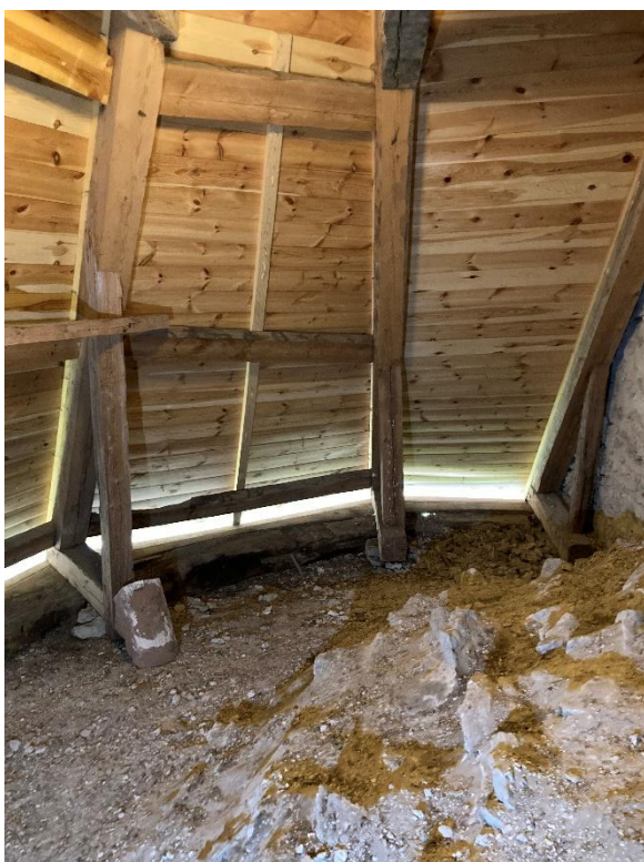
Absidens sedd mot söder. Till höger del av absidmurens remstycke med urtag för en tidigare takstol. Foto JL 2023.
