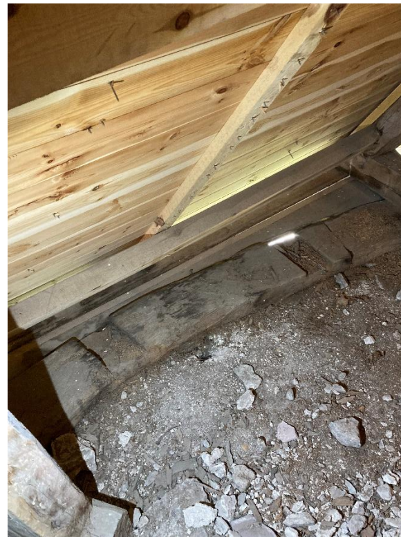
Absidens sedd mot söder. Till höger del av absidmurens remstycke med urtag för en tidigare takstol. Foto JL 2023.
