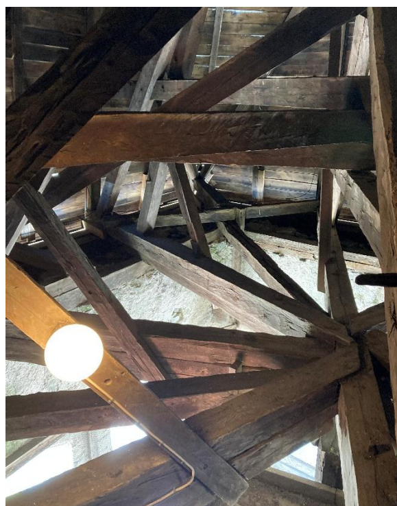
Klockvåningen mot norr med klockstolen av bjälkar mellan murarna och stolpar med fasade hörn. Nedan tornhuvens stjärna av bindbjälkar, understöta av en mittstolpe, sedd underifrån och ovanifrån. Foto JL 2023.
