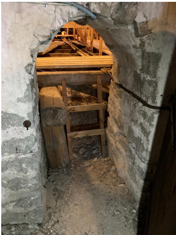
Passage mellan tornets första övervåning och långhusvinden, sedd från väster och sydöst. Foto JL 2023. Öppningen är placerad i långhusets västgavel och var synlig utifrån innan tornet byggdes.
