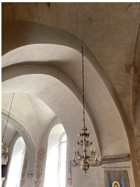
Tornbågen sedd från ringkammaren mot sydöst. Till höger tornbågens södra vederlag. De dubbla bågarna visar att tornbågen var förberedd innan tornet byggdes. Foto JL 2023.
