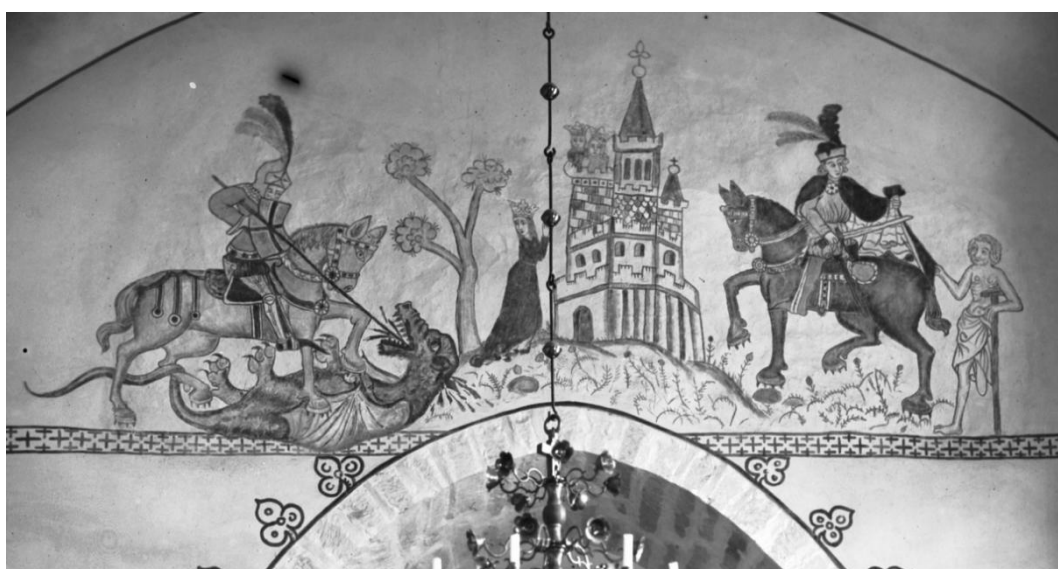
Kalkmålningen ovanför triumfbågen efter restaureringen 1896. Foto Carl R. af Ugglas 1907-1912, ATA.
