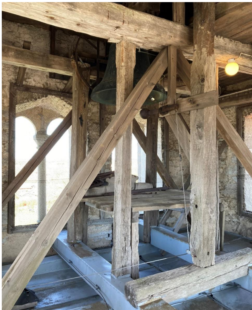
Klockvåningen mot norr med klockstolen av bjälkar mellan murarna och stolpar med fasade hörn. Nedan tornhuvens stjärna av bindbjälkar, understöta av en mittstolpe, sedd underifrån och ovanifrån. Foto JL 2023.
