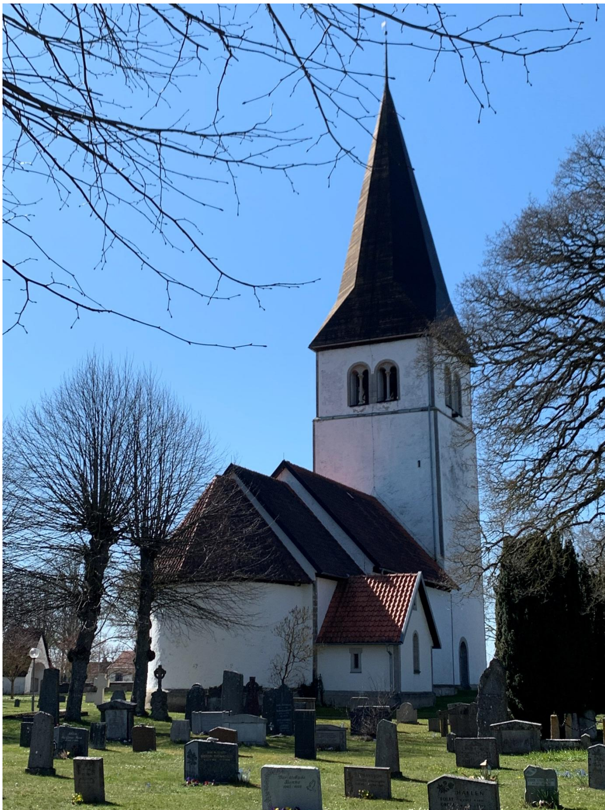
Exteriör från nordöst. Foto JL 2023.
