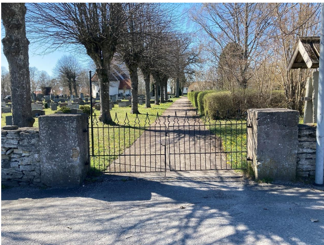
Ingång i nordost. En dubbel järngrind i samma utformning som järngrinden i sydost. Grinden flankeras av murade stolpar. Foto ES 2023.
