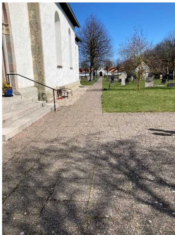
Gång med betongplattor längs med södra långhuset. Foto ES 2023.
