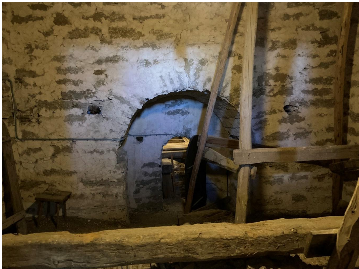
Tornets första övervåning mot öster med sparbåge kring passagen till kyrkvinden. Foto JL 2023.
