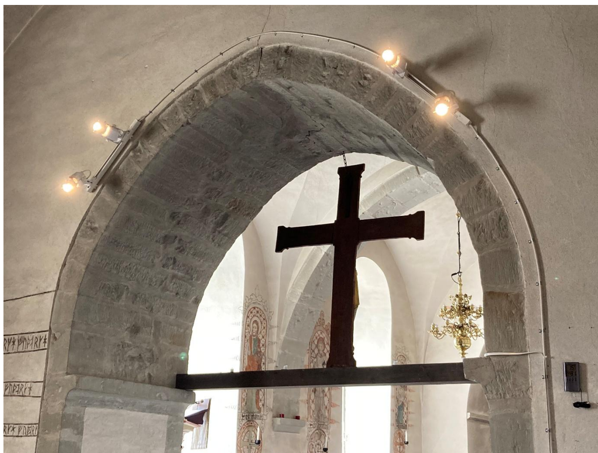
Triumfbågens övre del från nordöst. Den svagt spetsbågiga formen härrör sannolikt från en ombyggnad. Sprickan över bågen talar för att reparationer kan ha behövts. Foto JL 2023.
