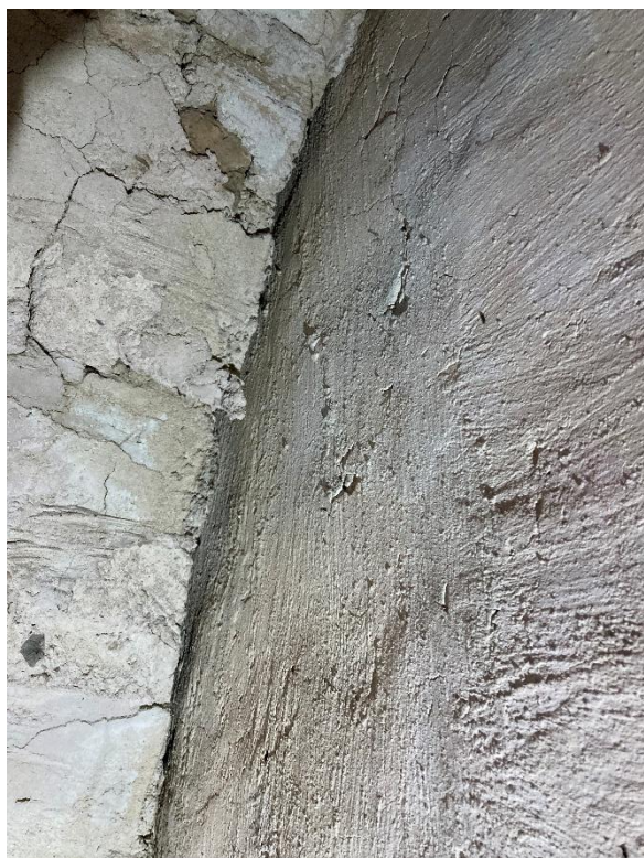
Murytan i sparbågen sedd uppåt mot norr och söder och visar hur putsen fortsätter obruten in bakom muren. Ytan tillhör långhusets västgavel och visar att putsen är från 1200-talet, innan tornet byggdes mot gaveln. Foto JL 2023.
