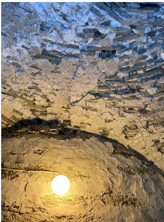
Dörren in till andra övervåningen, gjord av tre plankor, möjligen medeltida. Till höger anslutningen mot valvet, visande hur sköldmuren murades upp med en avsats och avtrycken av valvformen visar hur bräderna lades horisontellt i svicklarna och sedan diagonalt mellan sidomurarna, upp mot rummets mitt. Foto JL 2023.
