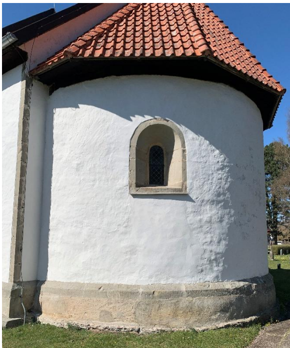
Absiden från sydöst och öster. Foto JL 2023.
