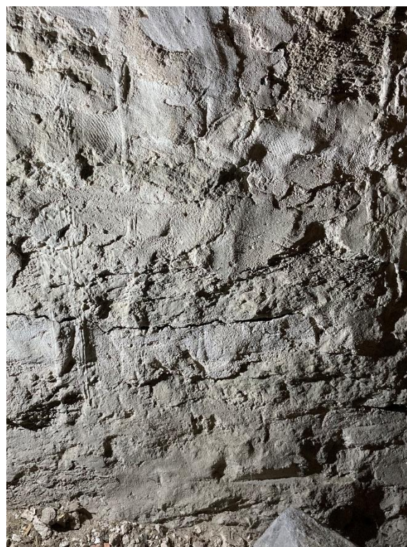
Nedre delen av passagen från tornet till långhusvinden, sedd från sydöst. Till höger del av murverket norr om öppningen med avtryck av textil som tryckts mot bruket. Foto JL 2023.
