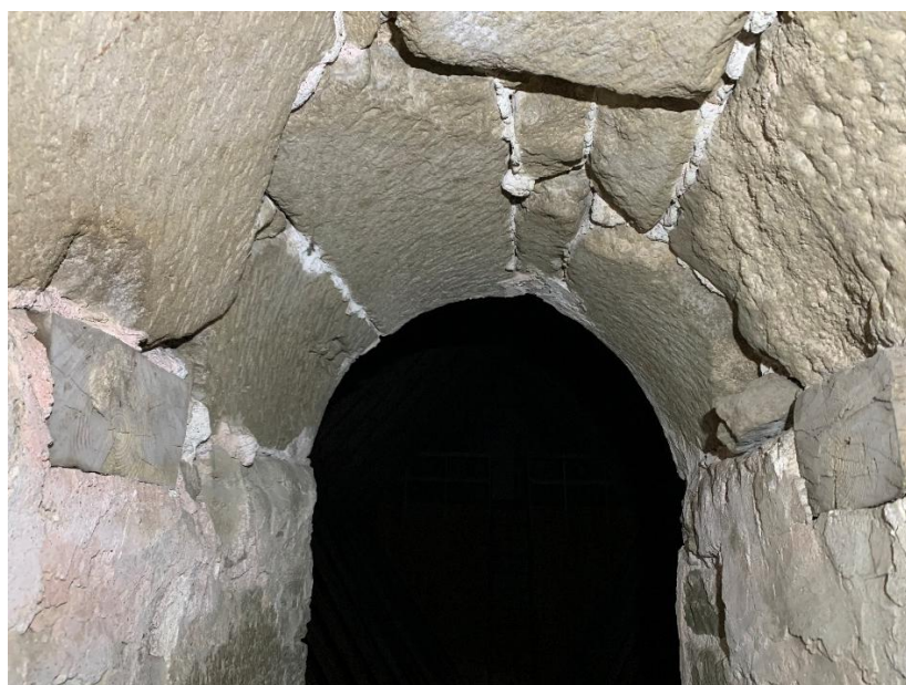
Passage till långhusvinden. Till höger detalj av murverket i första övervåningens östra mur med kvaderritsar. Nedan detalj av passagens vältning samt en avkapad inmurad bjälke. Foto JL 2023.
