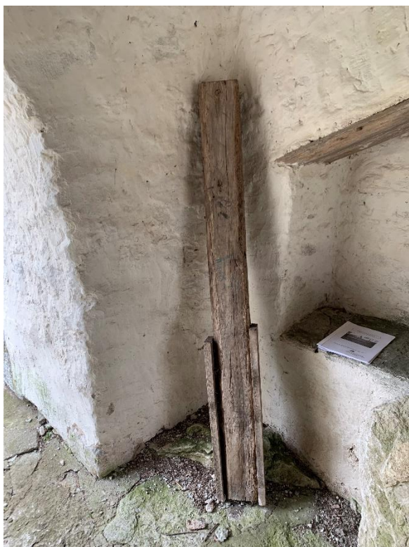
Den sydöstra nischen i den västra stigluckan. Foto JL 2023.
