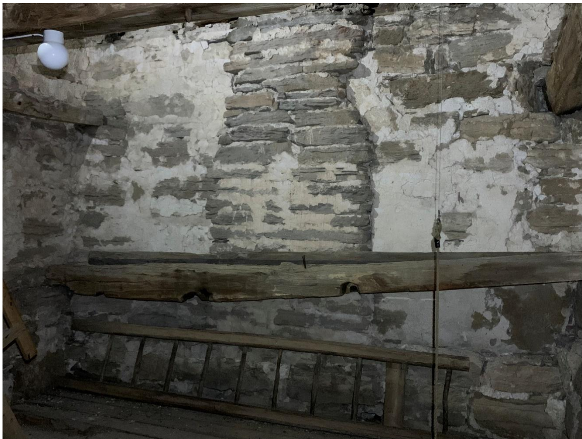
Tredje övervåningen mot norr med igenmurad ljudglugg. Delar av gluggens bågstenar har bevarats på höger sida. Foto JL 2023.
