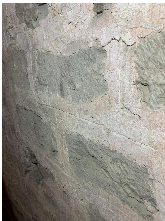
Passagen från tornet till långhusvinden, sedd från öster. Till höger parti av muren söder om passagen visande kvaderritsar i fogarna. Foto JL 2023.
