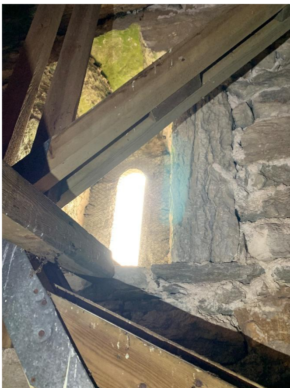
Övre delen av korets östra gavel med ljusöppning, vars yttre omfattning sannolikt kommer från det äldre koret. Foto JL 2023.
