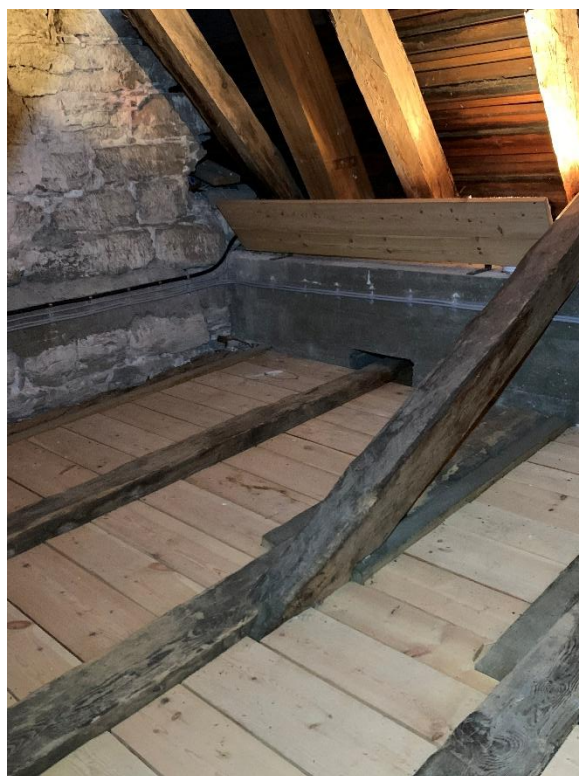
Det tidigmedeltida taket samt över det takstolen från 1960-talet till det nuvarande yttertaket sedda mot öster. Till höger långhusvindens nordvästra hörn med ett stycke av påmurningen i betong från 1960-talet. Foto JL 2023.
