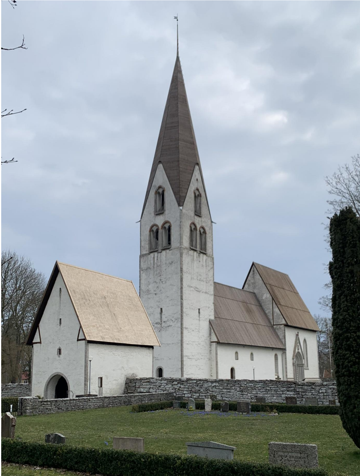
Exteriör från sydväst. Foto JL 2023.
