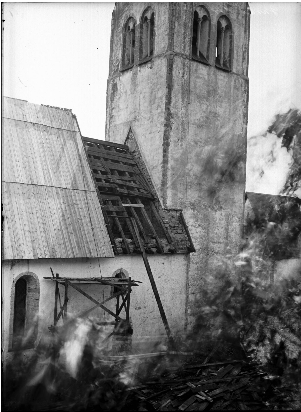
Tornets nedre del från nordöst under takarbeten, varvid resterna av det ursprungliga långhustaket var frilagda och långhusets ursprungliga takvinkel framgick i förhållande till tornet. Foto Alfred Edle 1931, ATA.
