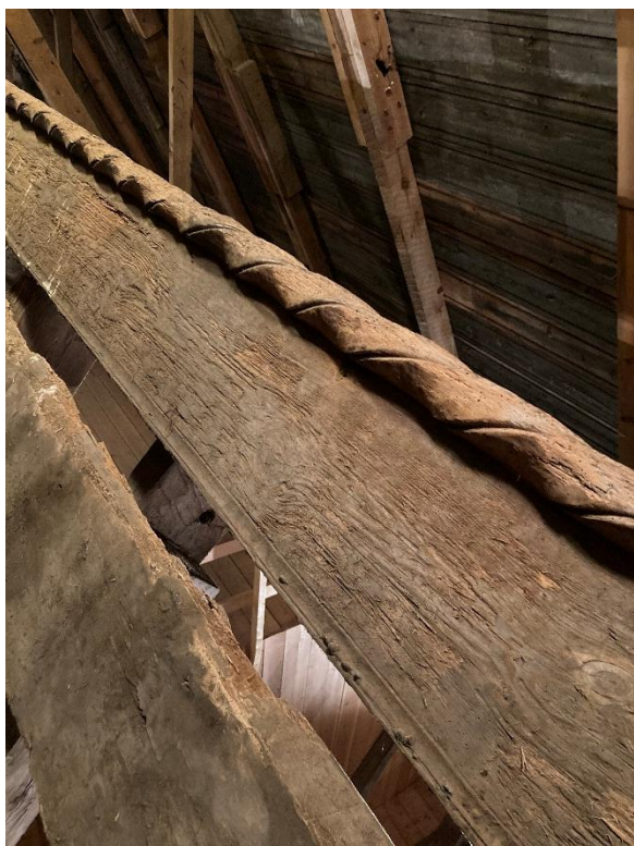
Del av det tidigmedeltida takets skulpterade nockbräda samt bevarat parti av spånklädseln. Foto ES respektive JL 2023.
