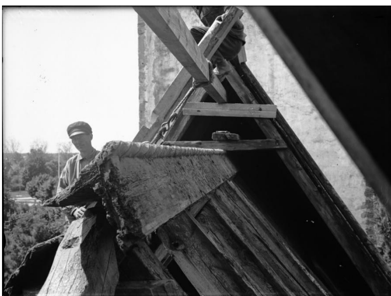
Långhusets äldre yttertak frilagt under takets ombyggnad. Taknocken sedd från nordöst. Foto Alfred Edle 1931, ATA.
