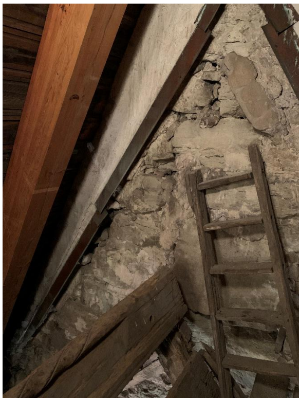
Det tidigmedeltida taketsnockbräda, sedd närmast tornmuren i väster samt underifrån i öster. Foto JL 2023.
