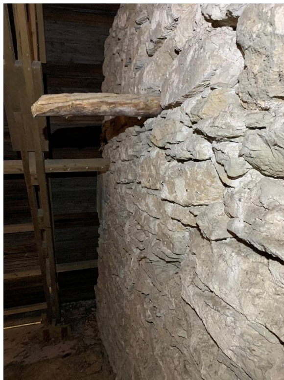
Del av korvinden mot sydöst med takstolen från 1960-talet. Till höger parti av norra delen av korets östra gavel med kvarsittande ställningsvirke. Foto JL 2023.
