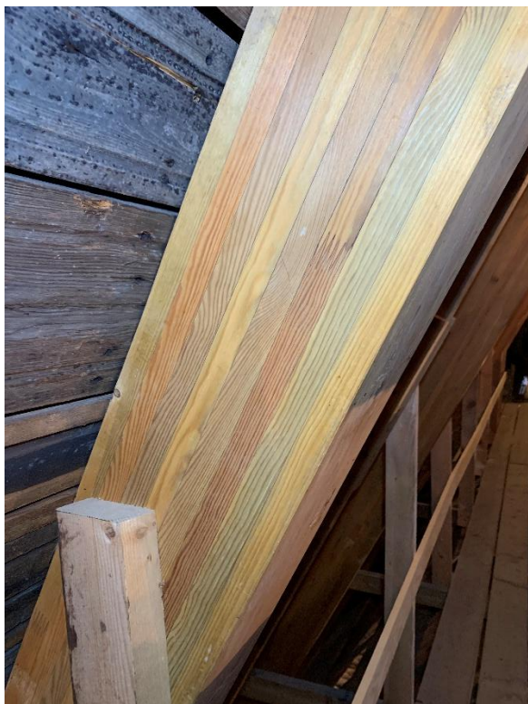
Högben av limträ i långhusets takstol från 1960-talet. Till höger ingången till korvinden samt takstolen över långhusets östra del. Foto JL 2023.
