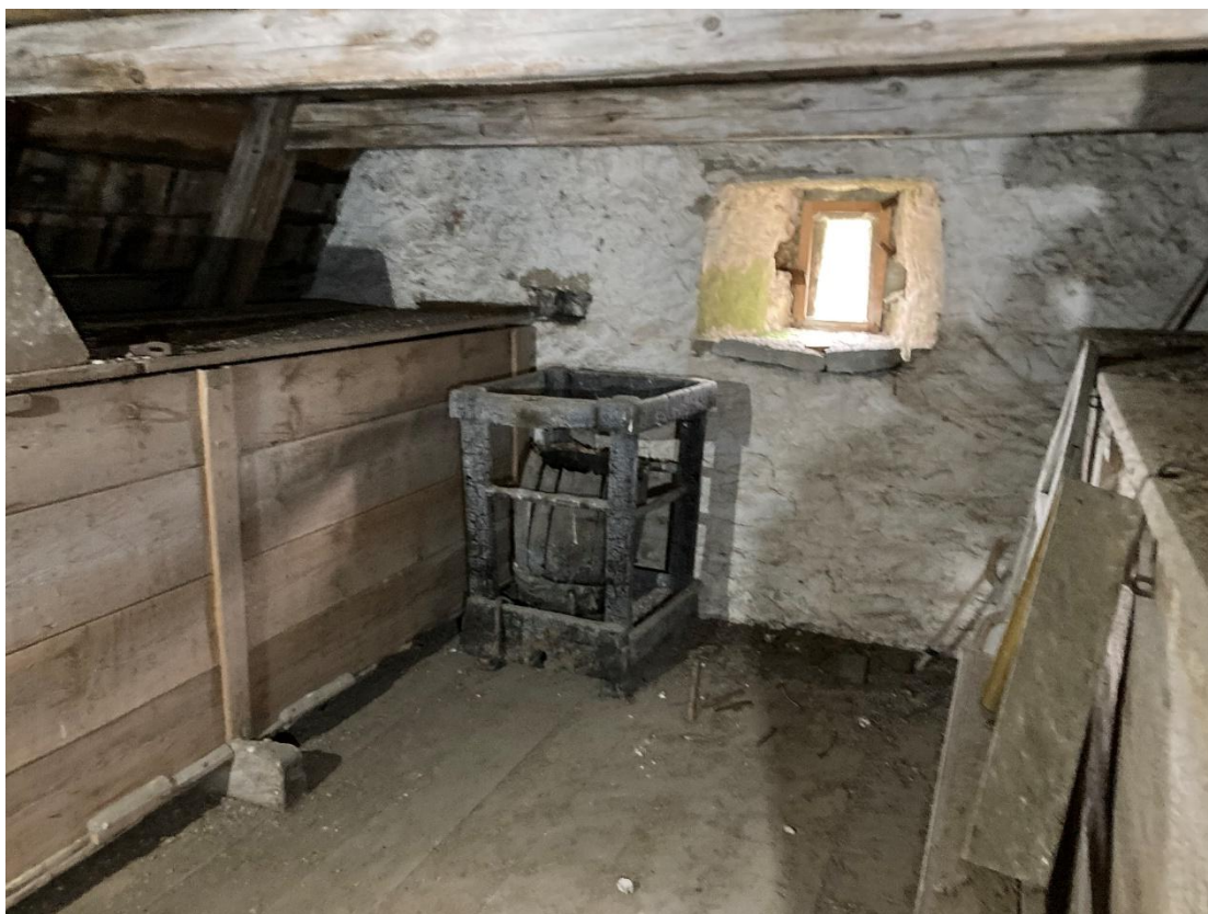
Den västra stigluckan. Andra våningen. Foto JL 2023.
