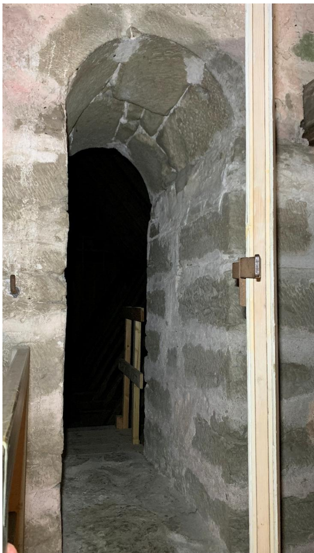
Passage till långhusvinden. Till höger detalj av murverket i första övervåningens östra mur med kvaderritsar. Nedan detalj av passagens vältning samt en avkapad inmurad bjälke. Foto JL 2023.
