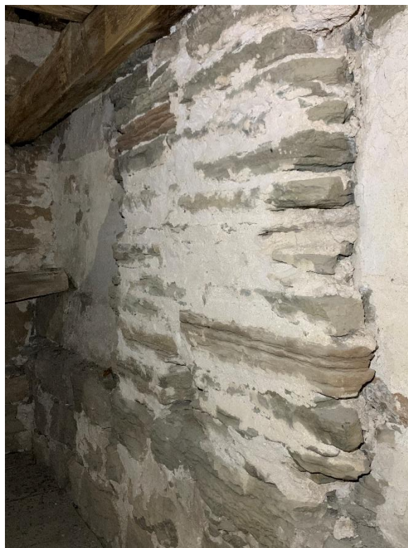
Tornets tredje övervåning mot sydväst samt del av östra muren med framspringande igenmurning av en av det då lägre tornets ursprungliga ljudgluggar. Foto JL 2023.
