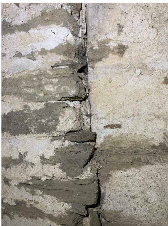
Igenmurningens skarv vid en av de tidigare ljudgluggarna visande hur putsen fortsätter in i skarven. Till höger tvärgående bjälke i våningen med olika urtag. Foto JL 2023.
