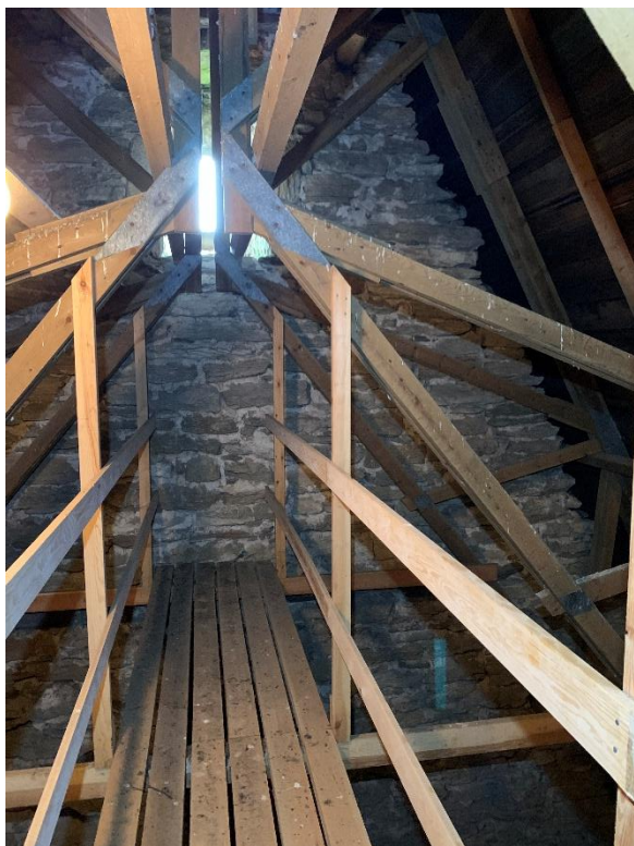
Övre delen av korets östra gavel med ljusöppning, vars yttre omfattning sannolikt kommer från det äldre koret. Foto JL 2023.
