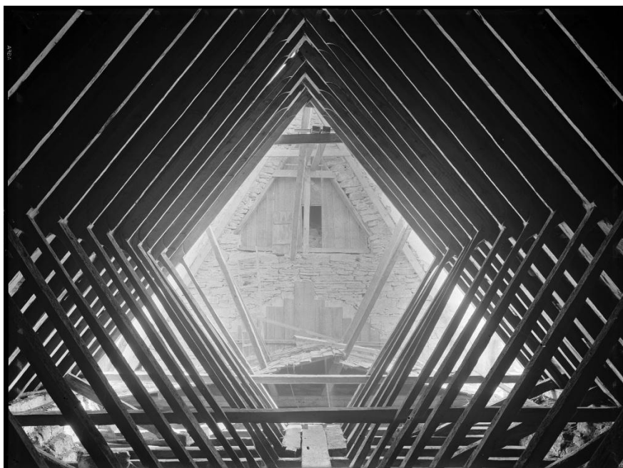
Långhusvinden under pågående takarbeten 1930. Ovan mot öster, i fonden korets frilagda västra gavel med öppning till vinden och brädpanel för triumfbågens övre del. Nedan vinden mot väster med dragbjälkar. Till höger med styrbjälken med gångbräda upplyft. Foto Alfred Edle 1931, ATA.
