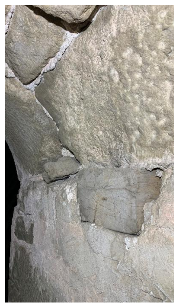
Passage till långhusvinden. Till höger detalj av murverket i första övervåningens östra mur med kvaderritsar. Nedan detalj av passagens vältning samt en avkapad inmurad bjälke. Foto JL 2023.
