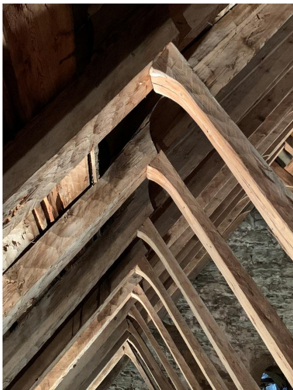
Detaljer av den tidigmedeltida takstolen över långhuset, vars detaljer ursprungligen var synliga från kyrkorummet. Foto JL 2023.
