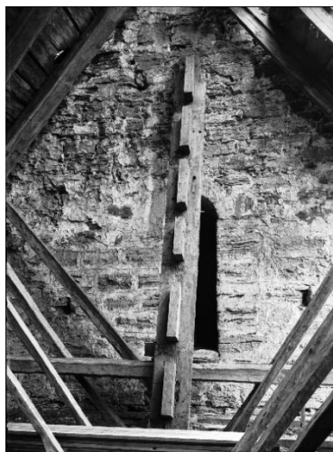
Långhusvinden under pågående takarbeten 1930. Ovan mot öster, i fonden korets frilagda västra gavel med öppning till vinden och brädpanel för triumfbågens övre del. Nedan vinden mot väster med dragbjälkar. Till höger med styrbjälken med gångbräda upplyft. Foto Alfred Edle 1931, ATA.
