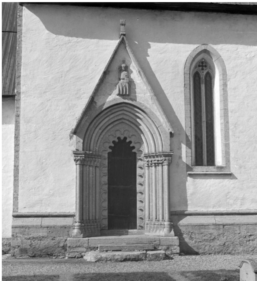
Korportalens dörrblad. Foto JL 2023. Ovan till höger korportalen och korets södra fönster. Foto 1917, ATA. Nedan korportalen och korets södra fönster. Foto Sören Hallgren 1959, ATA.
