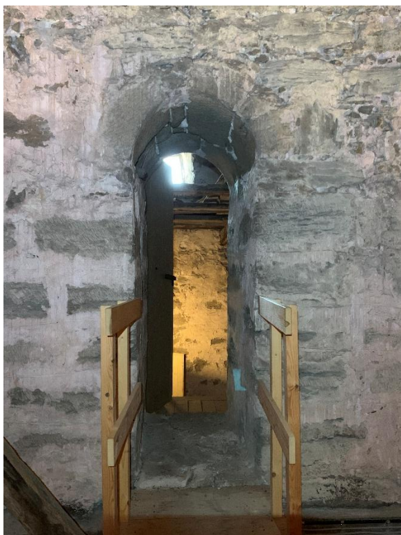
Passagen från tornet till långhusvinden, sedd från öster. Till höger parti av muren söder om passagen visande kvaderritsar i fogarna. Foto JL 2023.
