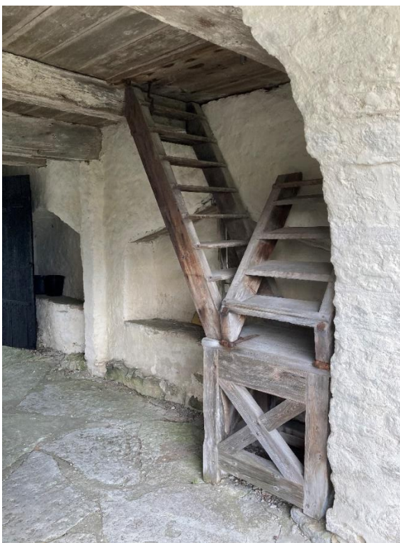
Västra stigluckan. Väster om trappan syns två nischer. En trätrappa leder upp till den första våningen. Foto ES 2023.
