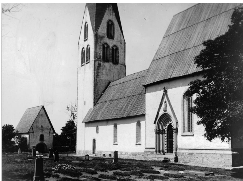
Långhuset norra fasad från nordväst samt västra delen av långhuset från sydväst. Foto Berit Wallenberg 1928, ATA. Till vänster kyrkans södra fasad. Foto ca 1930, ATA.
