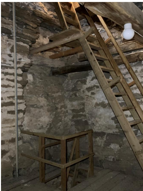
Tornets tredje övervåning mot sydväst samt del av östra muren med framspringande igenmurning av en av det då lägre tornets ursprungliga ljudgluggar. Foto JL 2023.
