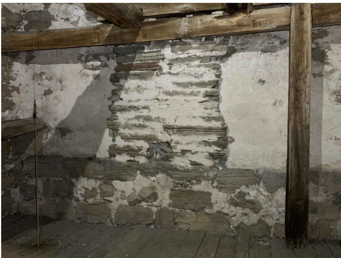
Tornets tredje övervåning mot öster med igenmurad ljudglugg. De putsade partierna talar för att klockvåningens väggar var putsade före påbyggnaden vid 1200-talets mitt. Foto JL 2023.
