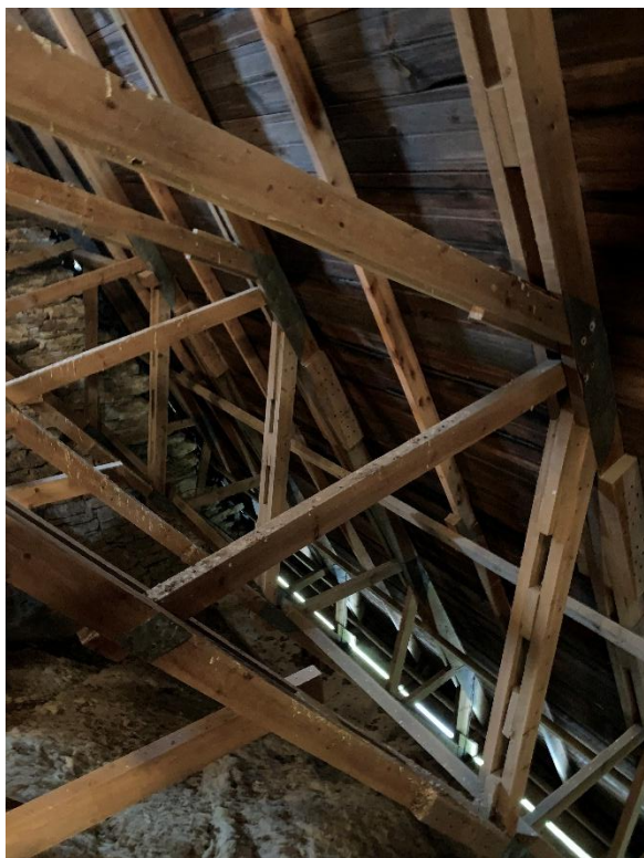
Del av korvinden mot sydöst med takstolen från 1960-talet. Till höger parti av norra delen av korets östra gavel med kvarsittande ställningsvirke. Foto JL 2023.
