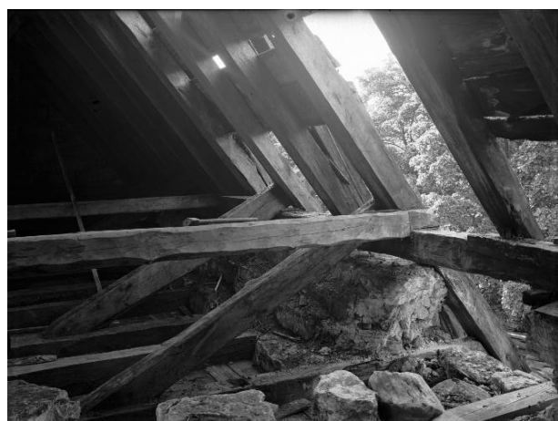
Långhusets murkrön frilagt under takarbeten. Till höger styrbjälken från norr medan delar av innertakets panel är avlägsnad under restaurering. Foto Alfred Edle 1931 respektive Erik Olsson 1968, ATA.
