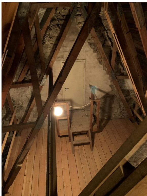
Högben av limträ i långhusets takstol från 1960-talet. Till höger ingången till korvinden samt takstolen över långhusets östra del. Foto JL 2023.
