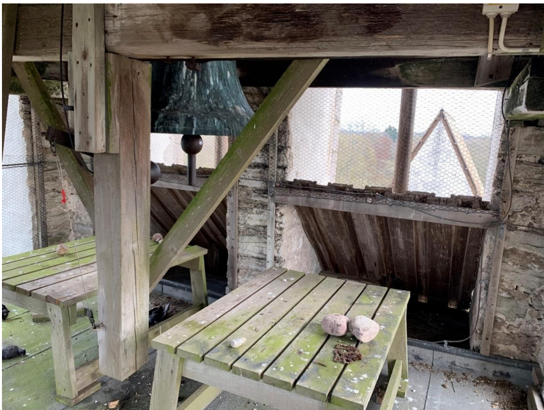
Klockvåningen mot öster. Foto JL 2023.
