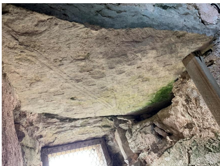
Ljusglugg mot söder i tornets andra övervåning med övertäckning bestående av ett bildstensfragment med synligt mönster, troligen av ett fartygssegel. Foto JL 2023.
