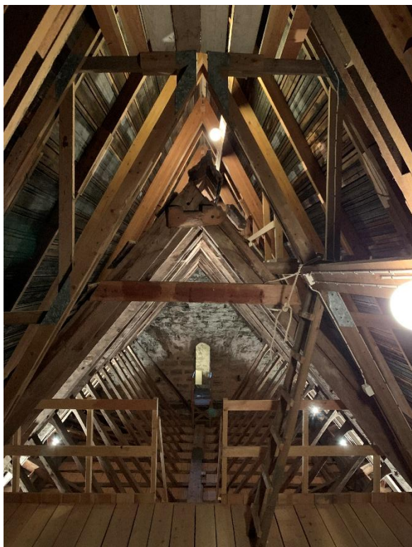
Långhusets tidigmedeltida takstol sedd mot väster. Till höger med del avnockbrädan och underpanel till spånklädseln. Foto JL 2023.
