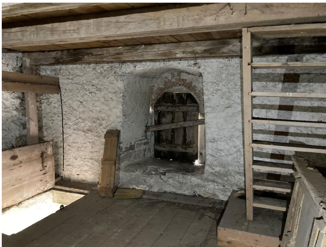
Den västra stigluckan. Första våningen. Foto JL 2023.
