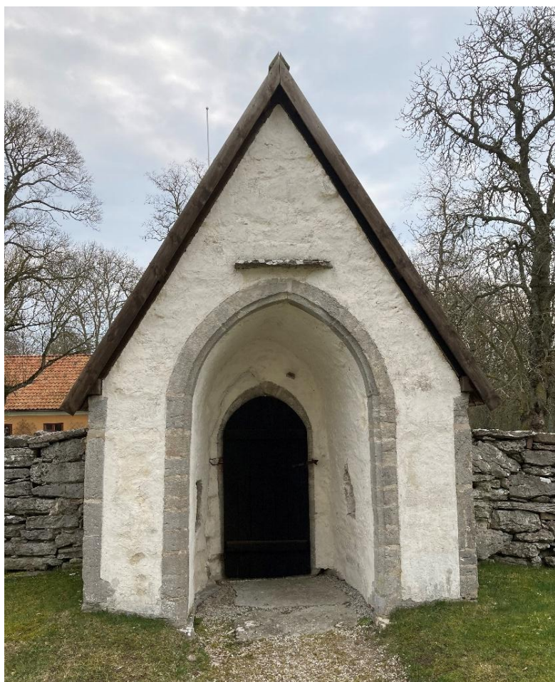
Den östra stigluckan, "Prästluku", fotograferad från väster. Portöppningen åt prästgården är förminskad. Över portalen finns en utskjutande stenplatta vilket kan vara en indikation på att det har funnits en skulptur här. Foto ES 2023.
