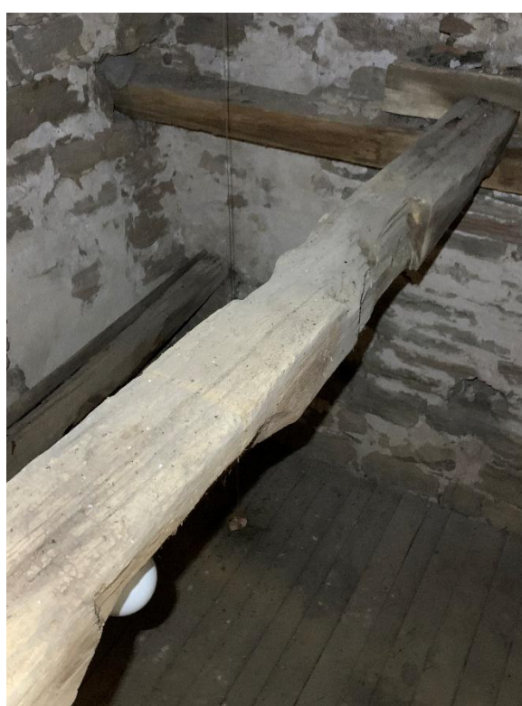
Igenmurningens skarv vid en av de tidigare ljudgluggarna visande hur putsen fortsätter in i skarven. Till höger tvärgående bjälke i våningen med olika urtag. Foto JL 2023.
