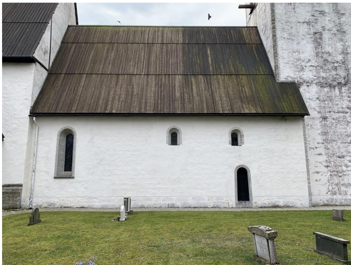
Långhusets norra fasad. Foto JL 2023.
