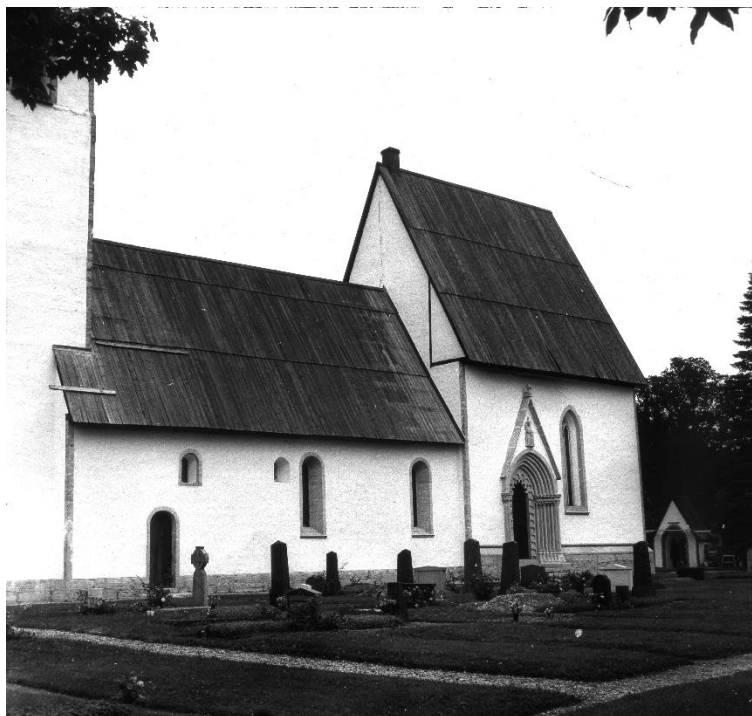
Långhuset och koret från sydväst på 1960-talet. Det östra av långhusets ursprungliga fönster återupptaget och det större fönstret intill, sannolikt medeltida men helt omgestaltat 1869, ännu ej igensatt. Foto Kungl. Konsthögskolan ca 1968 (Alvin).
