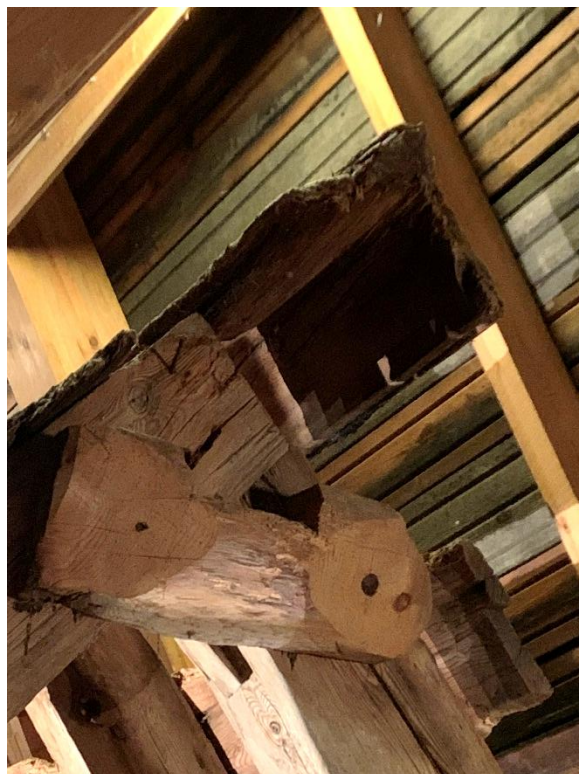
Det tidigmedeltida taketsnockbräda, sedd närmast tornmuren i väster samt underifrån i öster. Foto JL 2023.
