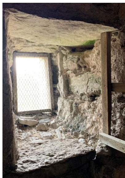
Ljusglugg mot söder i tornets andra övervåning med övertäckning bestående av ett bildstensfragment med synligt mönster, troligen av ett fartygssegel. Foto JL 2023.
