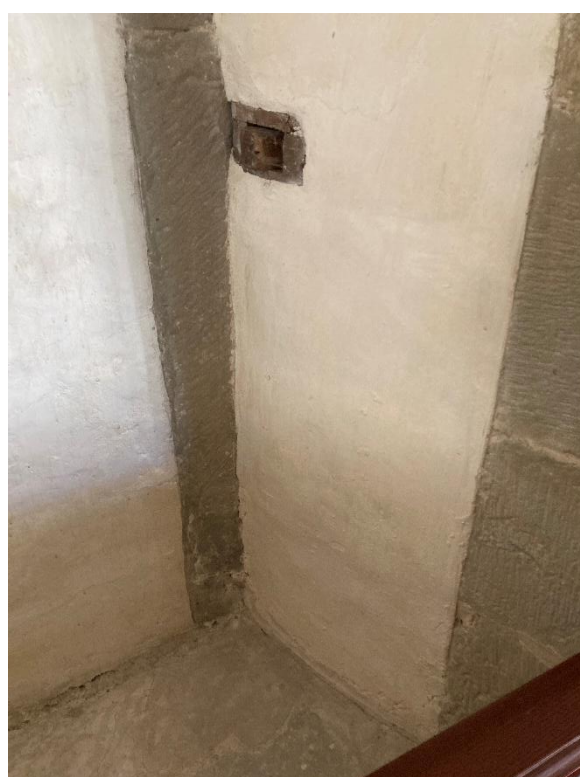
Den tidigare nordportalen sedd inifrån. Till höger portalens norra innersmyg med kvarsittande låsbom och trampsten. Foto JL 2025.
