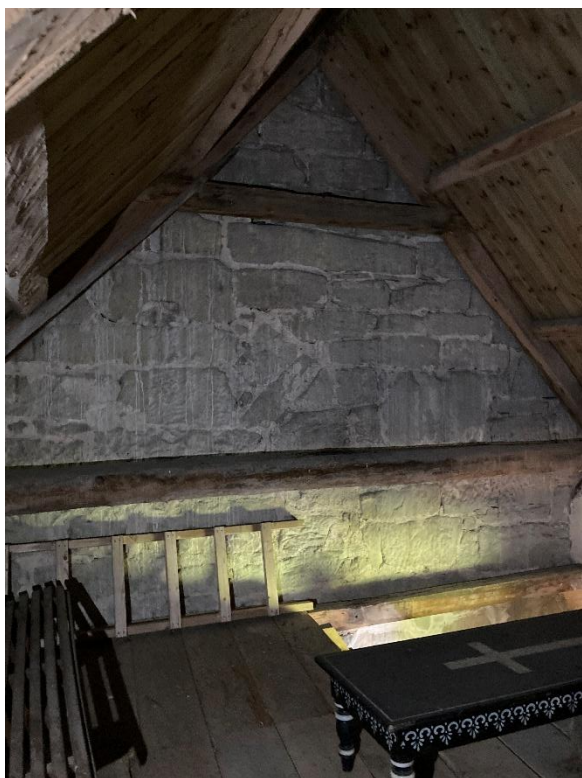
Magasinets övertage mot söder och norr, visande att tornet var oputsat när magasinet byggdes 1820. Foto JL 2025.
