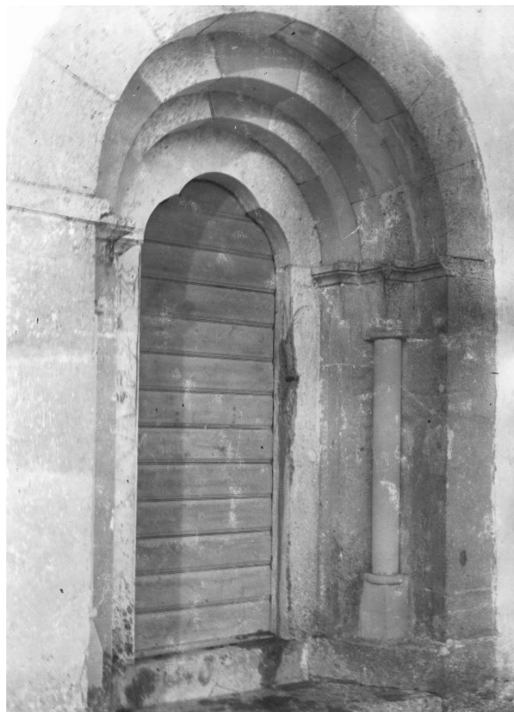
Korportalen innan kolonnetterna rekonstruerades omkring 1900. Till höger korportalen med kolonnetter, men skador på inre posten. Foto Olof Sörling (detalj) ca 1890 respektive foto från 1900-talets början, ATA.
