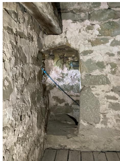
Trappans mynning i andra övervåningen. Till vänster blick uppåt, väster nedåt, norr åt höger, med synliga bjälkar, den högra helt inne i muren. Till höger öppningen sedd från söder. Foto JL 2025.
