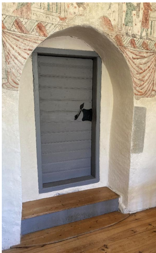
Ingång till sakristian från koret, placerad i en svagt spetsbågig nisch, möjligen från sakristians byggnadstid 1832-1833 eller äldre. I östra posten en omfattningssten, kanske från ett tidigare murskåp på samma plats. Till höger inskrift på sakristiedörrens insida. Foto JL 2025.
