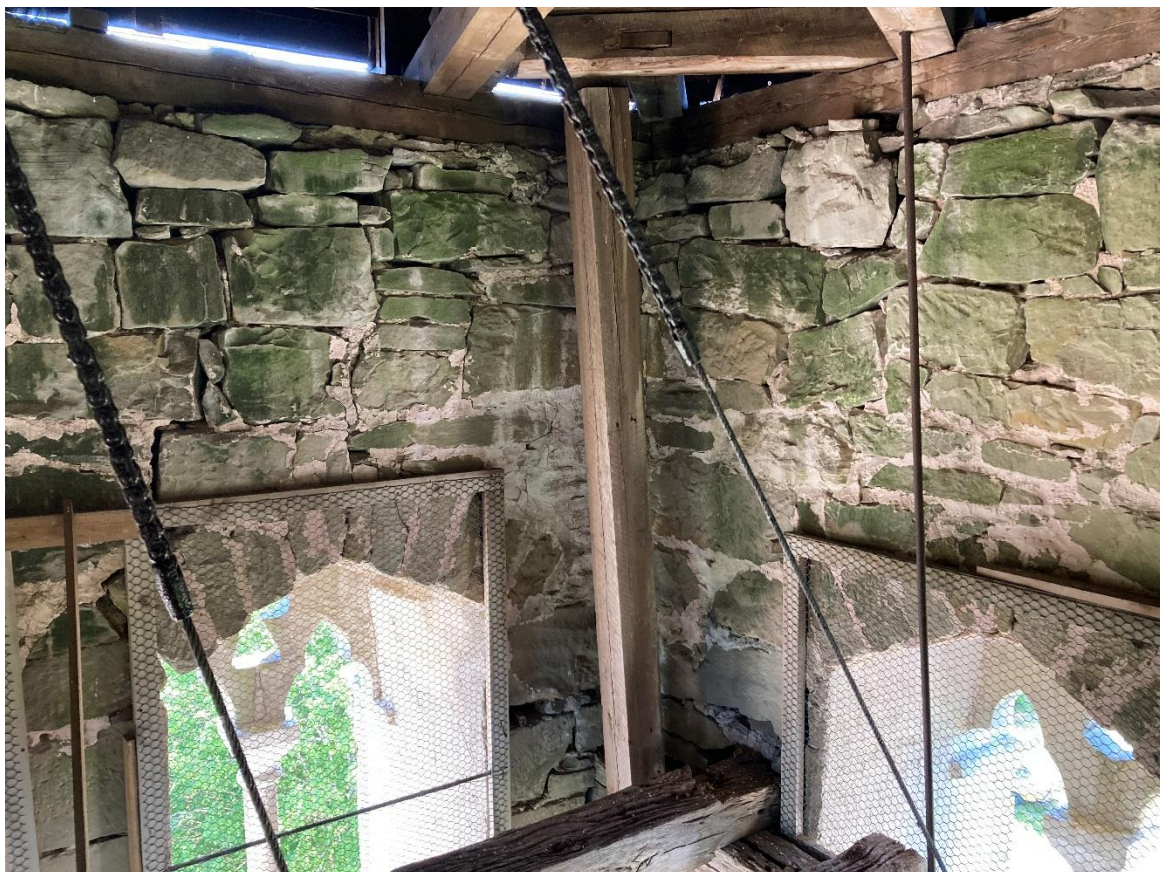
Klockvåningens övre del mot sydväst. Murverket något oregelbundet, men utan tydliga spår av att tornet tidigare till exempel varit högre och haft gavlar. Foto JL 2025.
