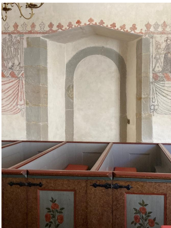
Den tidigare nordportalen sedd inifrån. Till höger portalens norra innersmyg med kvarsittande låsbom och trampsten. Foto JL 2025.
