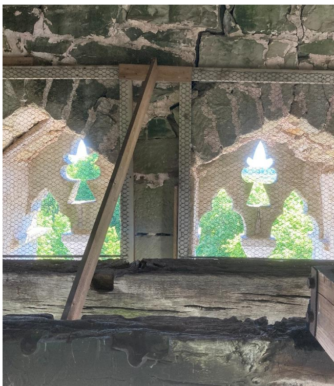
Klockvåningen och klockstolen mot väster. Foto JL 2025. Till höger blick mot söder med äldre urtag för klockupphängning i klockvåningens bjälkar, de bortre möjligen från tiden när kyrkan hade flera klockor. Foto ES 2025.
