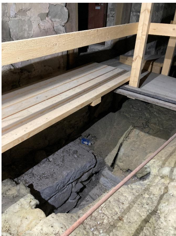
Övre delen av tidigare vindstrappa i långhusets västra mur, sedd mot nordväst och söder. Valven täcks av en isolering med glasfiberull. Foto JL 2025.
