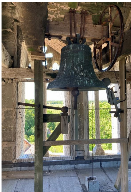
Klockvåningen och klockstolen mot väster. Foto JL 2025. Till höger blick mot söder med äldre urtag för klockupphängning i klockvåningens bjälkar, de bortre möjligen från tiden när kyrkan hade flera klockor. Foto ES 2025.
