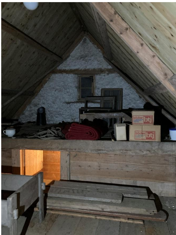
Magasinets övertage mot söder och norr, visande att tornet var oputsat när magasinet byggdes 1820. Foto JL 2025.
