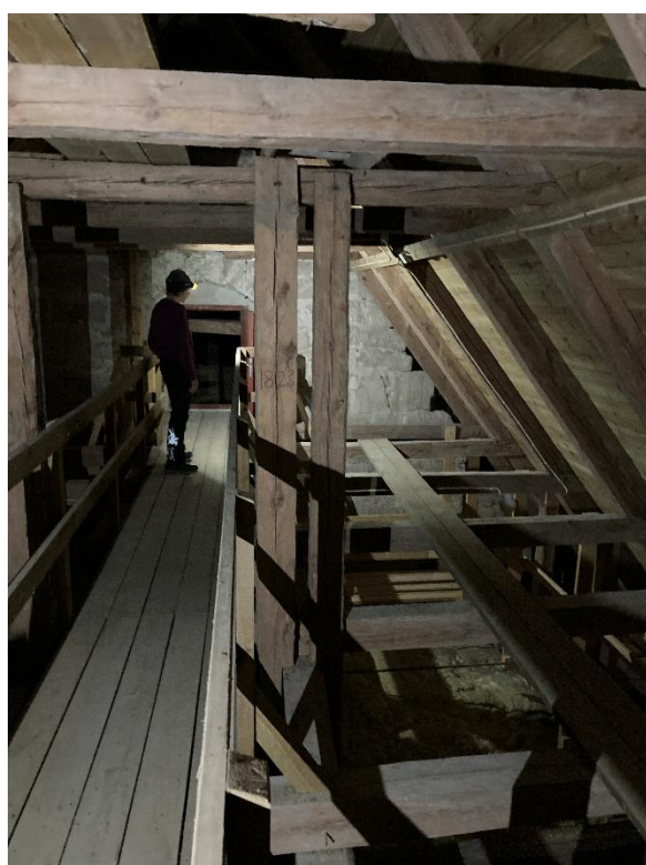
Långhusvinden sedd mot öster. Till höger ena murkrönet med dymlingar i remstyckena. Foto JL 2025.
