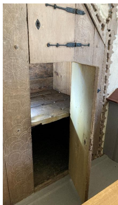
Väggsåp med huvudsakligen medeltida front, möjligen flyttat vid sakristians tillkomst för att ge plats åt ingången till sakristian. Omfattningsstenen i bågen kring sakristians dörr kan antyda att murnischen kan ha suttit här tidigare. Till höger såpets inre med sannolikt icke medeltida träfodring, vilket skulle kunna tala för att såpet flyttats. Foto JL 2025
