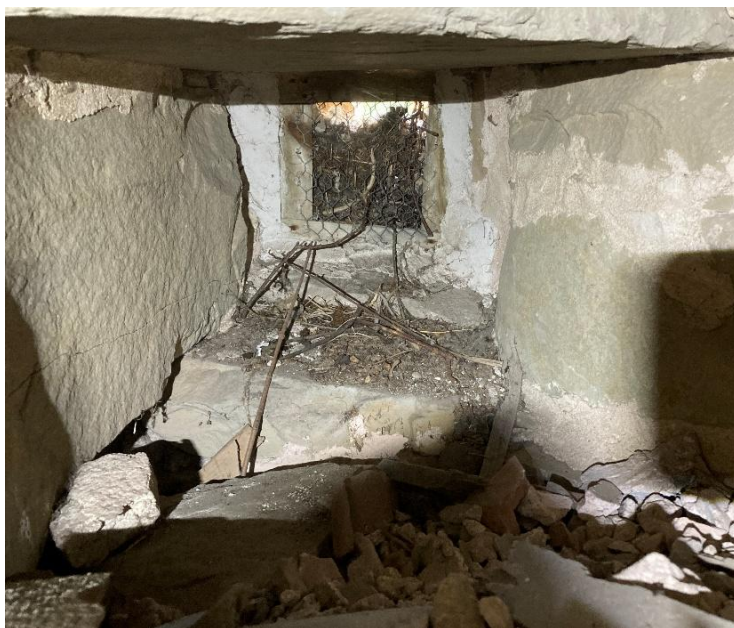
Tidigare vindstrappa i långhusets västra mur sedd ovanifrån mot söder. Till höger ljusglugg mot söder i trappan. Foto JL2025.
