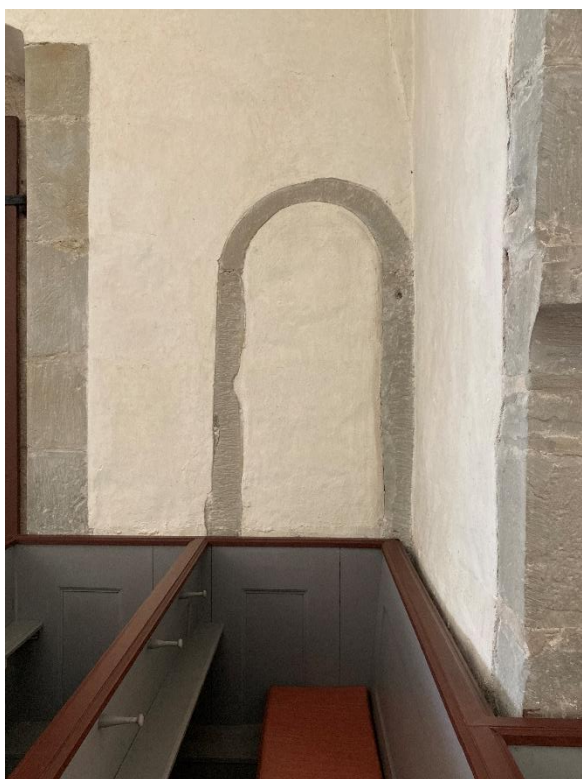
Igensatt öppning till den tidigare vindstrappan i långhusets nordvästra hörn. Till höger västra posten. Spår av gångjärn och en uppbruten läskolv visar att den stängts med en dörr. Foto JL 2025.
