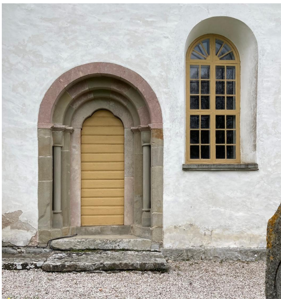
Korportalen och korets södra fönster. Foto JL 2024.
