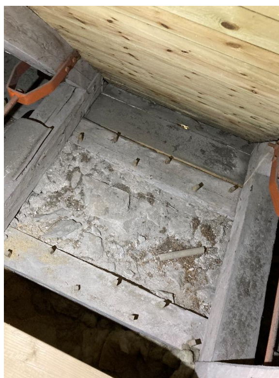
Långhusvinden sedd mot öster. Till höger ena murkrönet med dymlingar i remstyckena. Foto JL 2025.
