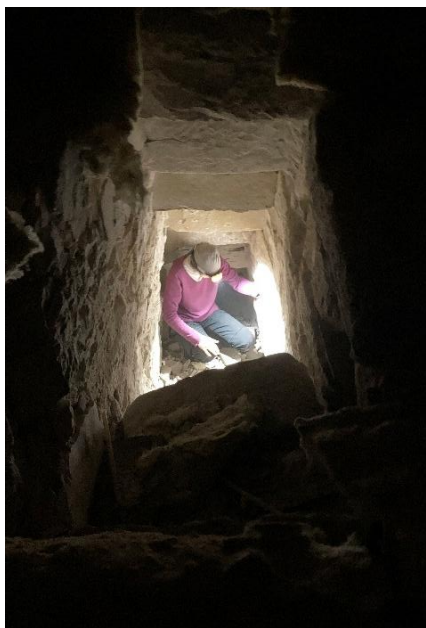
Tidigare vindstrappa i långhusets västra mur sedd ovanifrån mot söder. Till höger ljusglugg mot söder i trappan. Foto JL2025.
