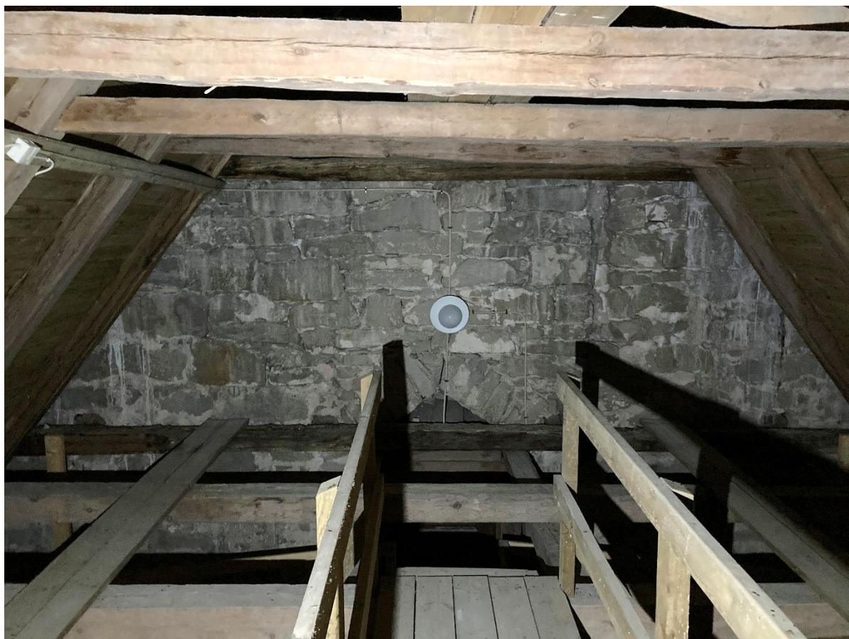
Långhusvinden sedd mot väster med den övre delen av öppningen mellan tornet och långhusvinden. Foto JL 2025.
