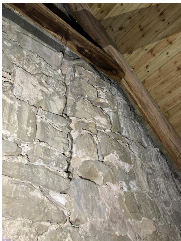
Passagen mellan tornets första övervåning och långhusvinden, sedd från öster. Till höger del av tornets östra mur sedd från långhusvinden med spår av tidigare inmurad bjälke. Foto JL 2025.
