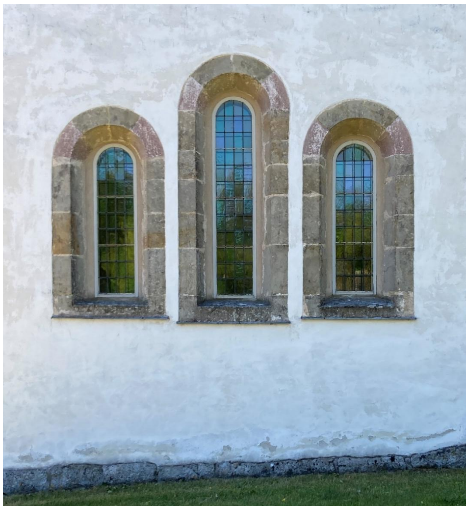
Korets östfönstergrupp. Foto JL 2025.
