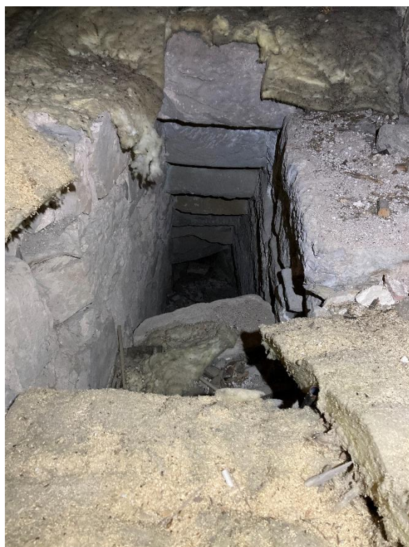
Övre delen av tidigare vindstrappa i långhusets västra mur, sedd mot nordväst och söder. Valven täcks av en isolering med glasfiberull. Foto JL 2025.
