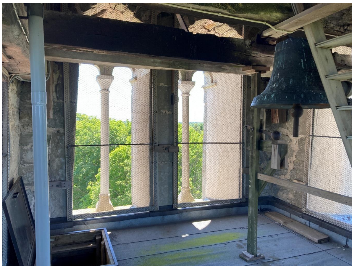
Klockvåningen sedd mot söder. Foto JL 2025.
