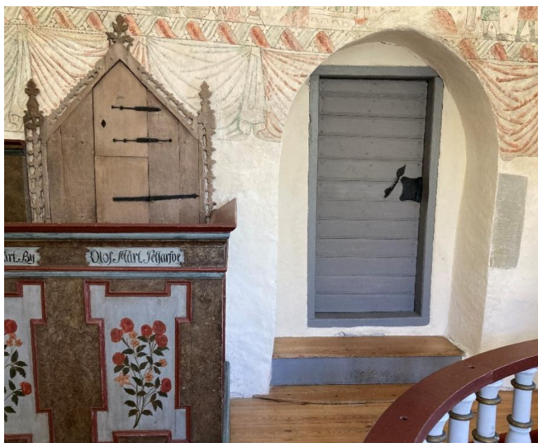
Väggsåp med huvudsakligen medeltida front, möjligen flyttat vid sakristians tillkomst för att ge plats åt ingången till sakristian. Omfattningsstenen i bågen kring sakristians dörr kan antyda att murnischen kan ha suttit här tidigare. Till höger såpets inre med sannolikt icke medeltida träfodring, vilket skulle kunna tala för att såpet flyttats. Foto JL 2025
