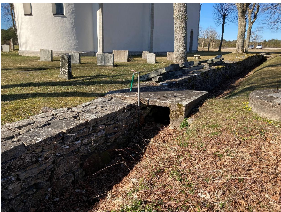
Den norra terrassmuren och omgivande dike fotograferad från öster. Närmast en sentida bro över diket. Foto ES 2022.
