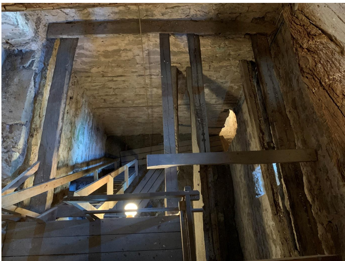
Blick nedåt mot söder genom tornets tidigare övervåningar. Foto JL 2022.
