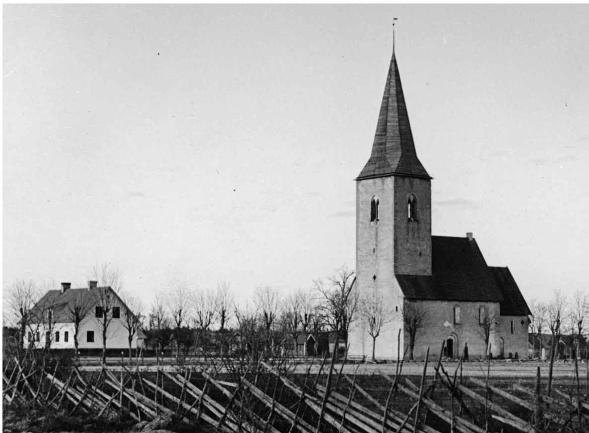
Exteriör från sydväst. Foto Iwar Anderson 1943, ATA. En skorsten reser sig över långhustaket.
