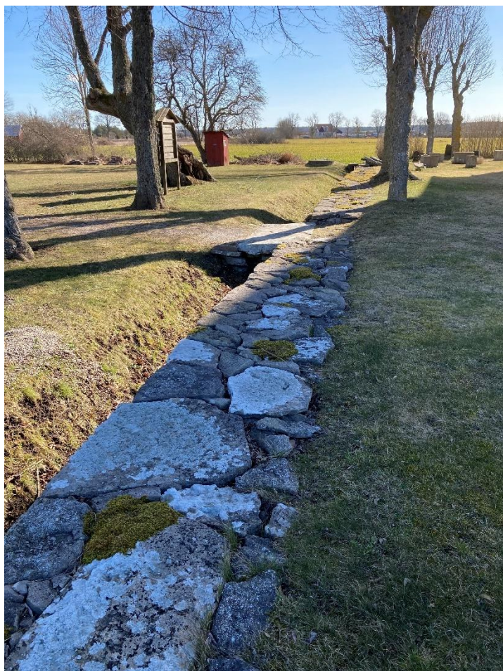
Den nordvästra delen av kyrkogården med terrassmur, dike och ingång från norr. Foto ES 2022.
