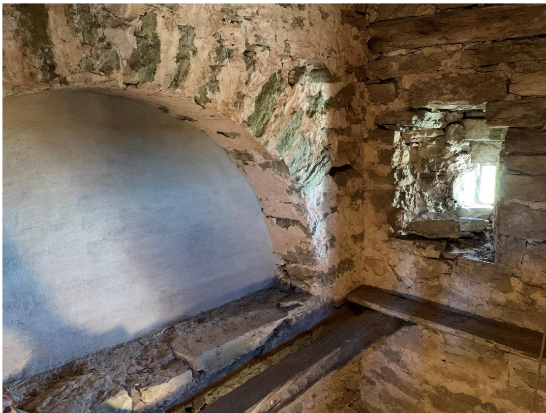
Igenmurad öppning mot långhusvindens övre del samt ljusglugg i tornets tidigare övervåning närmast under klockvåningen, sett mot sydöst. Foto JL 2022.
