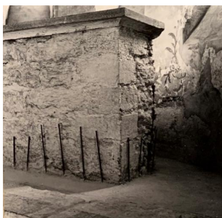
Korvalvet förbereds för en ny stödkonstruktion av armerad betong. Till vänster altaret innan ommurning då det även flyttades närmare väggen i öster. Foto Valdemar Falck 1967, Gotlands Museum (GFF 935_22, 935_21 och 935_47).
