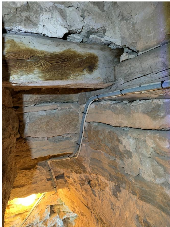
Övre delen av murtrappans trapplopp, med synlig knutpunkt för två i övrigt helt inmurade bjälkar, sannolikt del av en kring tornets sidor löpande sammanhållande ram av bjälkar. Foto JL 2022.
