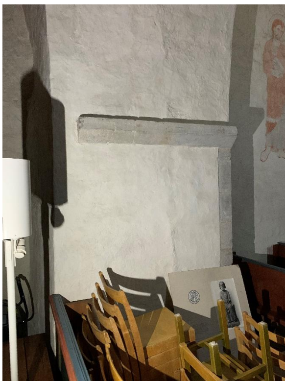
Tornågens norra och södra vederlag med skarv mitt i bågen. Foto JL 2022.
