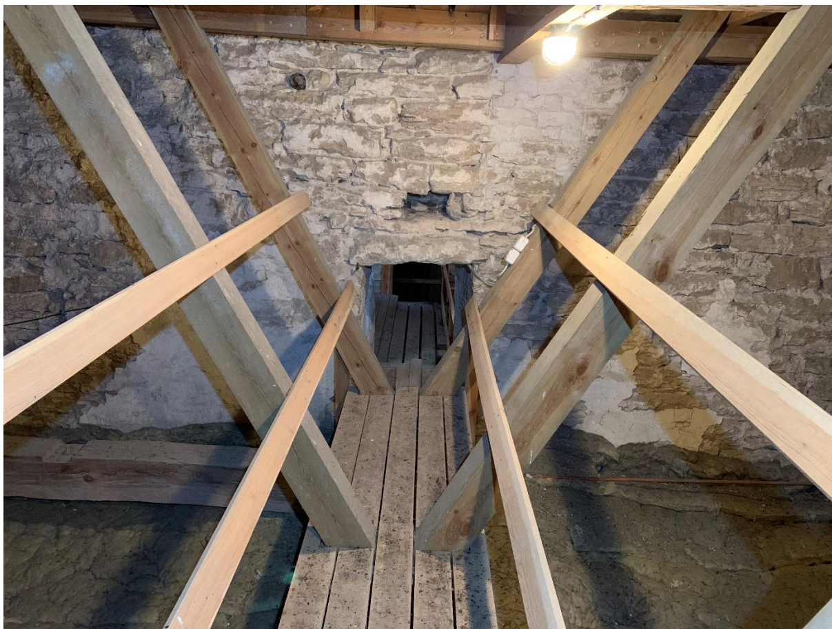
Triumfbågsmuren sedd från långhusvinden med passage till koret. Putsen kvarsitter från den tid när detta var korets västfasad, innan långhuset byggdes. Foto JL 2022.
