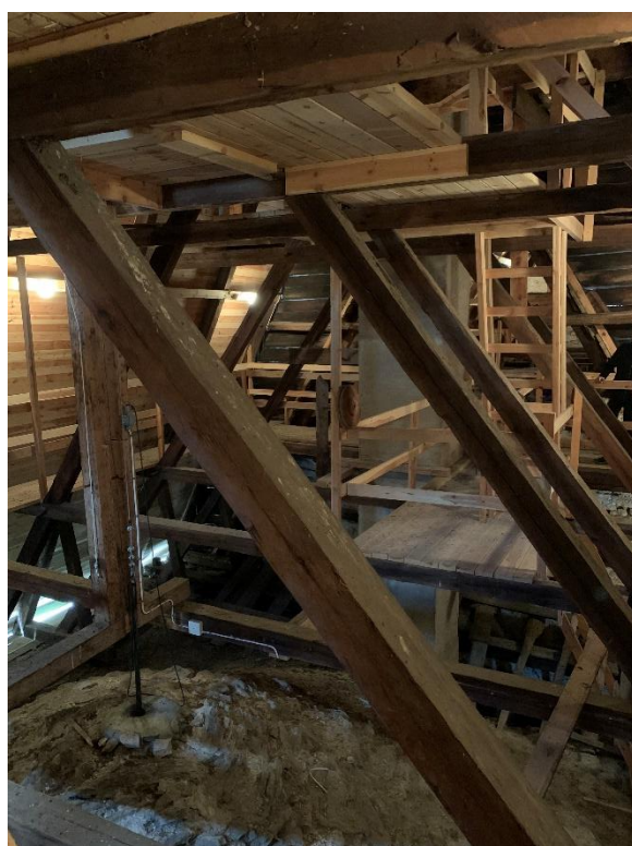
Långhusets östra gavelröste sett från långhusvinden med det äldre långhusets gavelröste synligt. Till höger blick från korvinden mot väster. Bakom skorstenen syns västra korgavelns trävägg och öppningen till långhusvinden ovanför den stympade östra långhusgaveln. Foto JL 2022.
