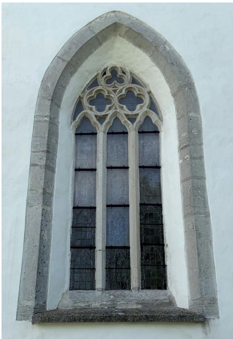
Till vänster korets östra fönster med poster och masverk från kyrkans byggnadstid. Foto JL 2022. Nedan öppning i korets gavelröste. Foto Pär Malmros 2022, Visby stift.
