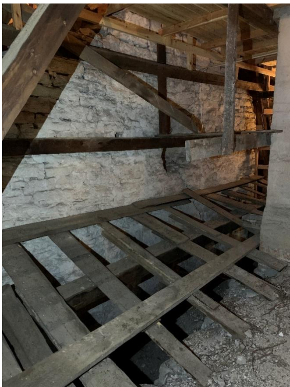
Långhusets östra gavelmur sedd från sydöst och nordöst inifrån vinden med trägaller över det lägre partiet ovanför triumfbågen. Foto JL 2022.
