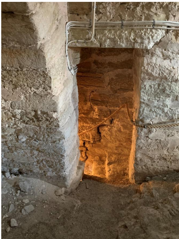
Tornets första övervåning, nordöstra hörnet med murtrappans mynning samt nordvästra hörnet med avlastningsbågens västra anfang. Foto JL 2022.
