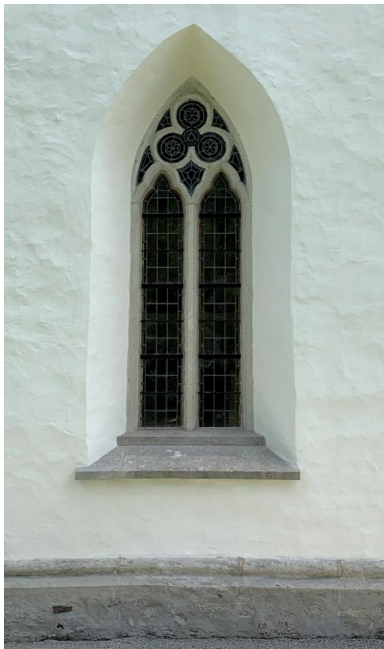
Långhusets norra fönster, upptaget 1828, försett med masverk och poster i kalksten 1869-70. Till höger tornets västra fönster, troligen förstorat, kanske 1828, försett med masverk, troligen 1869-70. Foto JL 2022.
