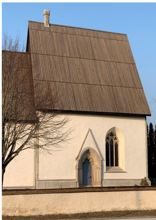
Koret från söder. Till höger korportalen och korets södra fönster. Fönstret sannolikt förstorat, troligen 1828, och försett med poster och masverk i kalksten 1869-70. Sockeln omhuggen, troligen 1869-70. Foto JL 2022.
