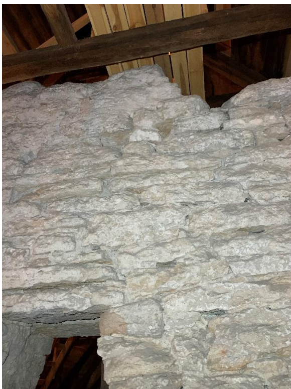
Långhusets delvis nedbrutna östra gavelröste, sett från långhusvinden, till höger snett ovanifrån. Liksom övriga murar uppvisar de brandspår i form av vittring. Foto JL 2022.
