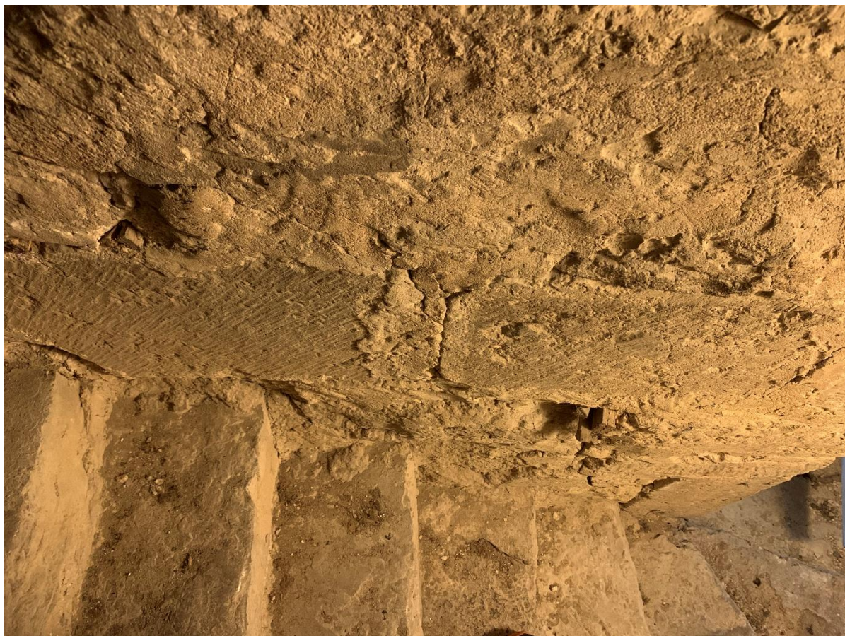
Infogade äldre murblock i trapploppets sidor. Foto JL 2022.
