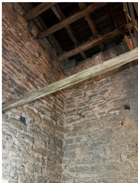
Tornets andra övervåning sedd uppåt mot nordväst. Att murverket skiftar karaktär till tunnare skift kan möjligen tyda på ett kortare byggnadsuppehåll. Till höger, spår av att bjälklaget under klockvåningen tidigare legat lägre. Foto JL 2022.
