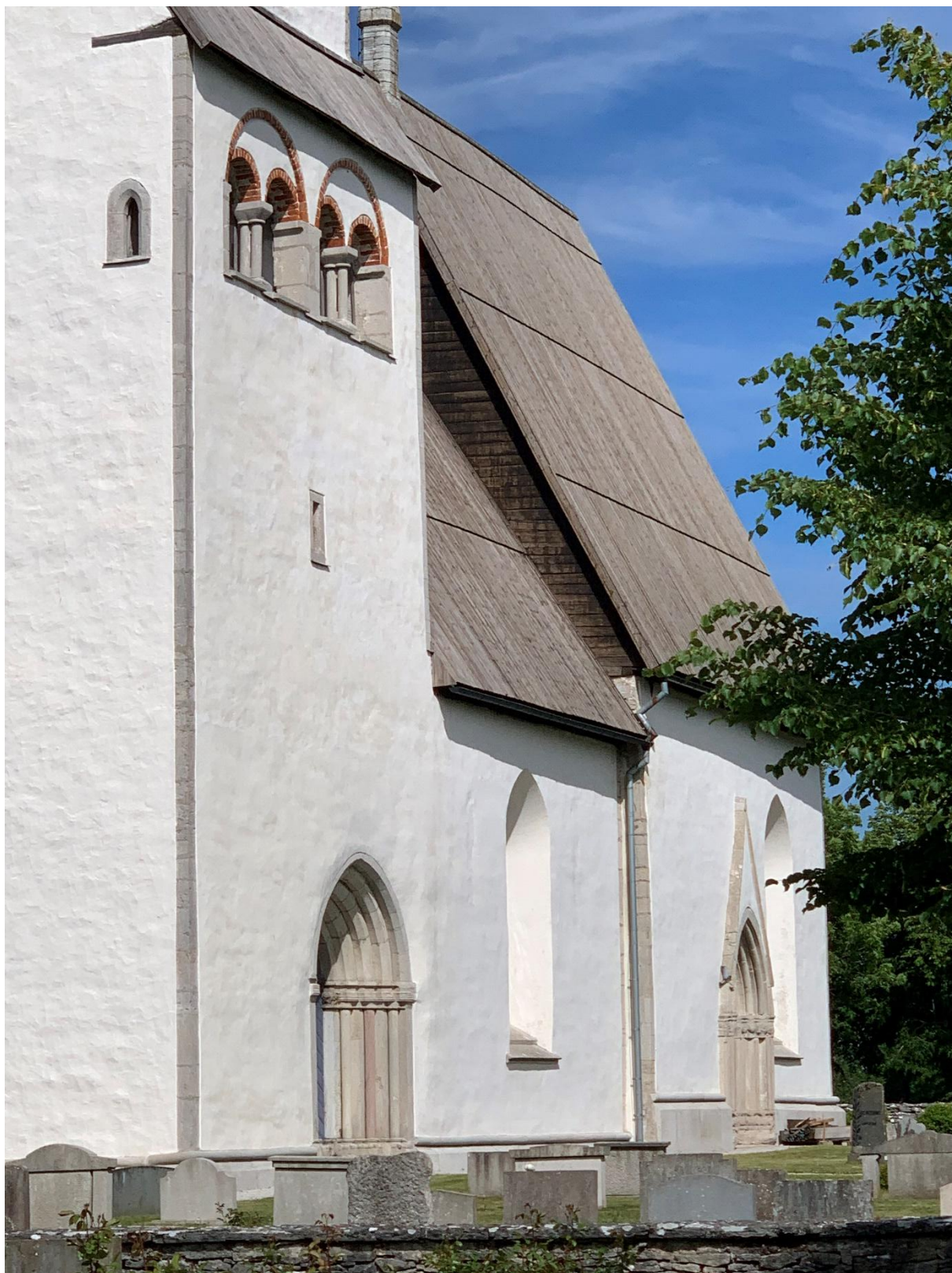
Sydfasadens portaler, fönster och gallerier från sydväst. Foto JL 2022.
