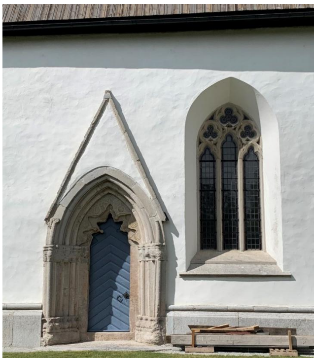
Koret från söder. Till höger korportalen och korets södra fönster. Fönstret sannolikt förstorat, troligen 1828, och försett med poster och masverk i kalksten 1869-70. Sockeln omhuggen, troligen 1869-70. Foto JL 2022.
