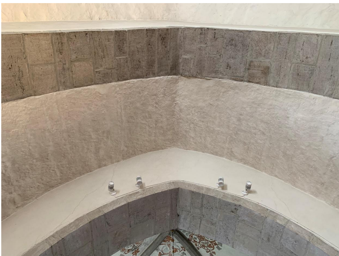
Triumfbågen sedd underifrån. Nedtill bågöppningen i långhusets östra mur. Upptill bågöppningen närmast koret. Mellan dessa ett tunnvalv som stöter stumt mot korbågen, sannolikt tänkt som ett provisorium i väntan på att ett nytt och större långhus skulle byggas. Foto JL 2022.
