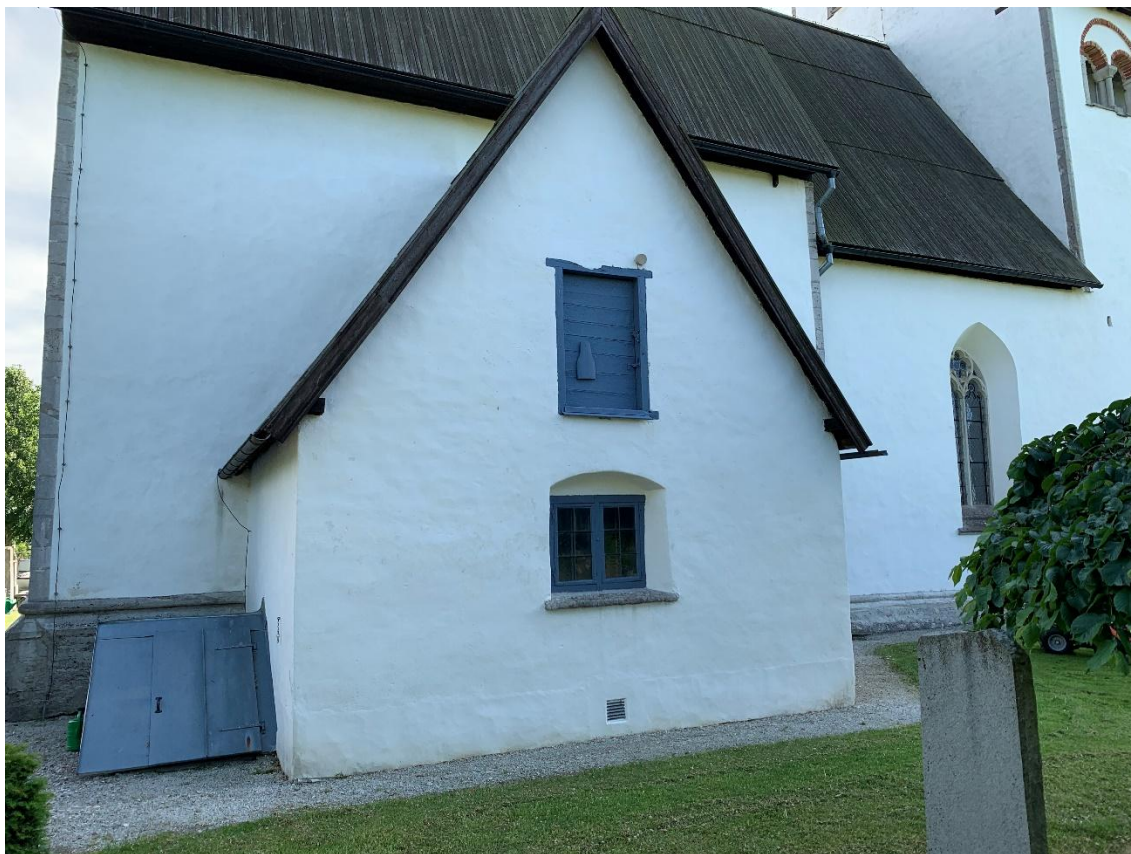
Sakristian, byggd 1795, från nordöst och korets norra fasad. Foto JL 2022.
