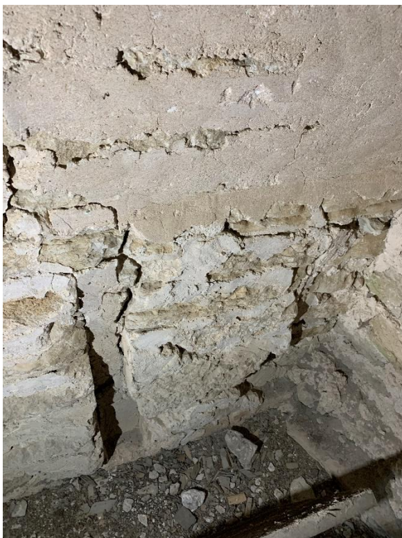
Avtryck i första övervåningens nordvästra hörn efter träställningen från bågens slagnig. Till höger sydöstra hörnet med avtryck av skälbrädor, bestående av återanvänd takpanel. Foto JL 2022.
