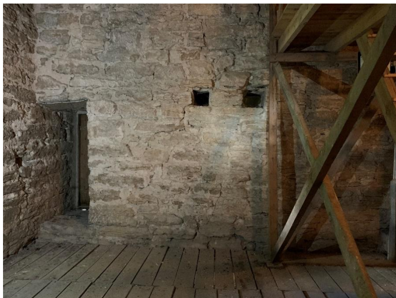
Tornets andra övervåning mot norr med utgång till galleriet och två bjälkhål med kvarsittande brända bjälkändar. Foto JL 2022.
