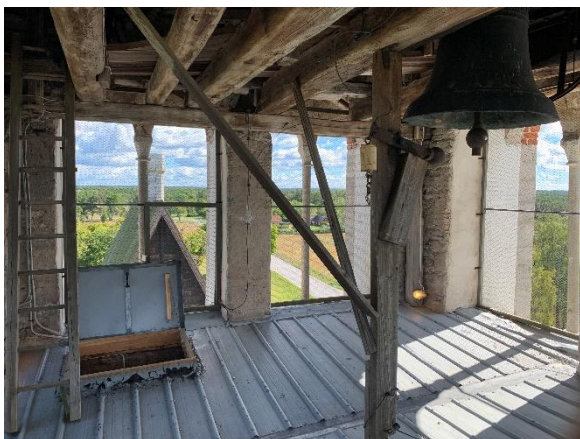
Klockvåningen mot öster och söder. Foto JL 2022.
