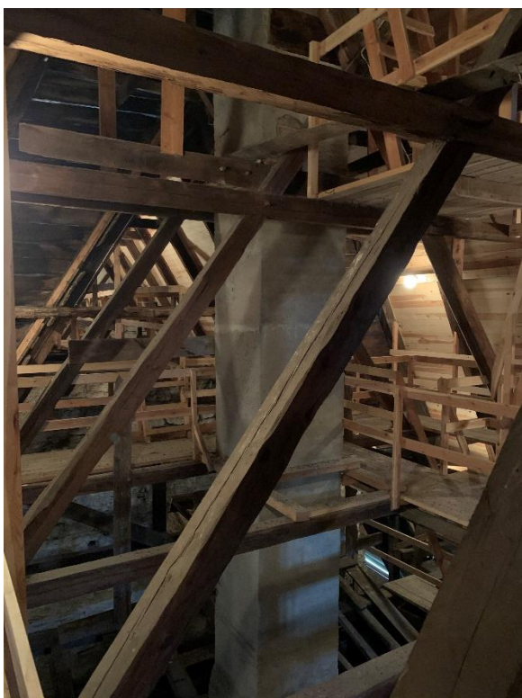
Långhusets östra gavelröste sett från långhusvinden med det äldre långhusets gavelröste synligt. Till höger blick från korvinden mot väster. Bakom skorstenen syns västra korgavelns trävägg och öppningen till långhusvinden ovanför den stympade östra långhusgaveln. Foto JL 2022.
