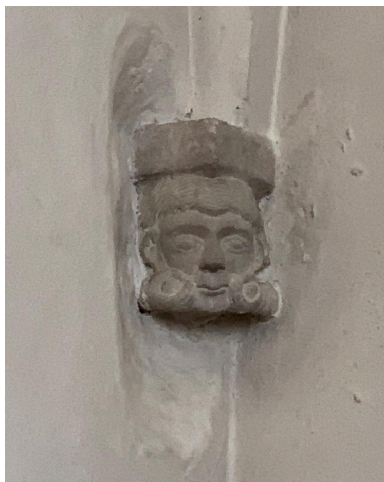
Valvkonsol i korets nordvästra hörn. Foto. JL2022.
