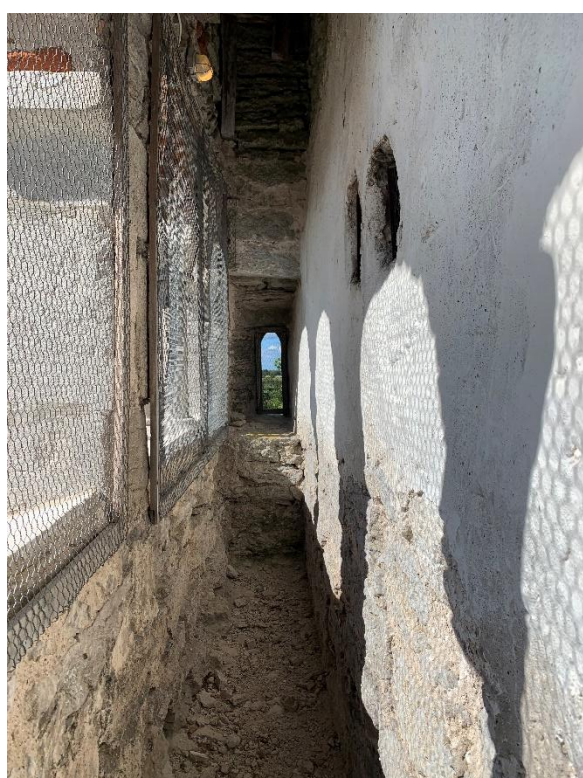
Takstolen över södra galleriet. Till höger södra galleriet mot väster. De två ljusluggarna är hål för tidigare bjälkar. Foto JL 2022.
