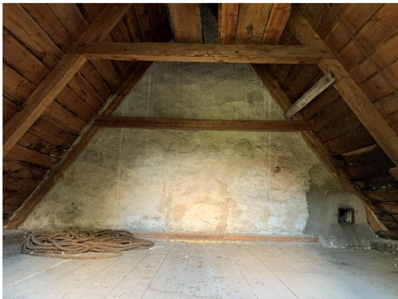
Sakristians vind mot söder. I fonden korets norra mur. Foto JL 2022.
