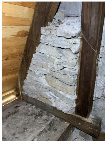
Remstycken på södra långhusmuren och utfyllnadsmur i långhusvindens sydöstra hörn. Foto JL 2022.
