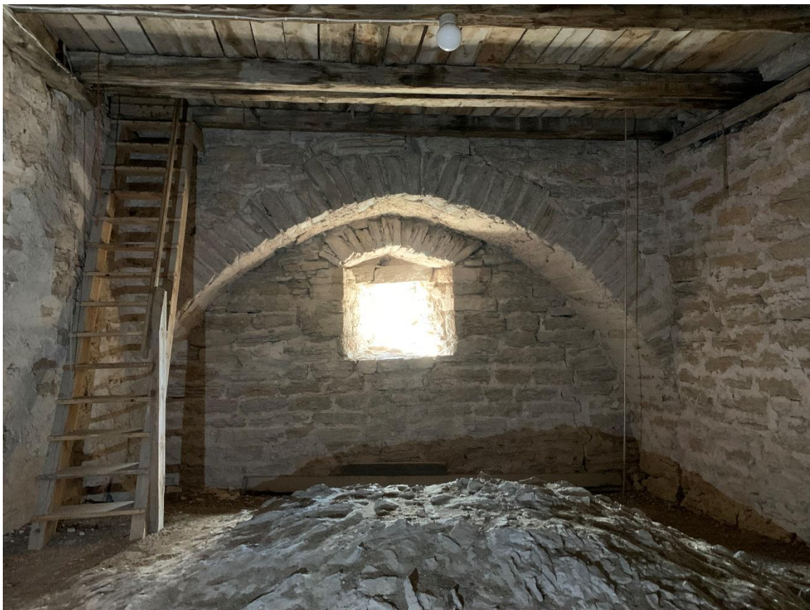
Tornets första övervåning mot söder. Foto JL 2022.
