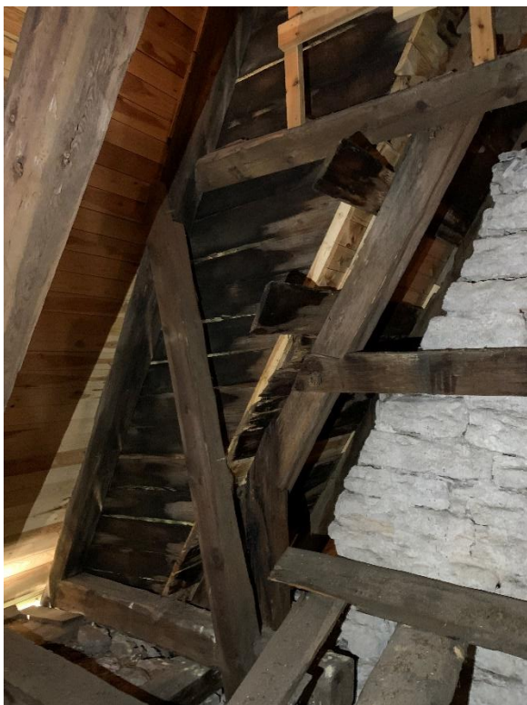
Västra korgavelns träpanel sedd från korvinden. Till höger södra delen av långhusets östra gavelröste, visande att det ursprungliga taket låg lite lägre och hade något brantare resning. Foto JL 2022.
