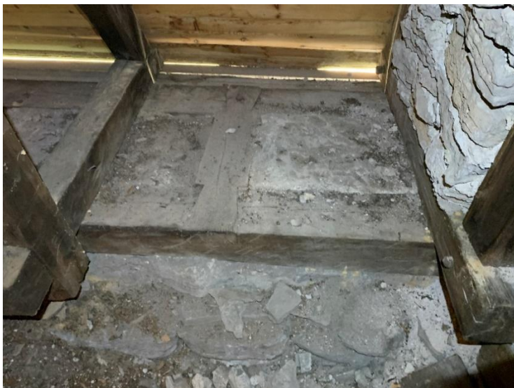
Remstycken på södra långhusmuren och utfyllnadsmur i långhusvindens sydöstra hörn. Foto JL 2022.
