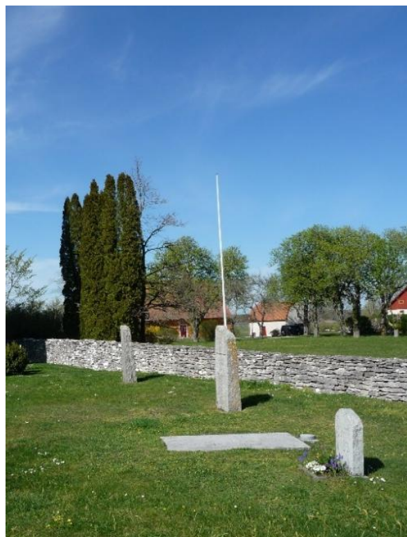
Den östra muren av kallmurad kalksten fotograferad från söder. Foto ES 2022.
