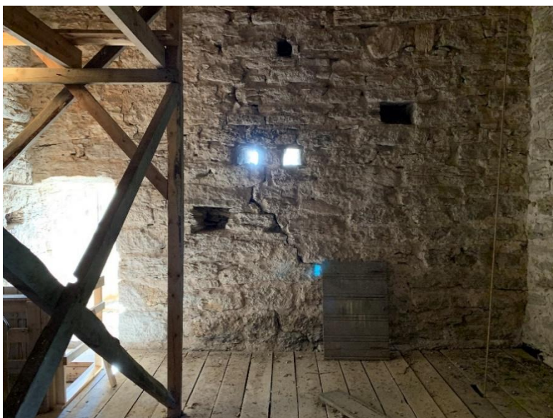
Tornets andra övervåning mot söder med utgång till galleriet och två ljusluggar, formade av tidigare bjälkhål. Foto JL 2022.
