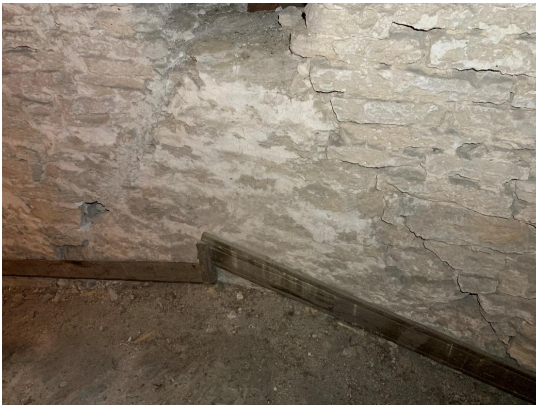
Det tidigare långhusets gavelröste, sett från långhusvinden i väster. Röstet, som vände sig in mot vinden synes ha varit putsat. Det kan tyda på att det varit avsett att ses nedifrån och att det alltså kan ha haft öppen takstol. Foto JL 2022.
