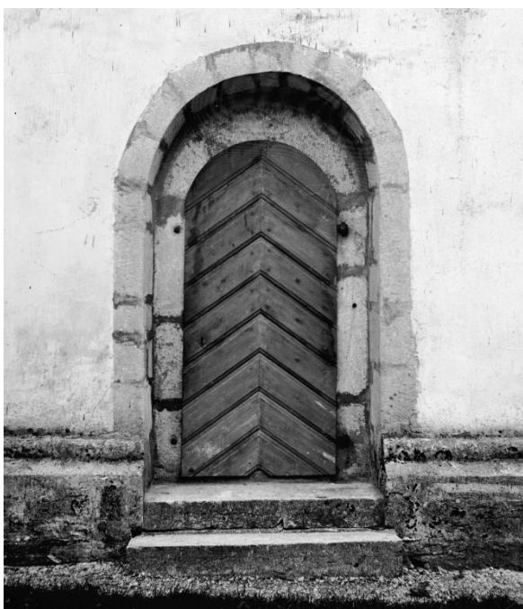
Nordportalen innan rampen byggdes. Foto Einar Erics 1914, ATA.
