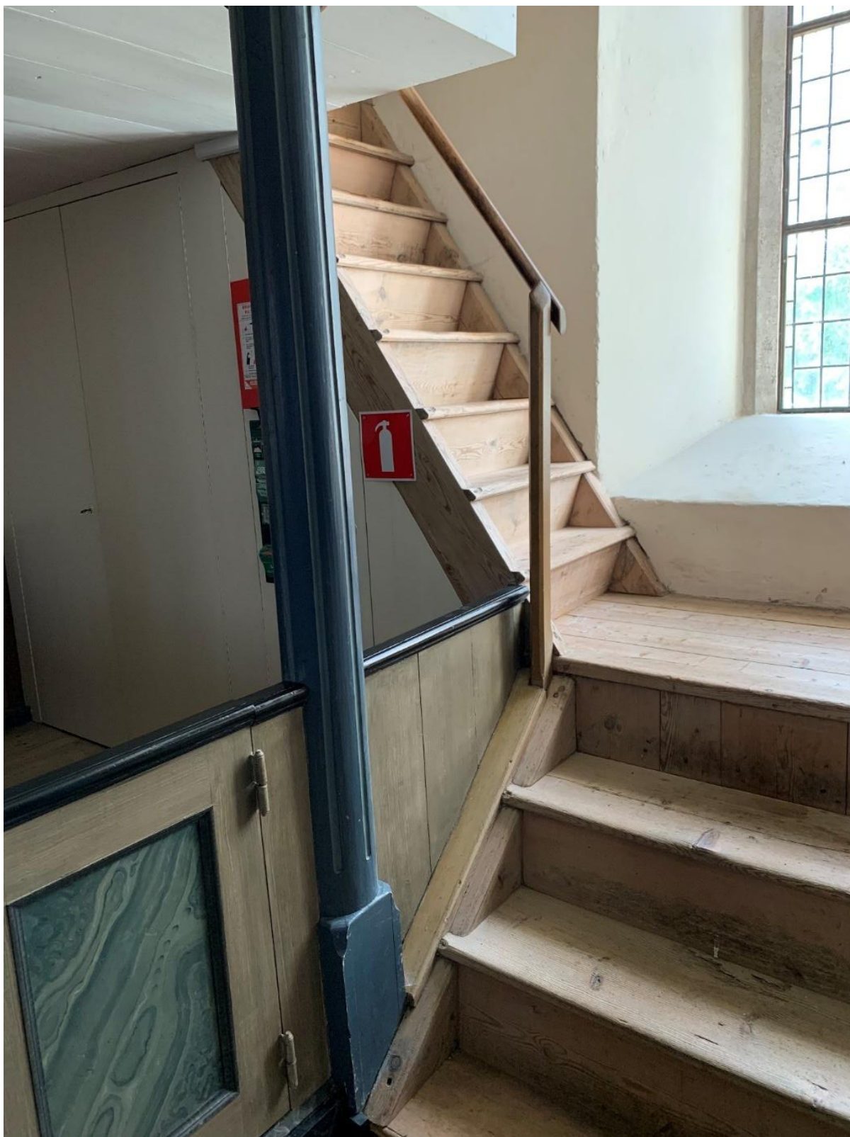
Ringkammarens västra del med läktartrappan sedd mot sydväst. Foto JL 2022.
