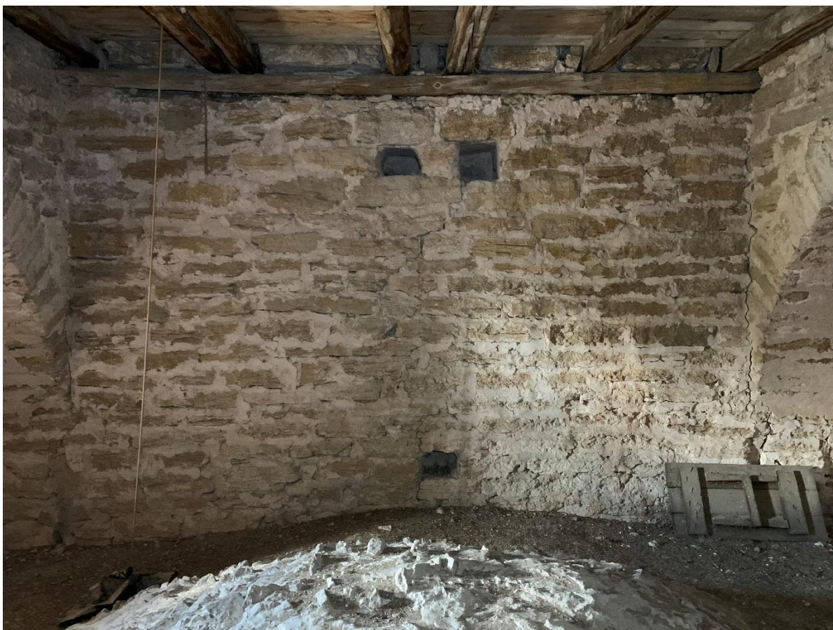
Tornets första övervåning mot väster. Foto JL 2022.
