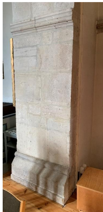
Triumfbågens södra vederlag. Till höger triumfbågens norra vederlag i bågöppningen i östra långhusmuren. Foto JL 2022.
