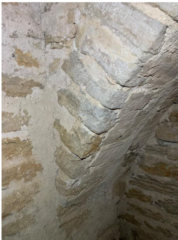
Avtryck i första övervåningens nordvästra hörn efter träställningen från bågens slagnig. Till höger sydöstra hörnet med avtryck av skälbrädor, bestående av återanvänd takpanel. Foto JL 2022.
