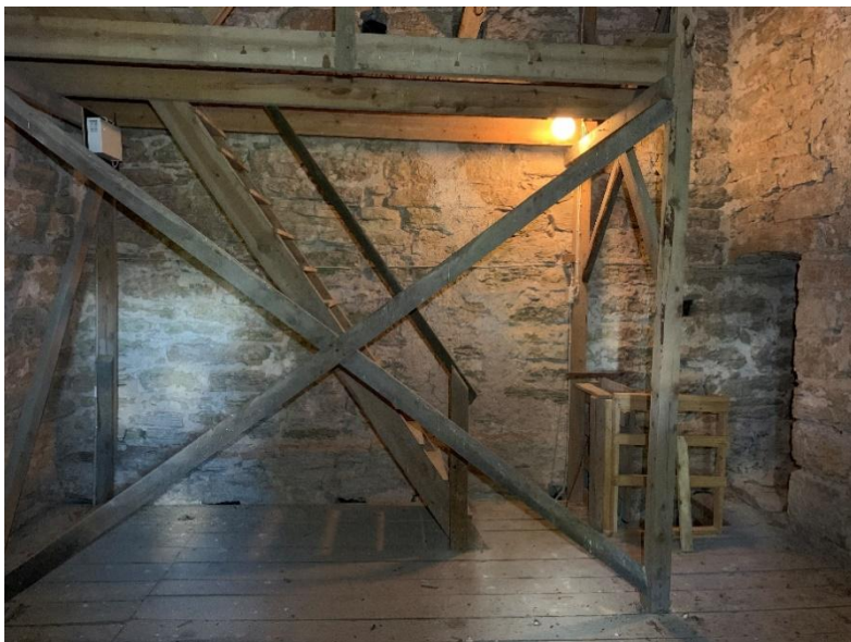
Tornets andra övervåning mot öster. Foto JL 2022.
