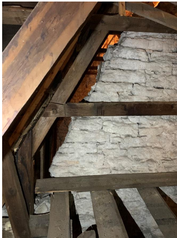
Västra korgavelns träpanel sedd från korvinden. Till höger södra delen av långhusets östra gavelröste, visande att det ursprungliga taket låg lite lägre och hade något brantare resning. Foto JL 2022.
