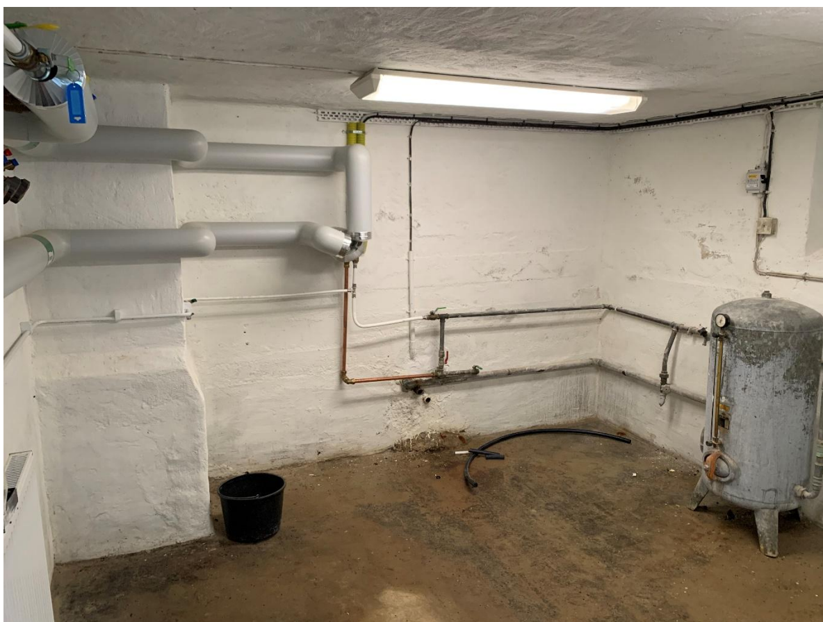
Sakristians källare, byggd 1935-36, mot väster. Foto JL 2022.
