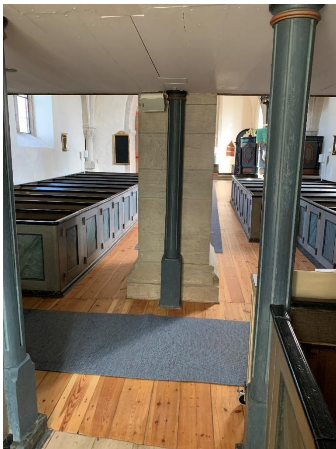
Mittpelaren mellan tornbågarna sedd från väster. Pelaren saknar sockel in mot ringkammaren, kanske för att ge plats åt dopfontens basplatta. Foto JL 2022.
