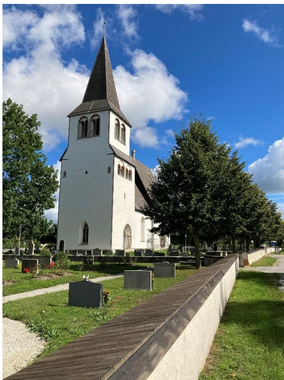
Den södra mursträckningen med putsad mur och spontade snedställda brädor. Foto ES 2022.
