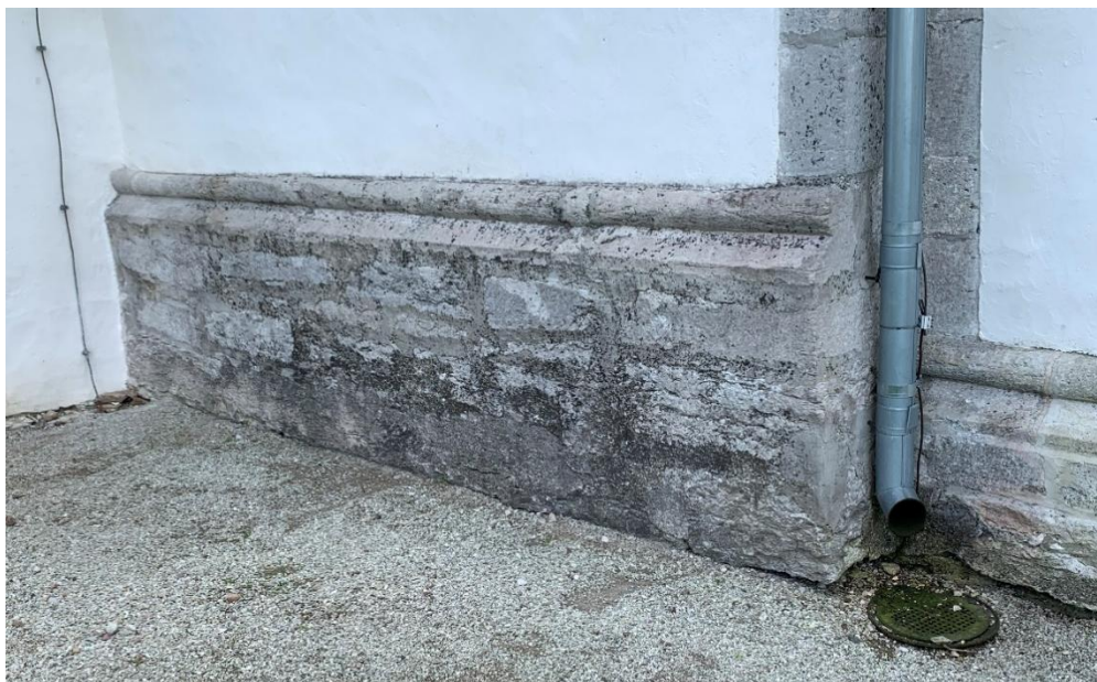
Sockel i korets nordvästra hörn. Till skillnad från på södra sidan är nordsidans sockel inte förnyad i senare tid, troligen 1869-70. Foto JL 2022.
