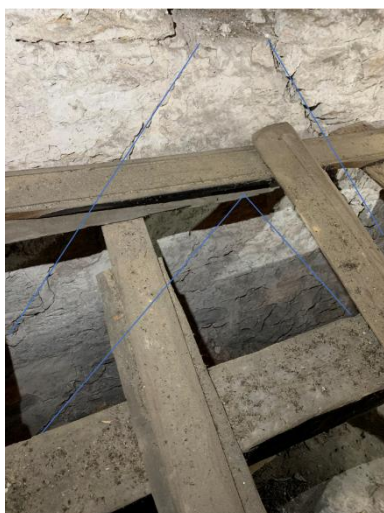
Äldre gavelröste, inbyggt i långhusets östra gavelröste, sett från korvinden. Avtrycken av det äldre långhusets gavel och från det äldre korets ifyllda i nedre bilden. Foto JL 2022.
