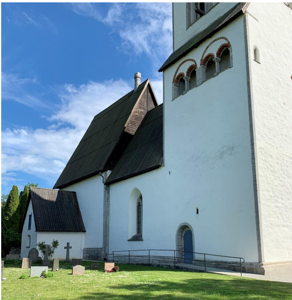
Kyrkans norra fasad från nordväst. Foto JL 2022.
