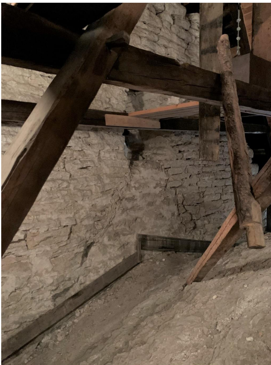
Långhusets östra gavelmur, sedd från nordväst, med inbyggt gavelröste från ett äldre långhus. Foto JL 2022.
