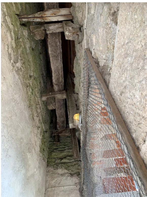
Takstolen över södra galleriet. Till höger södra galleriet mot väster. De två ljusluggarna är hål för tidigare bjälkar. Foto JL 2022.
