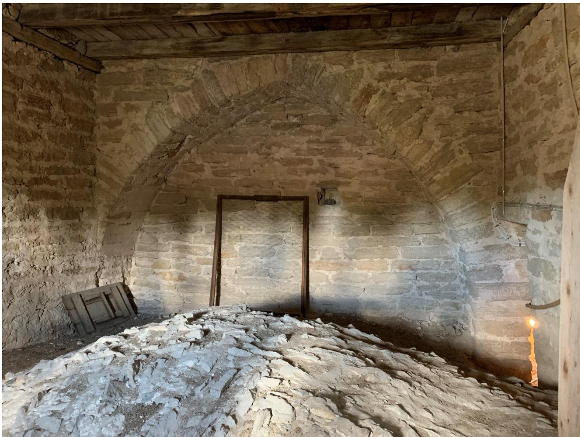
Tornets första övervåning mot norr. Foto JL 2022.
