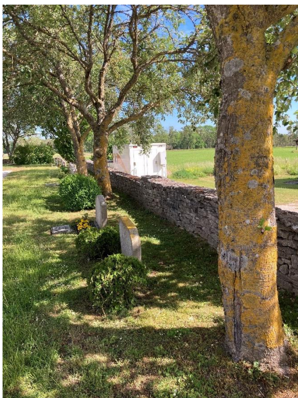
Den västra muren av kallmurad kalksten fotograferad från norr. Foto ES 2022.
