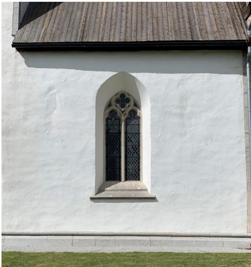
Långhusets södra fönster, upptaget 1828 och försett med poster och masverk i kalksten 1869-70. På var sida om fönsteröppningen spår av två tidigare fönsteröppningar. Foto JL 2022.
