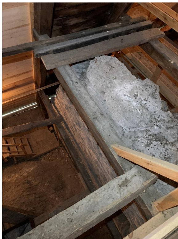
Långhusets delvis nedbrutna östra gavelröste, sett från långhusvinden, till höger snett ovanifrån. Liksom övriga murar uppvisar de brandspår i form av vittring. Foto JL 2022.
