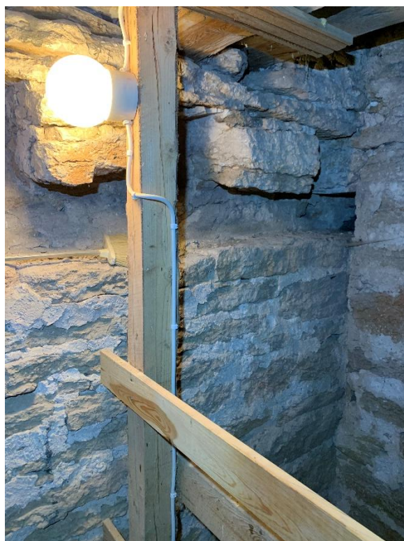
Tornets andra övervåning sedd uppåt mot nordväst. Att murverket skiftar karaktär till tunnare skift kan möjligen tyda på ett kortare byggnadsuppehåll. Till höger, spår av att bjälklaget under klockvåningen tidigare legat lägre. Foto JL 2022.
