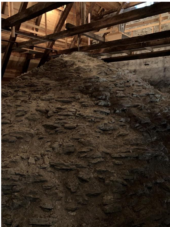
Korvalvets ovansida, sedd mot nordöst. Till höger korvinden sedd mot öster. Foto JL 2022.
