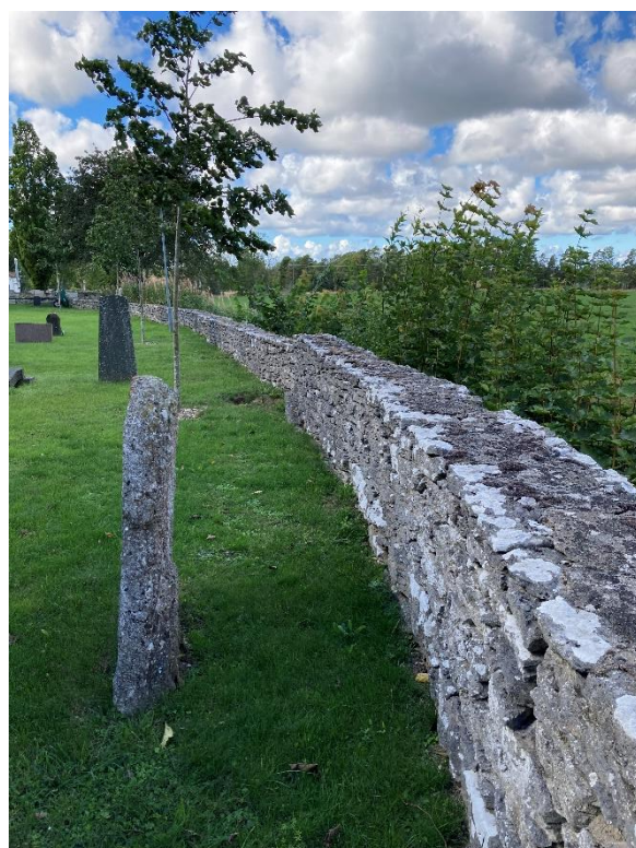
Den norra rundade muren av kallmurad kalksten fotograferad från öster. Foto ES 2022.
