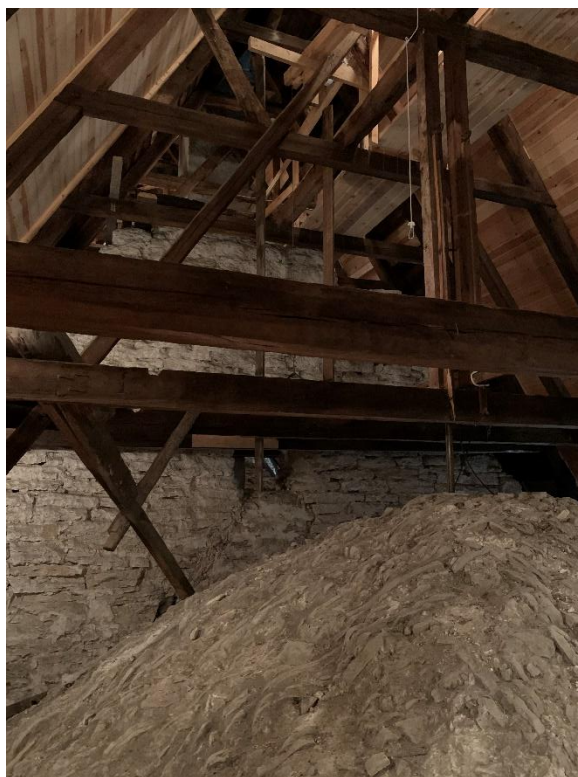
Tornets östra mur sedd från långhusvinden samt långhusvinden mot öster med valvets ovansida. Foto JL 2022 respektive 2018.
