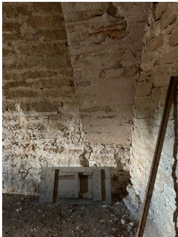
Tornets första övervåning, nordöstra hörnet med murtrappans mynning samt nordvästra hörnet med avlastningsbågens västra anfang. Foto JL 2022.
