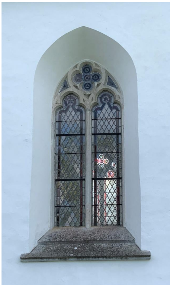
Långhusets norra fönster, upptaget 1828, försett med masverk och poster i kalksten 1869-70. Till höger tornets västra fönster, troligen förstorat, kanske 1828, försett med masverk, troligen 1869-70. Foto JL 2022.
