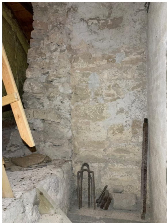
Öppningen från tornet till kyrkvinden. Till vänster uppgång till tunnvalvets ovansida. Under stegen finns den igensatta dörröppningen in till kyrkan. Till höger södra vederlaget i bågöppningen, visande tornmuren till höger och södra sidan av det medeltida långhusets västgavel till vänster. Foto JL 2022.
