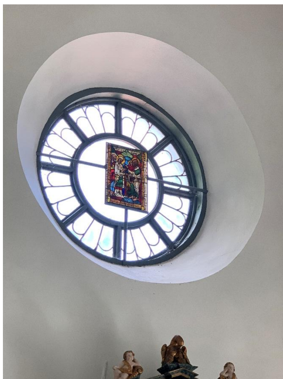
Östra och sydöstra fönstren. Foto JL 2022.
