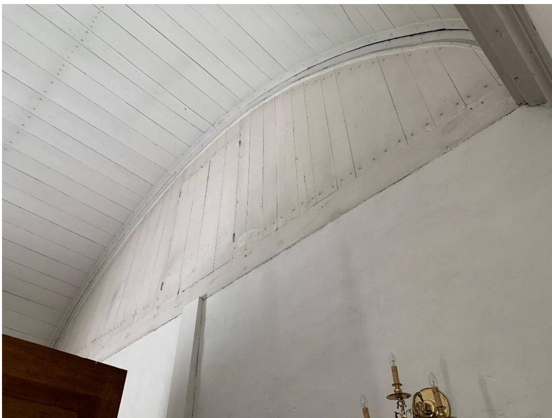
Väggparti i trä i väster, ovanpå muren och under trätunnvalvet, med dörrar in till tornets första övervåning. Foto JL 2022.
