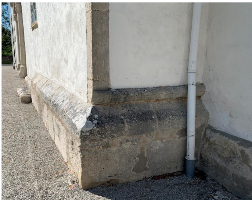
Kyrkans sydöstra hörn och anslutningen till östsakristian. Av det medeltida korets vulst är korta stycken bevarade på östgaveln medan den huggits bort på sidomurarna. Foto JL 2022.
