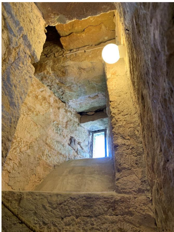
Torntrappa i norra muren, sedd uppåt mot väster. Till höger ljusglugg i tornets nordvästra hörn visande murverkets skarpa hörn. Foto JL 2022.
