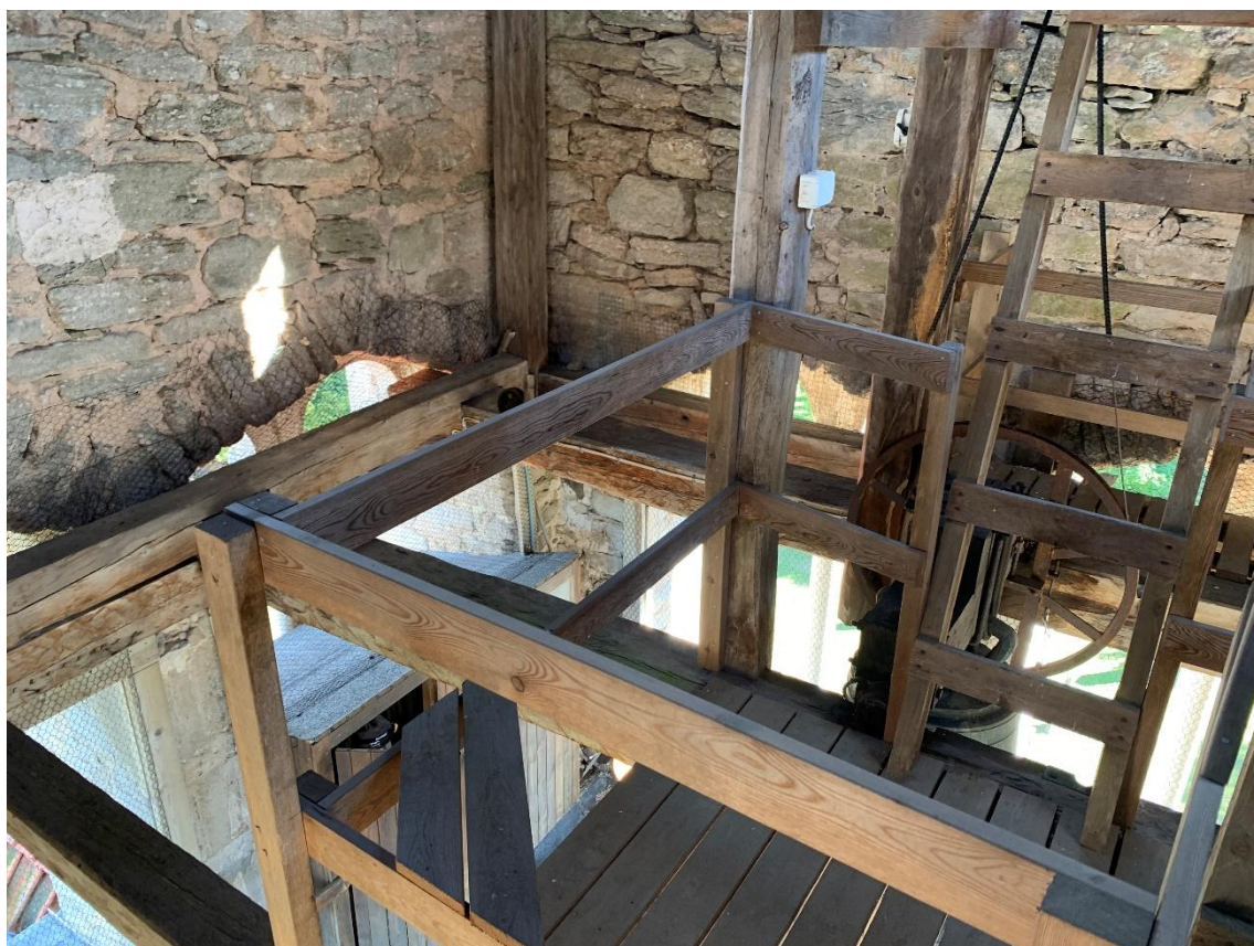
Klockvåningen mot sydöst med murpartiet mellan de båda våningarna av ljudgluggar. Foto JL 2022.
