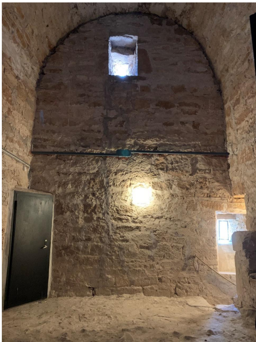
Tornets första övervåning mot väster. Foto JL 2022.
