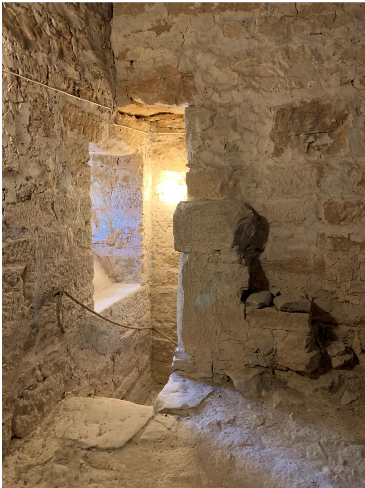
Murtrappans mynning i nordvästra hörnet av tornets första övervåning. Foto JL 2022.
