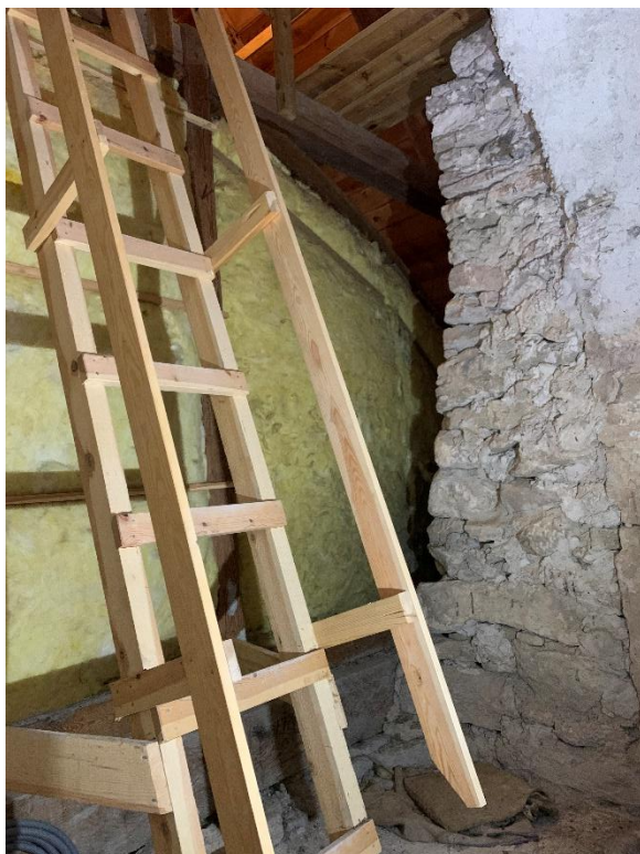
Öppningen från tornet till kyrkvinden. Till vänster uppgång till tunnvalvets ovansida. Under stegen finns den igensatta dörröppningen in till kyrkan. Till höger södra vederlaget i bågöppningen, visande tornmuren till höger och södra sidan av det medeltida långhusets västgavel till vänster. Foto JL 2022.
