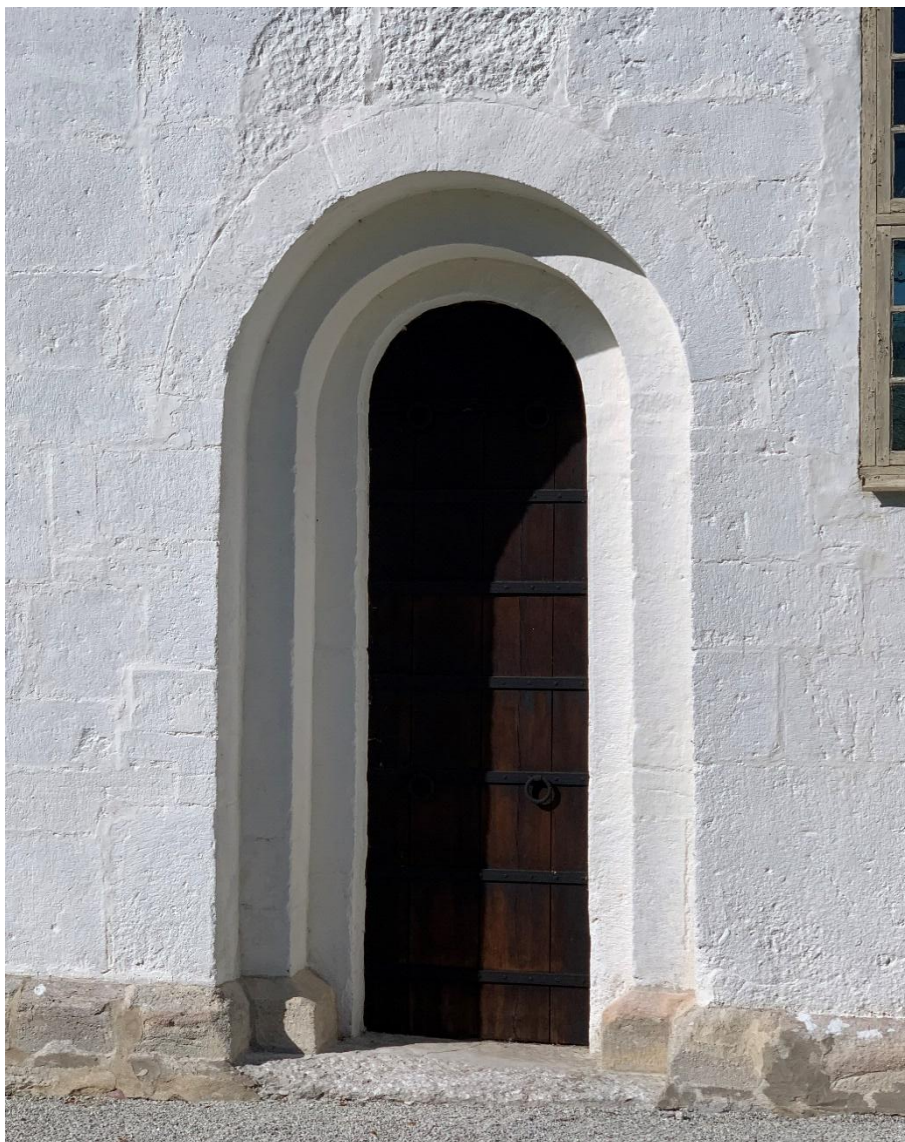
Sydportal i det romanska långhuset, sedan 1838-40 igenmurad inifrån. Foto JL 2022.
