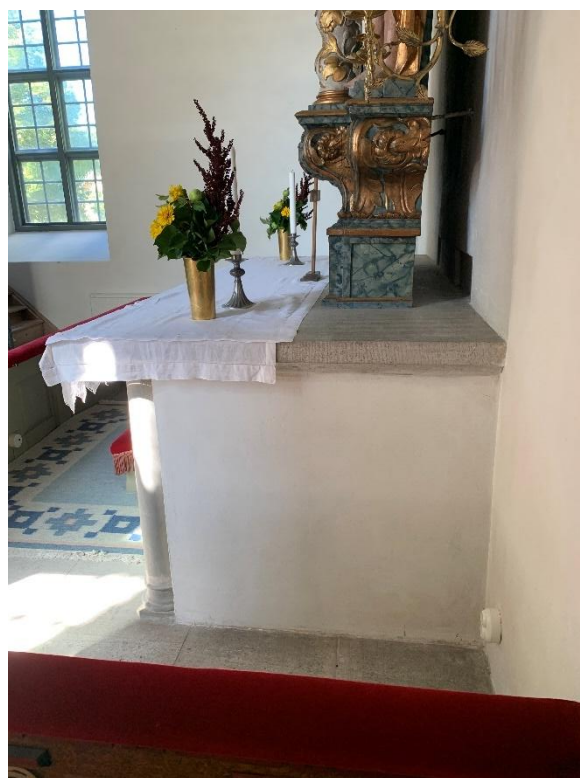
Murat altare från 1932 med två äldre sandstenskolonner, vilka även ingick i det föregående, panelade altaret med en murad kärna, från 1838-40. Foto JL 2022.
