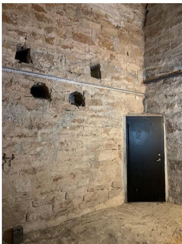
Första övervåningen sedd mot nordöst och sydväst med hål efter bjälkar, de övre sannolikt från bjälklag till en våning som endast nåddes nedifrån via stege, inte från murtrappan. Foto JL 2022.
