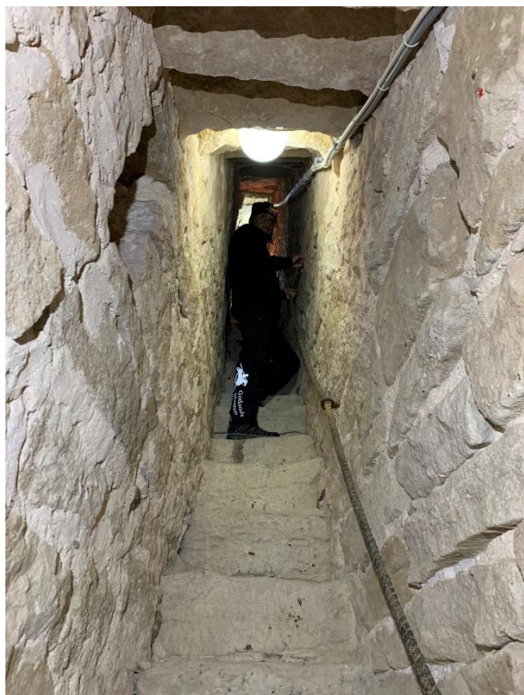
Murtrappan från första övervåningen upp genom södra muren. Ingången sedd från norr, med dörren vinklad för att få plats, samt trapploppet sett uppåt mot öster. Foto JL 2022.
