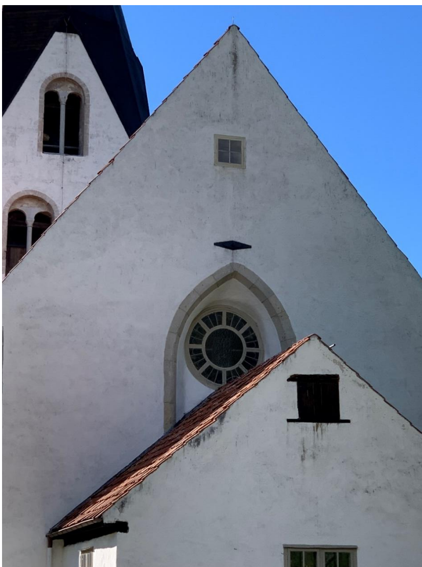
Övre delen av östra gaveln med östfönstret, omfattning till fönstrets tidigare form samt ljusöppning till kyrkvinden. Foto JL 2022.
