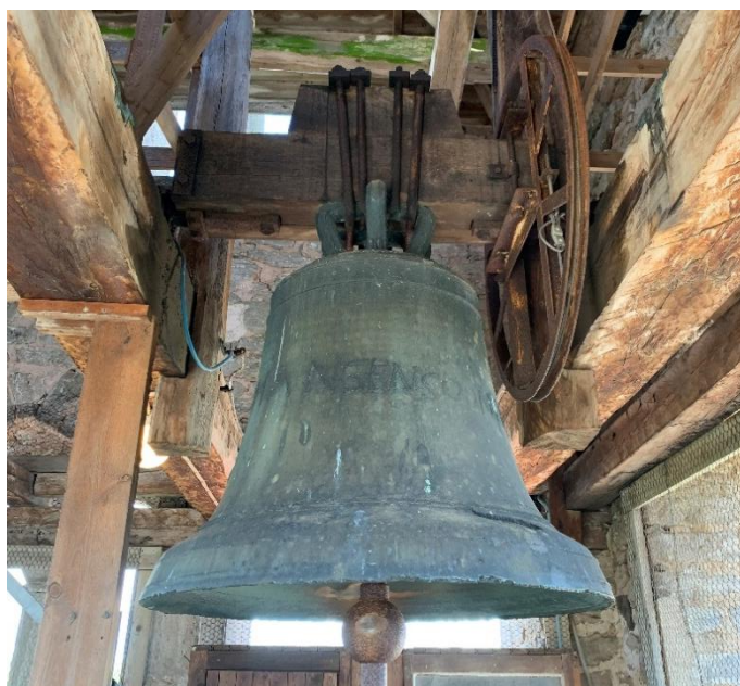
Klockan i tornet, sedd från öster och väster, gjuten 1650 vid kyrkan, sannolikt av malmen i en vid branden 1640 förstörd klocka, troligen i en 18 meter norr om tornet påträffad gjutgrop. Foto JL 2022.
