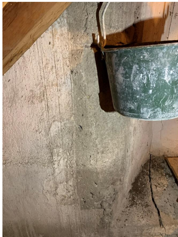
Sakristievinden mot nordöst. Till höger den medeltida fönsternischens västra post med skador, kanske av brand. Foto JL 2022.
