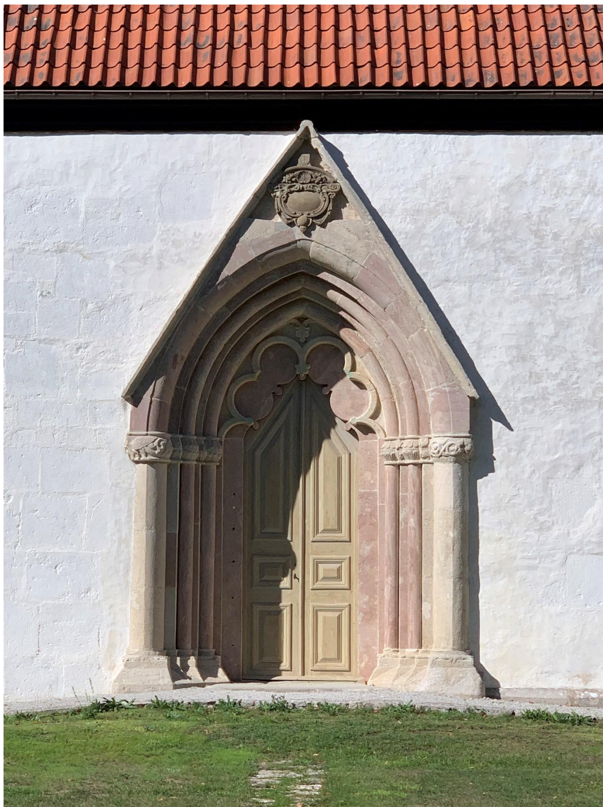
Den stora sydportalen, tidigare korportal i det gotiska koret, flyttad och restaurerad 1838-40. Foto JL 2022.
