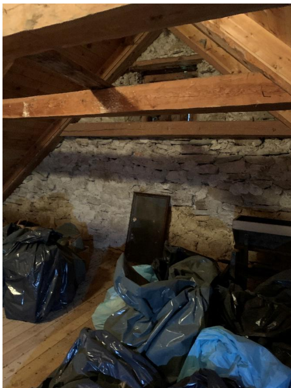
Sakristievinden mot nordöst. Till höger den medeltida fönsternischens västra post med skador, kanske av brand. Foto JL 2022.
