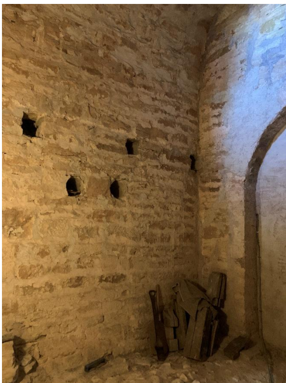
Första övervåningen sedd mot nordöst och sydväst med hål efter bjälkar, de övre sannolikt från bjälklag till en våning som endast nåddes nedifrån via stege, inte från murtrappan. Foto JL 2022.
