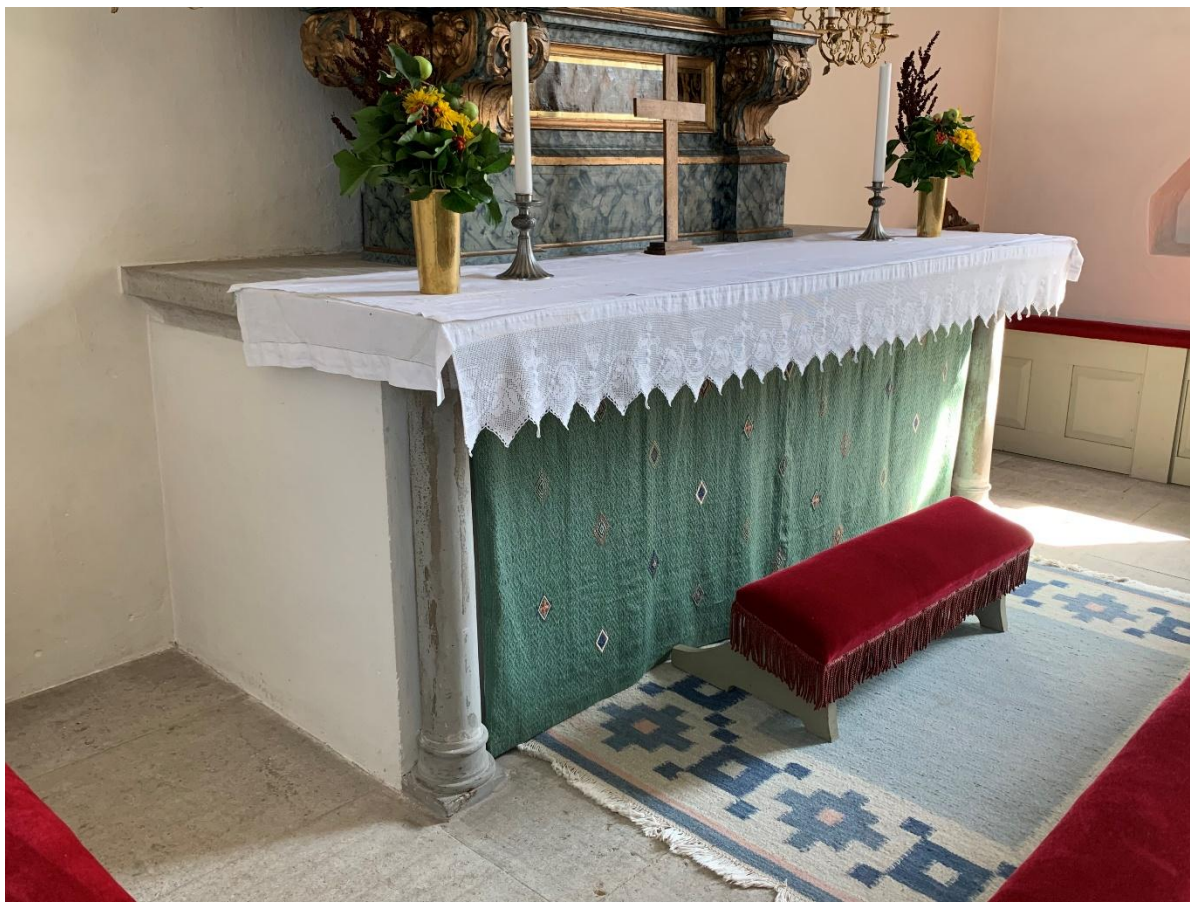
Murat altare från 1932 med två äldre sandstenskolonner, vilka även ingick i det föregående, panelade altaret med en murad kärna, från 1838-40. Foto JL 2022.
