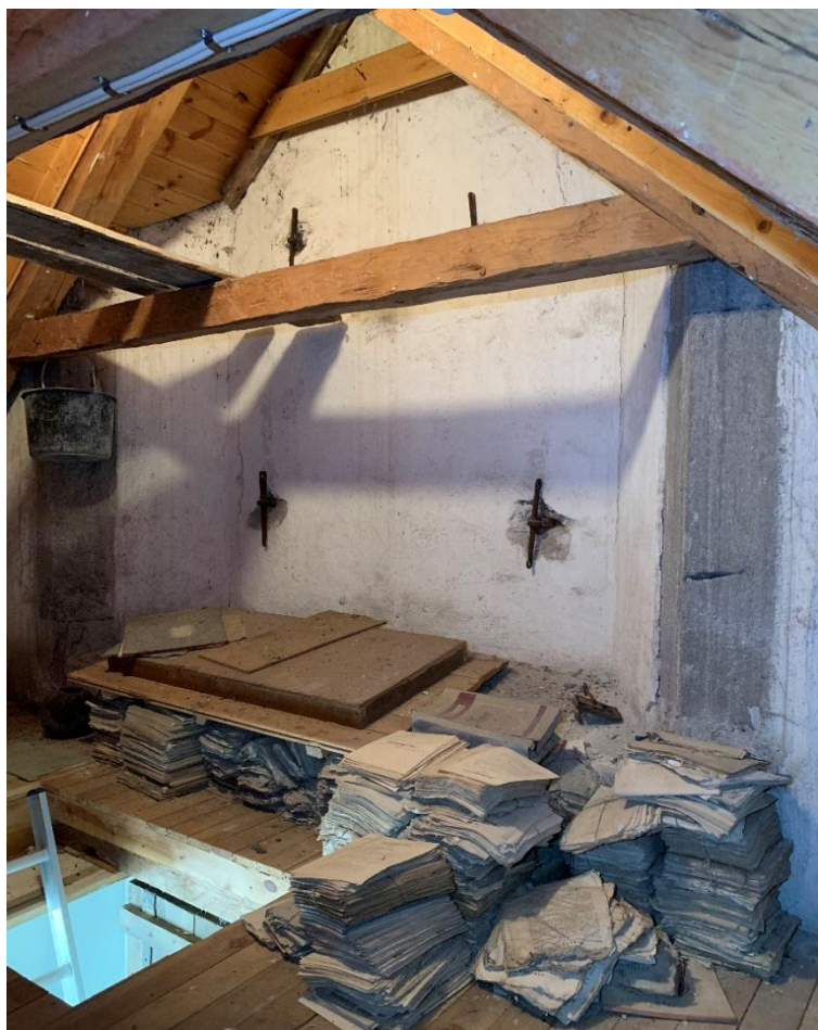
Ovan, sakristians vind mot väster. Till vänster nischen för det igenmurade östra fönstret. Kramlorna håller altaruppsatsen på plats. Att nischen är putsad under taket tyder på att detta murparti en gång varit synligt, men kanske bara under några få år innan sakristian var färdigbyggd. Foto JL 2022.
