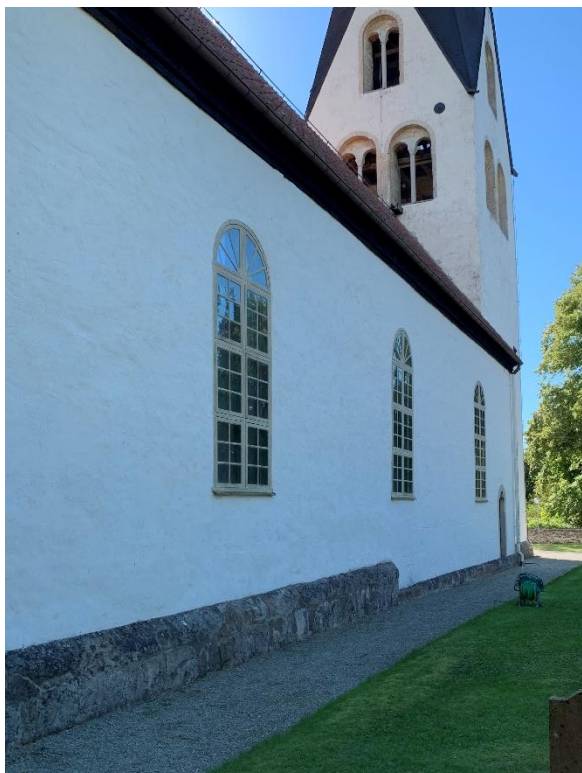
Kyrkans norra fasad mot väster. Sockeln byter höjd vid gränsen mellan det medeltida koret och långhuset. Till höger del av det medeltida långhusets kvaderstensfasad. Foto JL 2022.
