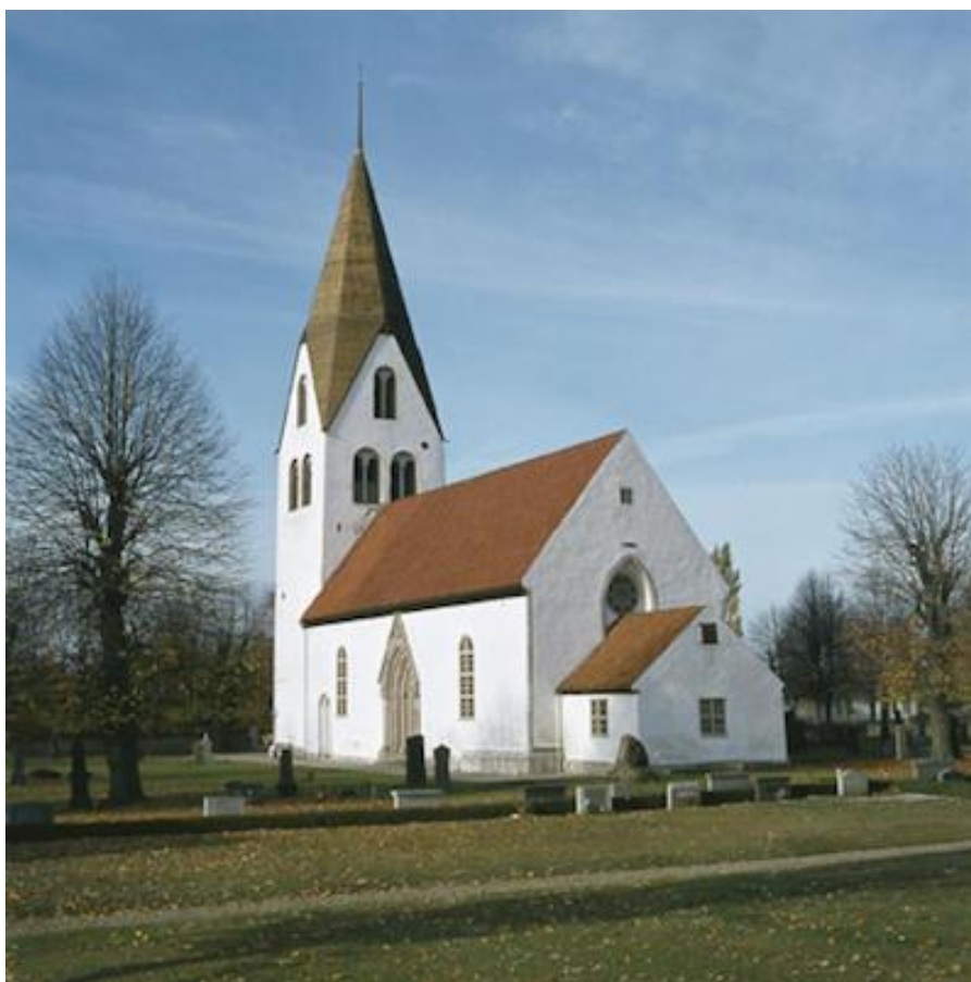
Ovan exteriör från sydöst, troligen på 1960-talet. Foto Hans Hemlin, Gotlandskonst, efter vykort i Gotlands Museum. Till vänster exteriör från sydöst efter 1970-talets restaurering. Foto Raymond Hejdström 1978, Gotlands Museum (GFFS005O31_).
