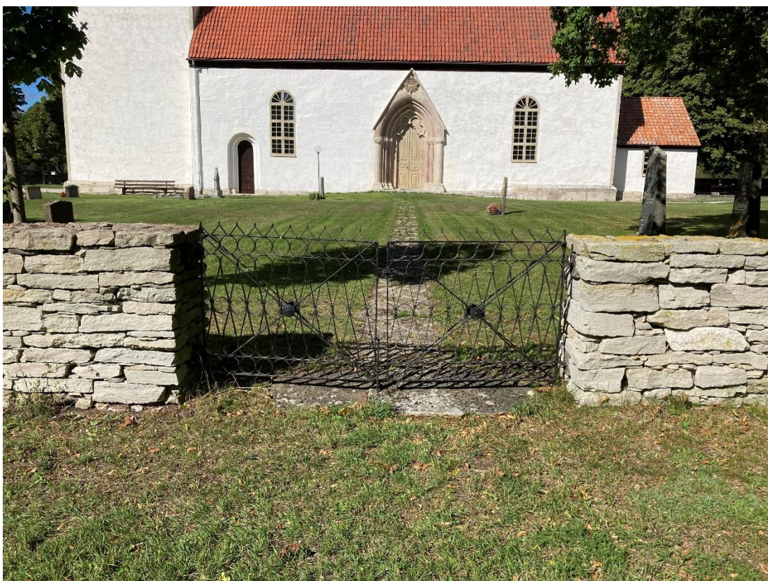
Den södra grinden leder till prästgården. Öppningen tillkom 1887 och grinden är tillverkad av bandjärn av samma utseende som det försvunna staketet i väster. Foto ES 2022.
