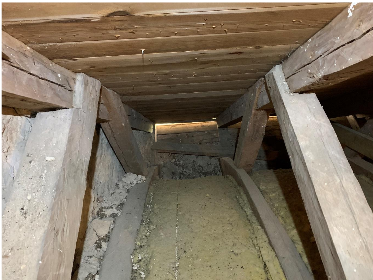
Tunnvalvets ovansida i vindens sydöstra hörn med bågformat trä för att bära tunnvalvet. Foto JL 2022.
