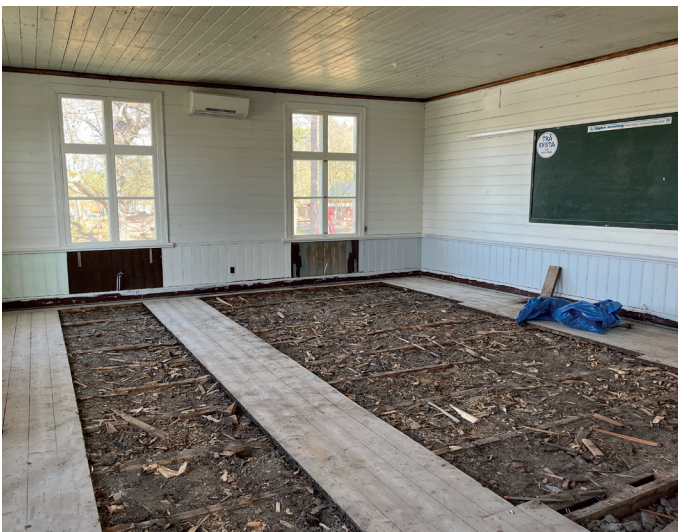
Gamla skolsalen under renoveringsarbetet.
