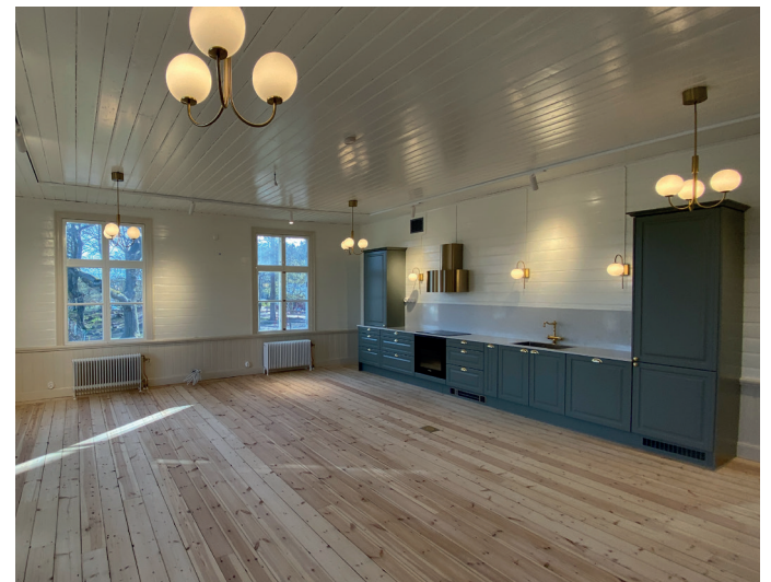
Gamla skolsalen nyrenoverad. De gamla golvplankorna har slipats och återanvänts och ett kök har installerats.
