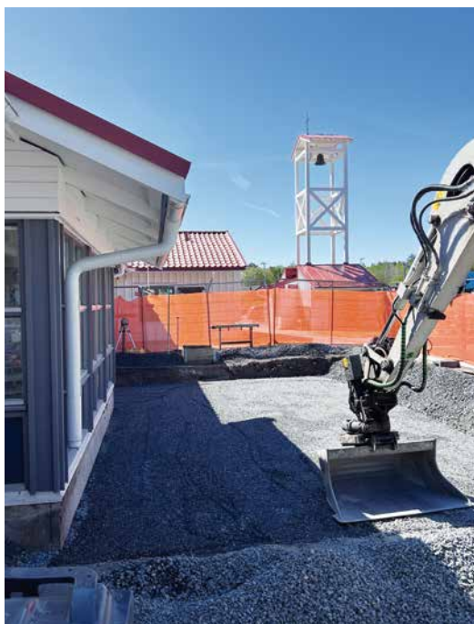
Arbetet med grunden till utbyggnaden av ungdomsrummet påbörjades i maj.
