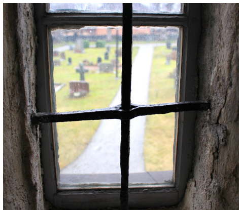
Fönster mot väster.
