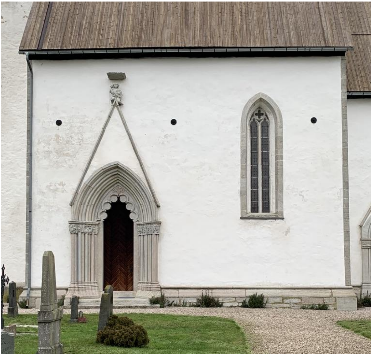
Långhusets södra fasad. Foto JL 2019.
