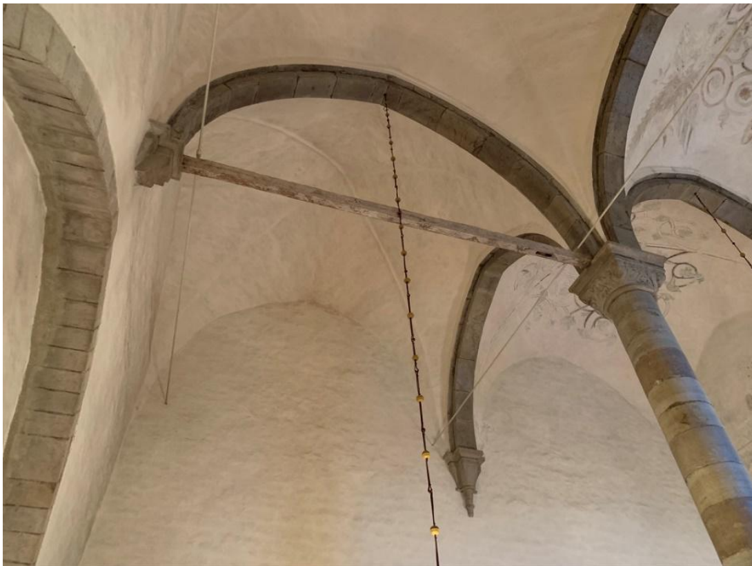
Medeltida hissbom i långhusets västra del med trissa för dopfuntslocket. Foto JL 2019.
