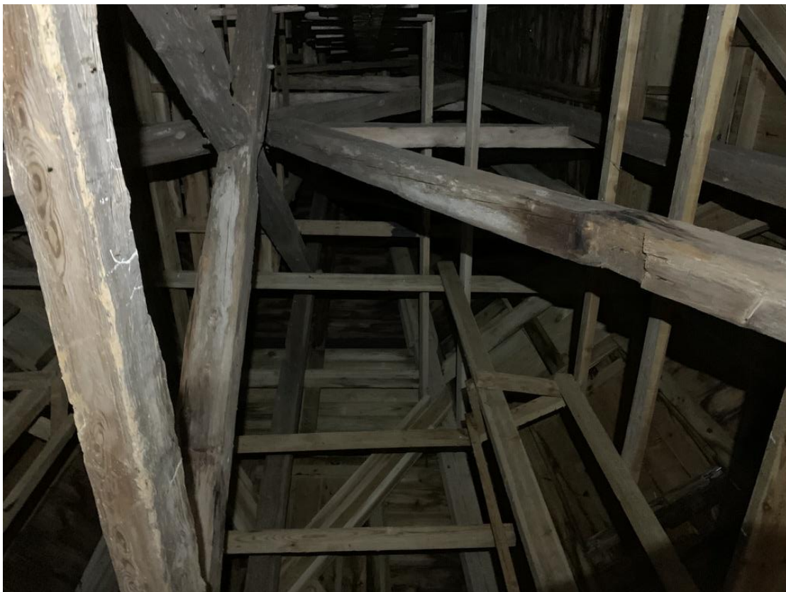
Tornhuvens konstruktion, sedd underifrån. Foto JL 2020.
