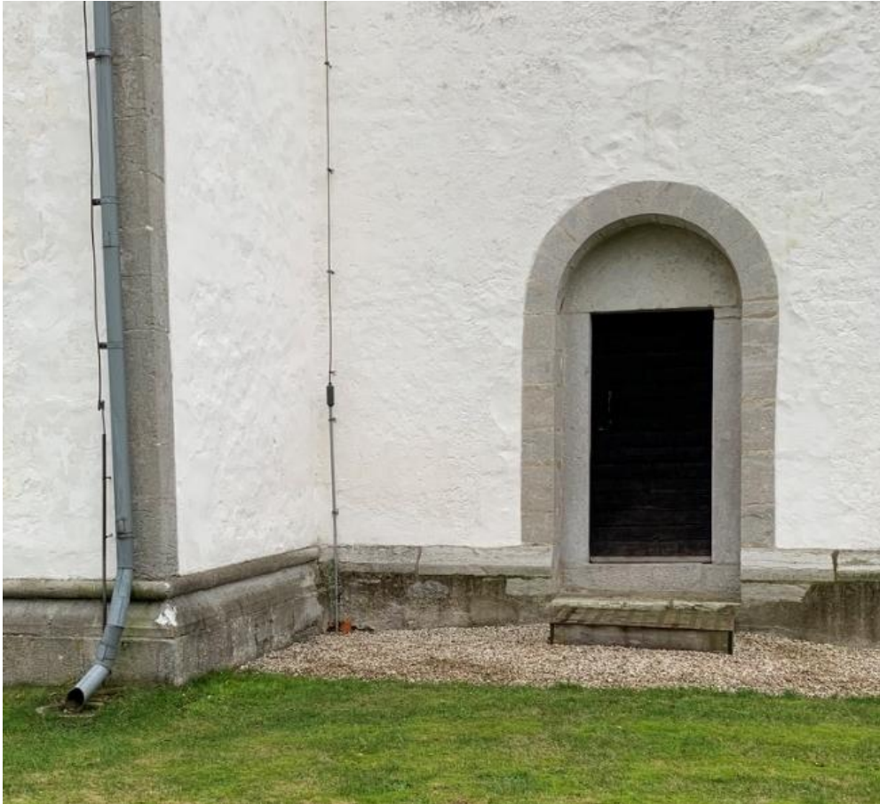
Tornets nordportal. Foto JL 2019.
