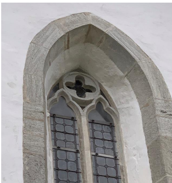
Långhusets södra fönster, masverket. Foto JL 2019.
