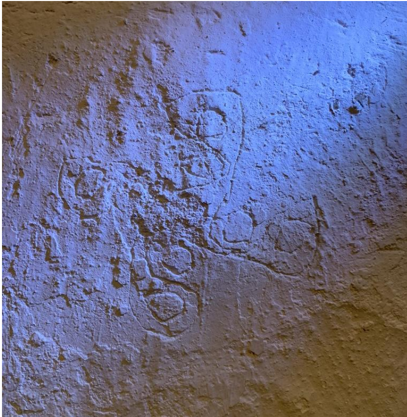
Ristning på södra muren i sakristian. Foto JL 2019.
