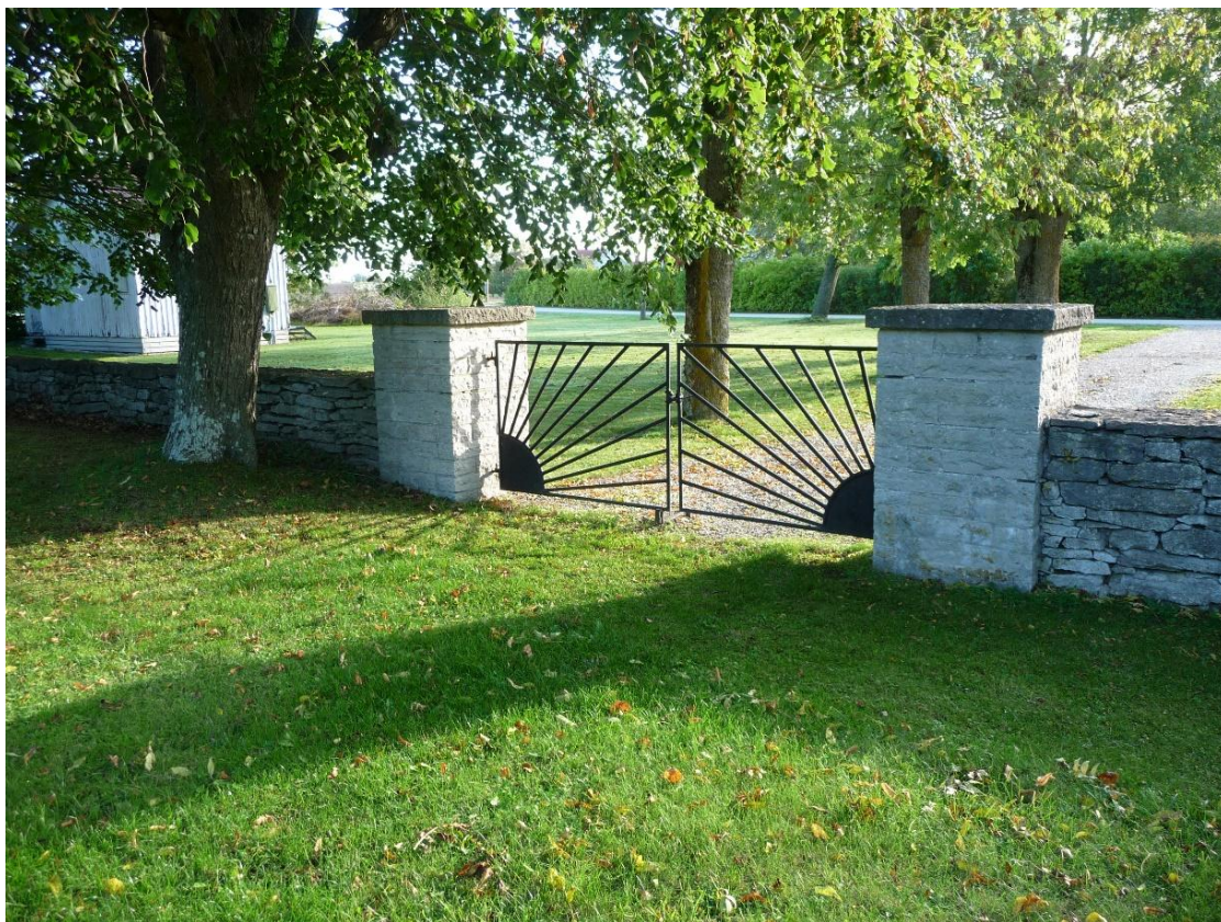
Vid den östra ingången finns en grind i smidesjärn, flankerad av kalkstensstolpar. Foto ES 2019.
