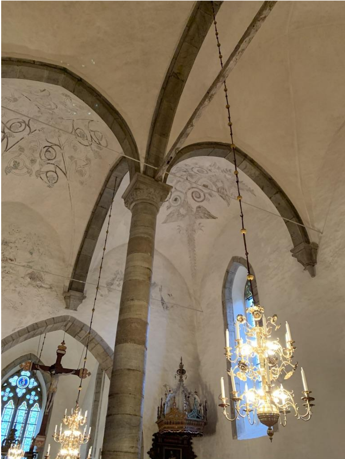
Långhusets valv sett underifrån mot sydöst. Kalkmålningarna från 1300-talet framtogs 1978-80. Foto JL 2019.
