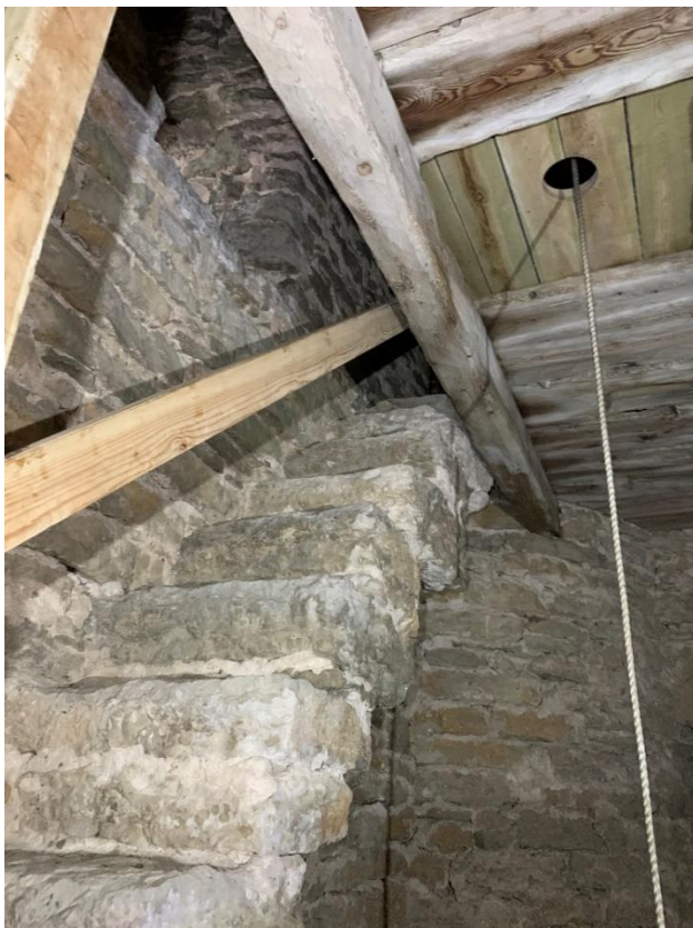
Tornets första övervåning sedd mot sydväst. Trappan längs södra muren till tredje våningen med utkragande steg. Foto JL 2019.
