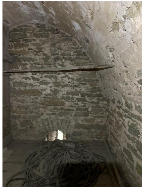
Tornets andra övervåning mot väster. Foto JL 2019.
