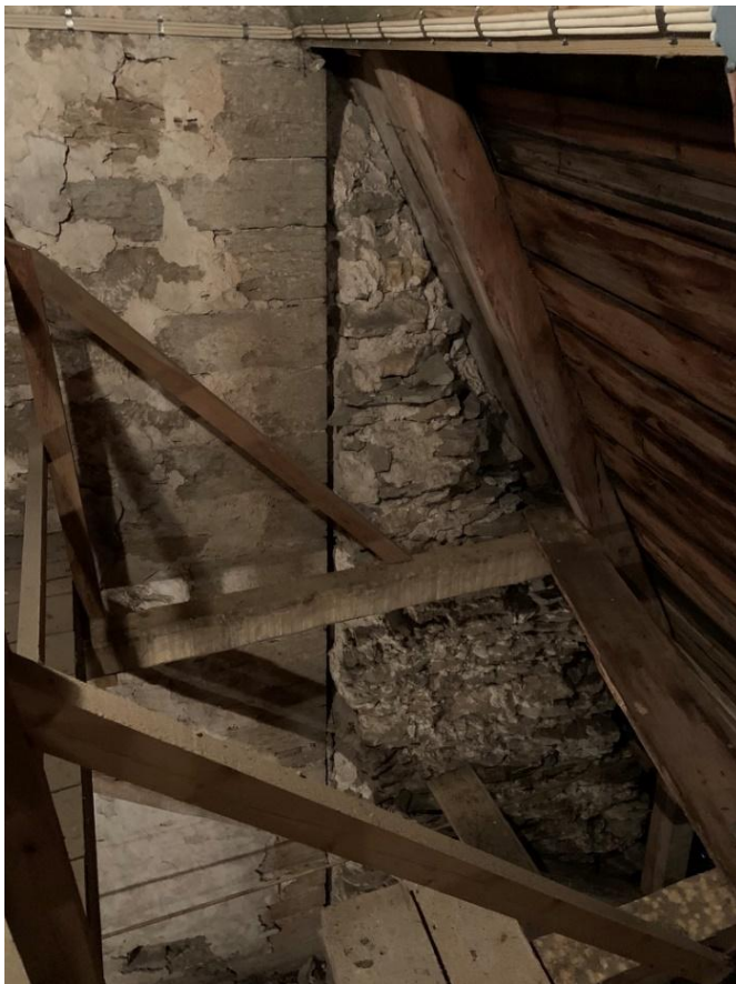
Långhusvindens nordvästra hörn med tornets nordöstra hörn, och till höger fyllnadsmur för långhusets västgavel. Foto JL 2019.
