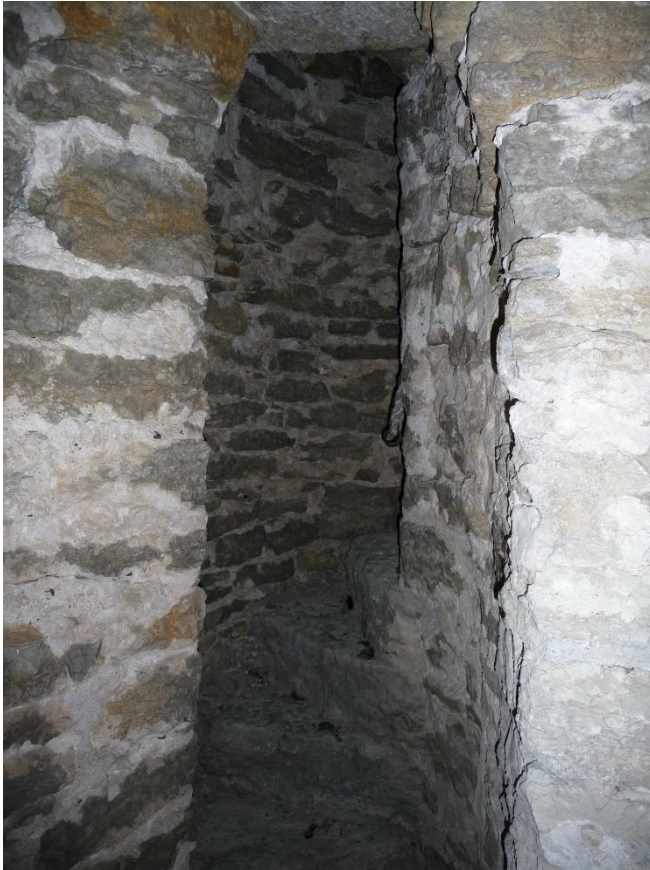
Spiraltrappan mellan tornets andra och tredje övervåning, sedd nerifrån. Foto ES 2019.
