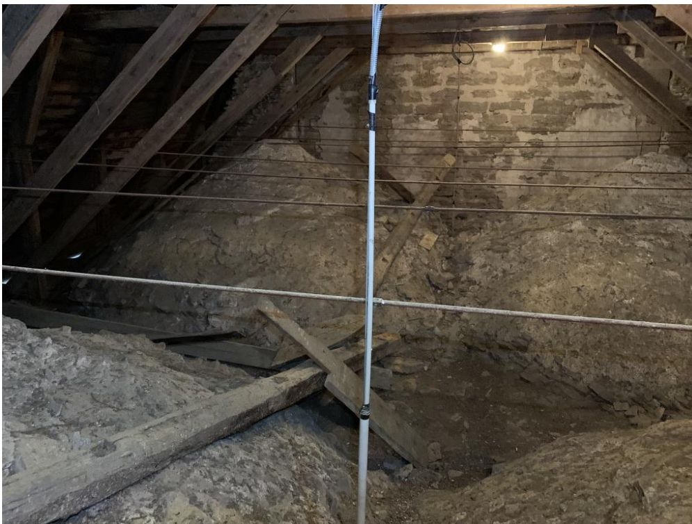
Långhusvinden med valvens ovansida sedd mot väster. I fonden tornets murverk med det romanska långhusets takfall skönjbart som en triangulär skugga. Foto JL 2019.
