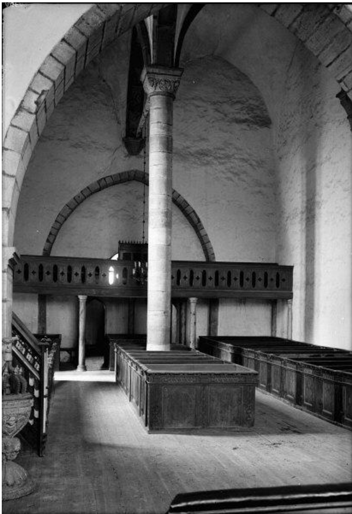
Foto mot väster före restaureringarna 1937–38, då bänkkvarteret väster om mittkolonnen togs bort, och 1978–80, då läktaren revs. Dopfunten stod i korets sydvästra hörn. Foto Erik Fant, troligen från 1910- eller 20-talet. RAÄ, Kulturmiljöbild.
