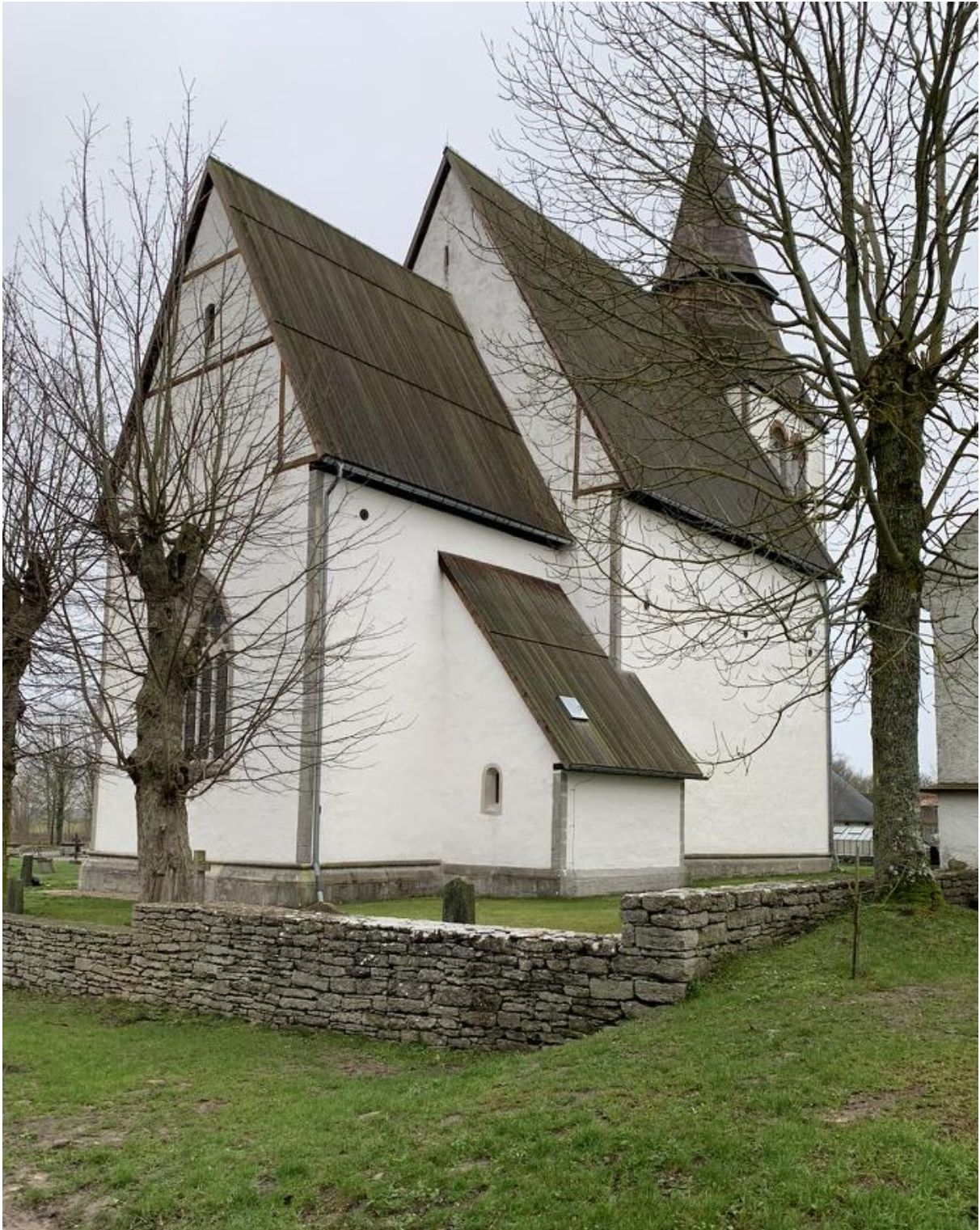
Exteriör från nordöst. Foto JL 2019.
