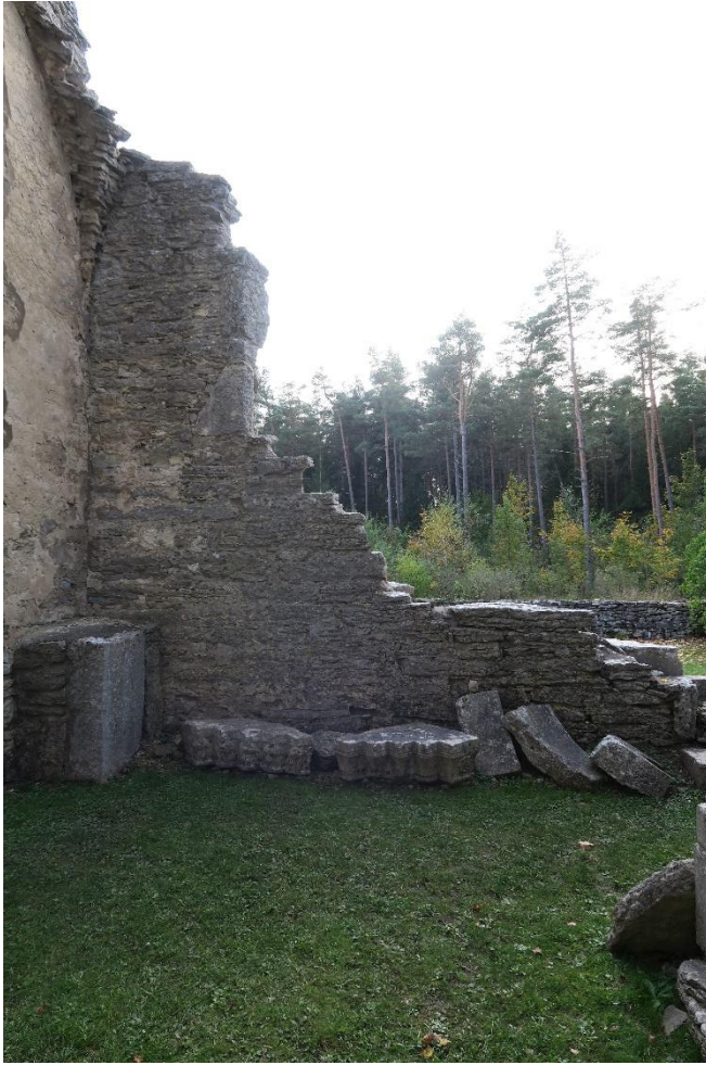
Långhusets östra del mot söder med det tidigare långhusfönstrets östra smyg och sidoaltaret samt delar av södra långhusportalens kapitälband, dopfunten och nisch till vigvattenskar från södra långhusportalen. Foto Pär Malmros 2020. Visby stift.
