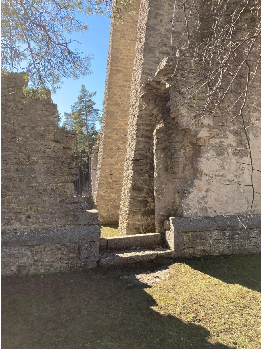
Långhusets nordportal. I bakgrunden strävpelarna från 1923. Foto Ola Nyström 2021. Gotlands Museum.
