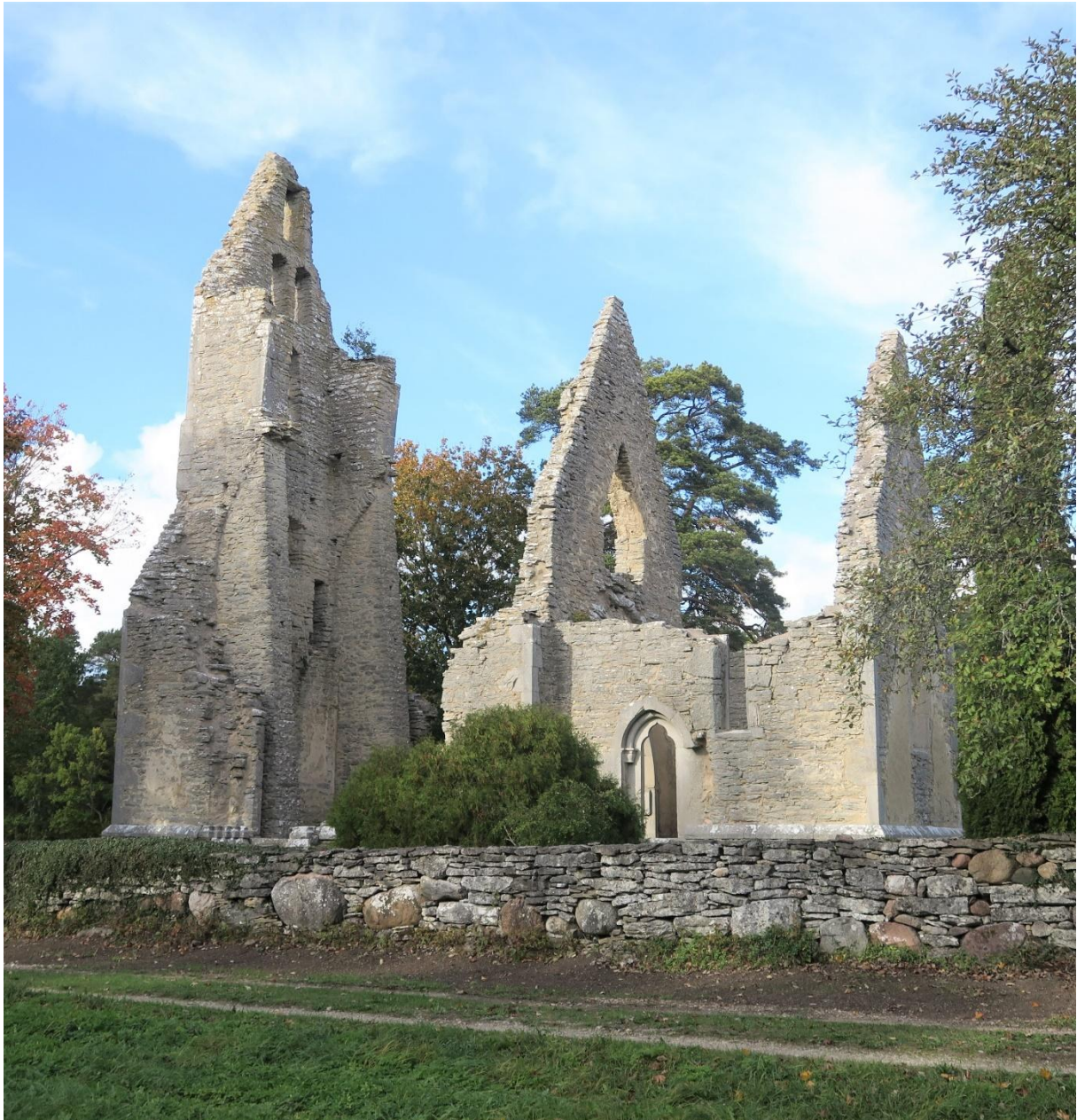
Exteriör från sydöst. Foto Pär Malmros 2020. Visby stift. Kyrkan byggdes under 1200-talets mitt och andra hälft. Tornet blev sannolikt klart i början av 1300-talet. Vid 1500-talets slut kunde den inte längre användas. Vid den första konserveringen, genomförd år 1923, säkrades den kvarstående torngaveln med strävpelare. Ruinen är sannolik en av de högsta medeltida kyrkoruinerna i landet, bortsett från de i Visby och Sigtuna.
