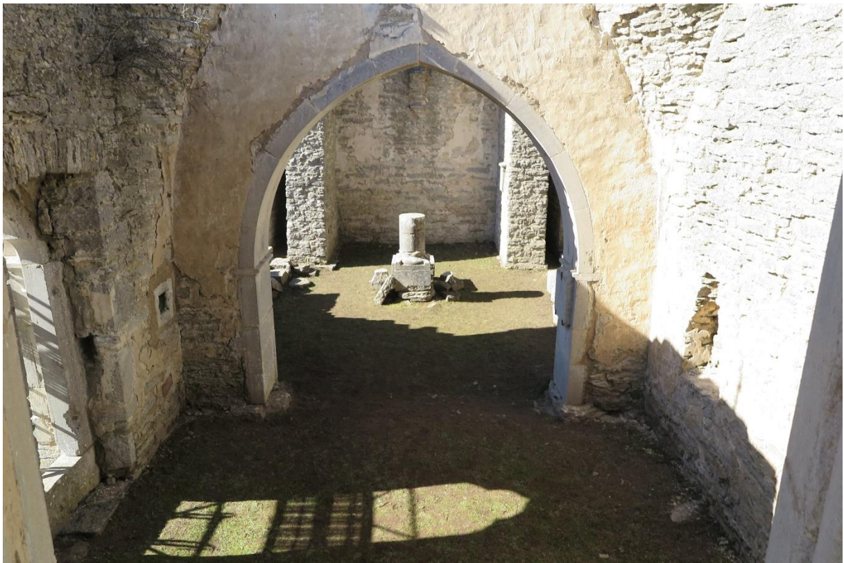
Interiör mot väster genom korets östra fönster. Foto Ola Nyström 2021. Gotlands Museum.
