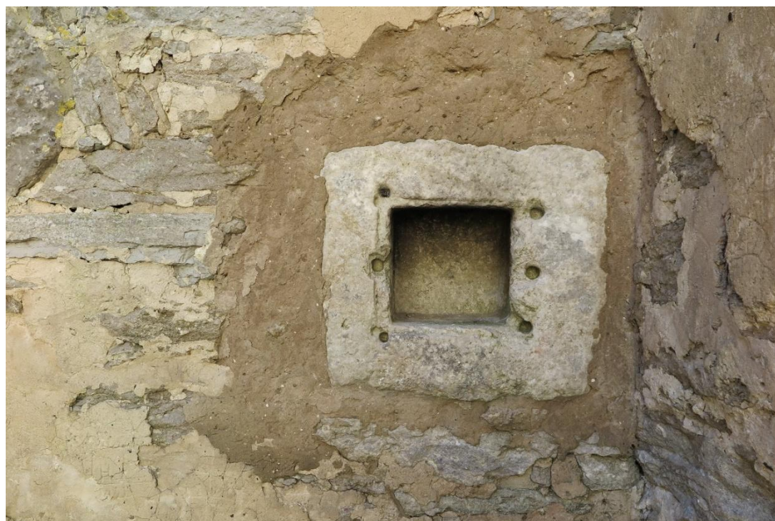
Nisch i korets nordvästra hörn med hål efter gångjärn och lås. Foto Ola Nyström 2021.
