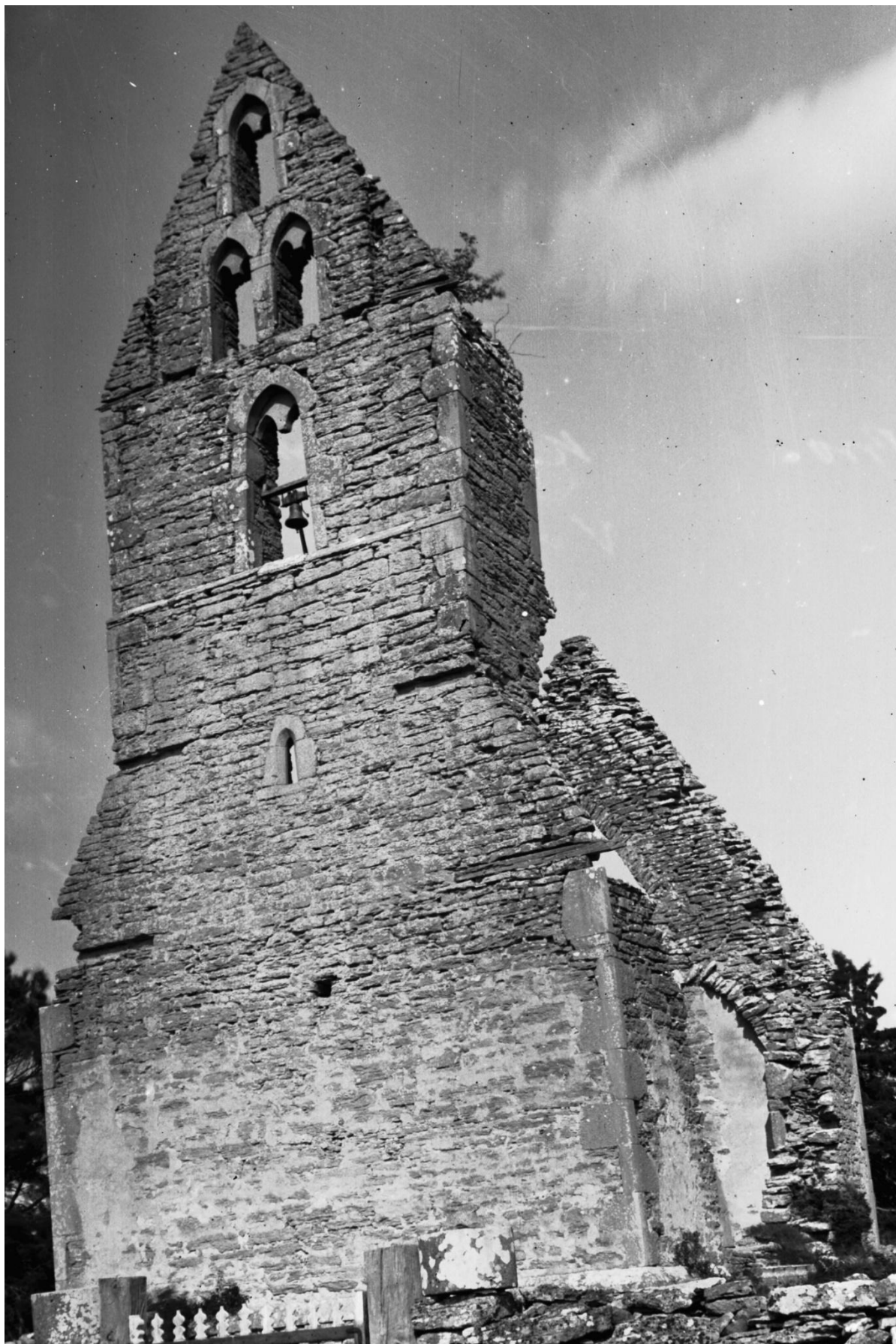
Beskuren förstoring av föregående foto från ca 1890. Några trästycken sitter ännu i fasaden. Av andra foton framgår att de fanns kvar till konserveringen 1923.
