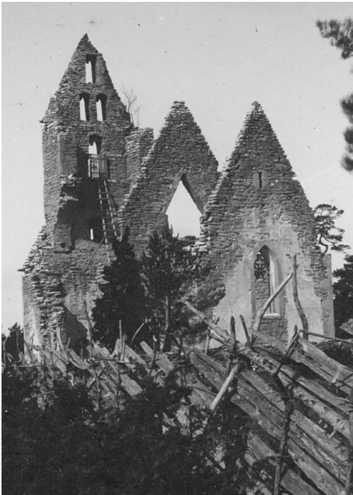
Exteriör från sydöst. Foto Axel Henrik Böhme, 1890-talet. Gotlands Museums arkiv (940:5). Ny inbyggnad vid klockan har tillkommit, men synes snart åter ha avlägsnats. Östgavelns bevarade puts framgår av bilden. Torngavelns spets är ännu i behåll.
