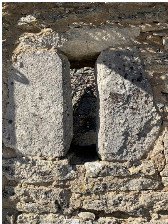
Till vänster detalj av östfönstrets masverk med synliga falsar och hål för infästningar. Till höger ljuslugg till vinden uppe i korets gavelröste. Öppningen i västfasaden, synlig i bakgrunden, sitter i samma nivå. Foto Ola Nyström 2021. Gotlands Museum.
