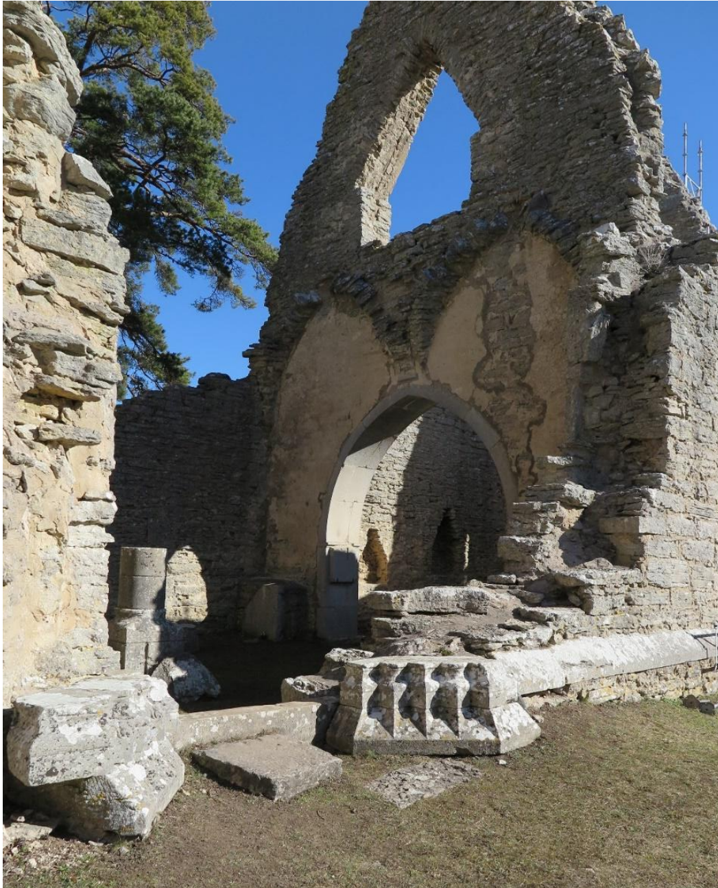
Långhusets sydportal. I den borte brottytan efter den nedrasade muren sitter den östra posten av det medeltida fönstret kvar. Foto Ola Nyström 2021. Gotlands Museum.
