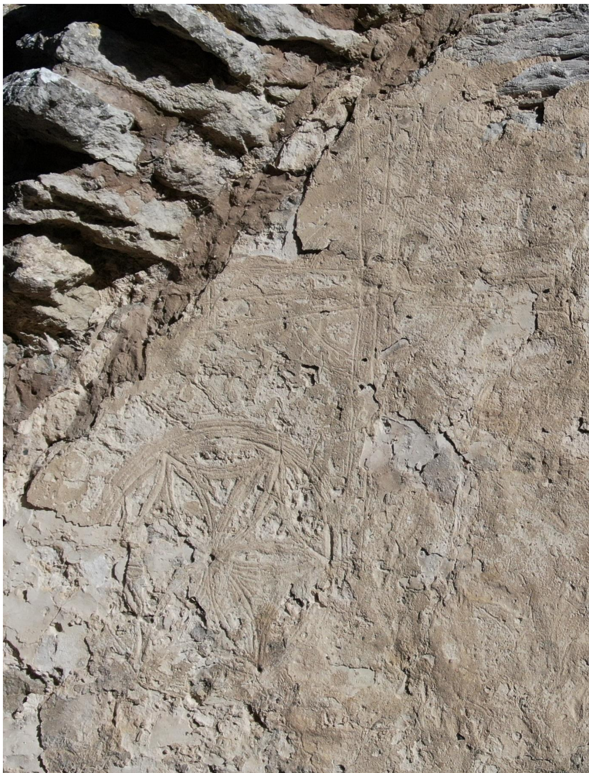
Putsristningar på långhusets östra mur, norra sida. Passarros och ringkors, sannolikt underlag för kalkmålningar. Foto Pär Malmros 2020. Visby stift.
