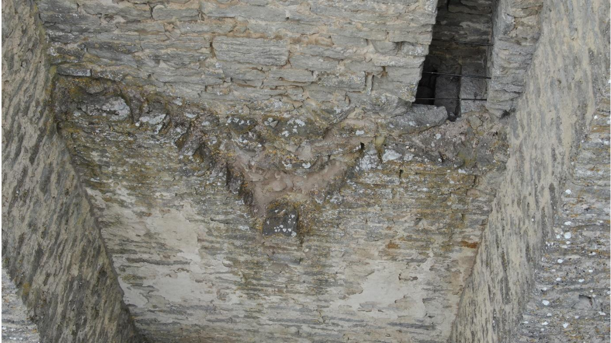
Tornmuren med sköldbågar och brottyta efter valven samt trappmyningen sedd ovanifrån. Foto Pär Malmros 2020.
