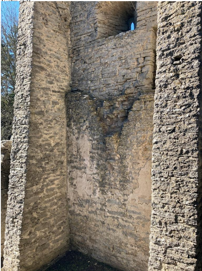
Tornmuren med sköldbågar och brottyta efter valven samt trappmyningen sedd ovanifrån. Foto Pär Malmros 2020.
