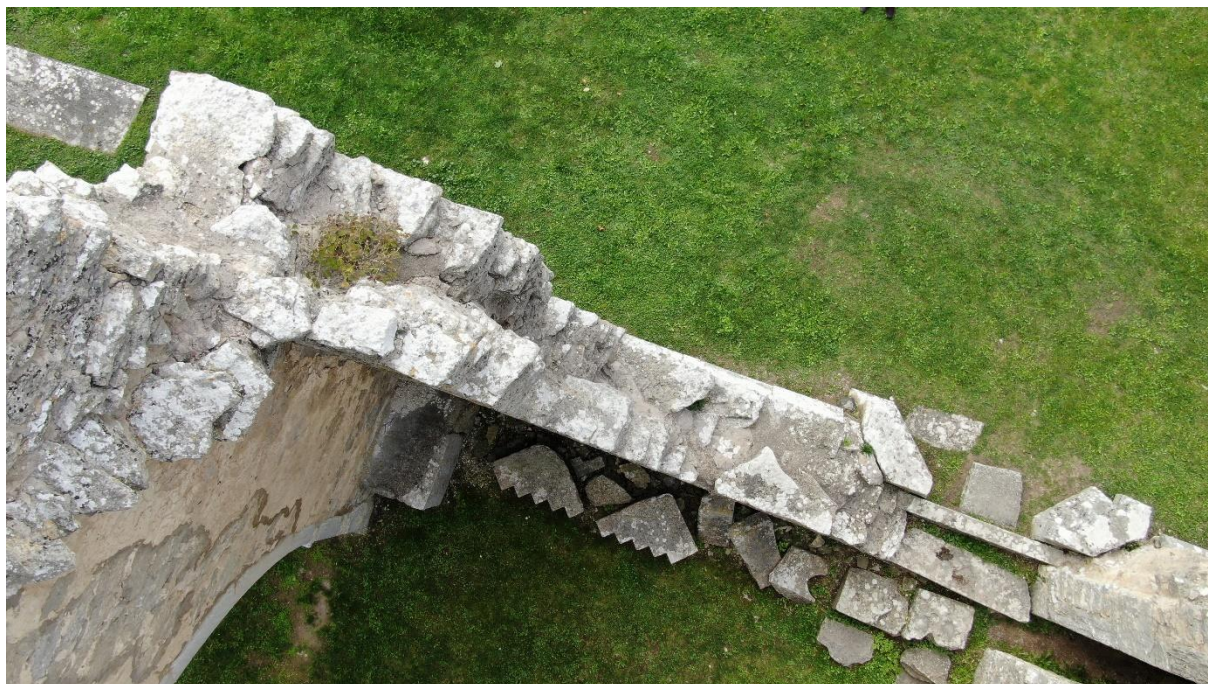
Långhusets södra mur sedd uppifrån, söder snett uppåt. Södra långhusportalen med sin utskjutande omfattning till höger i bild. Innanför muren syns lapidariet av delar till portalen och andra stendetaljer. Foto Pär Malmros 2020. Visby stift.
