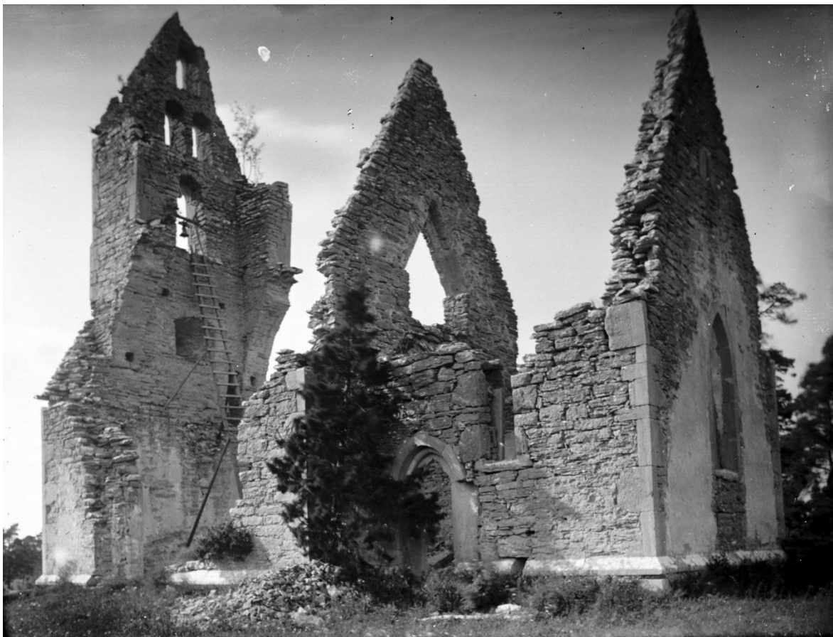
Exteriör från sydöst. Foto Olof Sörling omkring 1890. ATA, RAÄ Kulturmiljöbild. Tornets karaktär innan strävpelarna byggdes framgår, liksom de stora hålen för dragbjälkar vid båganfängen på tornets sidor. Södra långhussockeln är frilagd från rasmassor. Stegen är förnyad och centrerad, plattformen kring klockan avlägsnad.
