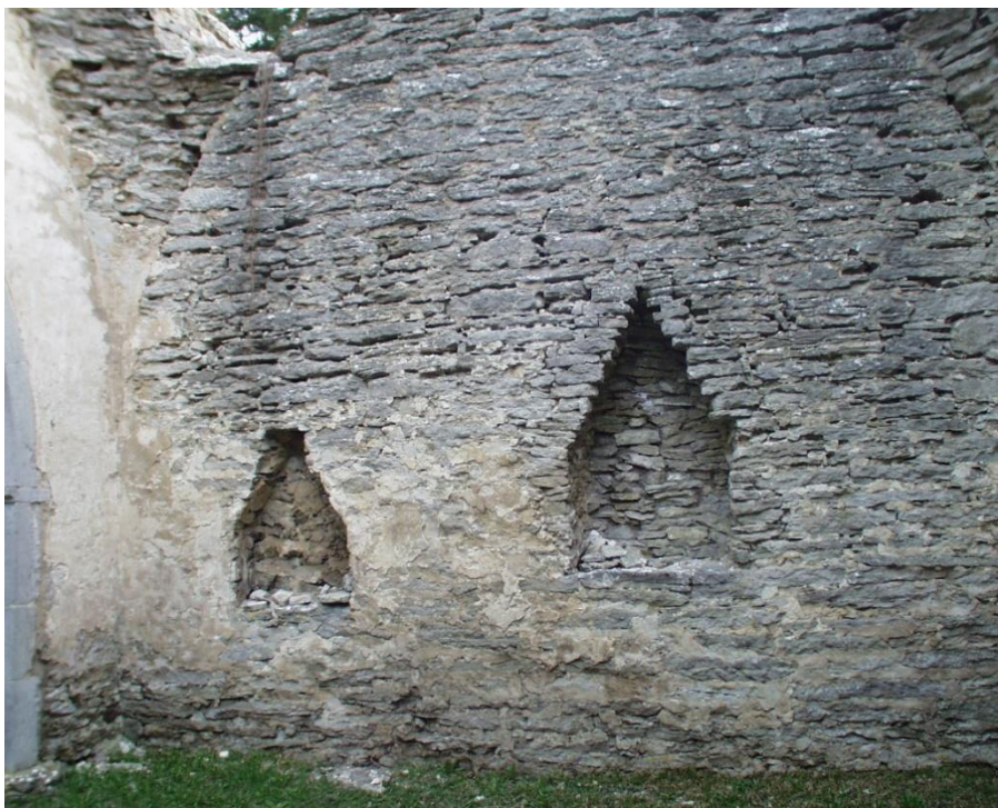
Nischer i korets norra mur. Foto Peter Olsson 2002. Gotlands Museum, (GF1151-008). Jämfört med bilder från ca 2020 framgår viss skillnad i hur mycket puts som är bevarad.
