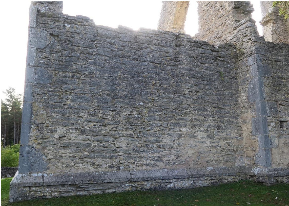
Korets norra fasad och långhusets nordöstra hörn. Foto Pär Malmros 2020. Visby stift.
