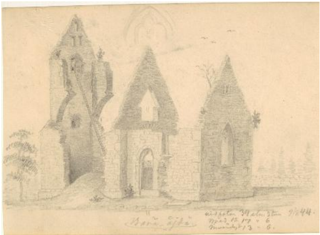
Exteriör från sydöst. Blyertsteckning av Pehr Arvid Säve 1844. UUB, Alvin (92584). En inbyggnad för klockringning finns i ljudgluggen. Rasmassornas fyller en stor del av långhuset och skymtar även genom korportalen. De grävdes bort, sannolikt i omgångar ca 1860-ca 1920.
