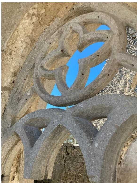
Till vänster detalj av östfönstrets masverk med synliga falsar och hål för infästningar. Till höger ljuslugg till vinden uppe i korets gavelröste. Öppningen i västfasaden, synlig i bakgrunden, sitter i samma nivå. Foto Ola Nyström 2021. Gotlands Museum.
