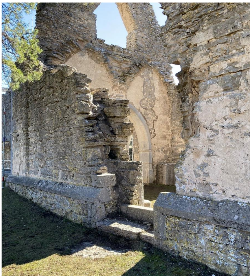
Långhusets nordportal samt den öster om portalen utåt tryckta muren. Foto Ola Nyström 2021. Gotlands Museum.
