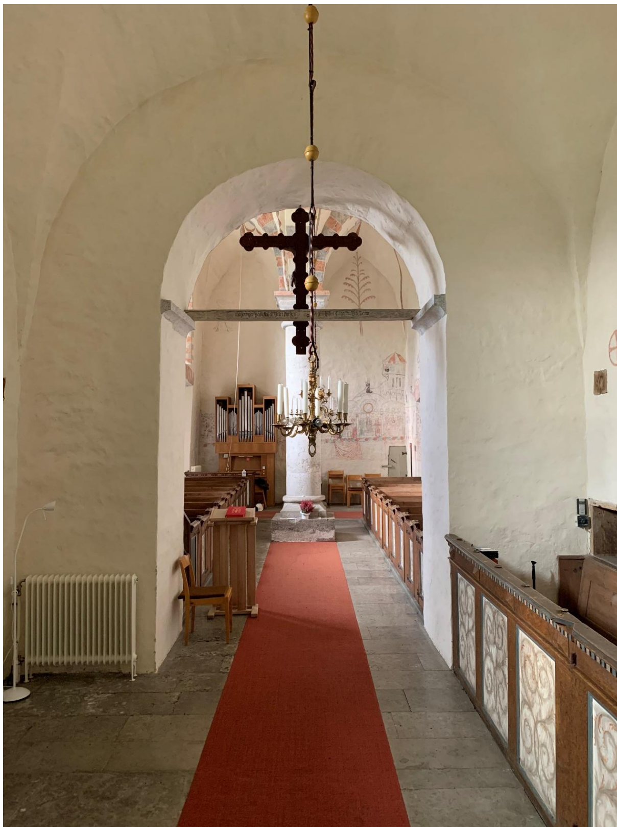
Triumfbågen sedd från öster. Foto JL 2020.
