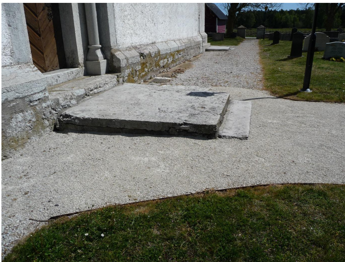
Entrén till kyrkan med en stor kalkhäll som trappsten. Foto ES 2020.
