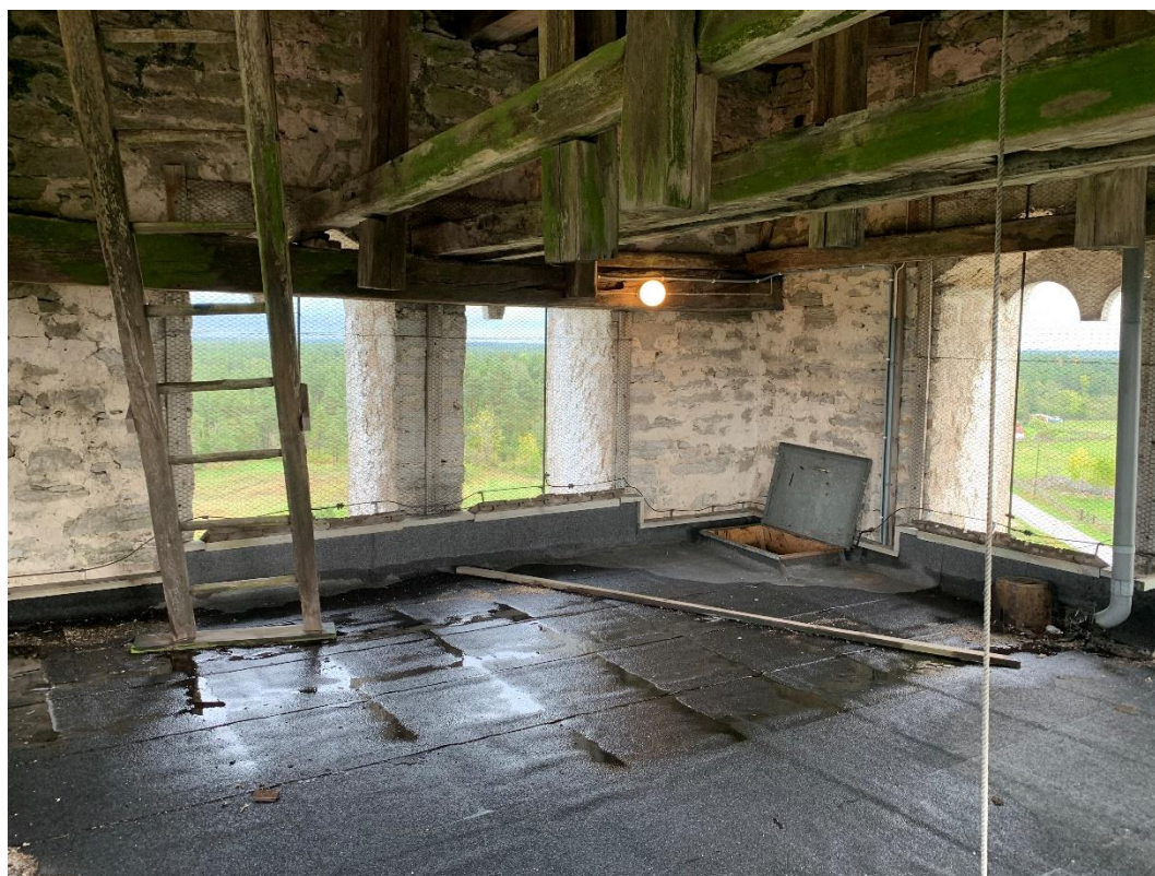
Tornets tredje övervåning, ursprungligen klockvåning, sedd mot nordöst. Foto JL 2020.
