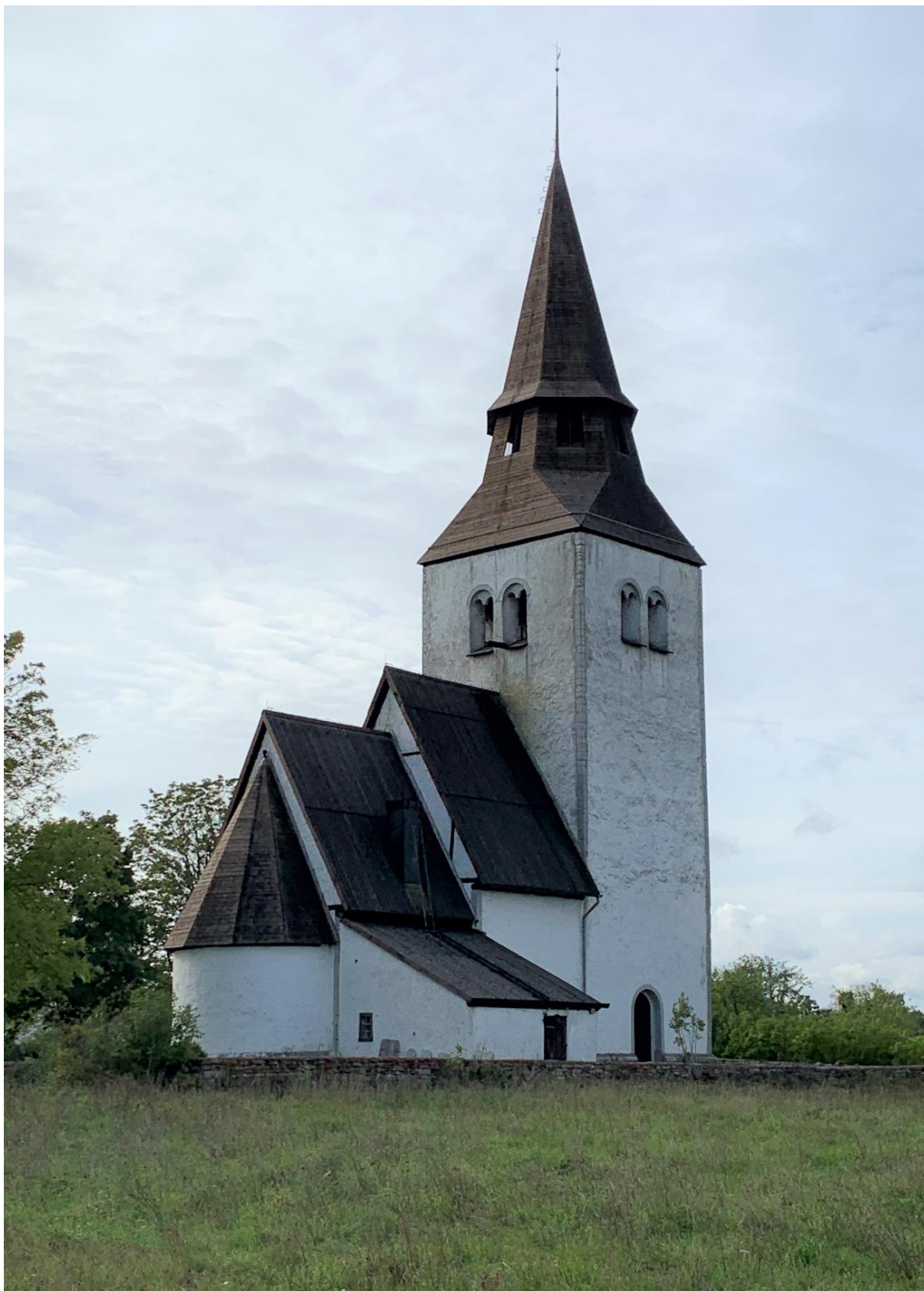
Exteriör från nordöst. Foto JL 2020.
