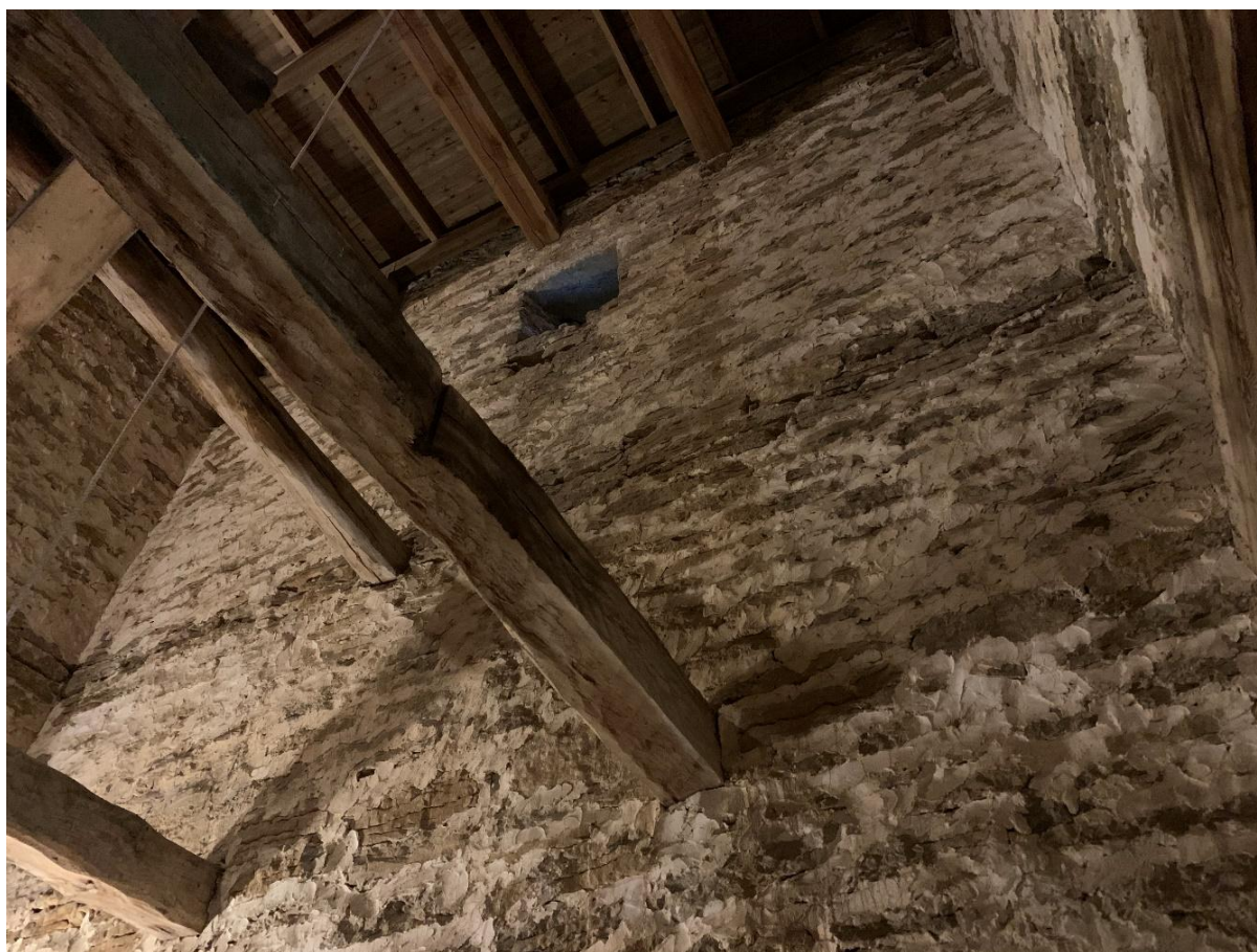
Tornets södra mur sedd uppåt från tornets första övervåning. Bjälkarna i förgrunden bär i sin norra del den halva andra övervåningen. Bjälken i mitten har en skåra, sannolikt från en klocklina. Foto JL 2020.
