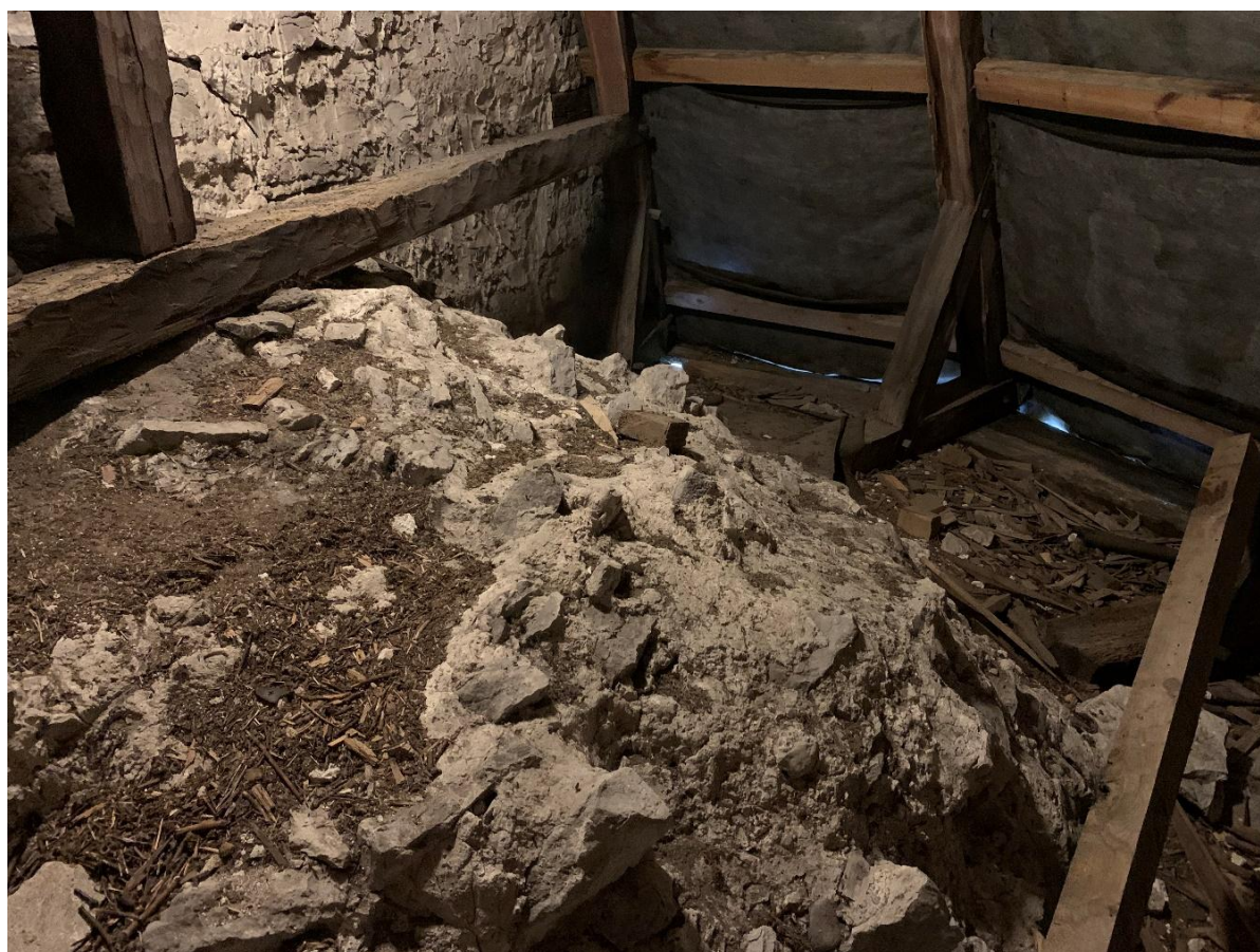
Absidens vind sedd mot nordväst med ovansidan av hjälmvalvet. Foto JL 2020.
