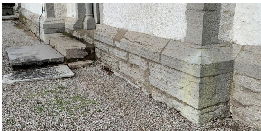
Långhusets sydöstra hörnkedja. Ovan hörnet långhus och kor, t.v. korets sockel. Foto JL 2020.
