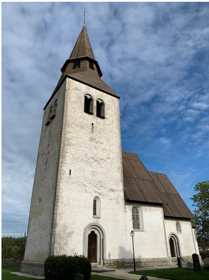
Exteriör från sydväst Foto JL 2020.
