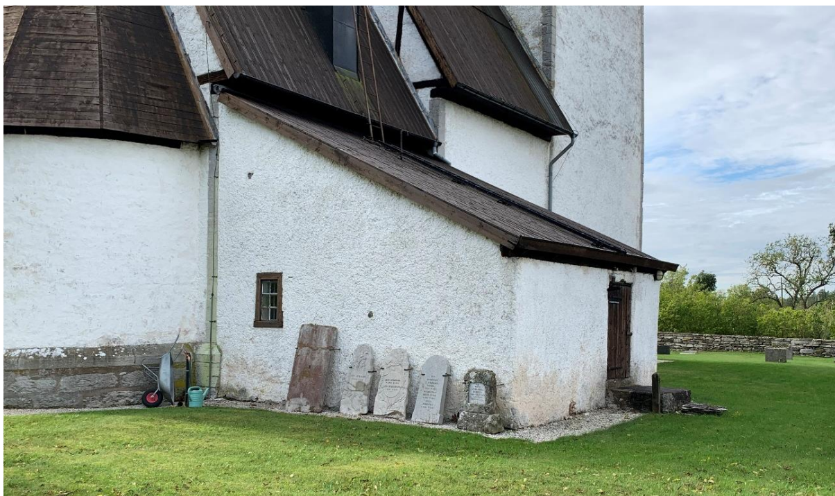
Absiden och sakristiebyggnaden med sockenmagasin från nordöst. Foto JL 2020.
