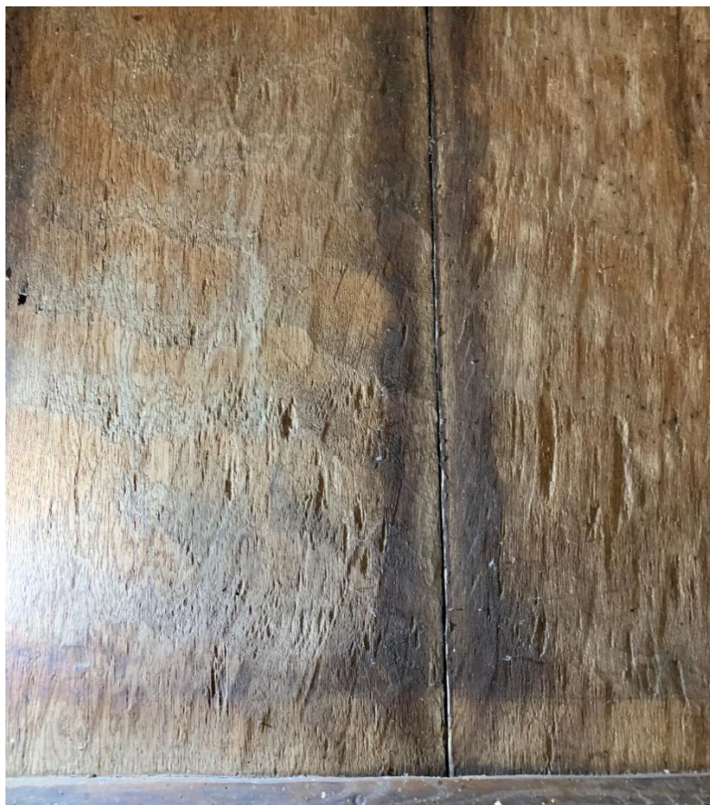
Detalj av dörrbladens insida i långhusets sydportal, ovan, och nordportal, nedan. Foto JL 2020.
