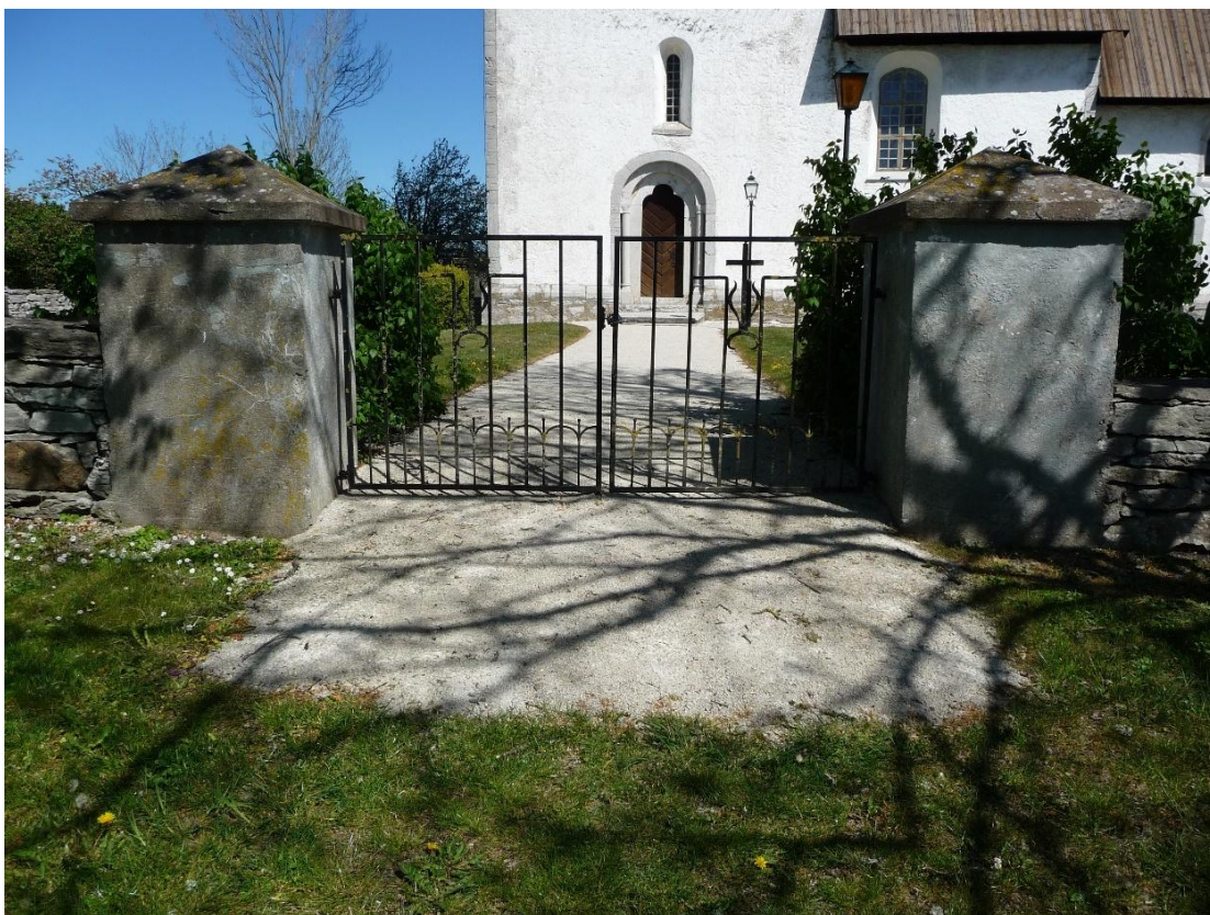
Ingången från söder. En grind i svartmålat järn flankeras av fyrkantiga stolpar med pyramidformade överliggare, putsade med cement. Denna typ av putsade fyrkantiga stolpar fanns 1890. Tidigare pryddes överliggarna av klot. Foto ES 2020.
