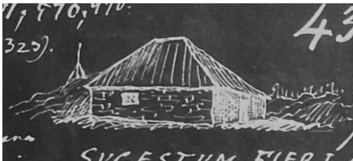
Exteriör av det murade kapellet från nordväst vid 1800-talets mitt medan det ännu stod under tak. Teckning av Pehr Arvid Säve före 1864. Fotokopia, Gotlands Museums arkiv.
