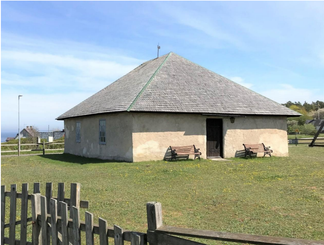
Exteriör från nordväst. Foto JL 2021.
