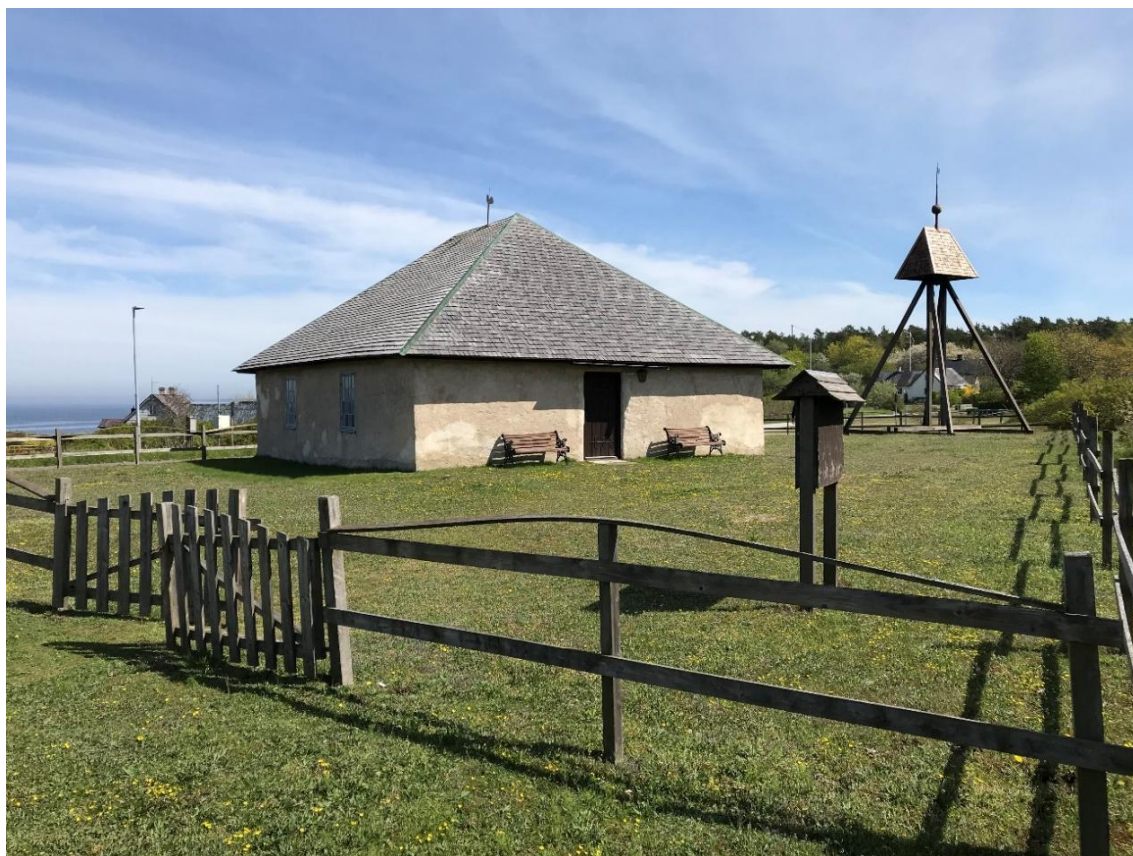
Exteriör från nordväst. Foto JL 2021.
