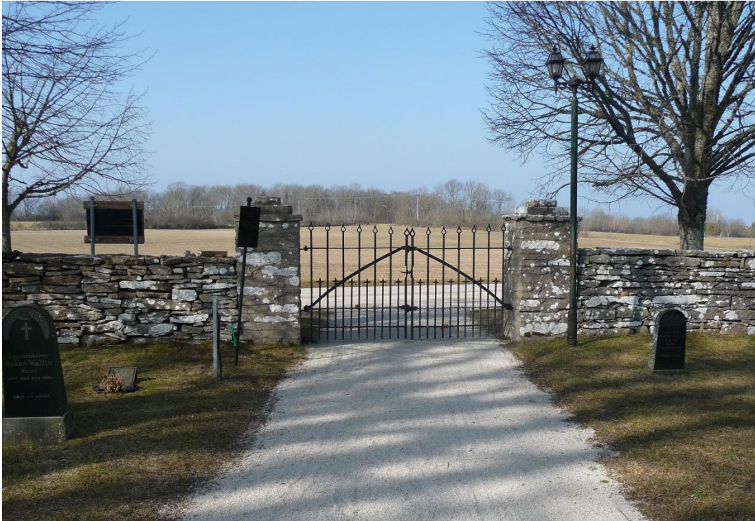
Huvudingången i väster med dubbel järngrind och murade stolpar. Foto ES 2021.
