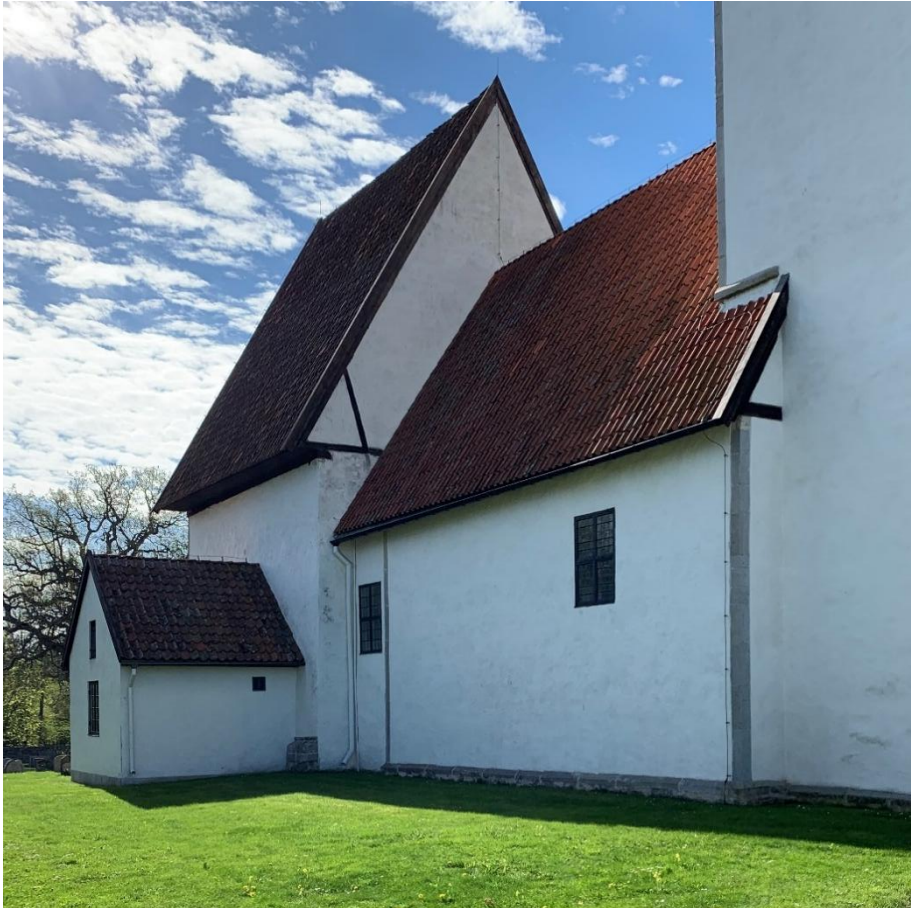
Långhusets norra fasad och koret från nordväst. I putsen under det närmaste fönstret upptäcktes 2018-19 en ristad ritning till korportalens bågar. Foto JL 2021.
