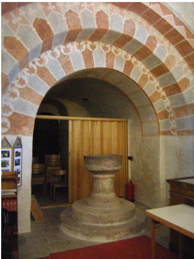
Interiör mot öster samt tornbågen i väster med avskärmande vikkvägg mot förvaringsutrymme i ringkammaren innan den ersattes med nuvarande skärmvägg 2018-19. Foto Sara Strindevall 2007, efter Utas, Vård- och underhållsplan 2010.
