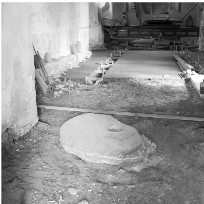
Dopfontens sockel påträffad på ursprunglig plats under restaureringen 1960-61. I bakgrunden läggs undergolv av betong i långhuset. Foto Gunnar Svahnström 1961, ATA, RAÄ.
