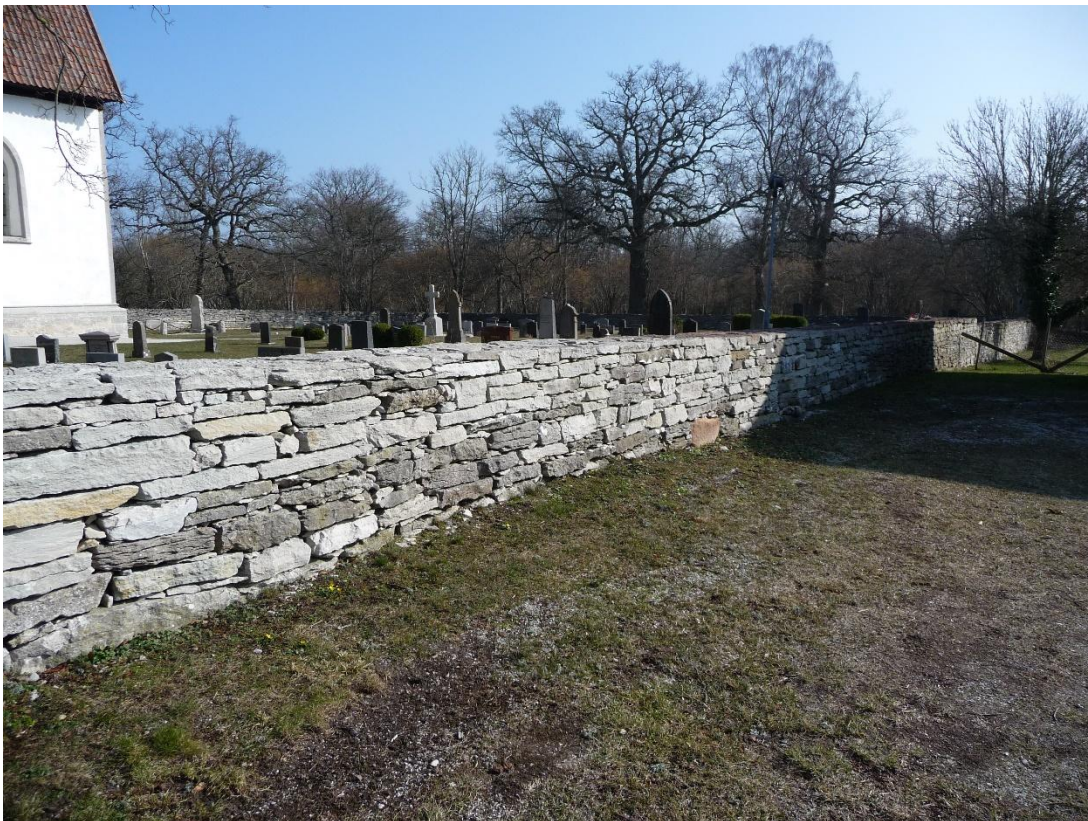
Den södra mursträckningen. Foto ES 2021.
