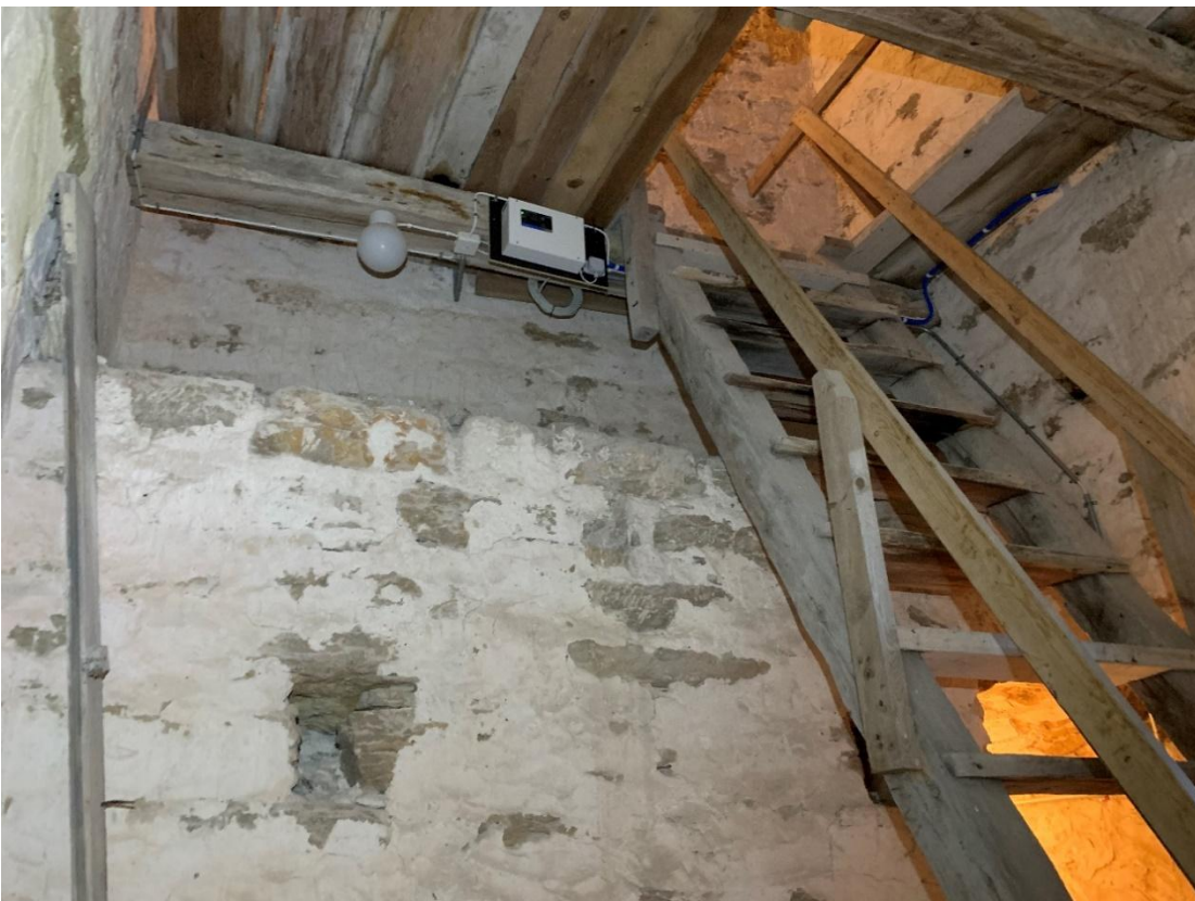
Tornets första övervåning sedd uppåt mot söder. Muren är bredare nedtill för murtrappan. Foto JL 2021.
