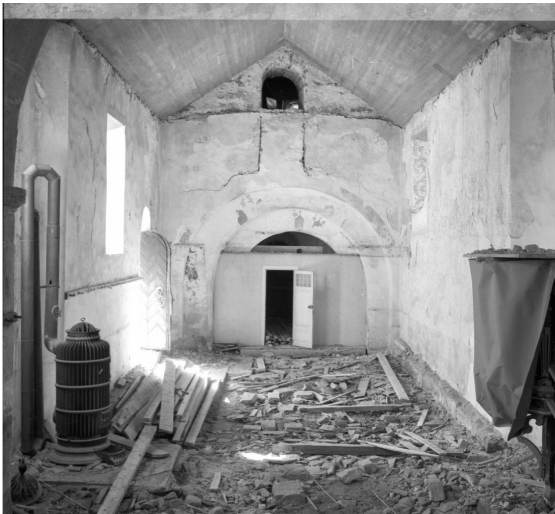
Interiör mot väster under pågående restaurering. Träinnertaket ersatt av betongtak, läktaren riven, golvet uppbrutet men kaminen från 1914 ännu kvar och kalkmålningarna ännu ej framtagna. Öppningen över tornbågen ledde tidigare in på långhusvinden. Foto Gunnar Svahnström 1960, ATA, RAÄ.
