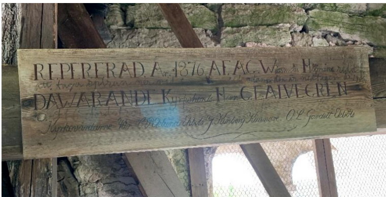
Minnestavla över tornhuvens reparation 1876. Foto JL.
