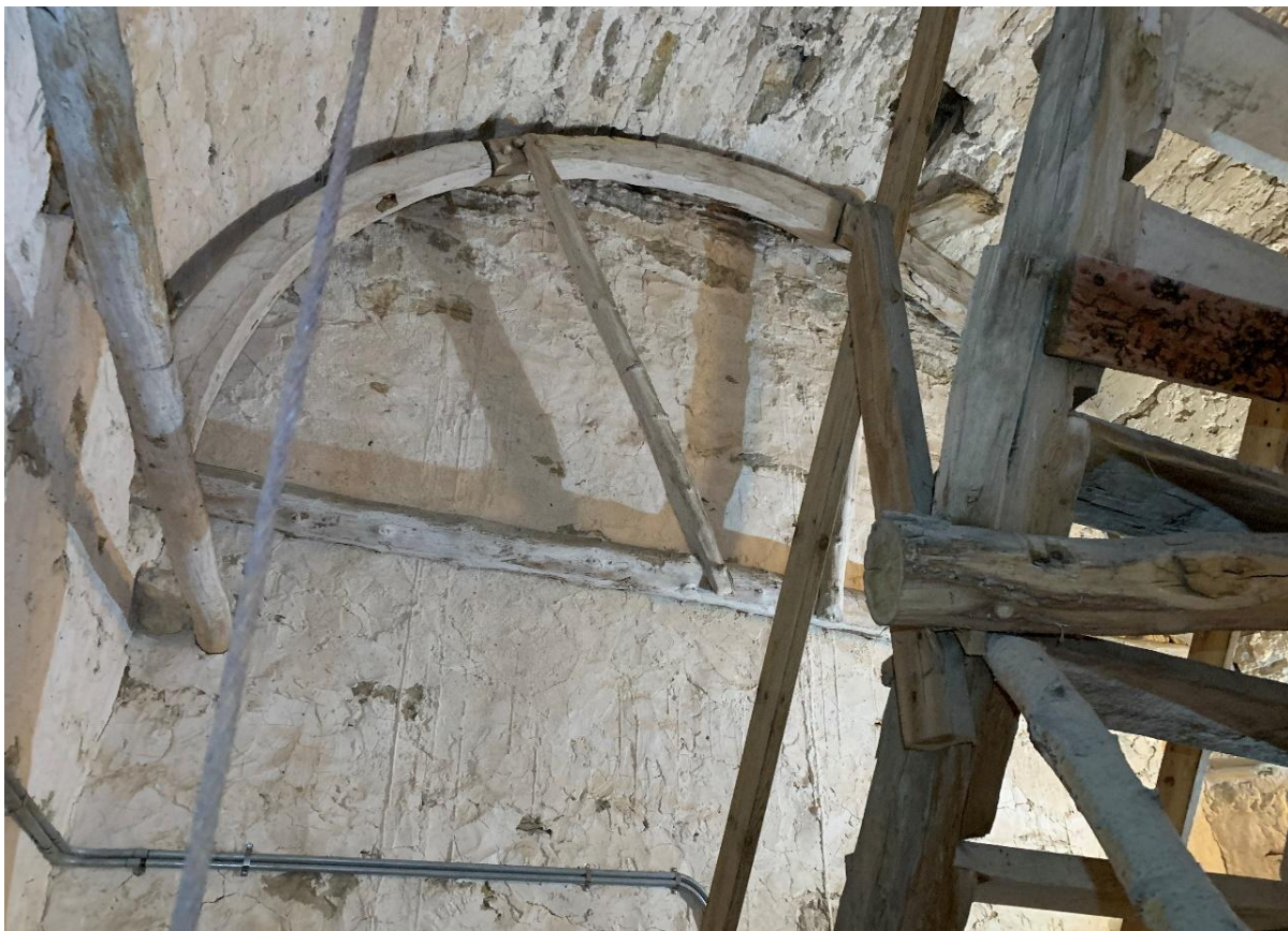
Tornets andra övervåning sedd mot öster och uppåt med kvarstående ställning från valvslagningen. Foto JL 2021.
