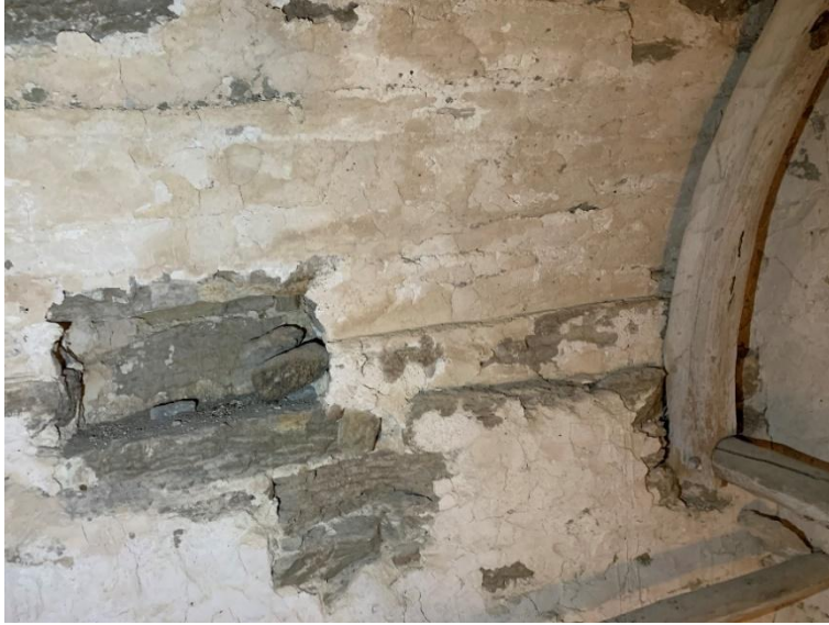
Tornets andra övervåning, valvanfanget på norra sidan. Bågställningen förefaller inhuggen i murverket efter detta putsats. Foto Ola Nyström 2021, Gotlands Museum.
