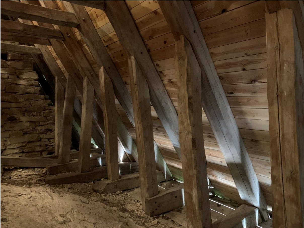
Korets takfot på södra sidan vid, sedd mot sydöst. Foto Ola Nyström 2021, Gotlands Museum.
