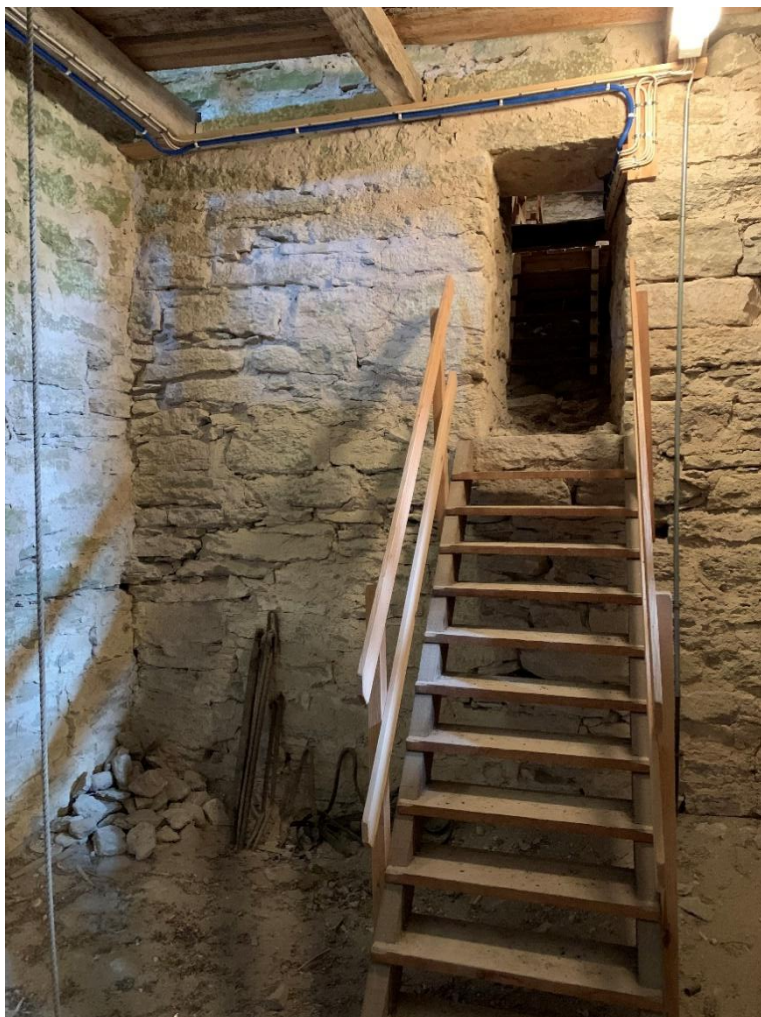
Tornets första övervåning mot öster med utgång till långhusvinden. Murningen i tornet är omsorgsfullt gjord och de flesta stenarna har en jämnt utförd pikhuggning. Nedan tornet mot nordväst samt innersmygen till den fyrpassformade gluggen i tornets södra mur. Foto JL 2021.
