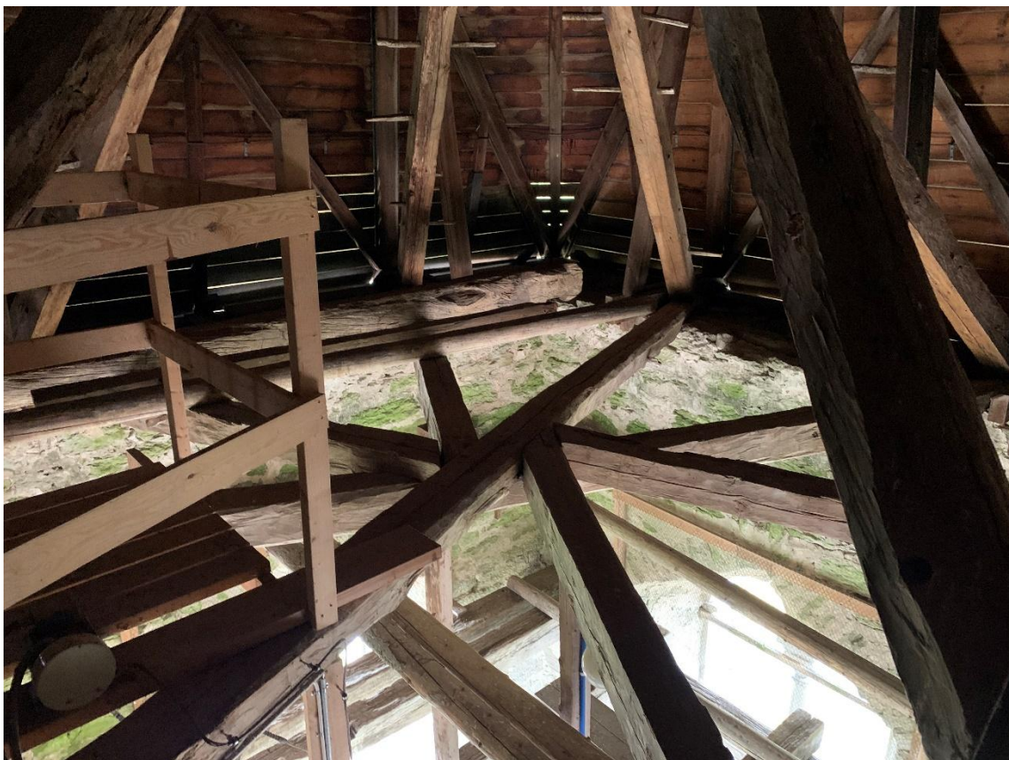
Stjärnformat bärverk av bindbjälkarna i tornhuvens konstruktion. Foto JL 2021.
