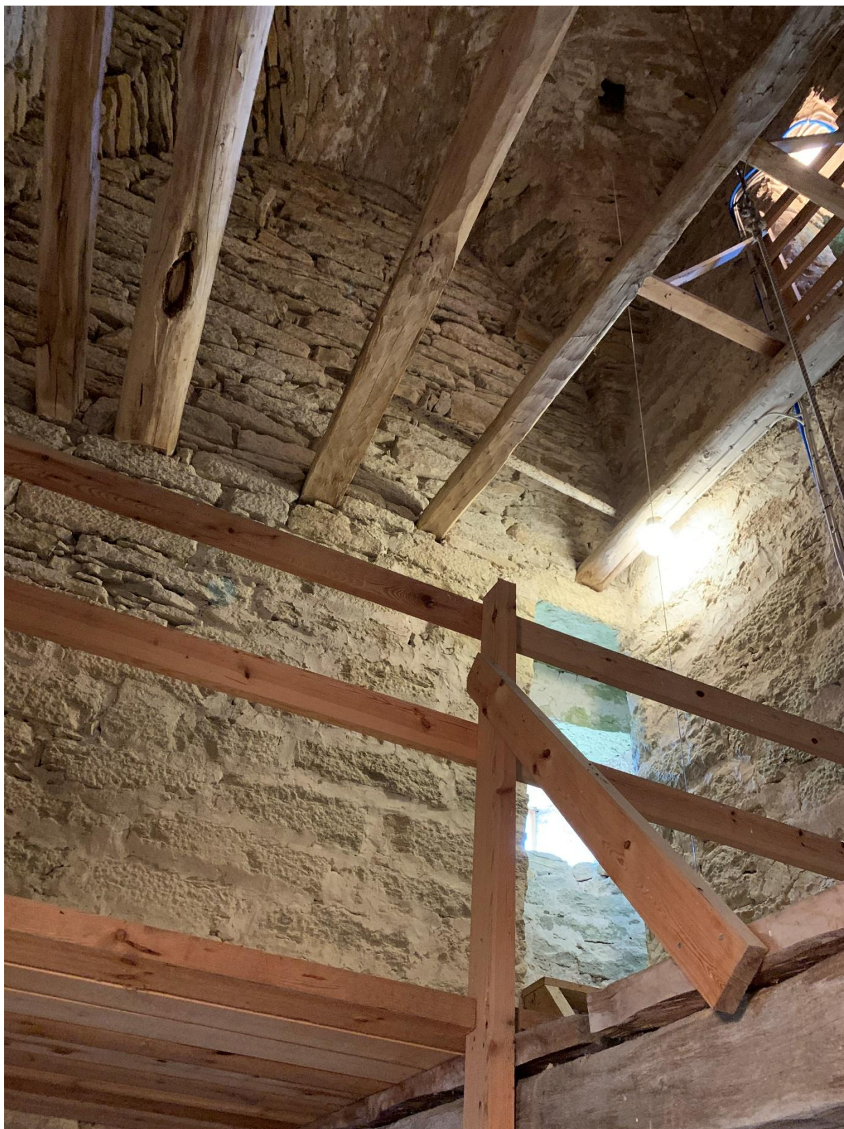
Blick uppåt mot nordväst från tornets första övervåning genom den andra och tidigare tredje övervåningen, vars bjälklag helt saknar golvplank. Ovanför valvet ligger klockvåningen. Foto JL 2021.
