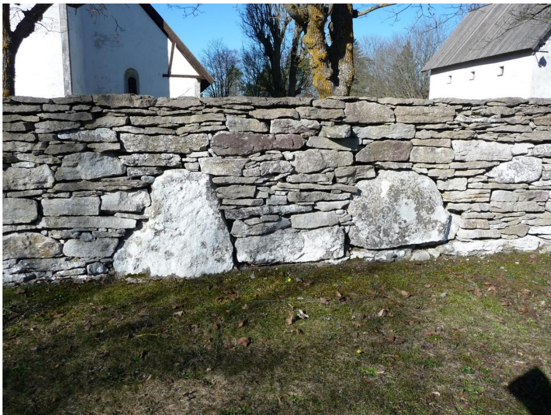
Murarna kring den äldre kyrkogården har en ålderdomlig prägel med sten av varierande storlek. Foto ES 2021.
