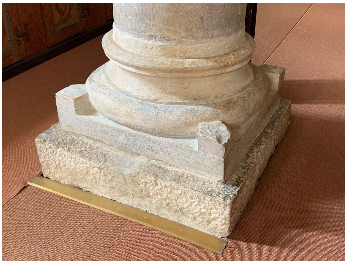
Den gotiska långhusdelens kolonnbas, sedd från nordöst. Hörnornamenten var troligen lämnade för att huggas till senare. Foto JL 2021.
