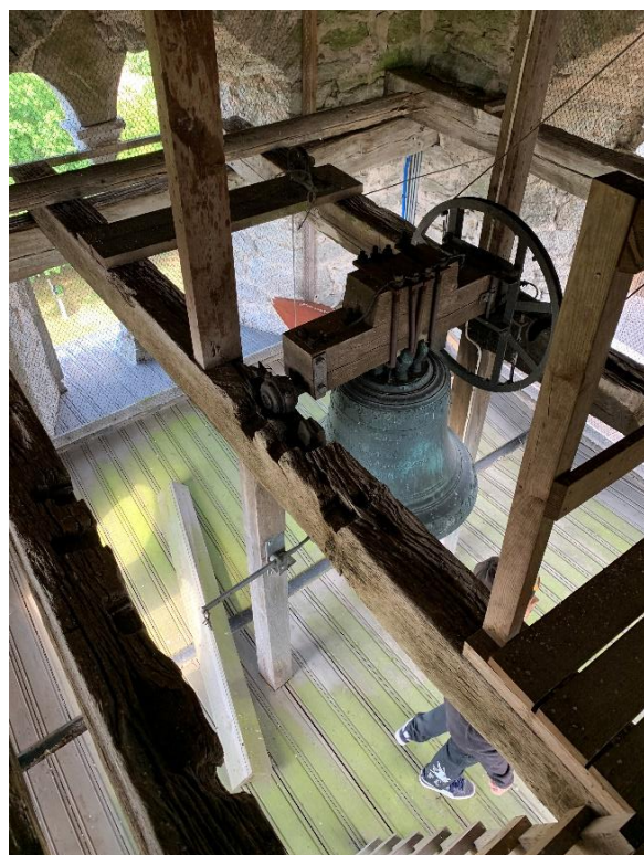
Klockvåningens sydvästra hörn med indragning av muren strax under murkrönet. Till höger klockan, sedd uppifrån mot nordöst. Bjälkarna i förgrunden visar urtag för tidigare klockupphängning. Foto JL 2021.
