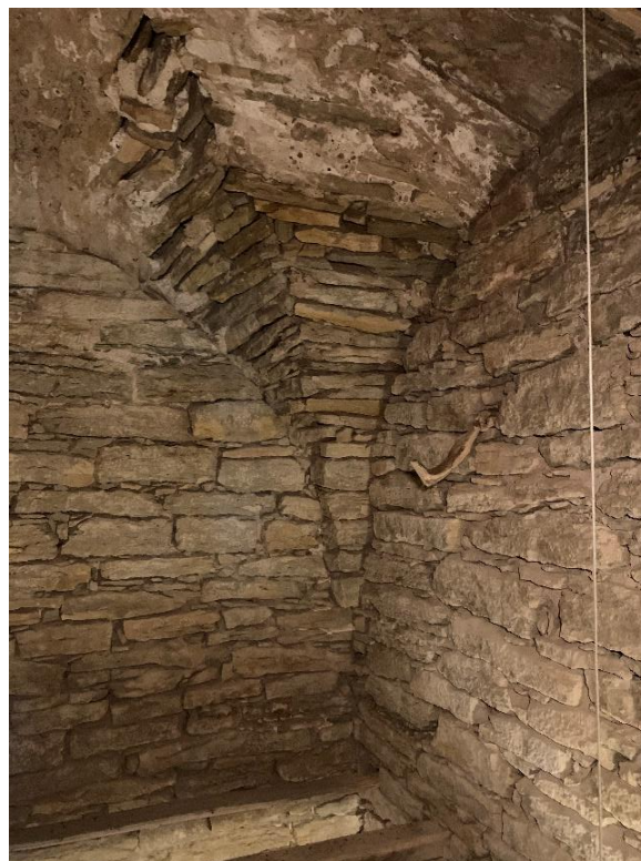
Valvet mellan tidigare tredje övervåningen och klockvåningen sett mot sydöst och sydväst med avtryck av skålbträder från valvslagningen, varav några delvis sitter kvar. Foto JL
