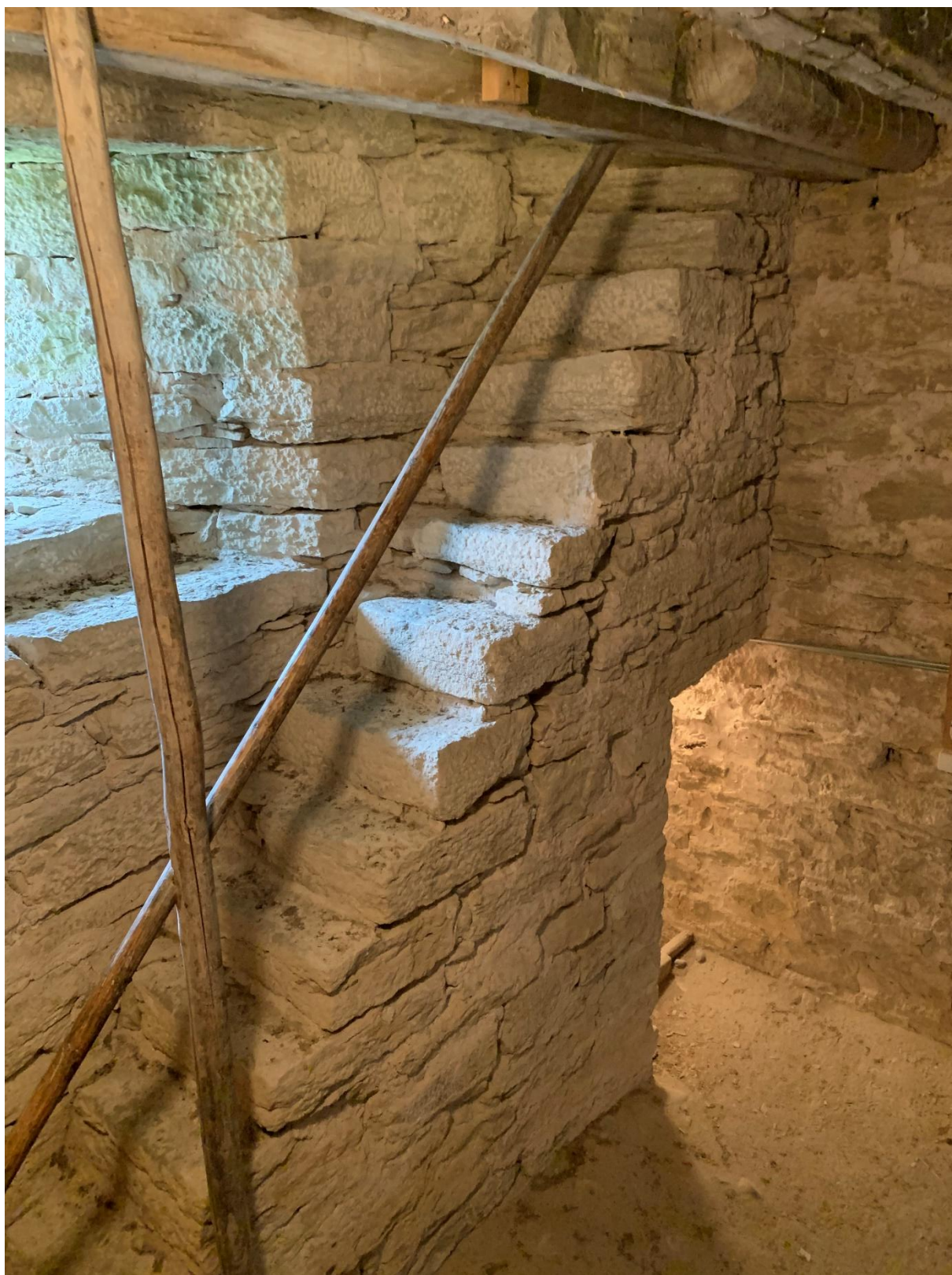
Tornets första övervåning mot sydväst med mynningen för murtrappan nedifrån och öppen murtrappa till andra övervåningen. Nischen till den fyrpassformade gluggen till vänster. Foto JL 2021.
