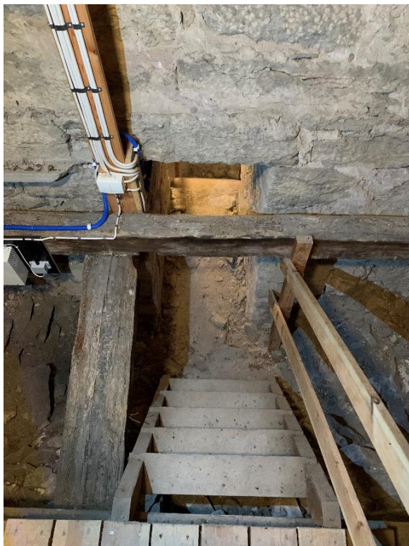
Passage från tornet till långhusvinden, sedd från östra sidan. Till höger murverket i tornets östra mur (långhusets västra gavel) med jämn pikhuggning över ytan, liksom in mot tornet. Foto JL 2021.
