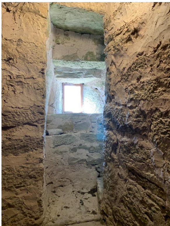
Murtrappa från tornets andra övervåning och uppåt. Ingång och rundning i tornets nordvästra hörn. Foto JL 2021.
