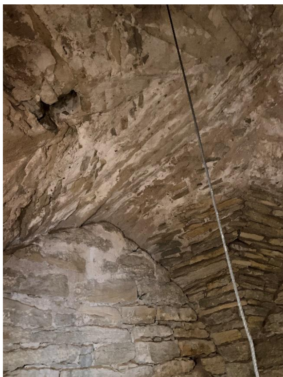
Valvet mellan tidigare tredje övervåningen och klockvåningen sett mot sydöst och sydväst med avtryck av skålbträder från valvslagningen, varav några delvis sitter kvar. Foto JL
