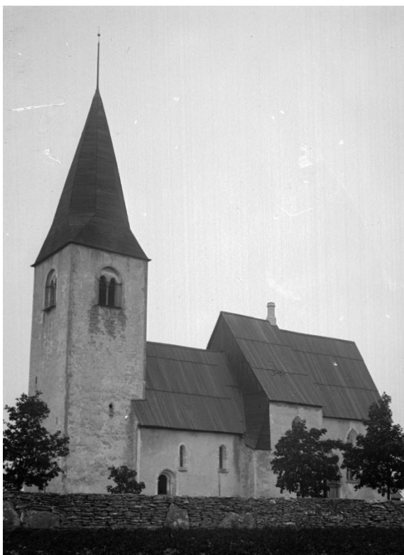
Exteriör från sydväst efter att fönstren förstörats och en skorsten placerats över det gotiska långhusets gavelröste. Till höger långhusportalen och det västra av långhusets fönster, där det framgår att det är förlängt nedåt men med återanvändande av solbänken. Foto Einar Erics, sannolikt omkring 1915, ATA.
