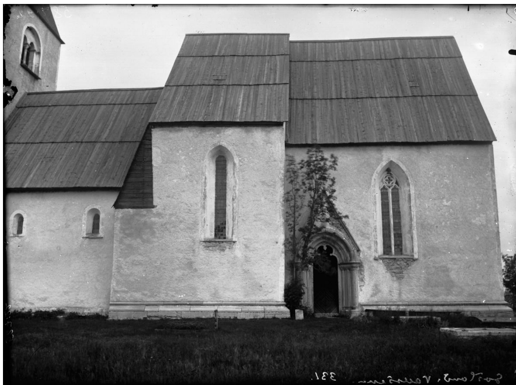
Exteriör från söder. Foto Olof Sörling, troligen ca 1890, ATA. Det romanska långhusets fönster har ännu kvar sin ursprungliga storlek. Fönstersmygarna är putsade, delar av korfönstrets masverk är igensatt. Ett träd växer vid korportalen.
