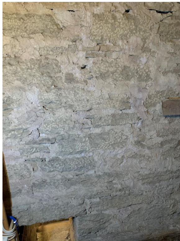
Passage från tornet till långhusvinden, sedd från östra sidan. Till höger murverket i tornets östra mur (långhusets västra gavel) med jämn pikhuggning över ytan, liksom in mot tornet. Foto JL 2021.
