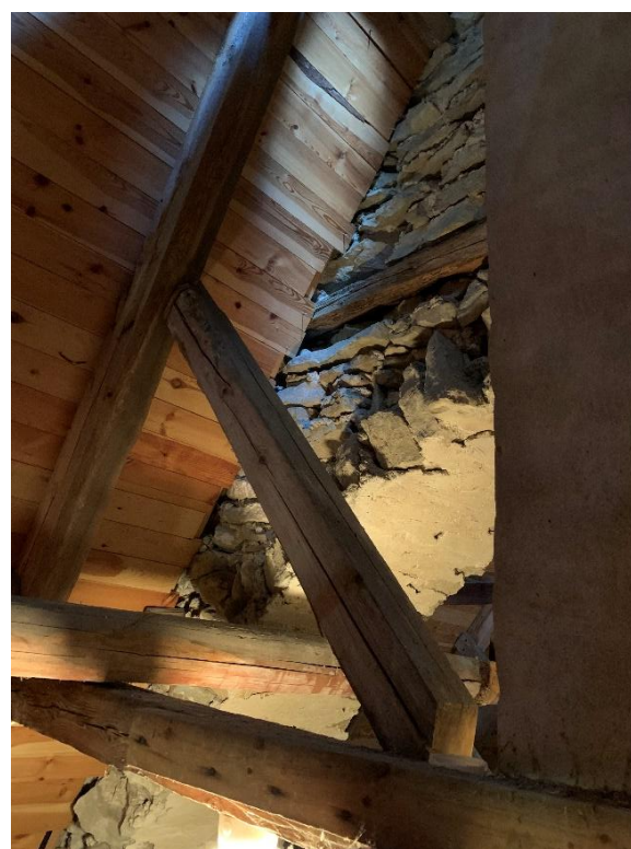
Den gotiska långhusdelens vind sedd mot öster genom den vida bågen in mot korvinden. Till höger södra delen av den vida bågen, sedd från korvinden i öster. Stenarna i bågen är lagda i ett tjockt bruk men in mot koret har bågen en mycket ojämn kant som gör att själva bågens bredd skiftar och stenarna skjuter ut på olika avstånd från murverket i övrigt. Foto JL 2021.
