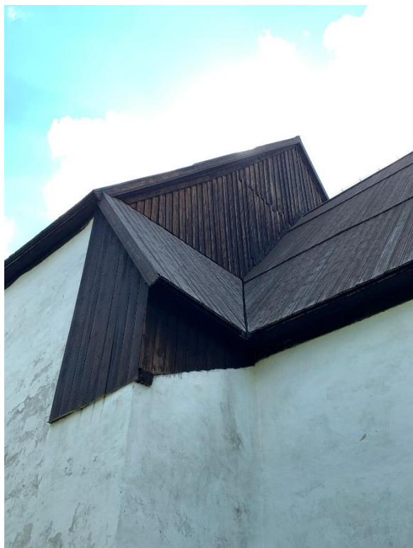
Takets och det i trä byggda gavelröstets utformning mellan gotiska och romanska långhuset, på norra respektive södra sidan. Foto JL 2021.
