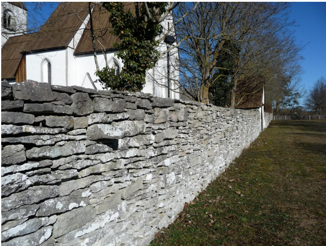
Den norra mursträckningen. Närmast syns ett utstickande hästbindsle. Foto ES 2021.
