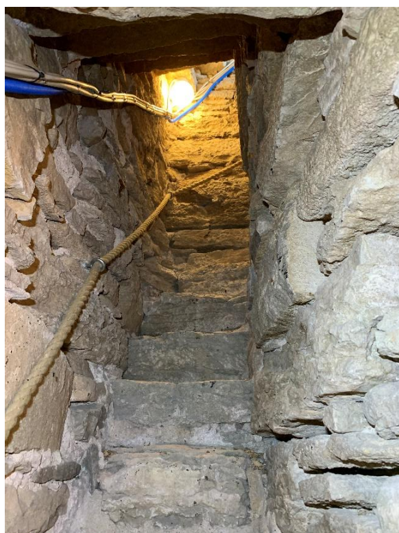
Murtrappan i norra muren, fortsättningen förbi valvet upp till klockvåningen. Murverket är mycket grövre än längre ner i tornet. Till höger ovasidan av valvet, sedd mot väster. Den släta ovasidan kan ha utgjort golv i klockvåningen. Foto JL 2021.
