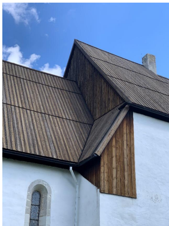
Takets och det i trä byggda gavelröstets utformning mellan gotiska och romanska långhuset, på norra respektive södra sidan. Foto JL 2021.
