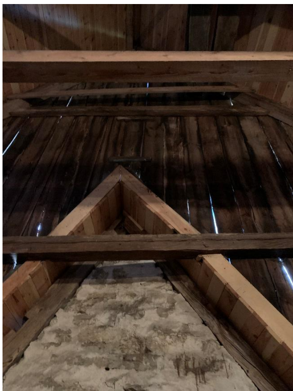
Den gotiska långhusdelens provisoriska avslutning åt väster. Till vänster panelväggen ovanför den romanska långhusgaveln. Till höger den södra av träöverbyggnaderna ovanför sidomurarna åt väster. Foto JL 2021.
