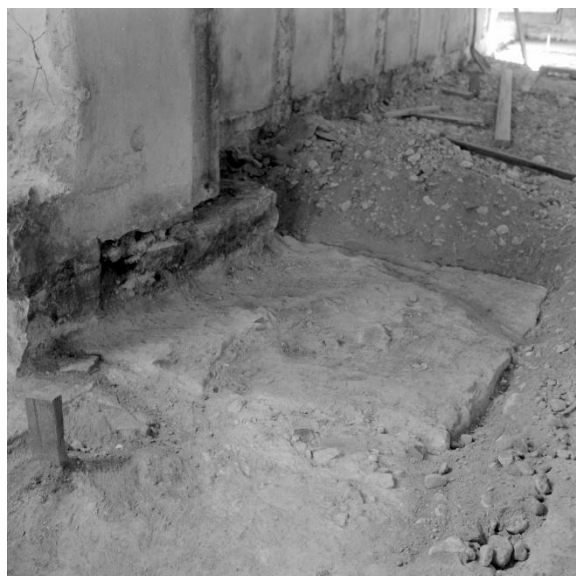
Grundmurar till det romanska koret, sett mot väster med långhusets sydöstra hörn synligt. Till höger grundmur till det södra vederlaget i den romanska kyrkans ursprungliga triumfbåge, som var betydligt smalare än den nuvarande. Foto Evald Gustafsson 1957, ATA.
