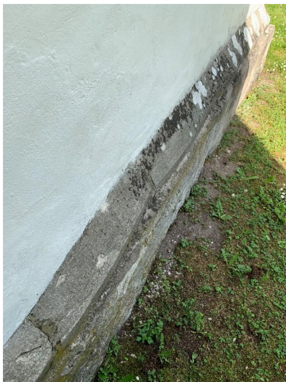
Sakristians sockel på östra och norra sidan med infällda rundade återanvända sockelstenar som visar att det romanska koret hade absid. Foto JL 2021.
