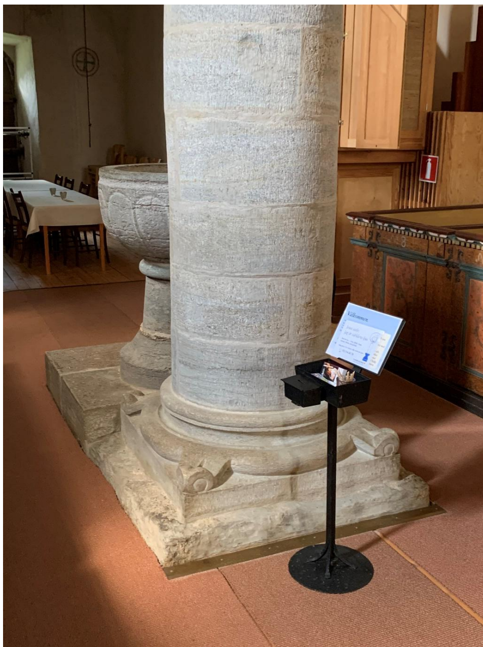
Det romanska långhusets kolonnbas, sedd från sydöst och nordöst. Den gotiska kolonnens bas synes ha tagit denna till förebild varför den sannolikt var tänkt att återanvändas i det fullbordade gotiska långhuset. Foto JL 2021.
