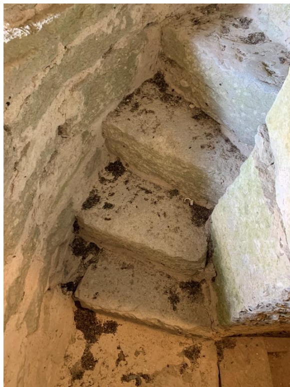
Murtrappa från tornets andra övervåning och uppåt. Ingång och rundning i tornets nordvästra hörn. Foto JL 2021.
