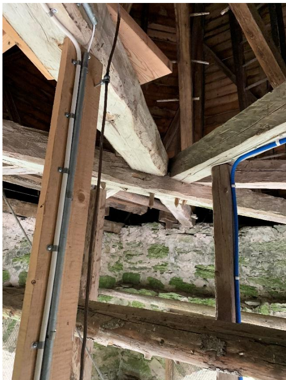
Bärverket sett underifrån med synliga dymlingar. Tornhuvens konstruktion sett uppåt med kryss, varav flera försedda med stegpinnar, nu ersatta av trästegar med räcken och vilplan. Foto JL 2021.
