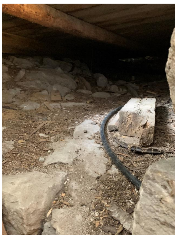
Murtrappan i norra muren, fortsättningen förbi valvet upp till klockvåningen. Murverket är mycket grövre än längre ner i tornet. Till höger ovasidan av valvet, sedd mot väster. Den släta ovasidan kan ha utgjort golv i klockvåningen. Foto JL 2021.
