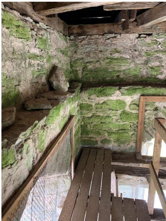
Klockvåningens sydvästra hörn med indragning av muren strax under murkrönet. Till höger klockan, sedd uppifrån mot nordöst. Bjälkarna i förgrunden visar urtag för tidigare klockupphängning. Foto JL 2021.
