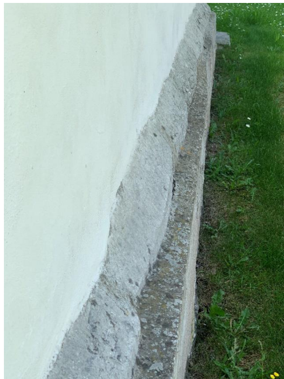
Sakristians sockel på östra och norra sidan med infällda rundade återanvända sockelstenar som visar att det romanska koret hade absid. Foto JL 2021.
