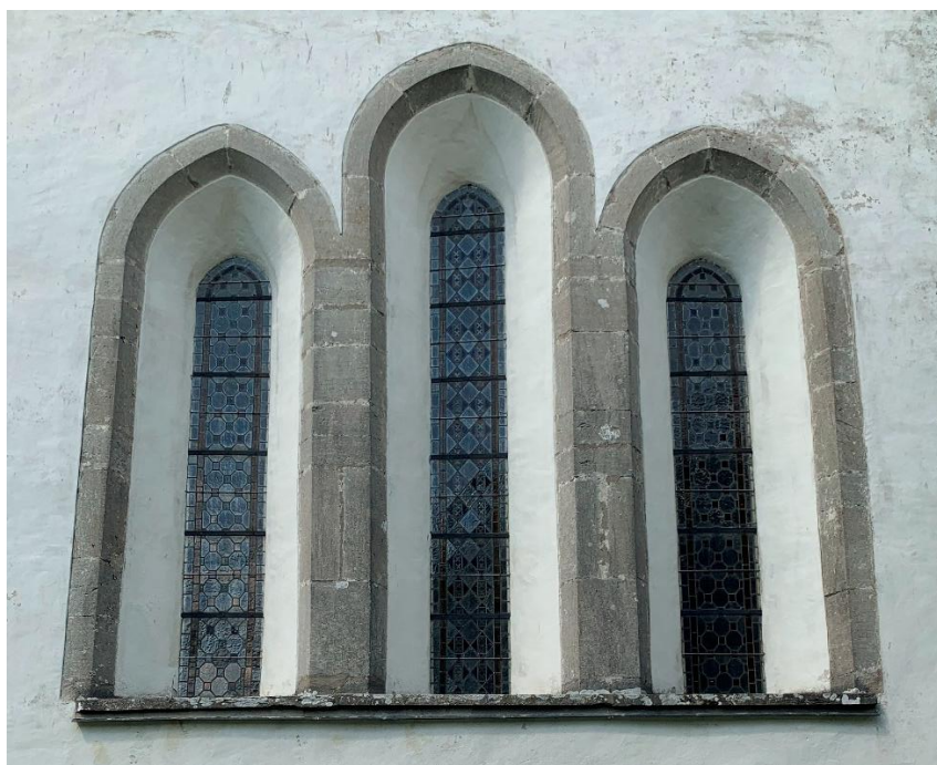
Det gotiska långhusets fönster, södra korfönstret samt de tre fönstren i öster. Foto JL 2021.
