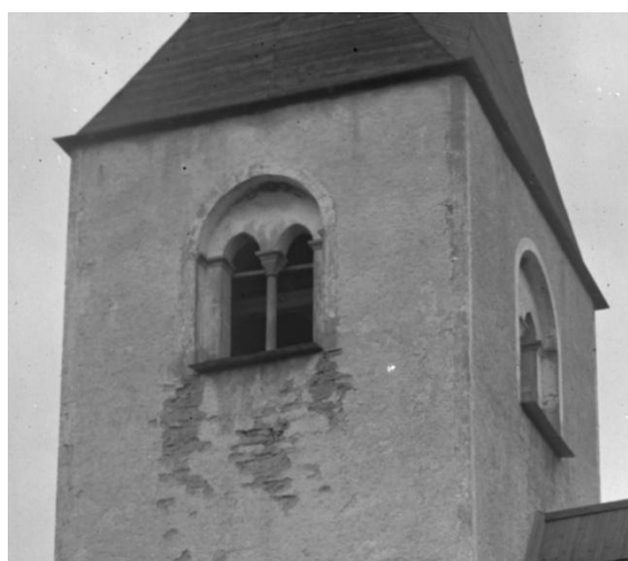
Ljudgluggarna före restaureringen 1957 med till stor del överputsad omfattning. Detalj av foto av Olof Sörling, troligen omkring 1890, ATA. Till höger fyrpassformad ljusglugg i tornets södra fasad. Foto ES 2021.
