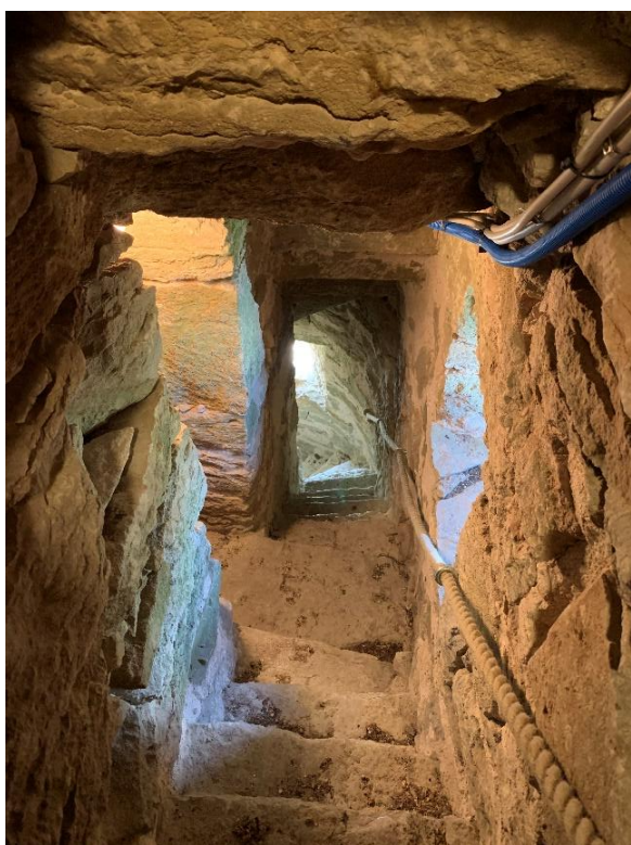
Murtrappa i norra muren från tornets andra övervåning och uppåt, sedd uppifrån mot väster. Vid vilplanet ingång till tornets tidigare tredje övervåning samt ljusglugg i norra muren, något större än de övriga. Till höger bjälklaget till tidigare tredje övervåningen sett nedåt åt sydväst. Två av de till synes ursprungliga bjälkarna har urtag för tidigare anordningar eller för att bjälken tidigare haft annan funktion. Foto JL 2021.
