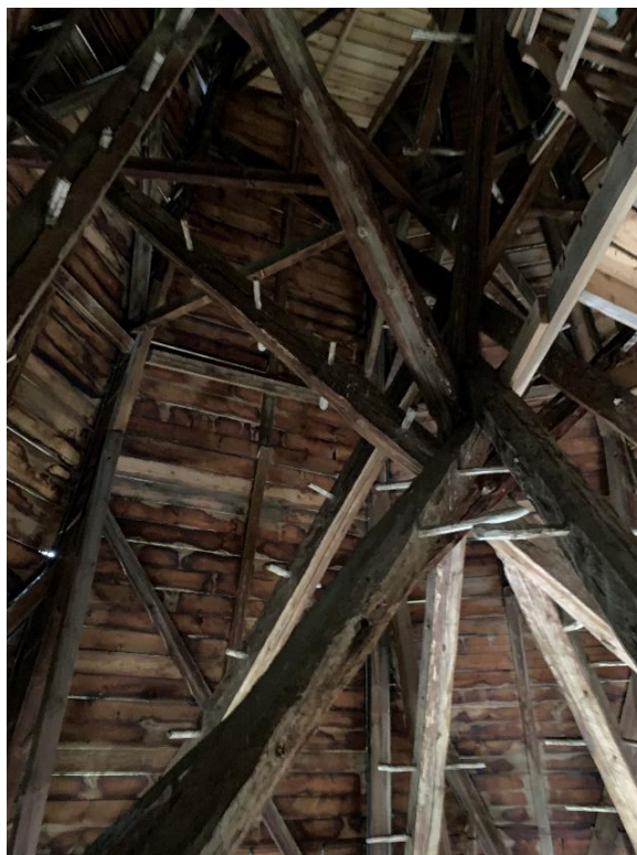
Bärverket sett underifrån med synliga dymlingar. Tornhuvens konstruktion sett uppåt med kryss, varav flera försedda med stegpinnar, nu ersatta av trästegar med räcken och vilplan. Foto JL 2021.
