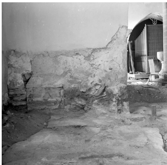
Grundmurar till det romanska koret, sett mot väster med långhusets sydöstra hörn synligt. Till höger grundmur till det södra vederlaget i den romanska kyrkans ursprungliga triumfbåge, som var betydligt smalare än den nuvarande. Foto Evald Gustafsson 1957, ATA.
