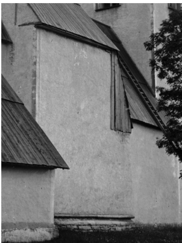
Motsvarande parti före 1957 års restaurering. Träöverbyggnaderna hade tidigare en något slumpmässigt oregelbunden utformning men gavs på 1950-talet en mer stringent form med släta plan som möter varandra i raka linjer och fler vertikala väggar i trä. Detaljer av foton av Olof Sörling och Einar Erics, troligen omkring 1890 respektive ca 1915, ATA.
