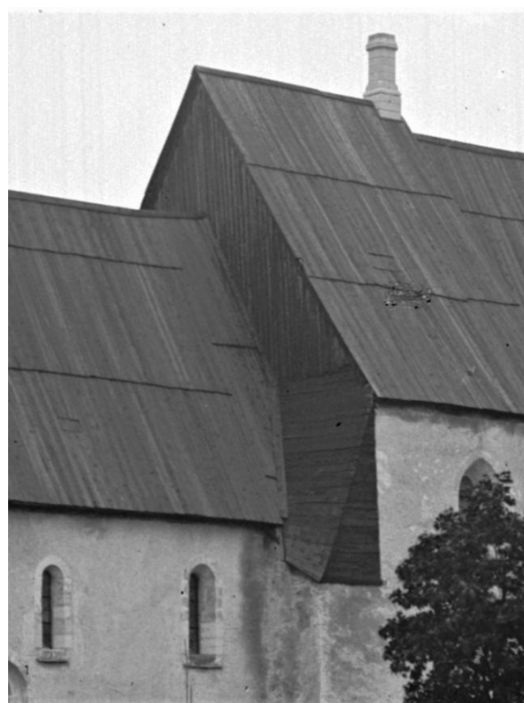
Motsvarande parti före 1957 års restaurering. Träöverbyggnaderna hade tidigare en något slumpmässigt oregelbunden utformning men gavs på 1950-talet en mer stringent form med släta plan som möter varandra i raka linjer och fler vertikala väggar i trä. Detaljer av foton av Olof Sörling och Einar Erics, troligen omkring 1890 respektive ca 1915, ATA.
