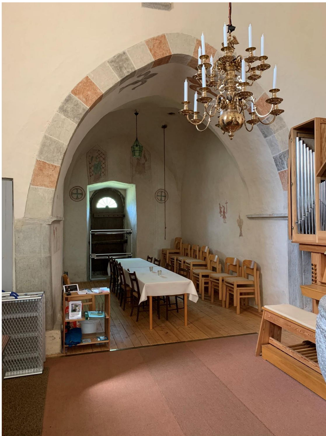
Tornbågen och ringkammaren från sydöst. Tornbågen, som har huggna vederlagsstenar med profil, är vidgad. Foto JL 2021.
