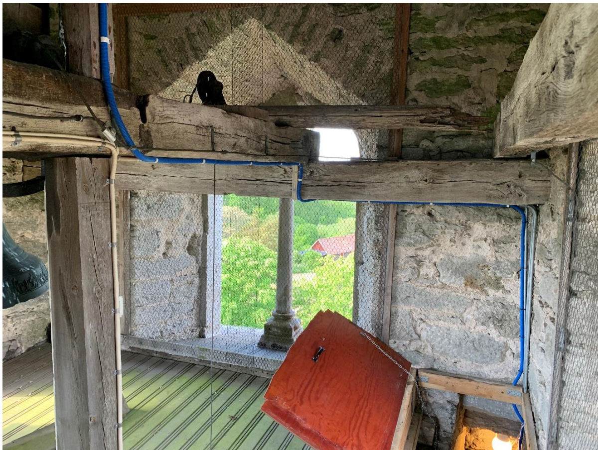
Klockvåningen mot norr med trappans mynning i nordöstra hörnet. Foto JL 2021.
