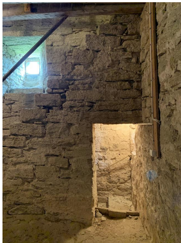
Trappa i tornets södra mur samt trappans mynning i första övervåningen. Öppningen har en tröskel i trä. Foto JL 2021.
