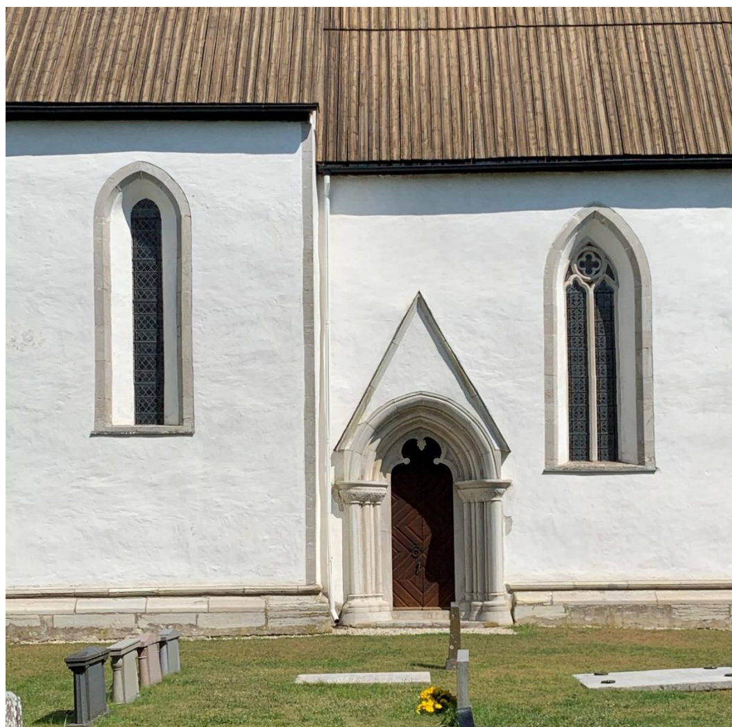
Utsnitt av den gotiska delens fasad för att ge en uppfattning om dess stilkaraktär. Fönstren är samtida, men varierar sig ändå genom att det ena är ett avlångt lansettfönster, det andra ett med mittpost tvådelat masverksfönster. Foto JL 2021.
