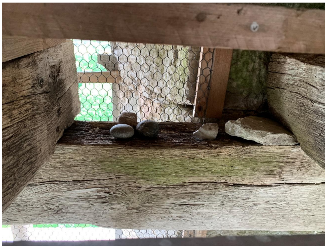
Några av klockvåningens väderbitna ekbjälkar med upplagda stenar för kimbning, att framkalla klang med lätta slag på olika ställen på klockan. Foto JL 2021.
