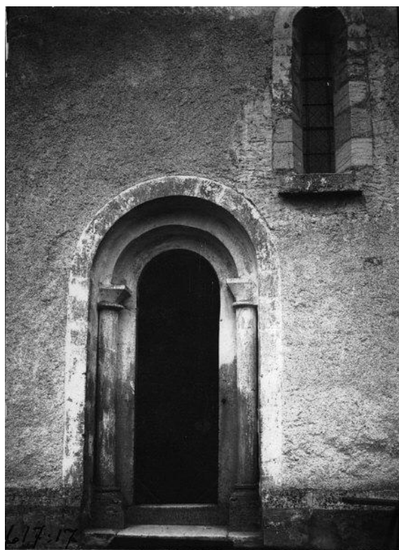
Exteriör från sydväst efter att fönstren förstörats och en skorsten placerats över det gotiska långhusets gavelröste. Till höger långhusportalen och det västra av långhusets fönster, där det framgår att det är förlängt nedåt men med återanvändande av solbänken. Foto Einar Erics, sannolikt omkring 1915, ATA.
