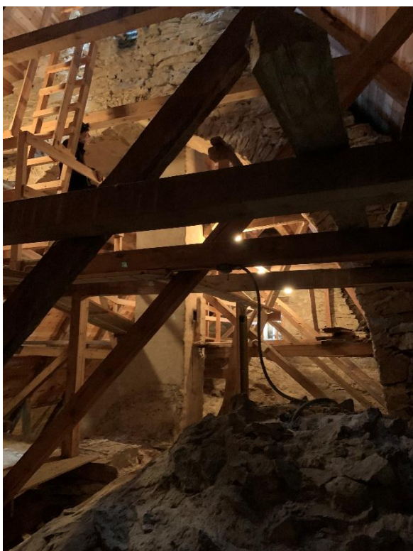
Den gotiska långhusdelens vind sedd mot öster genom den vida bågen in mot korvinden. Till höger södra delen av den vida bågen, sedd från korvinden i öster. Stenarna i bågen är lagda i ett tjockt bruk men in mot koret har bågen en mycket ojämn kant som gör att själva bågens bredd skiftar och stenarna skjuter ut på olika avstånd från murverket i övrigt. Foto JL 2021.
