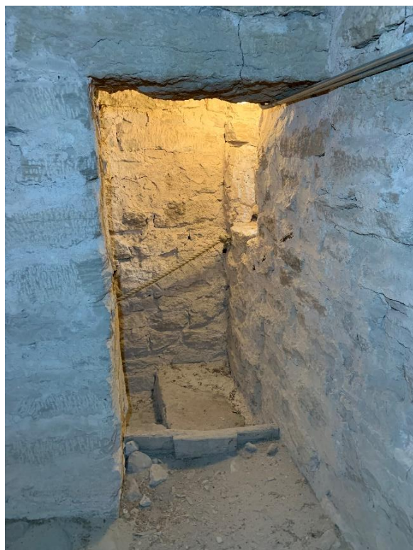
Trappa i tornets södra mur samt trappans mynning i första övervåningen. Öppningen har en tröskel i trä. Foto JL 2021.
