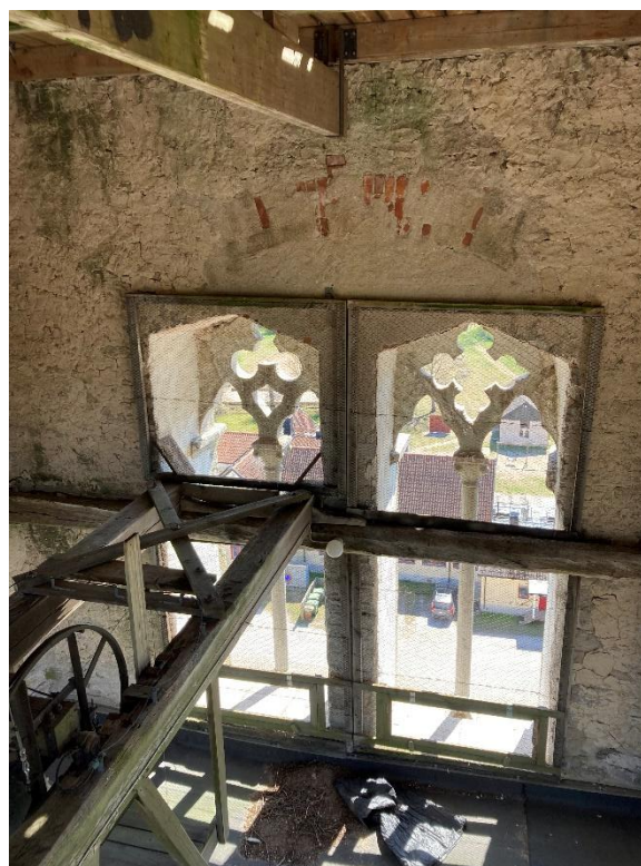
Klockvåningen mot öster och mot söder där ljudluggarna förstärkts med en avlastningsbåge i tegel vid ljudluggarnas restaurering 1907. Foto JL 2023.
