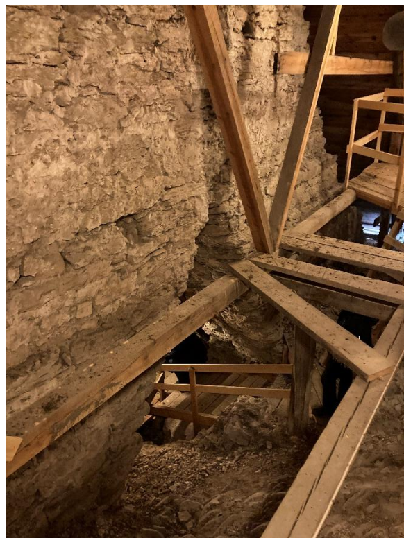
Del av södra delen av långhusets östra gavel med röstets påbyggnad från 1929 och skorstensstock. Till höger långhusets östra gavelröste (triumfbågsmuren) från nordväst med öppning till korvinden. Foto JL 2023.
