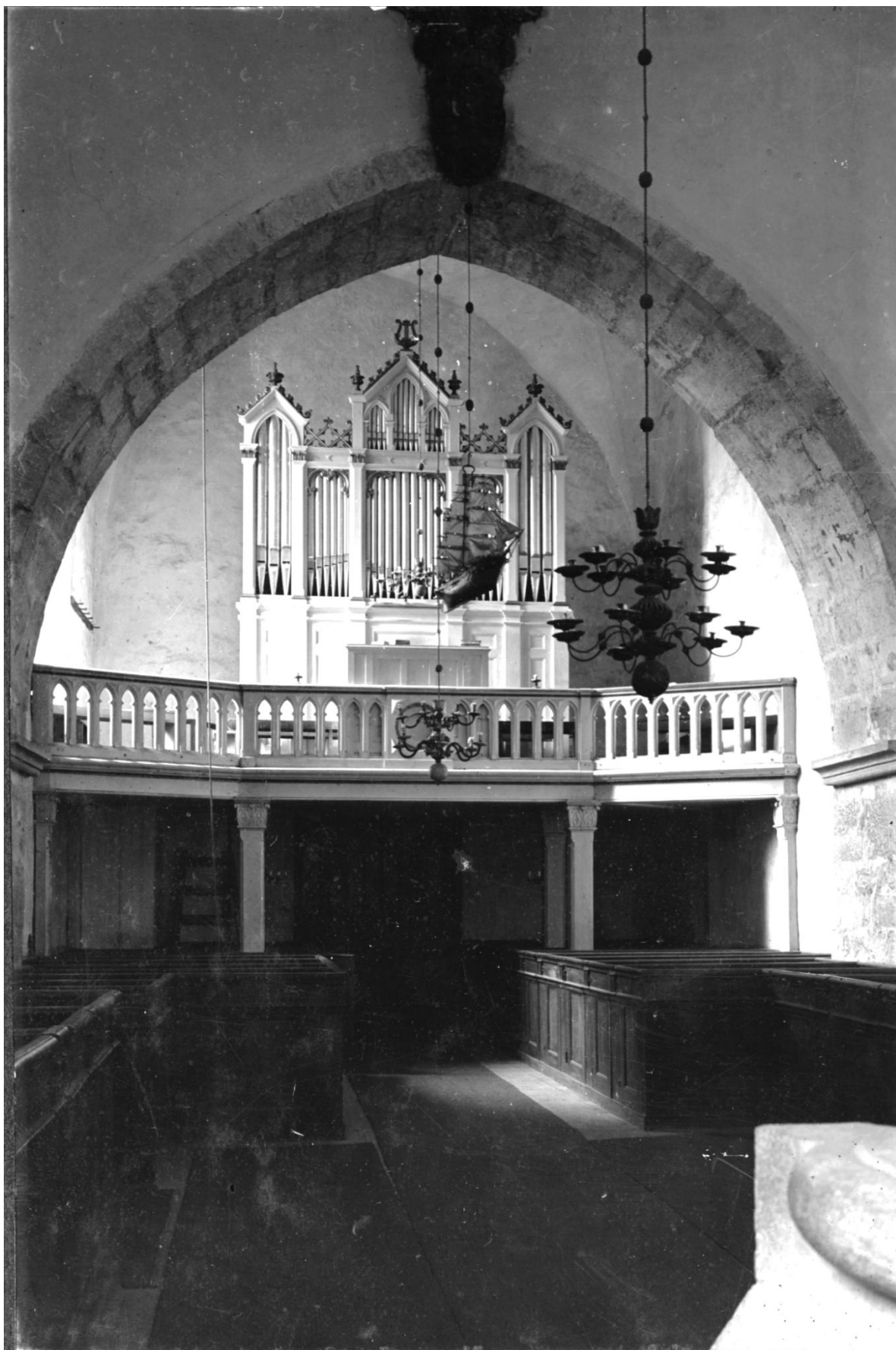
Ringkammaren och orgelläktaren mot väster före restaureringen 1929-1930. Läktarbarriären bruten och liksom orgelfasaden målad i en ljusare färg. Foto Erik Fant 1927, ATA.
