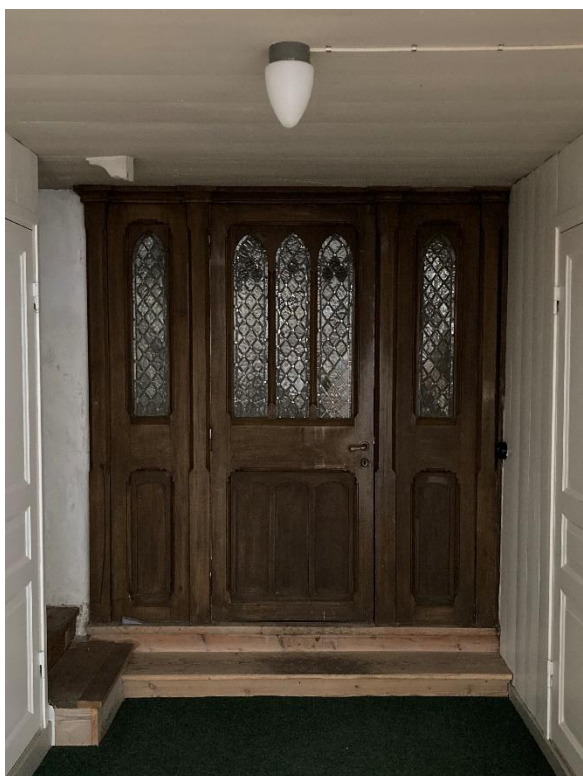
Glasat vindfång innanför västportalen. Till höger västportalens dörr, formad som vikdörr att kunna ställas upp innanför vindfånget för att släppa in ljus. Foto JL 2023.
