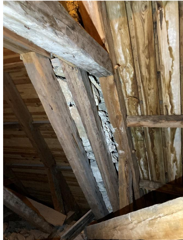
Gaveln mellan kor och absid, med bärande träkonstruktion och utfyllnad i delvis putsad sten, sedd från sydväst och sydöst. Foto JL 2023.
