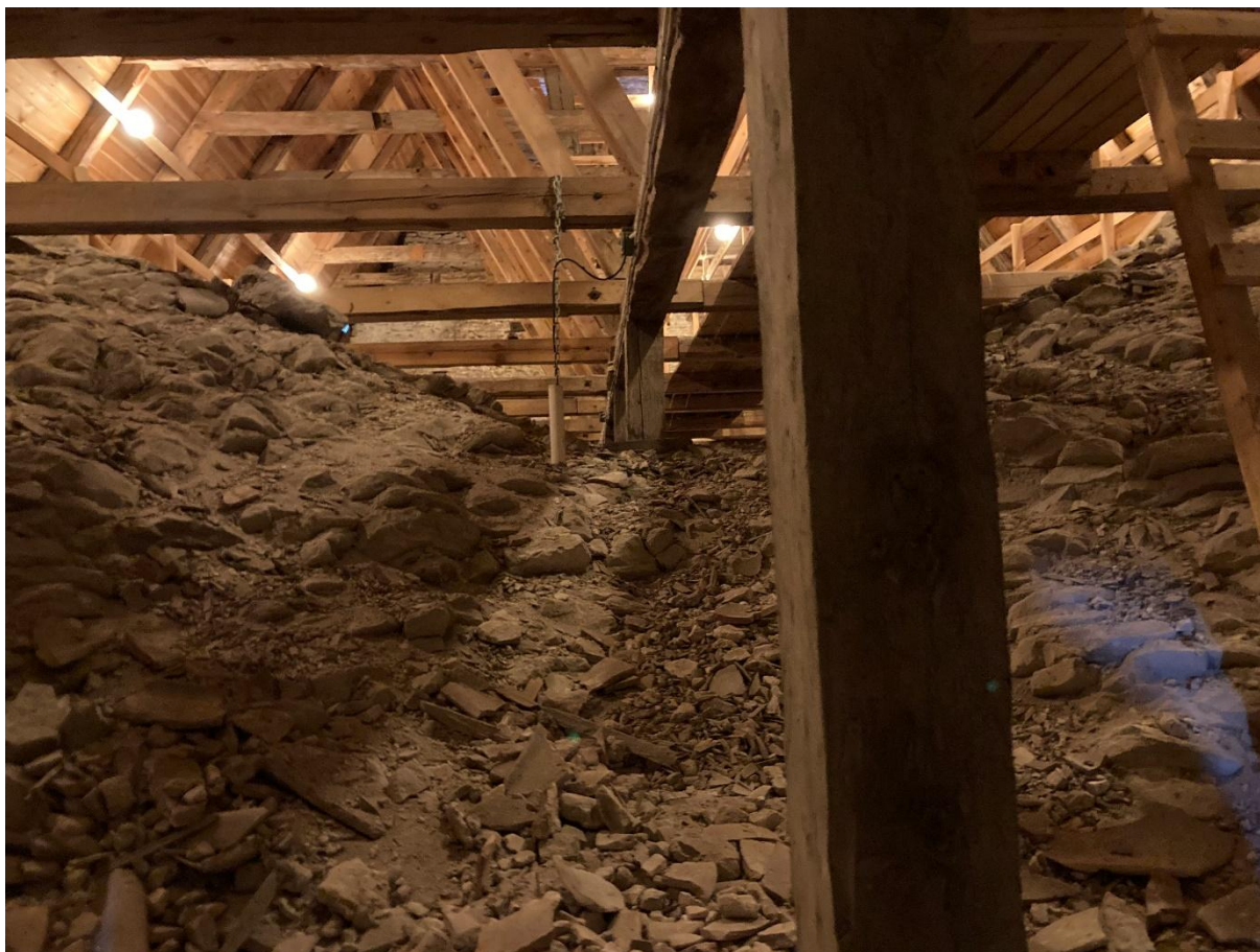
Långhusvinden mot öster med valvens ovansida. Foto JL 2023.
