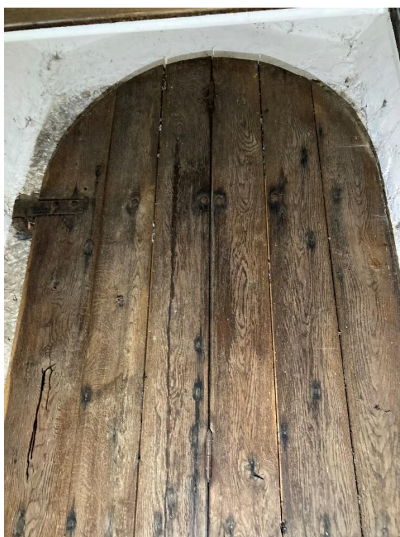
Glasat vindfång innanför västportalen. Till höger västportalens dörr, formad som vikdörr att kunna ställas upp innanför vindfånget för att släppa in ljus. Foto JL 2023.
