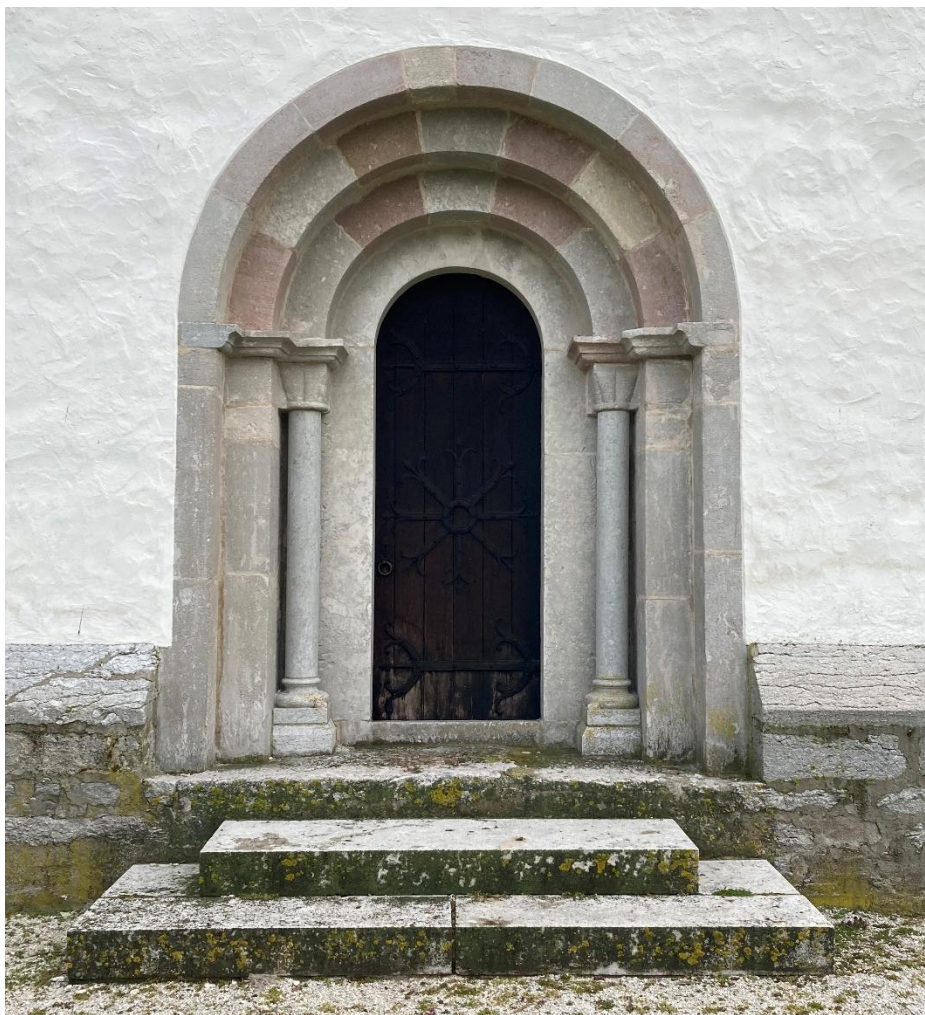
Tornportalen. Ursprungligen troligen det äldre romanska långhusets sydportal och kyrkans huvudingång, flyttad till det under byggnad varande gotiska tornet på 1300-talets. Foto JL 2023.
