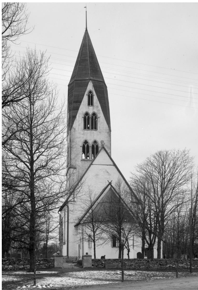
Exteriör från öster strax efter långhustakets höjning. Absidkorets spåntak ersatt av faltak, som på det nya långhustaket. Foto Iwar Anderson 1939, ATA.
