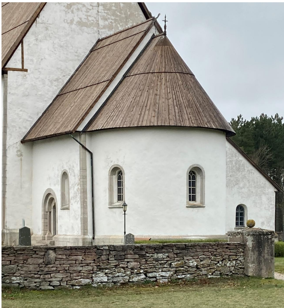
Koret, absiden och sakristian från sydöst. Byggda 1864-1865 efter förebild av det äldre korpartiet. Foto JL 2023.
