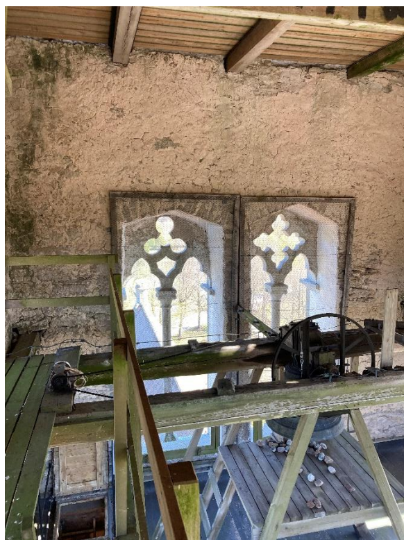
Klockvåningen mot öster och mot söder där ljudluggarna förstärkts med en avlastningsbåge i tegel vid ljudluggarnas restaurering 1907. Foto JL 2023.
