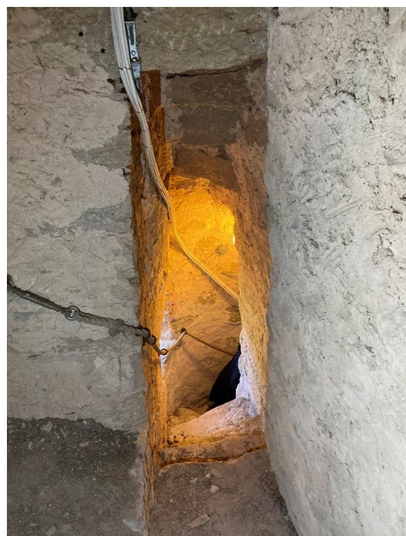
Bomhål för att kunna stänga tornet inifrån. Till höger trappans mynning i tornets första övervåning. Foto JL 2023.
