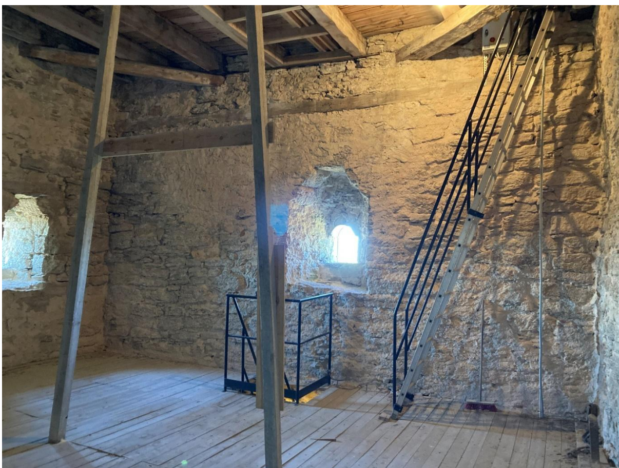
Tornets tredje övervåning mot norr. Foto JL 2023.
