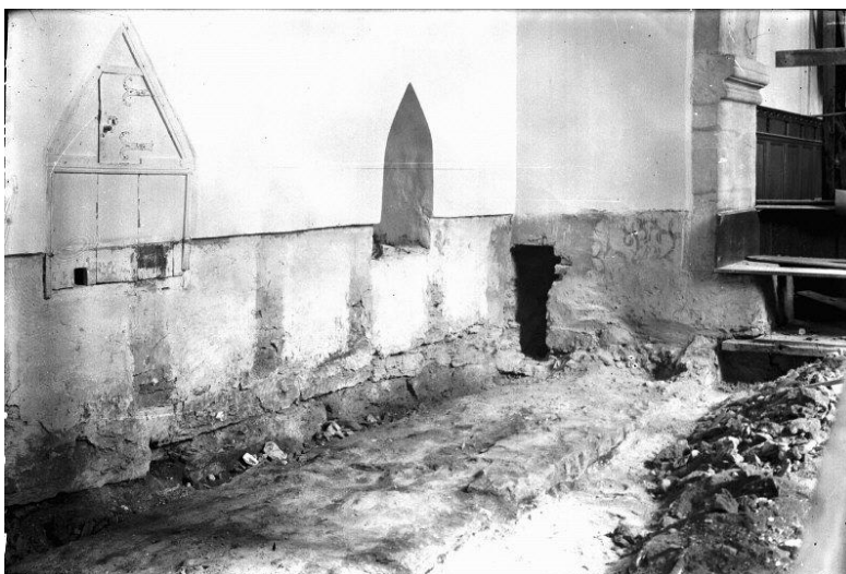
Långhusets nordöstra hörn under restaureringen 1929-1930 med frilagd grundmur från det äldre långhuset. Till höger interiör mot öster av det nyrestaurerade kyrkorummet. Foto Erik Fant 1929 respektive 1930, ATA.
