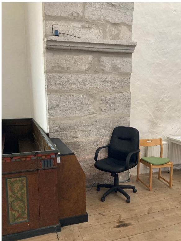
Tornbågens södra och norra vederlagsmur. Foto JL 2023.
