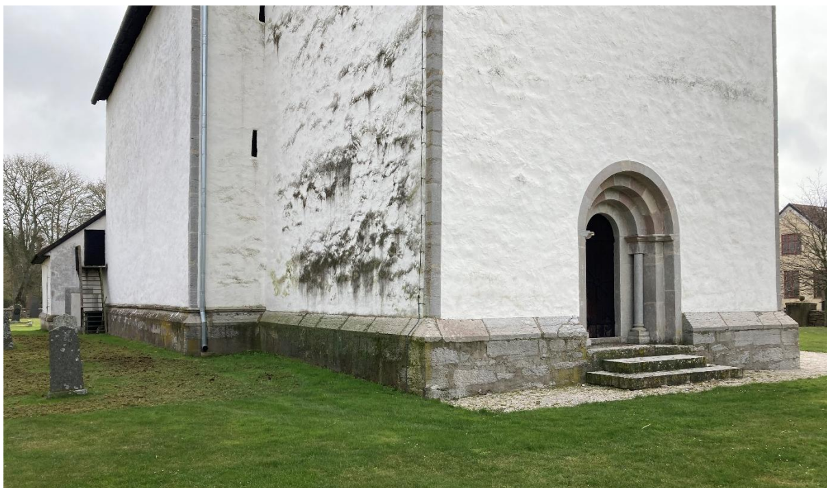
Tornets nedre del och långhuset från nordväst. Foto JL 2023.
