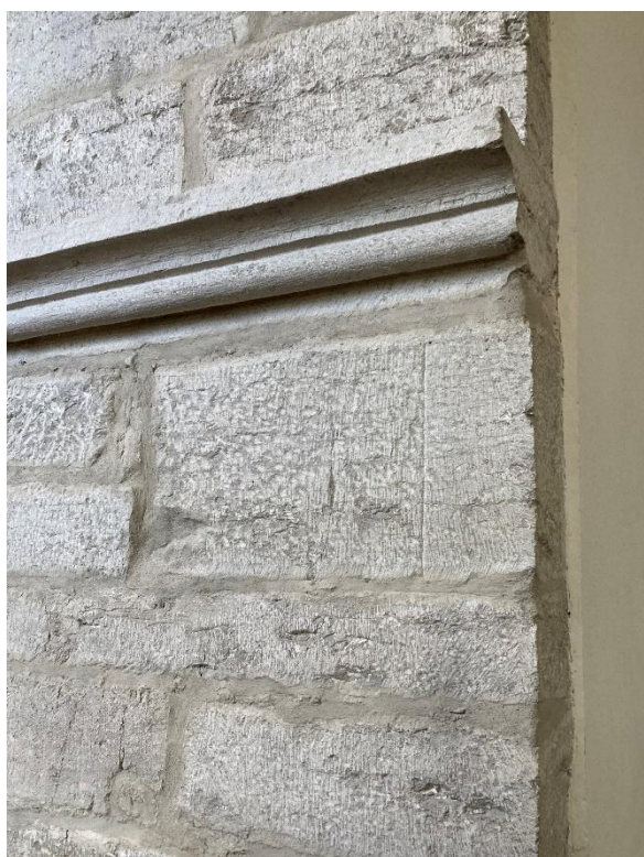
Detalj av tornbågens norra vederlagsmur med block, avsett för en hörnkedja samt närbild av gesimsen. Till höger ringkammarens och tornbågens övre del, sett från läktaren mot öster. Foto JL 2023.
