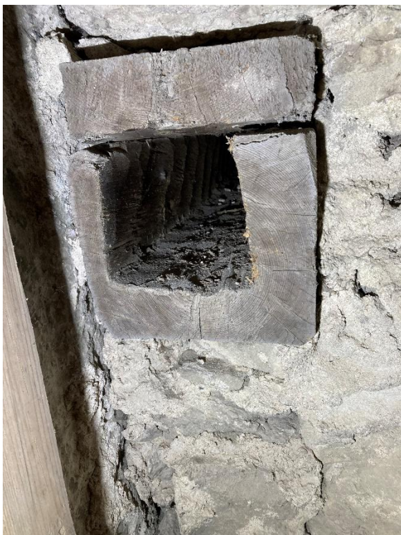
Bomhål för att kunna stänga tornet inifrån. Till höger trappans mynning i tornets första övervåning. Foto JL 2023.
