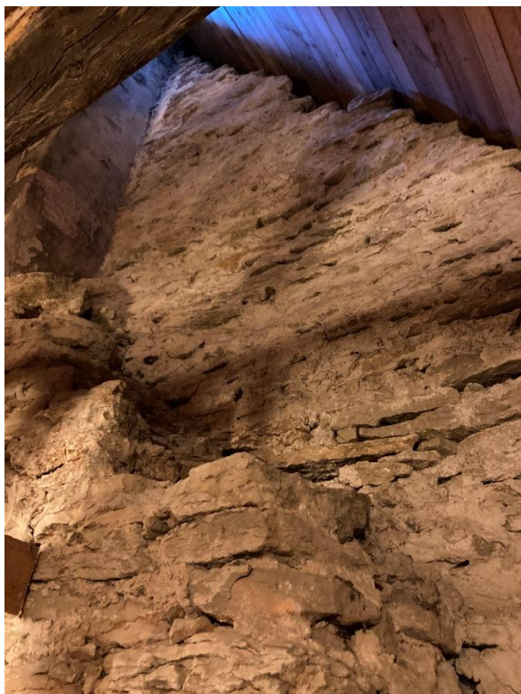
Del av södra delen av långhusets östra gavel med röstets påbyggnad från 1929 och skorstensstock. Till höger långhusets östra gavelröste (triumfbågsmuren) från nordväst med öppning till korvinden. Foto JL 2023.
