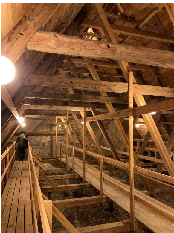
Långhusvinden mot nordväst och sydöst. Foto JL 2023.
