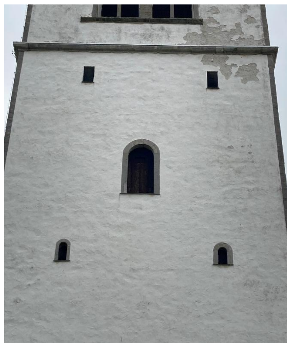
Lastport och ljusgluggar på västra fasaden av tornets mellersta del. Foto JL 2023. Ovan till höger detalj av öppningarna, nedan till höger öppning på norra fasaden under ljudgluggarna. Foto Pär Malmros 2022, Visby stift.
