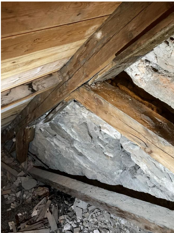
Triumfbågsmuren sedd från korvinden mot sydväst och nordväst. Entydiga spår saknas av byggnadskronologin mellan kor och långhus. Hålet ner till sakristian är en före detta rökgång till den tidigare skorstenen. Foto JL 2023.
