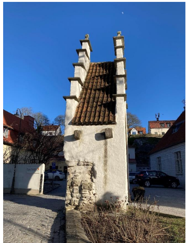
Den norra stigluckan fotograferad från öster respektive väster. På bilden tagen från öster syns spår efter den låga smala muren som uppfördes 1859. På bilden tagen från väster syns spår efter den tidigare muren samt konsoler för en takränna. Foto ES 2025.
