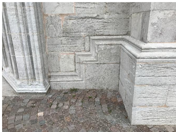
Stora kapellet. Sydöstra kontrefortens (strävpelarens) bas med detalj. Foto JL 2024.
