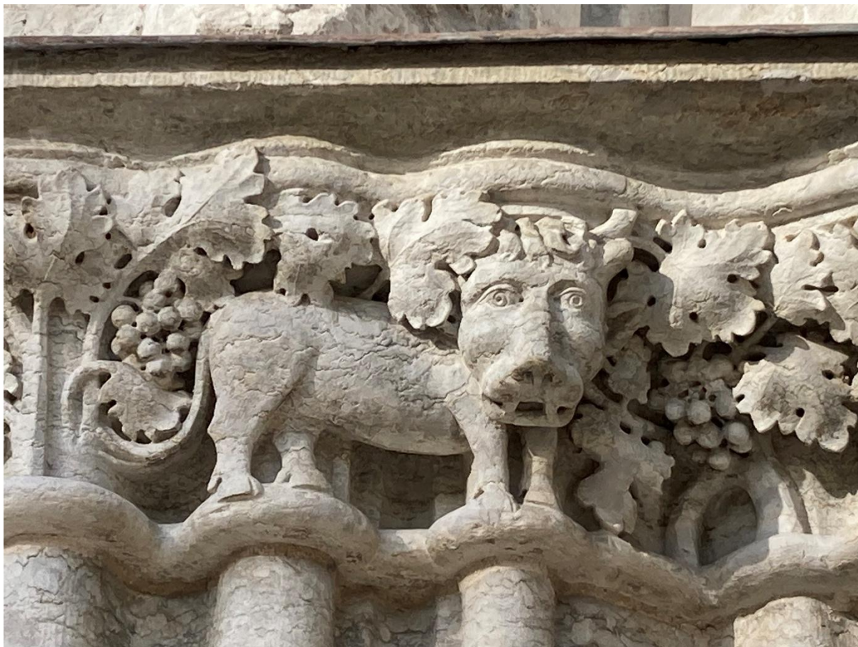
Detalj av västra kapitälbandet i Stora kapellet portal. Foto JL 2024.
