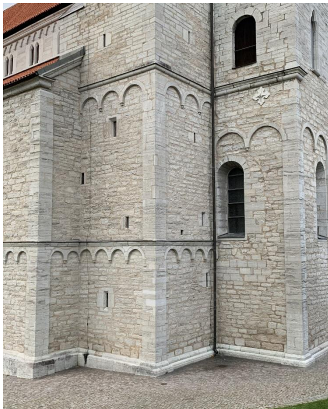
Koret från söder med rundbågigt fönster från 1892 i stället för ett spetsbågigt. Till höger sockel på korets östra sida. Foto JL 2020 respektive 2025.
