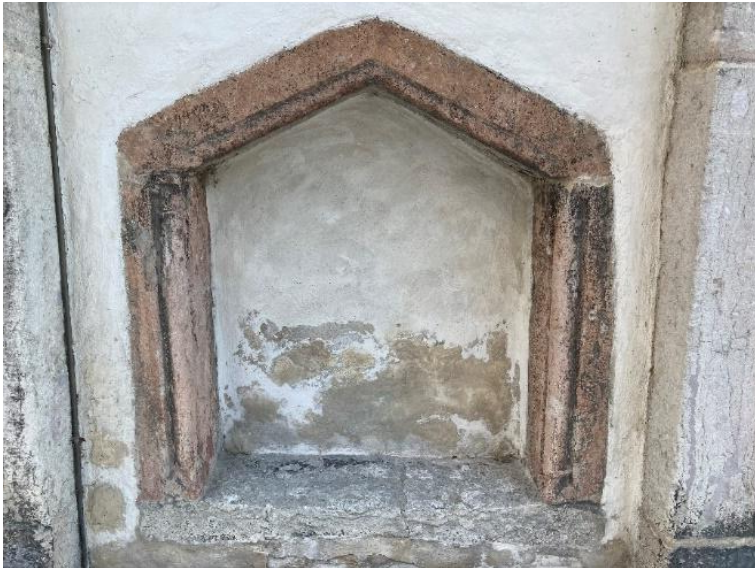
I stigluckan finns sittnisher på båda sidor under låga vinkelbågar. Vinkelbågens framkant bildar en rundstav som på båda sidor avslutas med gapande drakhuvuden i den östra sittnischen, överst. Foto ES 2024.
