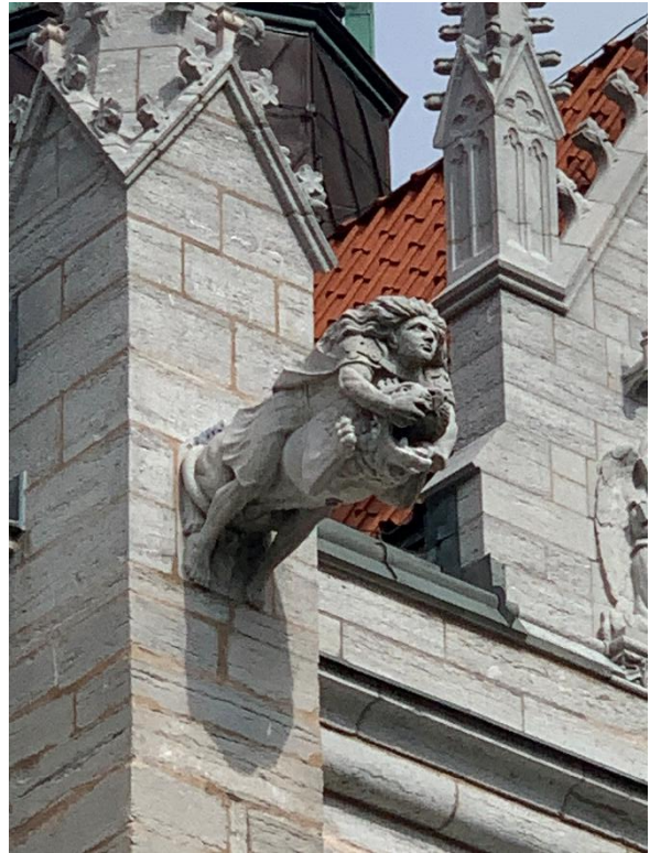
Stora kapellet. Del av takprofilen med fialer och skulpterade krönande detaljer. Till höger vattenkastare. Kopia från ca 1900 efter rester av medeltida vattenkastare. Foto JL 2018 och 2023.
