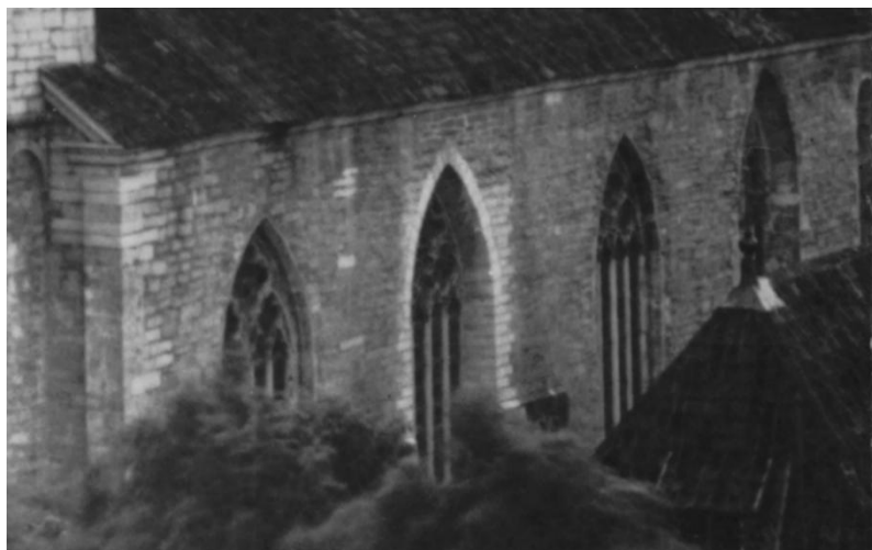
Långhusets nordfasad ovanifrån från nordöst strax efter restaureringen 1899-1903. Ljusa partier nyhuggna. Det andra fönstret från öster har helt nyhuggen omfattning, synbarligen inte lika snedfasad som tidigare. Foto (detalj) Gerd Reimers ca 1910, ATA.
