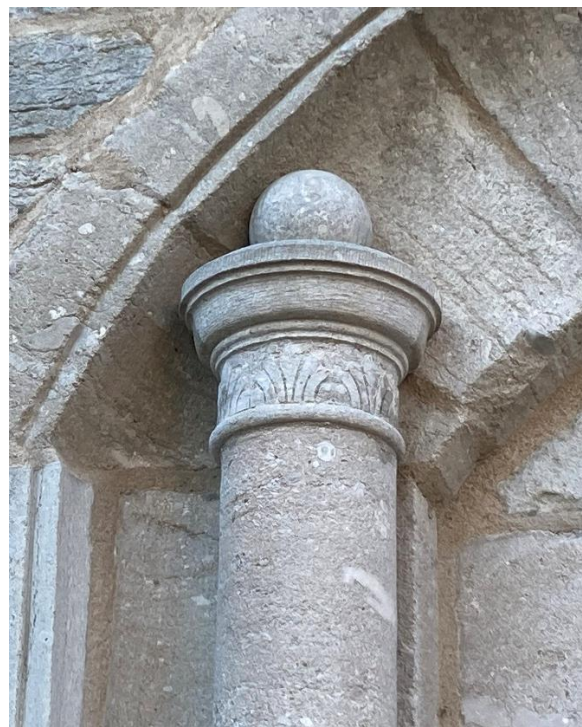
Murverket i nedre delen av det utvidgade långhusets norra fasad nära västra hörnet med återanvända stenblock från långhusets äldre murar. Sockeln nyhuggen på 1800-talet. Foto JL 2022. Nedan långhusets norra portal, troligen flyttad från det äldre långhuset och ombyggd, bland annat när fönstret ovanför förstorades på 1300-talet. Kapitälerna troligen från 1800-talet. Foto JL 2024.
