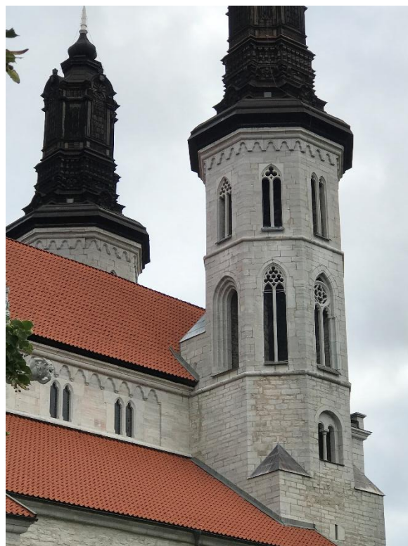
Romansk ljudglugg mot öster i den äldre nedre delen av sydöstra tornet. Till höger sydöstra tornets övre del från sydväst. Foto JL 2024 respektive 2017.
