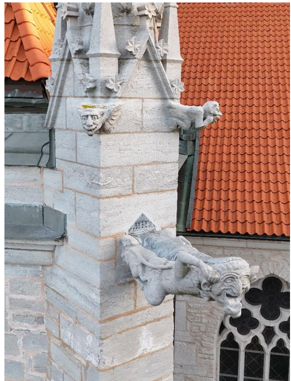
Stora kapellet. Vattenkastare och fialernas gargojler på kapellets västra del samt i sydöstra hörnet. Foto Pär Malmros 2024, Visby stift.
