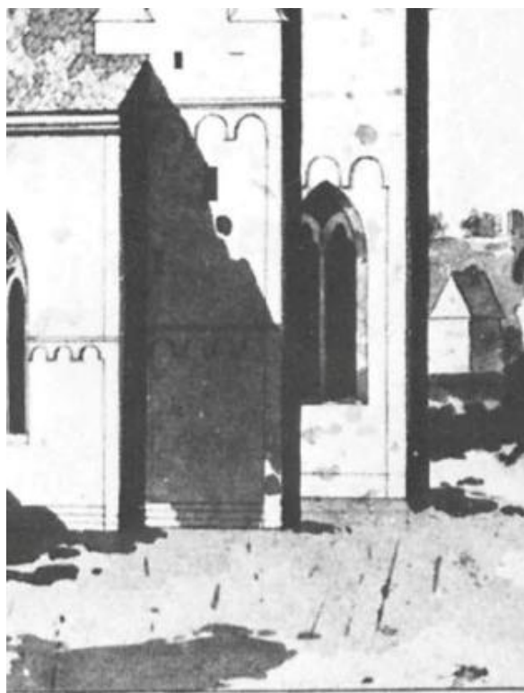
Koret från söder med det 1892 förändrade södra fönstret. Teckning av Jacob Gustaf Klingwall, efter Sveriges Kyrkor 175, Gotland XI:1 (1978). Till höger korets östra fasad med den gotiska påbyggnaden. Foto JL 2019.
