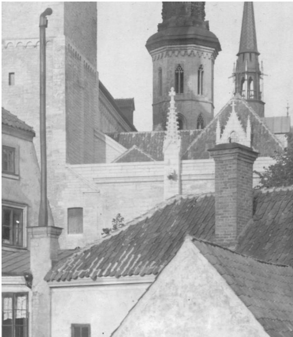
Anslutningen mellan västtornet och Stora kapellets tak mellan restaureringarna 1899-1903 och 1979-1985 sedd från väster med en takaltan intill tornet med tillgång från södra sidoskeppsvinden. Foto (detalj) ca 1900, ATA. Till höger anslutningen efter att ett tak lades ovanför den tidigare takaltanen 1979-1985 sedd från väster. Foto JL 2025.
