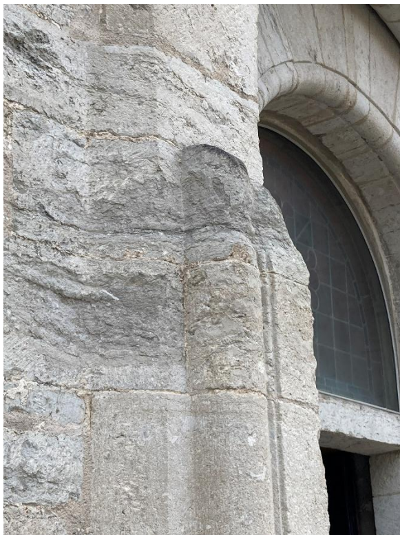
Del av västportalens yttre omfattning, formad som sockeln, men tvärt avbruten. Foto JL 2023.
