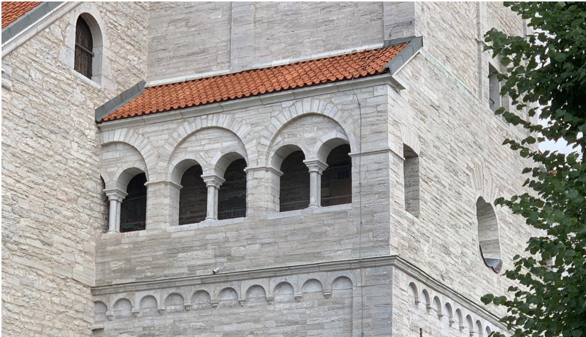
Västtornets gallerivåning från nordväst. Foto JL 2019. Galleriet, som haft en motsvarighet i söder, som är på samma höjd som det fyrpassformiga fönstret in till tornets emporvåning, framstår som en markering i fasaden av en invändiga emporvåningen. Galleriernas placering och form har tagits till förebild för flera andra gotländska kyrkor under 1200- och 1300-talen.
