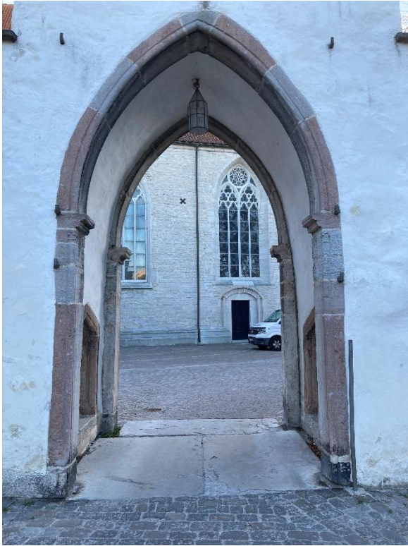
Nordportalens portöppningar är spetsbågiga med omfattningar huggna av röd- och gråaktig kalksten. Hörnen är formade som rundstavar med bas- och knoppkapital. Foto ES 2024.
