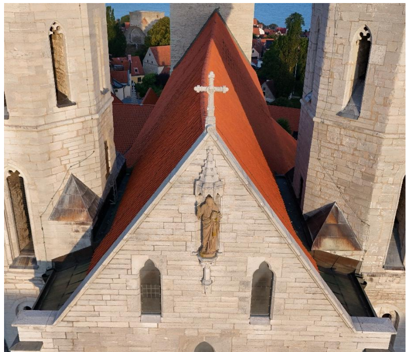
Östra gaveln. Lastport med hissbom, i nuvarande utformning från 1899-1903. Foto JL 2024. Till höger gavelröstet och bakom det taknocken med den vid restaureringen tillkomna krökningen avnocken. Foto Pär Malmros 2024, Visby stift.
