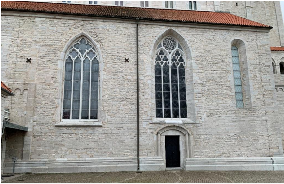
Västra delen av långhusets norra fasad. Foto JL 2020.
