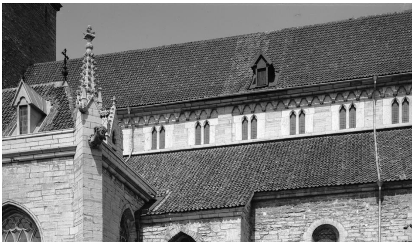
Klerestoriet strax efter restaureringen 1899-1903. Ljusa partier med nyhuggen sten visar att stora delar av öppningarna mot söder nyhöggs. Foto Martin Olsson ca 1910, ATA.
