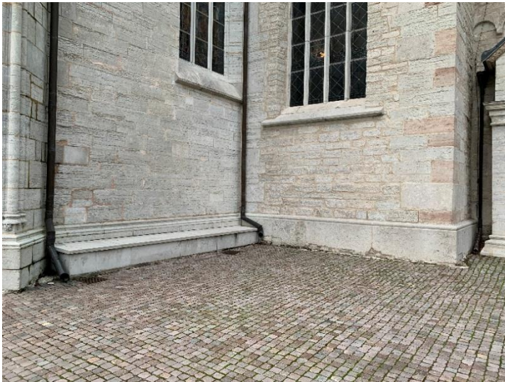
Hörnet mellan Stora kapellet, till vänster, och Köpmankoret, till höger, visande skillnad i karaktären i murverket. Till höger Köpmankorets fönster samt en del av Stora kapellets östra fönster visande skillnaden i omfattningens utformning. Foto JL 2020.
