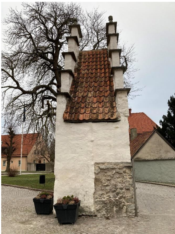
Den norra stigluckan fotograferad från öster respektive väster. På bilden tagen från öster syns spår efter den låga smala muren som uppfördes 1859. På bilden tagen från väster syns spår efter den tidigare muren samt konsoler för en takränna. Foto ES 2025.
