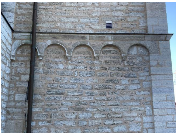
Romanska bågfriser på korpartiet. Ovan till vänster den övre bågfrisen, därunder den nedre på tornets östra sida, till höger båda friserna på tornets norra sida. Foto JL 2020.
