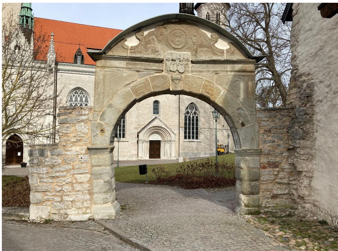
Den södra stigluckan uppförd i sandsten under första delen av 1600-talet. Flyttat till sin nuvarande plats 1863. I dag är den svårt vittrad. Foto från söder ES.
