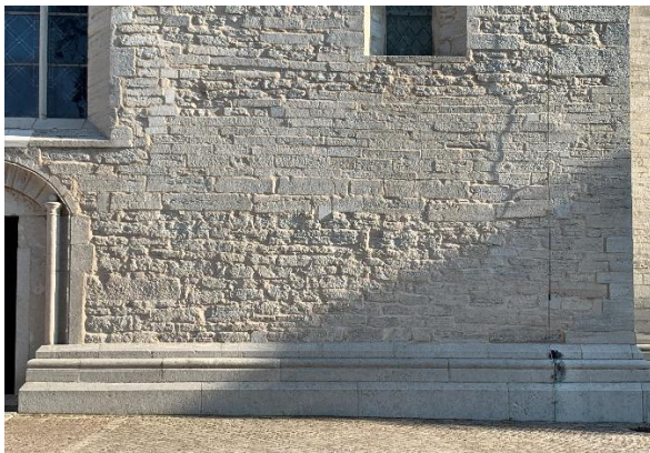
Murverket i nedre delen av det utvidgade långhusets norra fasad nära västra hörnet med återanvända stenblock från långhusets äldre murar. Sockeln nyhuggen på 1800-talet. Foto JL 2022. Nedan långhusets norra portal, troligen flyttad från det äldre långhuset och ombyggd, bland annat när fönstret ovanför förstorades på 1300-talet. Kapitälerna troligen från 1800-talet. Foto JL 2024.
