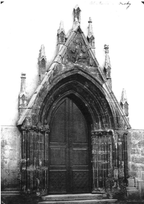
Stora kapellets portal före och efter restaureringen omkring 1900. Ljusa partier visar nyhuggen sten. Foto ca 1890 respektive J. W. Hamner 1907, ATA
