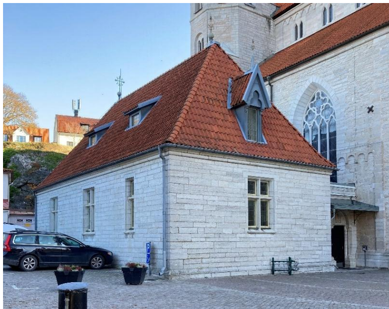
Sakristian, byggd 1899- 1903, sedd ovanifrån från nordöst, från sydöst och från nordväst. Foto Pär Malmros 2024, Visby stift, respektive JL 2020 och 2024. Förbindelsebyggnadens östra del tillkommen i slutet av 1920-talet.
