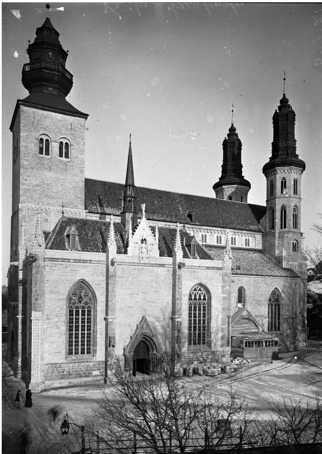
Exteriör från sydväst under pågående restaurering. Foto J. W. Hamner 1900, ATA.
