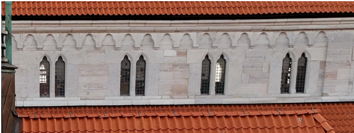
Mittskeppets högmur med "klerestorium" in till kyrkvinden. Frilagt och omfattningarna nyhuggna vid restaureringen 1899-1903. Vy från söder. Ovan foto JL 2024 respektive 2022. Till vänster och nedan foto Pär Malmros 2024, Visby stift.
