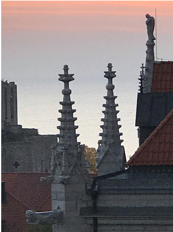
Stora kapellet. Del av takprofilen med fialer och skulpterade krönande detaljer. Till höger vattenkastare. Kopia från ca 1900 efter rester av medeltida vattenkastare. Foto JL 2018 och 2023.
