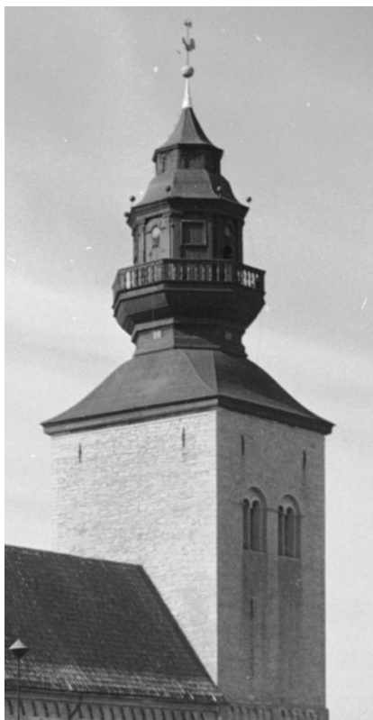
Tornkrönet från nordöst efter 1899-1903, innan de sluttande partierna täcktes med kopparplåt 1962-1963. Foto Iwar Anderson 1945, ATA. Till höger idéskisser till västtornets förändring. Axel Herman Hägg 1894-1896. Efter Sveriges Kyrkor 175, Gotland XI:1 (1978) respektive Domkyrkans arkiv R II a:7, foto Inventarieinventeringen.
