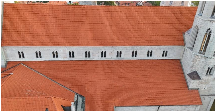
Mittskeppets högmur med "klerestorium" in till kyrkvinden. Frilagt och omfattningarna nyhuggna vid restaureringen 1899-1903. Vy från söder. Ovan foto JL 2024 respektive 2022. Till vänster och nedan foto Pär Malmros 2024, Visby stift.
