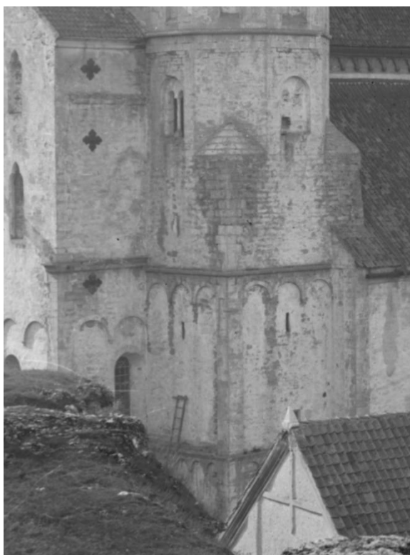
Det nordöstra tornets romanska del före och efter restaureringen. Ljusa stenar utbytta. Foto Carl Curman ca 1890 respektive Gerd Reimers ca 1910, ATA.
