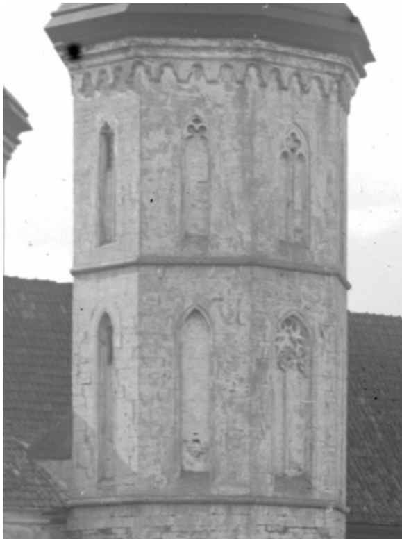
Nordöstra tornets övre del från nordöst före och efter restaureringen 1899-1903. Ljusa partier utbytta. Bilderna visar att de utbygga partierna är få. Foto Carl Curman ca 1890 respektive Gerd Reimers ca 1910, ATA.
