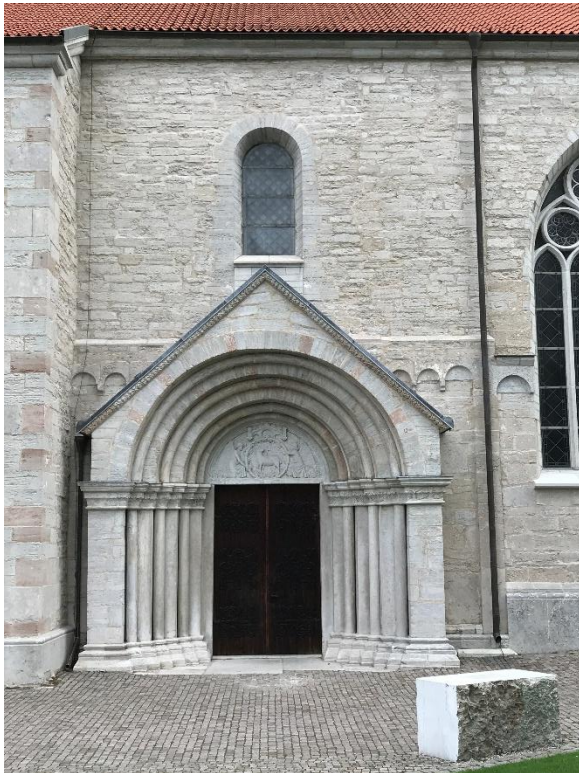
Murpartiet bakom Brudportalen utgörande den äldsta kyrkans södra tvärskeppsgavel med delvis igensatt äldre fönster. Foto JL 2017. Till höger Brudportalen före 1899-1903. Foto ca 1890 i ATA.
