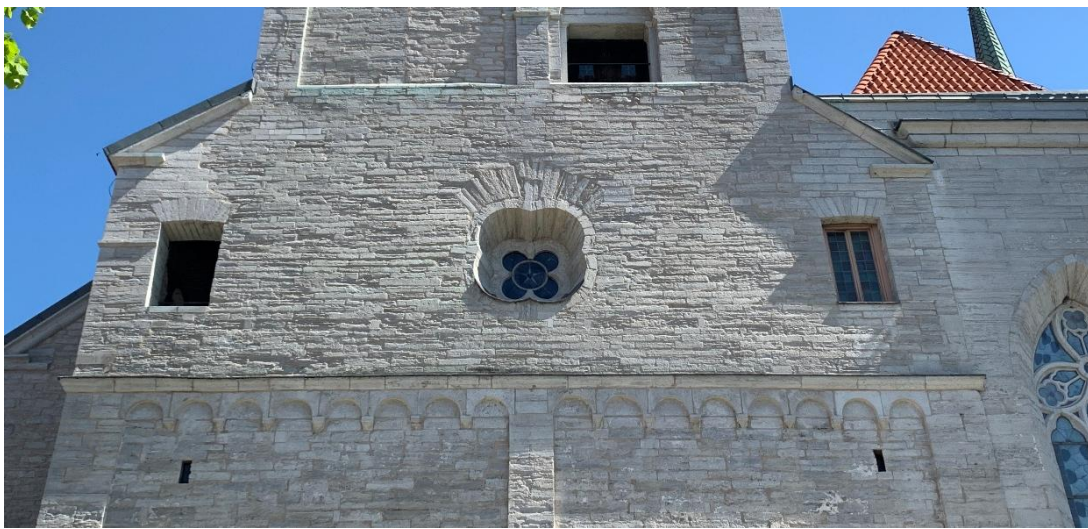
Västtornets västra fasad i nivå med emporvåningen och sidogallerierna i olika belysning. Foto JL 2024. Det fyrpassformade fönstret leder in till emporvåningen. Den rektangulära öppningen till vänster går till norra galleriet. Det rektangulära fönstret till höger är insatt i en motsvarande öppning till det tidigare södra galleriet. Galleriernas taklister rekonstruerade 1899-1903.
