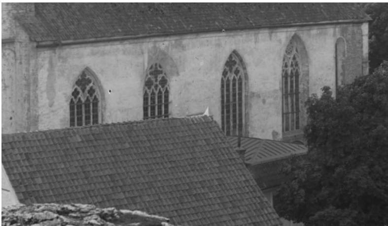
Långhusets nordfasad ovanifrån från nordöst före restaureringen 1899-1903. Fasaden var putsad. Foto (detalj) Carl Curman ca 1890, ATA.
