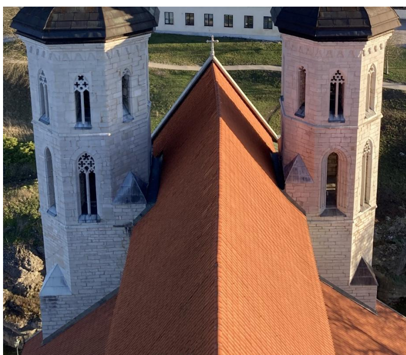
Östtornen sedda från västtornet. Till höger förstoring visande den gotiska förhöjningen och att norra tornet är bredare än det södra. Foto JL 2024.
