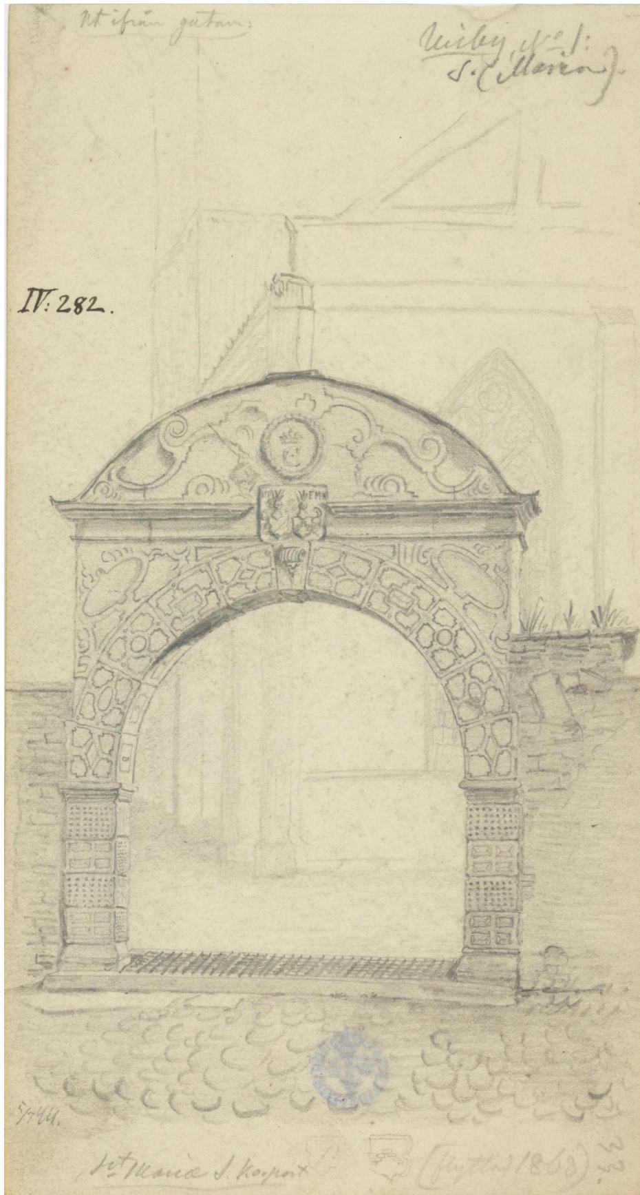
Den södra stigluckan tecknad av P A Säre 1844. Den uppfördes under första delen av 1600-talet. Stigluckan stod fortfarande vid mynningen av Södra kyrkogatan och flyttades 1863 till sin nuvarande plats vid mynningen av Ryska gränd. Porten är uppförd i sandsten och var fortfarande väl bibehållen under mitten av 1800-talet. I ingången fanns en färist (järngaller). Alvin, UUB.
