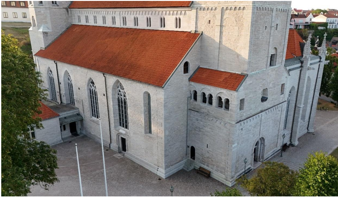
Norra fasaden och västtornets nedre del från nordväst, snett uppifrån. Foto Pär Malmros 2024, Visby stift.
