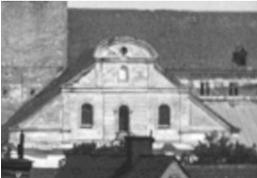
Stora kapellet tidigare gavel samt till höger klerestoriet under framtagning vid restaureringen 1899-1903. Foto (detalj) John Hertzberg ca 1900, Kungl. Tekniska Högskolan, Digitalt museum.
