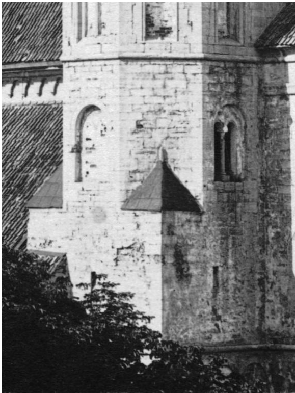
Sydöstra tornets nedre, äldre del från sydöst före 1899-1903 och från sydväst efter, där nya stenar är ljusa. Foto omkring 1890 samt av J. W. Hamner 1900, ATA.
