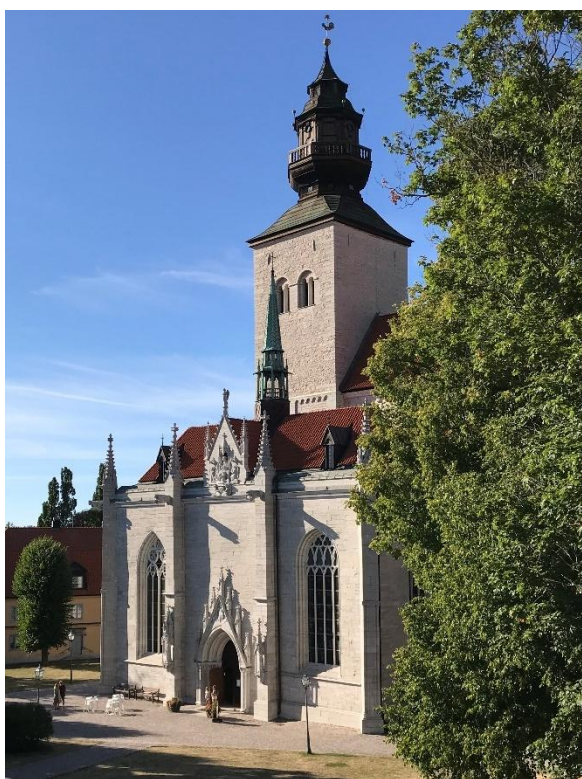
Stora kapellet från sydöst. Foto JL 2022 och 2024.
