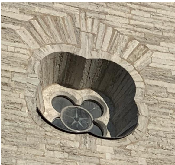
Emporvåningens fyrpassformade fönster med ram huggen i ett stycke. Domkyrkans äldsta bevarade fönsteröppning. Foto JL 2019 och Pär Malmros 2024, Visby stift.
