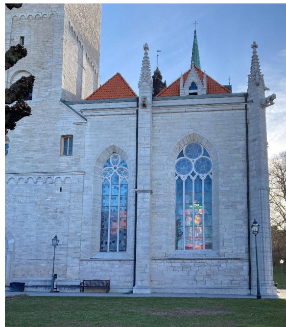
Anslutningen mellan västtornet och Stora kapellets tak mellan restaureringarna 1899-1903 och 1979-1985 sedd från väster med en takaltan intill tornet med tillgång från södra sidoskeppsvinden. Foto (detalj) ca 1900, ATA. Till höger anslutningen efter att ett tak lades ovanför den tidigare takaltanen 1979-1985 sedd från väster. Foto JL 2025.
