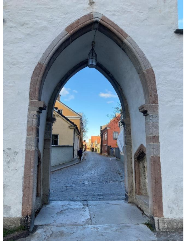
Nordportalens portöppningar är spetsbågiga med omfattningar huggna av röd- och gråaktig kalksten. Hörnen är formade som rundstavar med bas- och knoppkapital. Foto ES 2024.
