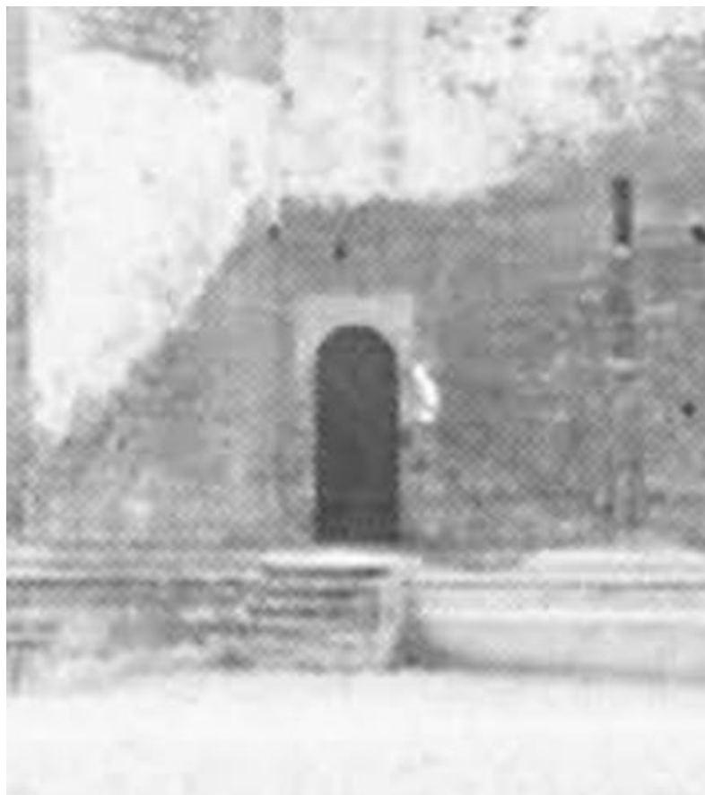
Ingången i tornets norra fasad till torntrappan före restaureringen 1899-1903. Foto J. A. Lagergren 1897. Efter Sveriges Kyrkor 175, Gotland XI:1 (1978). Öppningen sekundärt upptagen, senast på 1600-talet, igenmurad under 1700-talet, men återöppnad 1865. Sannolikt fick den då sitt rundbågiga krön att döma av att blocket med bågen är ljusare än omgivande murverk. Fältet som saknar puts markerar sannolikt taket på den bod som en tid låg i detta hörn enligt äldre ritningar.
