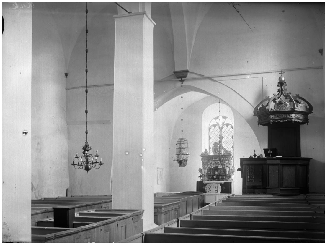
Interiör mot öster på 1920-talet, mellan restaureringarna 1873 (?) och 1950-51. Putsen kring triumfbågen är avtrappad i olika nivåer, sannolikt som en anpassning mellan den tjocka släta putsen och murens ojämnheter. Foto Anders Roland 1924, ATA.
