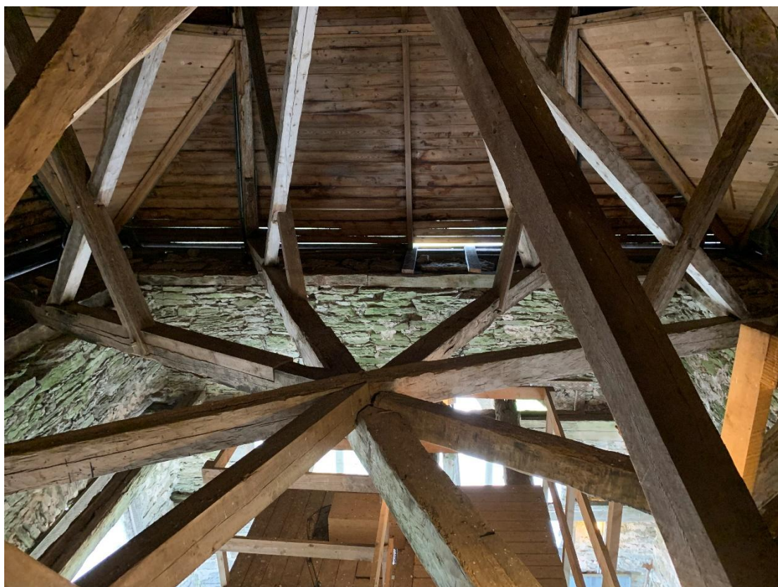
Tornhuvens bärande bjälklag mot norr. Foto JL 2021.
