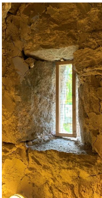
Ljusglugg i murtrappans nedre del. Till höger detalj av spiraltrappans trappsteg strax ovanför ljusgluggen med urtag i ett av stegen, sannolikt för att sprida ljuset från öppningen. Foto JL 2021.
