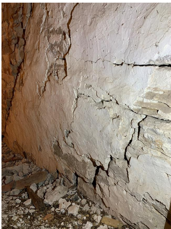
Det äldre långhusets bevarade gavelröste, södra delen med kvarstannande puts, sannolikt från 1100-talet eller 1200-talets början, samt avtryck av takfallet. Foto JL 2021.
