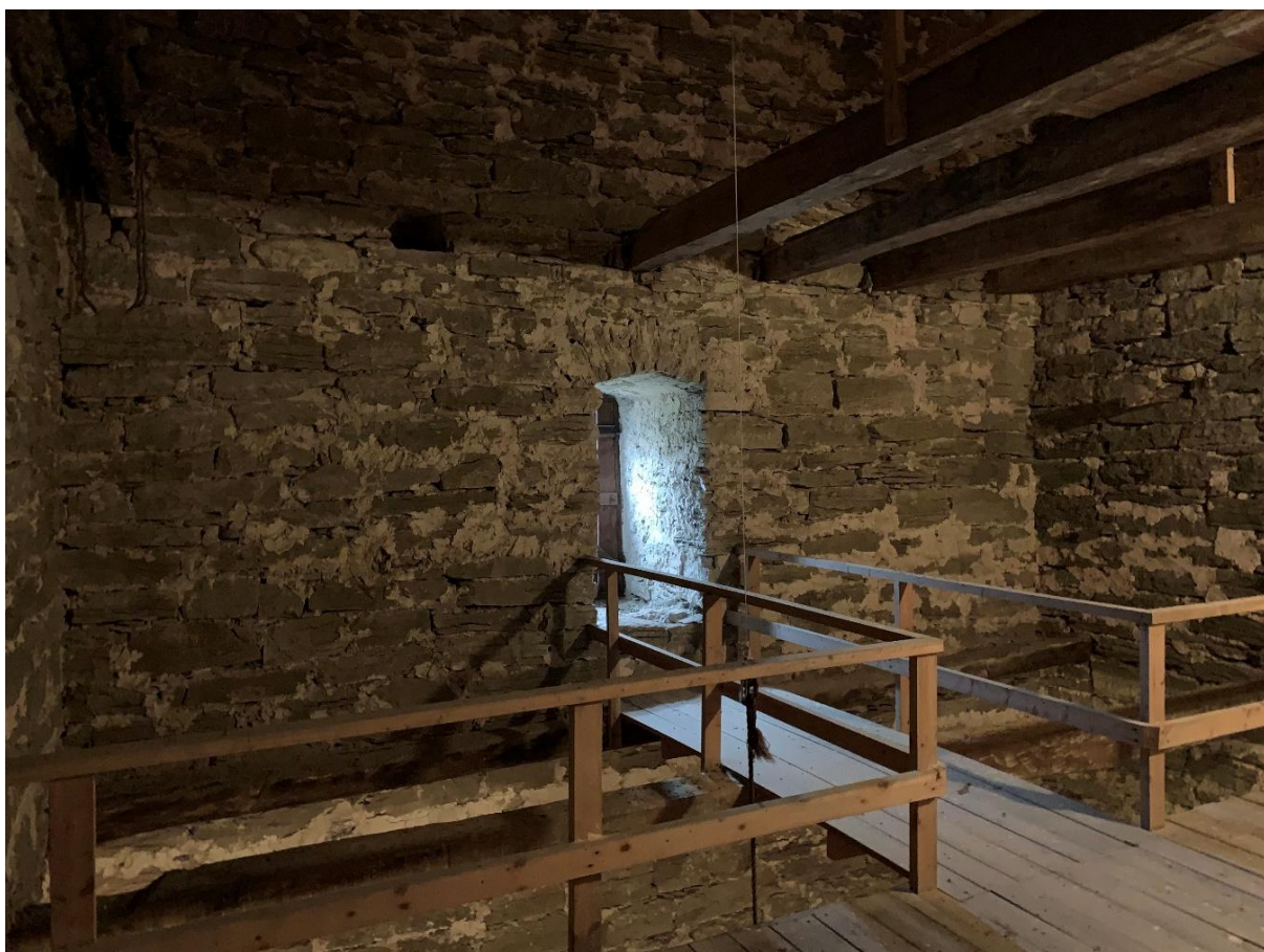
Tornets första övervåning mot väster. Bjälklagen under och över våningen endast delvis golvtäckta. Foto JL 2021.
