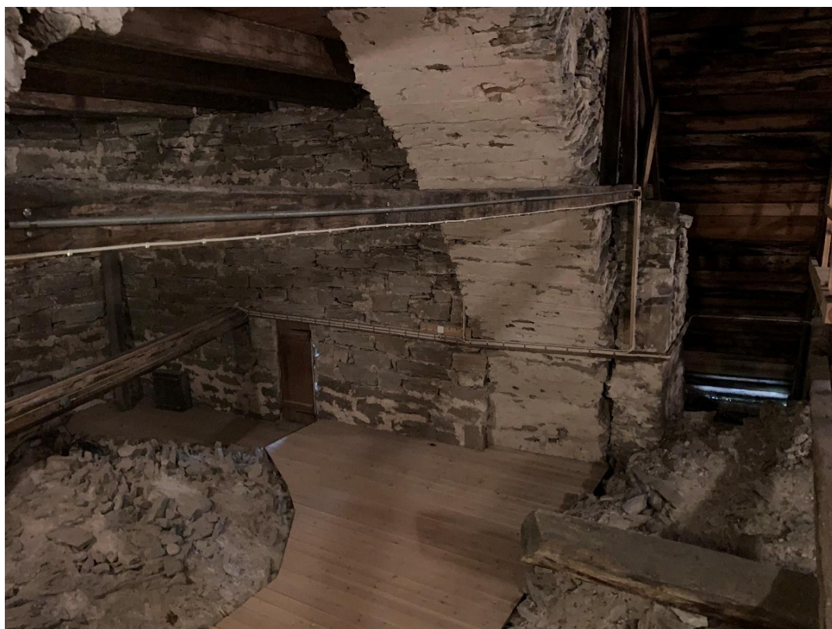
Vy mot nordväst från långhusvinden in mot tornets första övervåning. Foto JL 2021.
