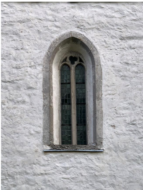
Tornets fönster, till höger tornet från sydöst. Foto JL 2021.
