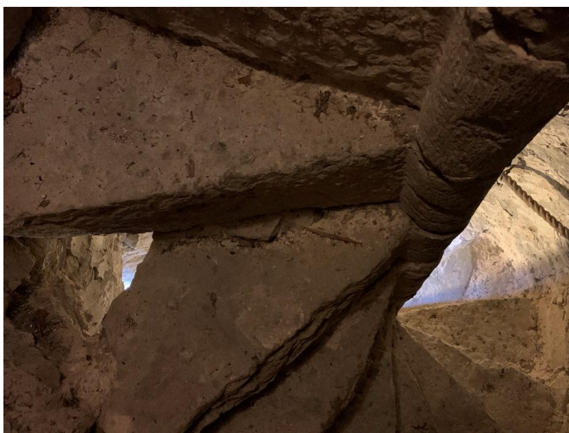
Ljusglugg i murtrappans nedre del. Till höger detalj av spiraltrappans trappsteg strax ovanför ljusgluggen med urtag i ett av stegen, sannolikt för att sprida ljuset från öppningen. Foto JL 2021.
