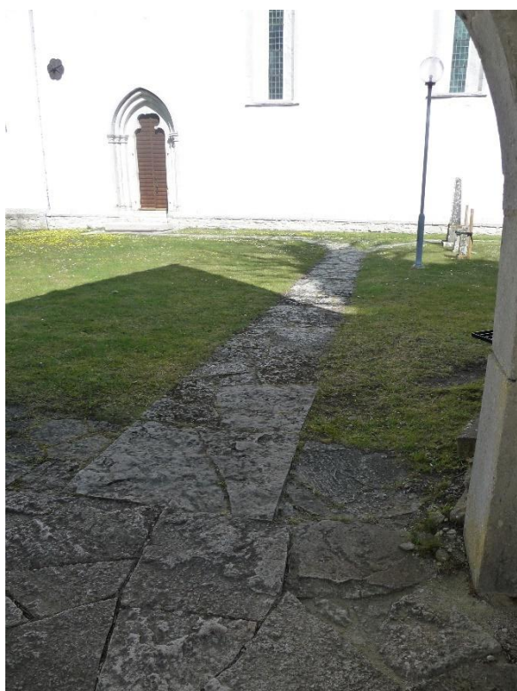
Gång belagd med kalkstensflis från en södra stigluckan mot kyrkan. Foto ES 2021.
