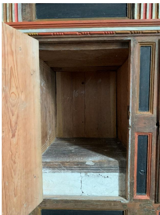
Skåp i korets norra mur med dörrar från 1600-talet. Den spetsigt formade panelen över skåpet samt den ornerade skåpsinsatsen visar att det är ett omgjort medeltida skåp, sannolikt tidigare sakramentsskåp. Foto JL 2021.
