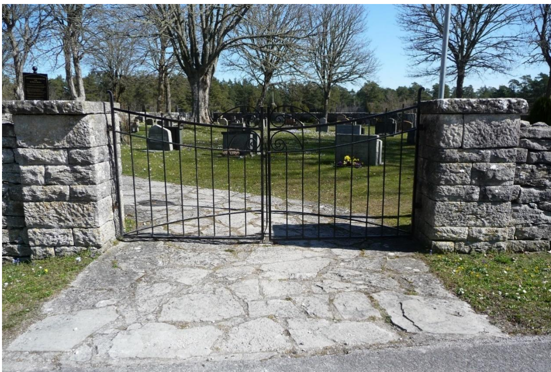
Ingången till den yngre kyrkogården ligger i det sydvästra hörnet. Järngrindar med fyrkantiga stolpar av kalksten med överliggare. Foto ES 2021.
