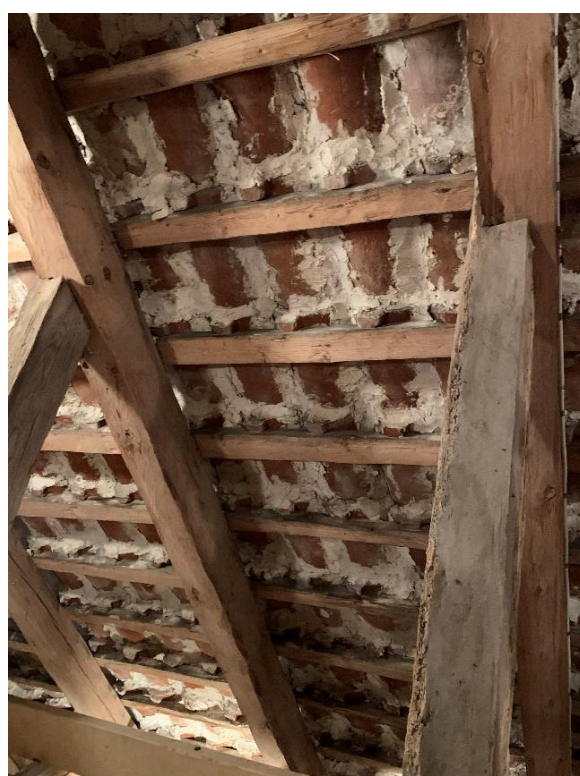
Korvindens nordvästra hörn samt del av södra takfallet med understruket tegel. Foto JL 2021.
