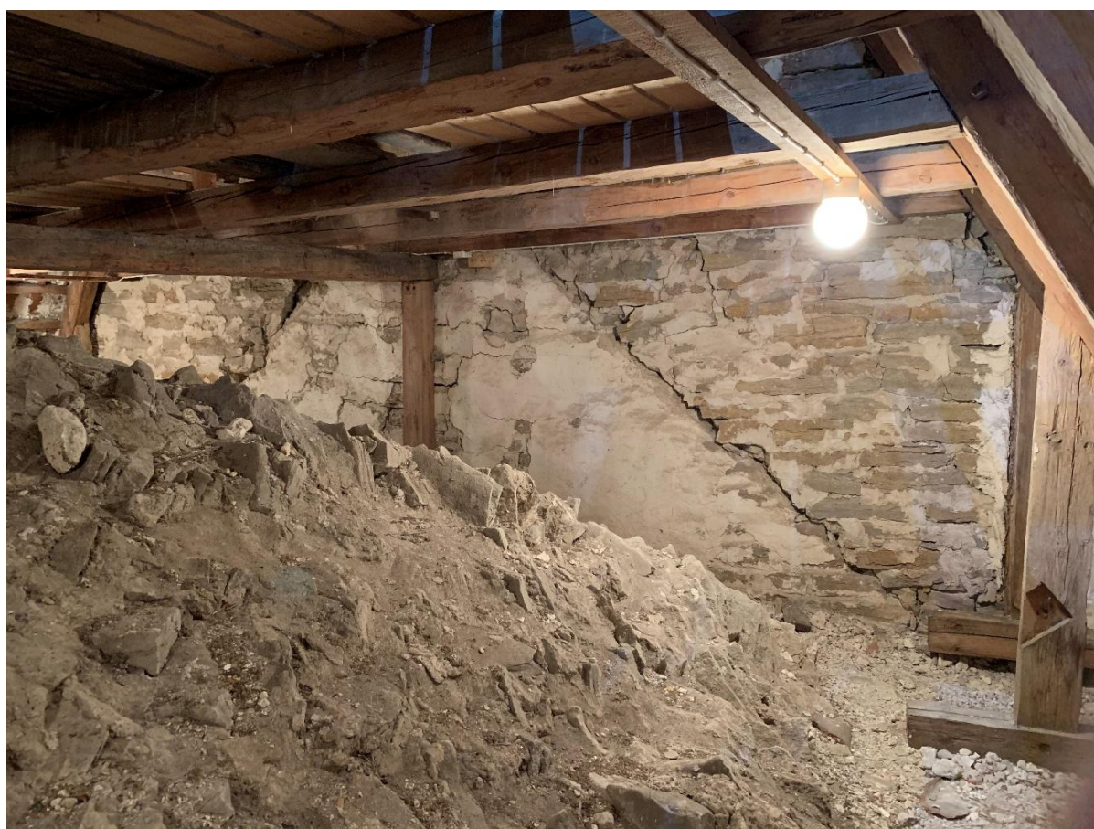
Korvindens nedre del mot väster. I korets västra gavel, triumfbågsmuren, ingår i den nedre delen ett äldre långhus östra gavel med ett ovanligt flackt sadeltak. Foto JL 2021.
