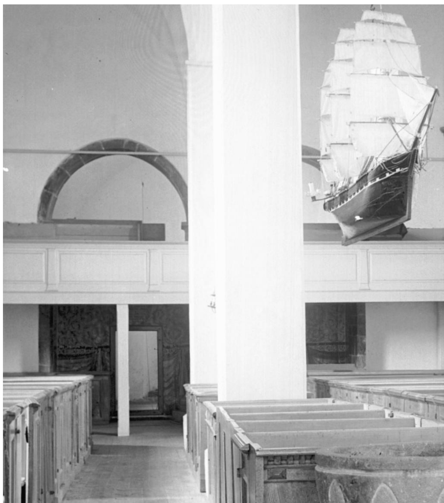
Interiör mot väster med skärmväggen uppställd i tornbågen för att avskilja ringkammaren, sannolikt som förvaringsrum. Beskuret foto Anders Roland 1924, ATA.
