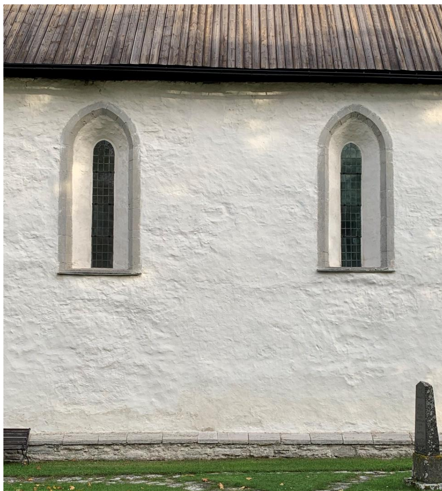
Södra långhusfasadens fönster. Foto JL 2021.
