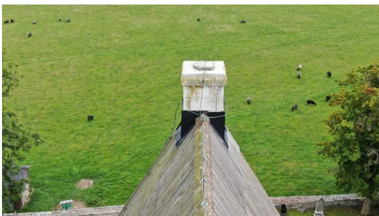
Skorstenen på långhustaket sedd ovanifrån från väster. Foto Pär Malmros 2021, Visby Stift.
