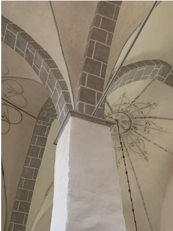
Östra långhuspelarens kapitäl sett från nordväst. Till höger sydvästra valvkonsolen samt avsågad bjälke, sannolikt från äldre dragstag. Foto JL 2021.
