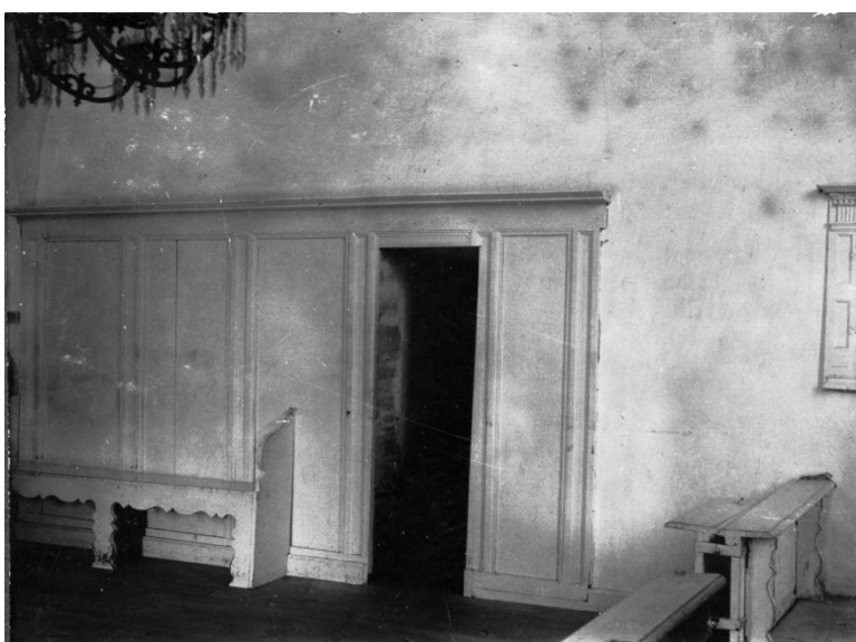
Korets norra sida före restaureringen 1950-51 med vitmålade snickerier och epitafierna avlägsnade. Foto från 1900-talets början, ATA.
