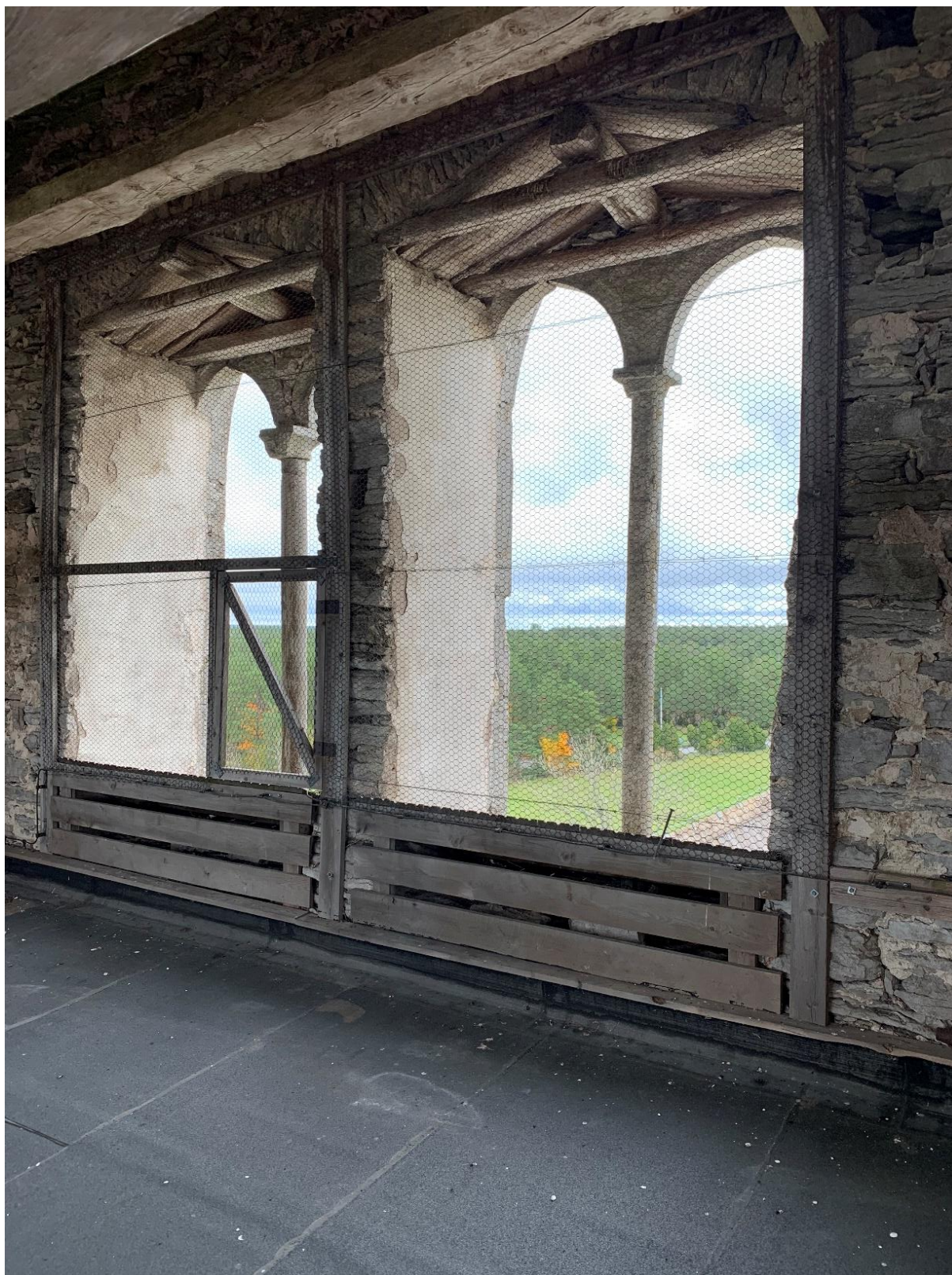
De östra ljudgluggarna, sedda mot nordöst. Det ursprungliga bärvirket från ljudgluggarnas rakspetsiga avtäckning intakt. Luckan i nätet är utgång till långhustaket. Foto JL 2021.
