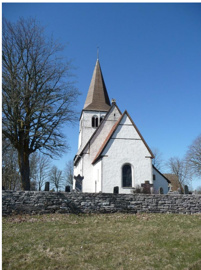
Den östra mursträckningen. Foto ES 2021.
