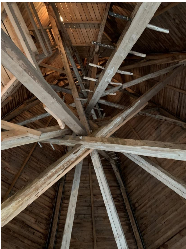
Tornhuvens inre konstruktion sedd underifrån. Foto JL 2021.
