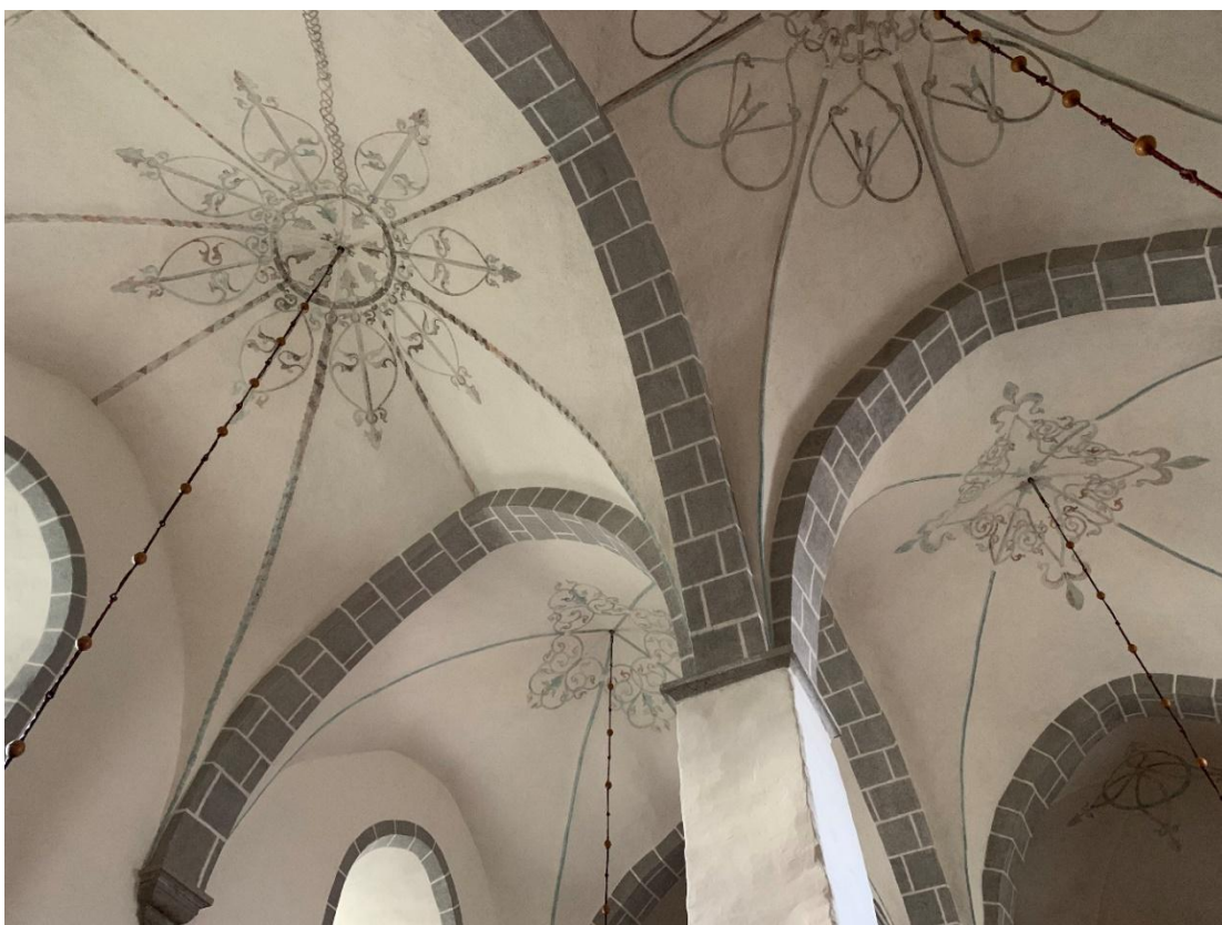
Långhusvalven sedda underifrån mot sydväst samt östra pelaren. Foto JL 2021.
