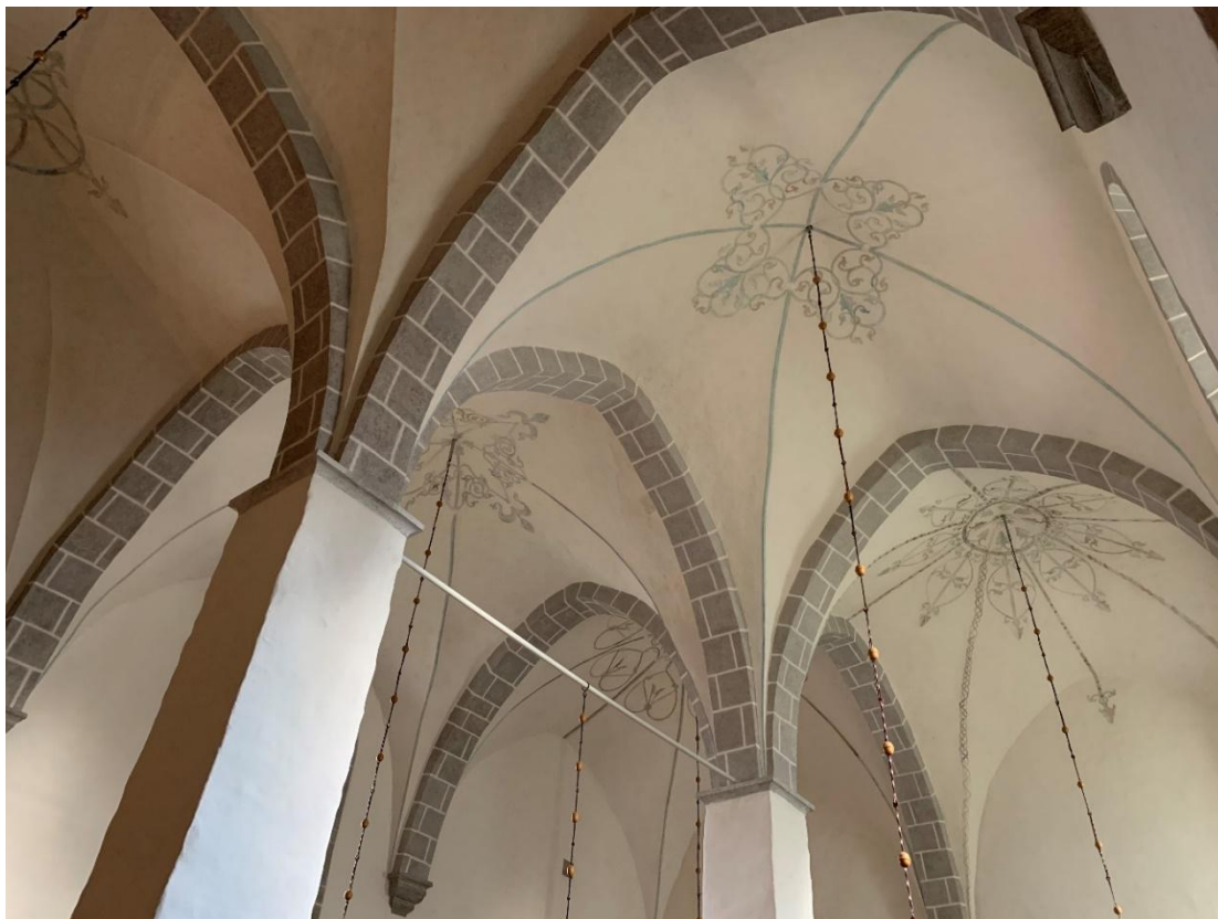
Långhusvalven sedda underifrån mot nordöst. Foto JL 2021.
