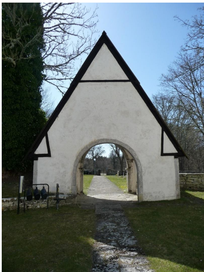
Den södra stigluckan fotograferad från norr. Foto ES 2021.
