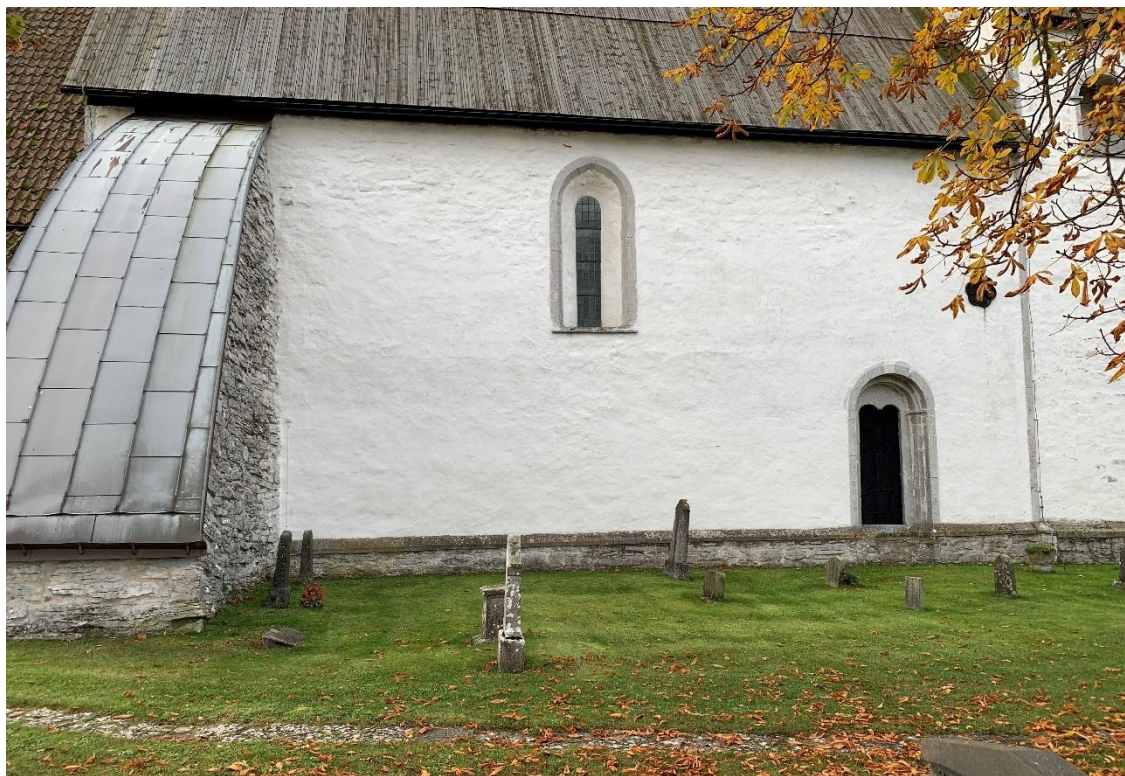
Långhusets norra fasad. Foto JL 2021.
