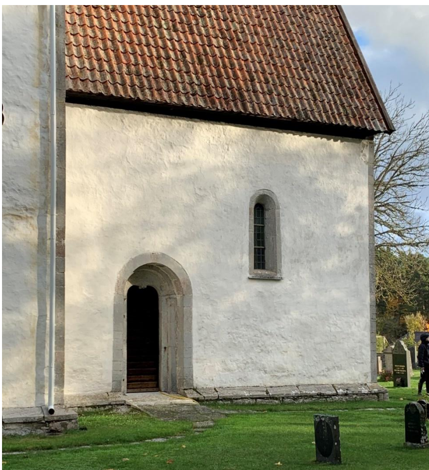
Korets södra fasad. Foto JL 2021.
