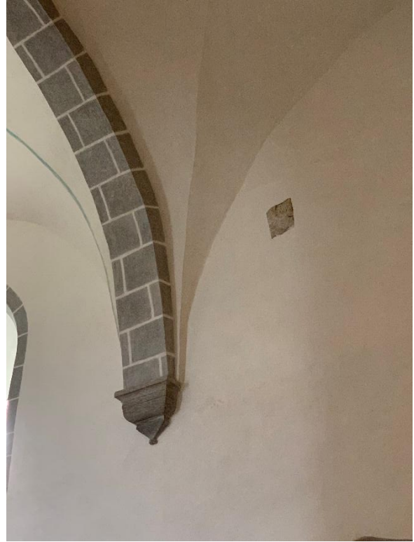
Östra långhuspelarens kapitäl sett från nordväst. Till höger sydvästra valvkonsolen samt avsågad bjälke, sannolikt från äldre dragstag. Foto JL 2021.
