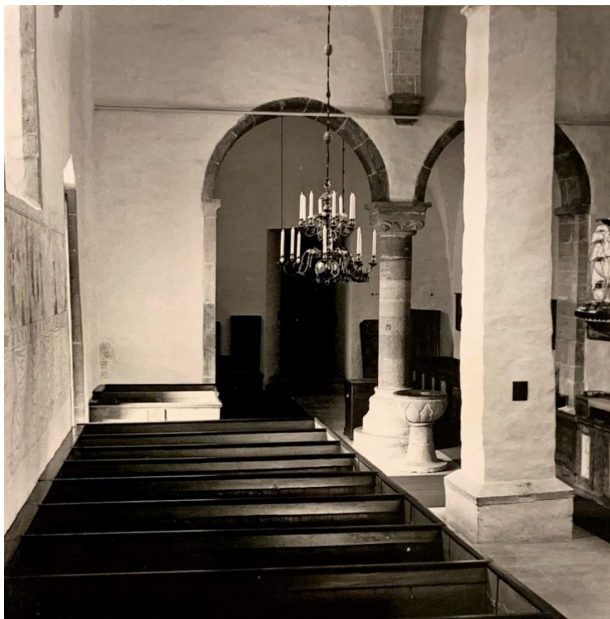
Interiör mot väster strax efter restaureringen 1950-51. Läktaren har rivits, tornbågen frilagts, skärmväggen flyttats och bänkarnas mittkvarter har ställts upp i ringkammaren. Foto från 1950-talet i Gotlands Museums arkiv (GFF960_29).
