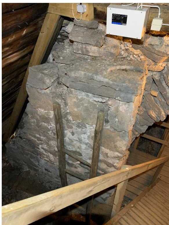
Den södra av sidomurarna framför tornets östra mur. Till höger staplat stöd för långhustakstolens hjärtstock, ställd på trappa i svickeln mellan långhusets västligaste valv, sett från väster. Foto JL 2021.
