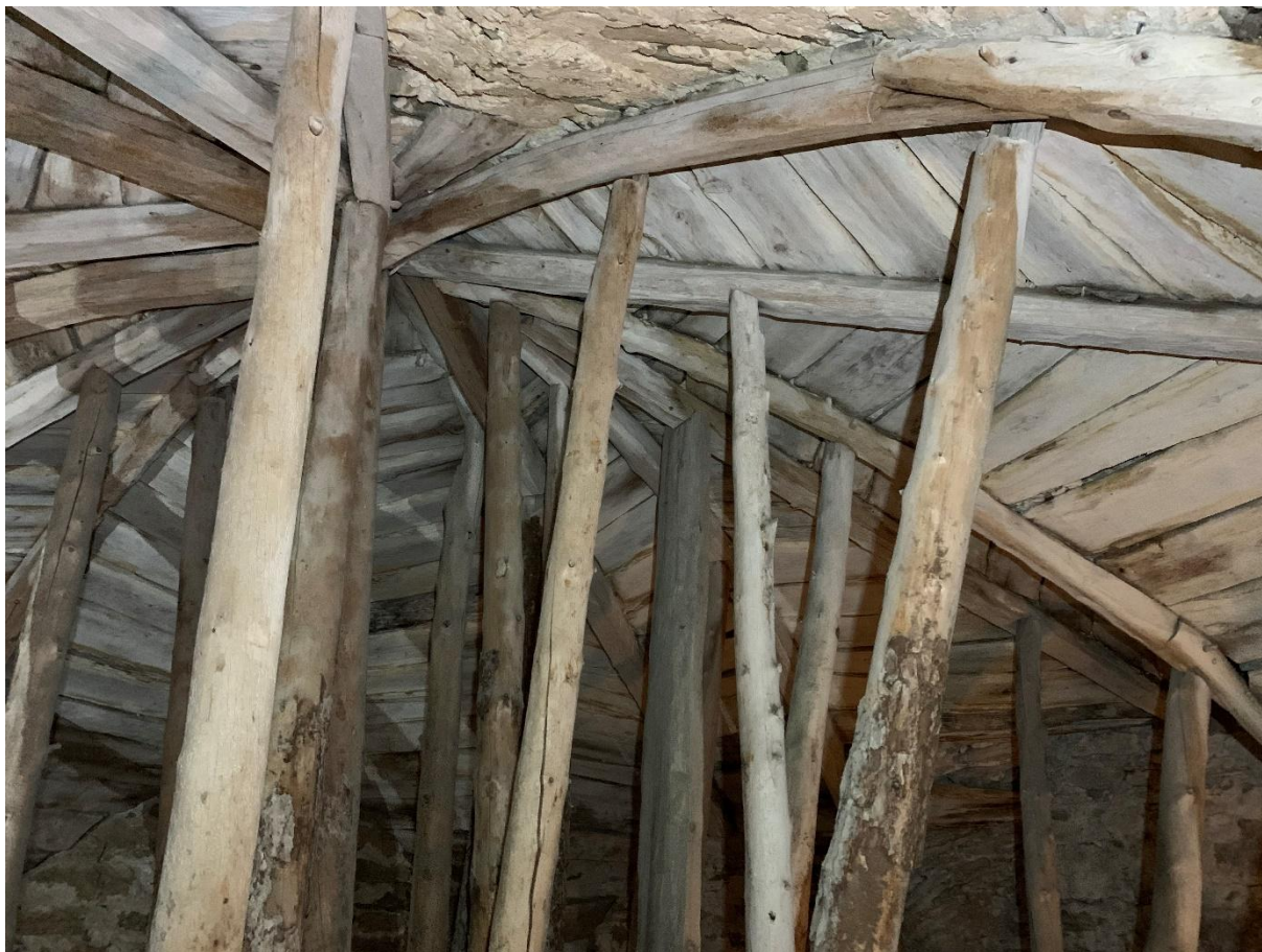
Fjärde övervåningens kvarstående bärkonstruktion och skällbräder för slagningen av det åttkantiga valvet. Foto JL 2021.
