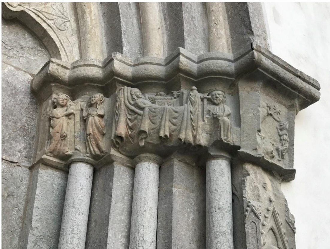
Tornportalens södra kapitälband. Foto JL 2021.
