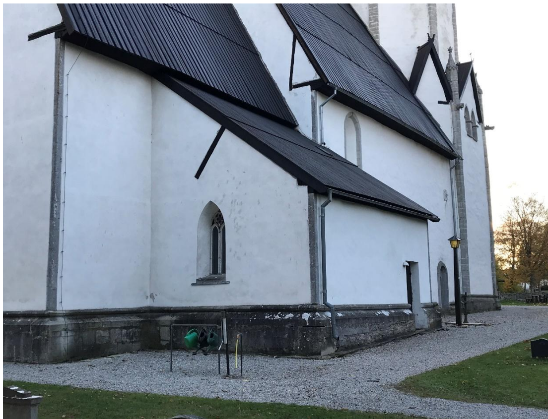
Exteriör av sakristian från nordöst. Foto JL 2021.
