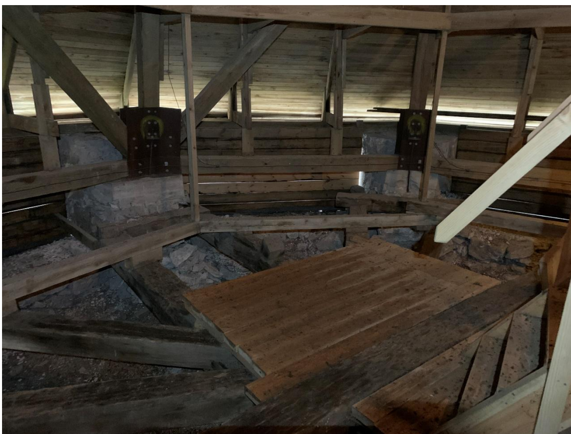
Tornets översta våning mot nordöst. Murtrappans mynning i mitten. Foto JL 2021.
