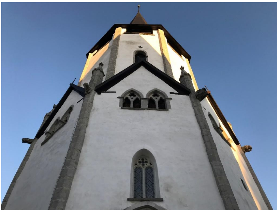
Tornet sett nedifrån från väster. Foto JL 2021.
