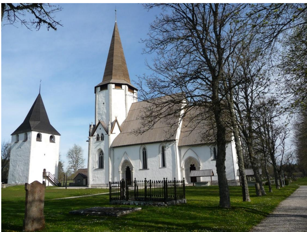
Lärbro kyrka och den södra delen av kyrkogården fotograferad från sydost. Foto ES 2021.
