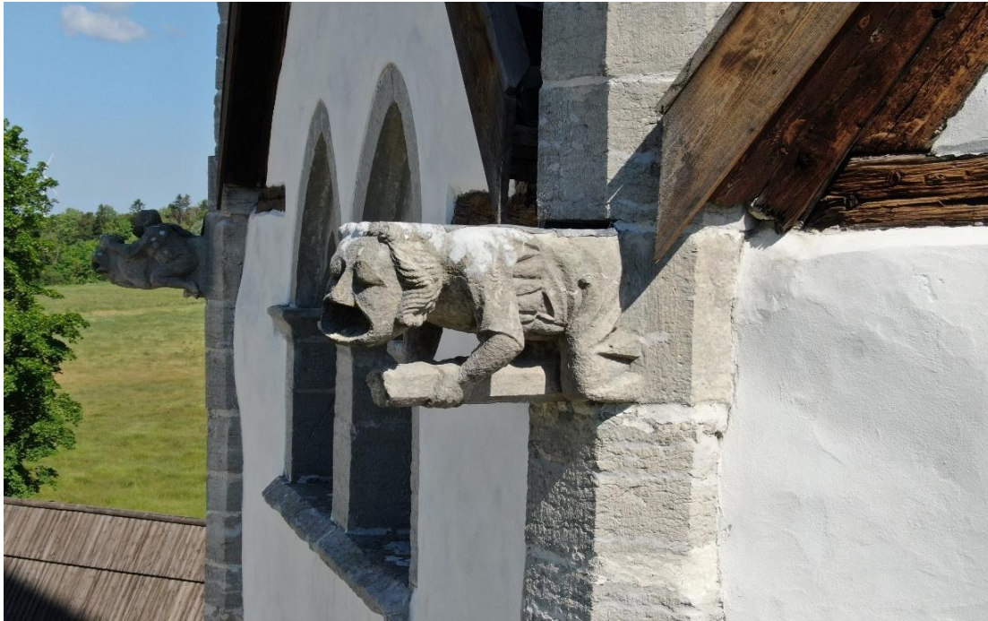
Tornets sydvästra galleri med vattenkastare. Foto Pär Malmros 2021, Visby stift.
