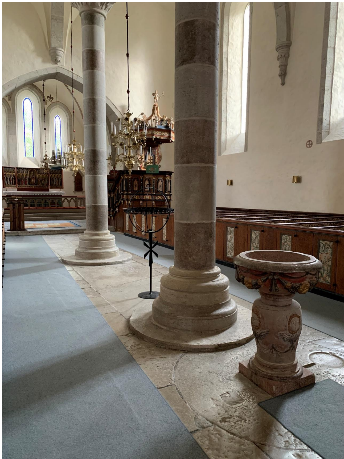
Interiör av långhuset mot sydöst med långhuskolonner. Kolonnbasernas runda form är ovanlig. Den låga plinten utgjorde sannolikt sittbänk när golvet låg lägre. Foto JL 2021.
