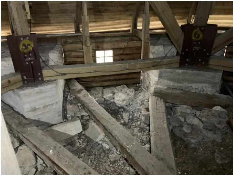
Tornets översta våning, sedd mot söder. Betongfundamenten mellan gluggarna tillkom 1982 för bäring av tornhuv. Foto JL 2021.
