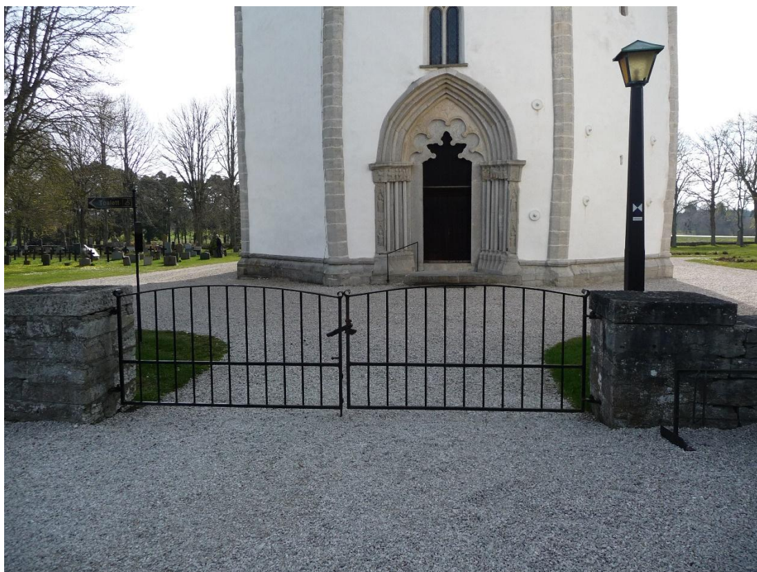
Den västra ingången har liknande dubbla järngrinden som den södra ingången med murade fyrkantiga grindstolpar. Foto ES 2021.
