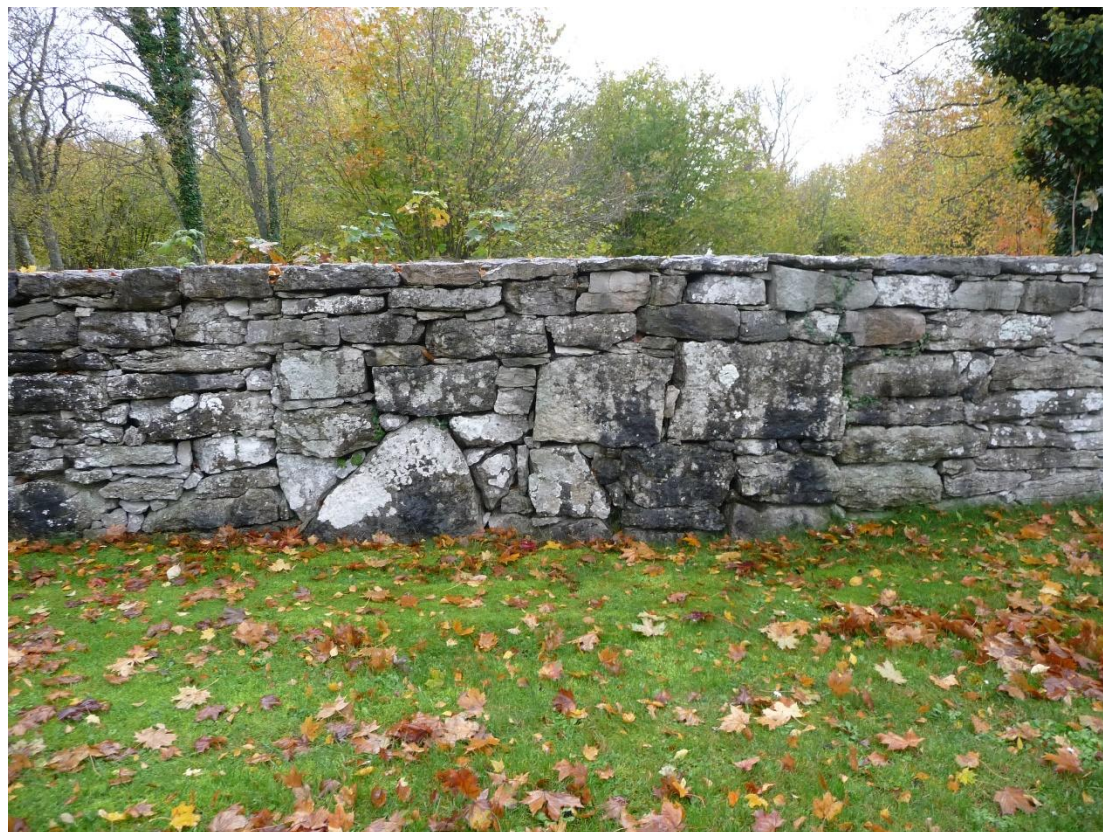
Spår i den västra muren efter en tidigare stiglucka. Foto ES 2021.
