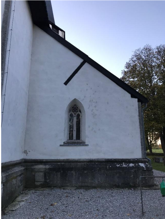
Sakristians östfasad och fönster. Foto JL 2021.
